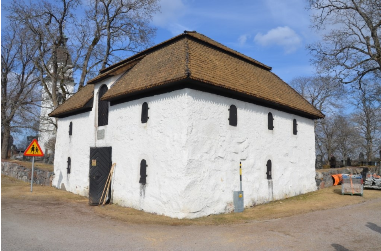
Götlunda sockenmagasin efter genomförda omläggning av spåntak. Vlm_kmvFE-2708.
