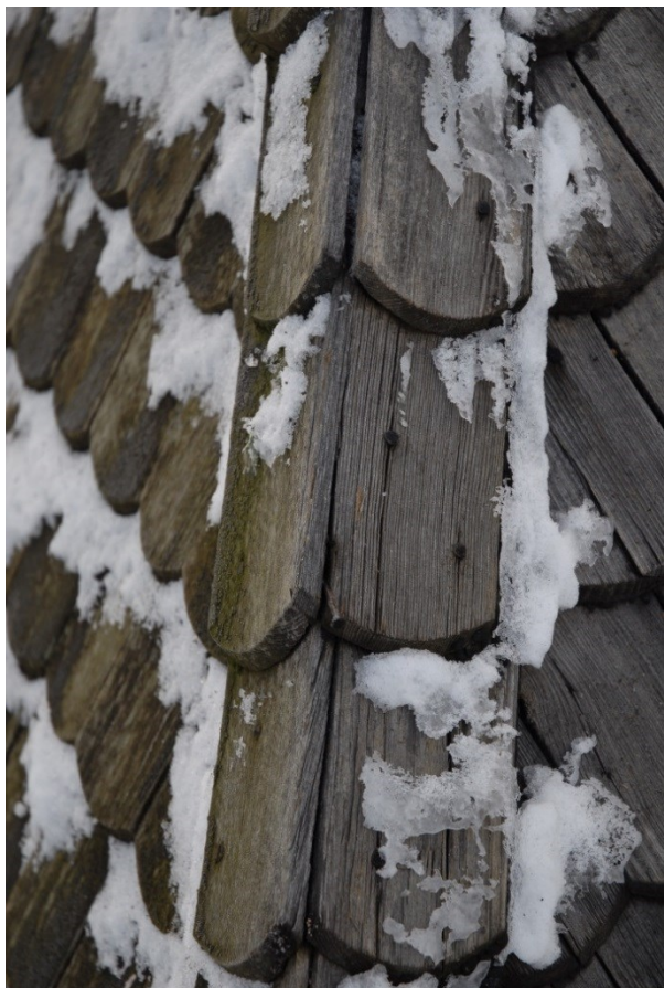
Spånets nocktäckning innan åtgärderna. Foto: Lars-Åke Augstusson.
