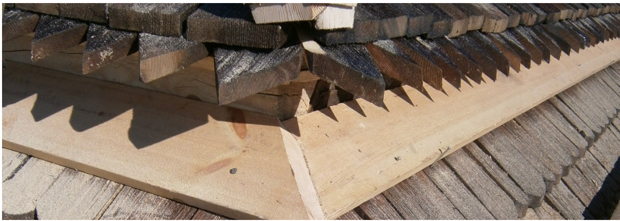
Ny utformning på den mellersta takfoten. Spånet sträcker sig längre ut och ska på så vis leda bort vatten bättre. Foto: Hälsinge Takspån AB.
