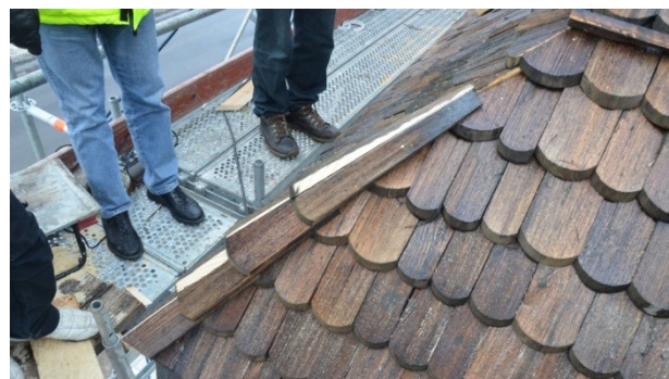
Växelvis nocktäckning under arbete. Vlm_kmvFE2577 och Vlm_kmvFE-2576
