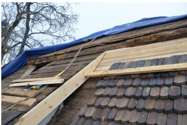
Spåntaket under omläggning. Vlm_kmvFE-2581
