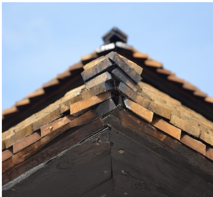
Närbild på den nya nocktäckningen som utfördes enligt befintligt utförande. Vlm_kmvFE-2710.
