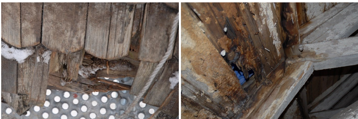
Exempel på skador på spåntäckningen som lett till rötskador på undertakets panel. Foto: Lars-Åke Augustsson.
