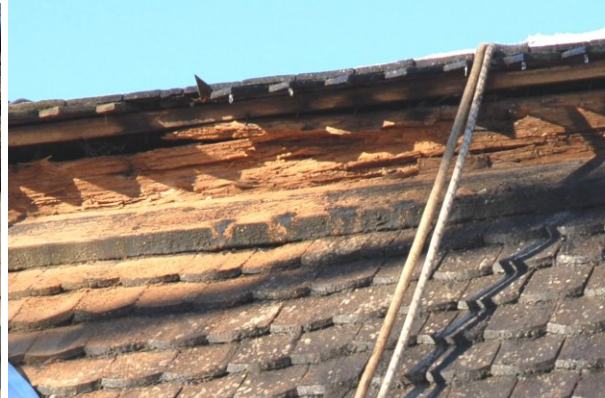
Rötskadad bjälke östra takfallet. Foto: Lars-Åke Augustsson
