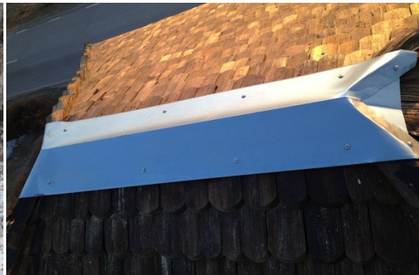
Ny nockplåt på plats. Foto Hälsinge Takspån AB.
