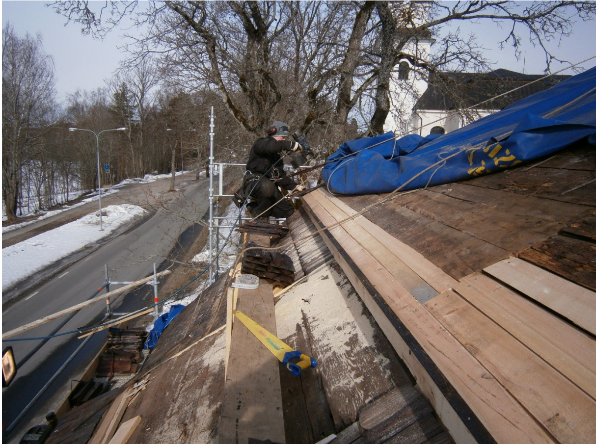
Undertaket reparerades men mycket av det befintliga taket bevarades. Foto: Hälsinge Takspån AB.
