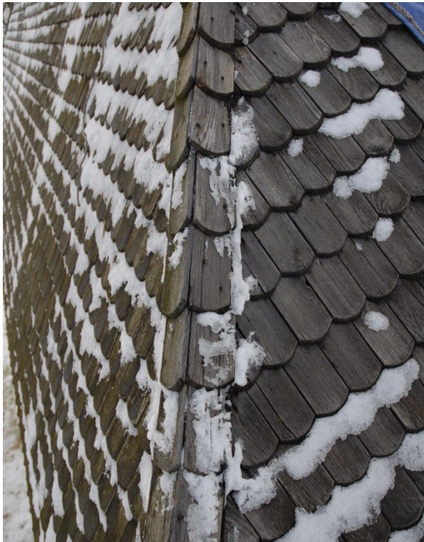
Nocktäckningens utseende innan åtgärder. Foto: Lars-Åke Augustsson
