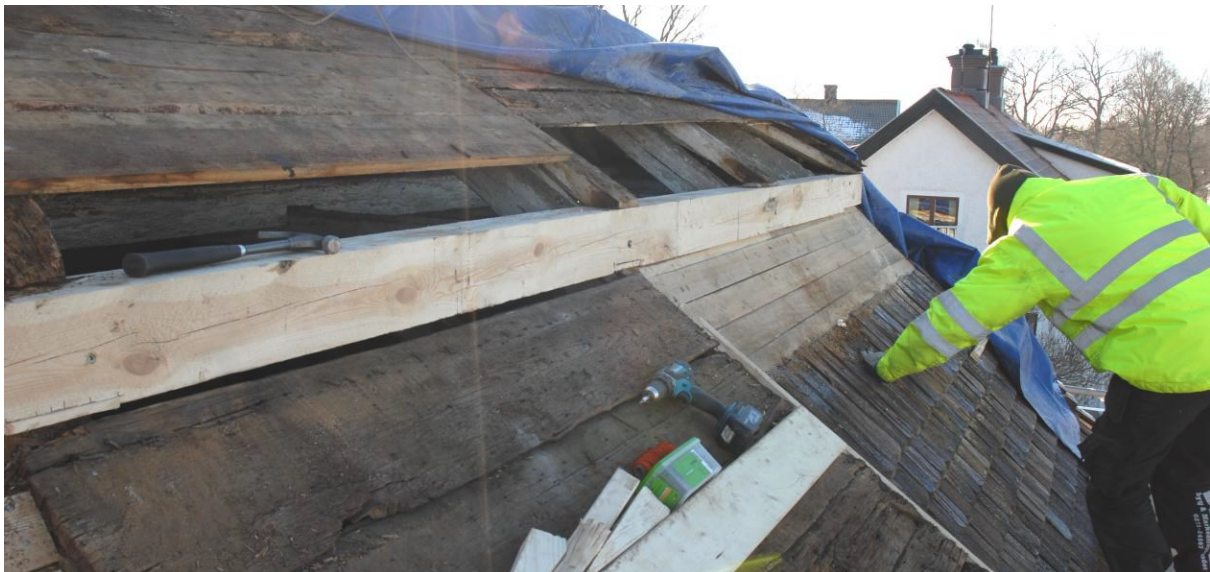
Den bärande bjälkarna i det västra och det östra takfallet byttes ut i sin helhet. Foto: Lars-Åke Augustsson
