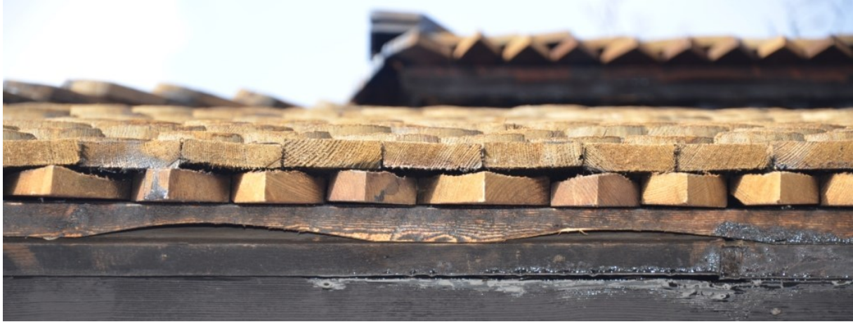
På bilden syns takfoten med den urtagna läkten som skapar ventilation in till undertaket. Vlm_kmvFE-2609
