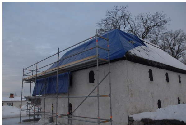
Vid arbetsuppehåll täcktes taket med en pressenning. Foto: Lars-Åke Augustsson.
