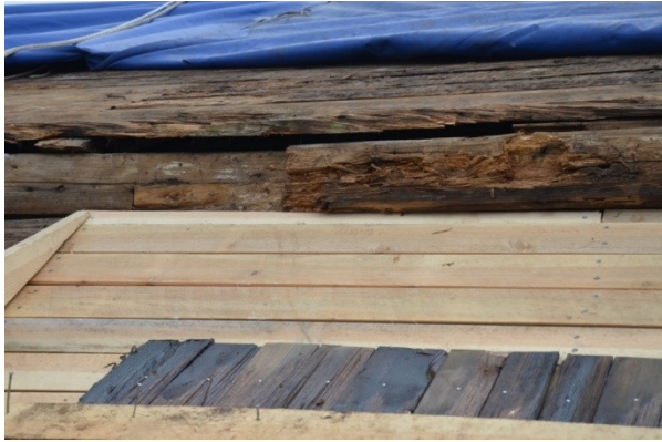
Rötskadad bjälke västra takfallet. Vlm_kmvFE-2580
