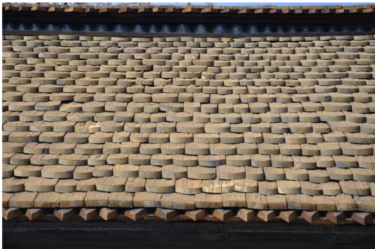
Den nya spåntäckningen bildar ett vackert mönster och bevarar byggnadens uttryck som är av stor vikt för dess höga kulturhistoriska värden. Vlm_kmvFE-2696
