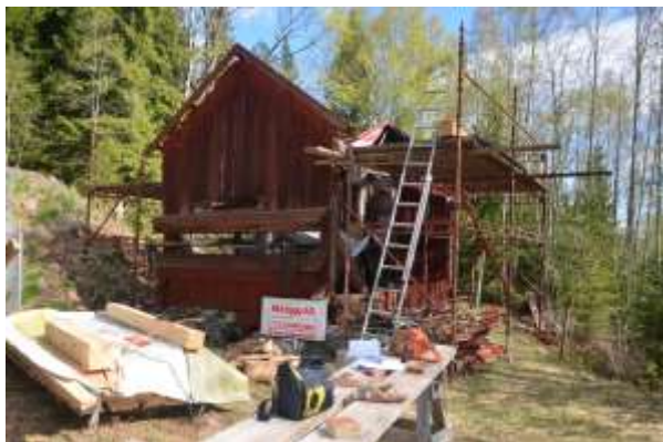
Bild 3. Pågående rivning och reparation.
