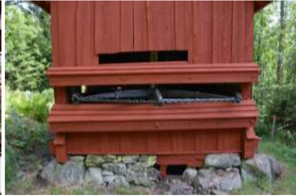
Bild 18. Sydöstra fasaden efter målning.
