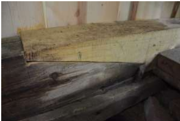
Bild 14. Skarv mellan gammal och ny syllstock.
