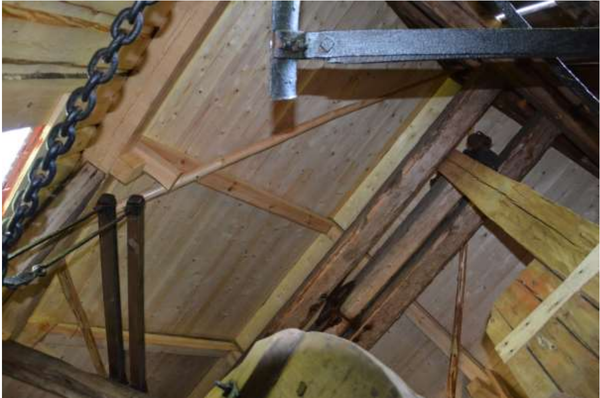
Bild 6. Då även takstolarna var skadade byttes dessa ut mot nya.
