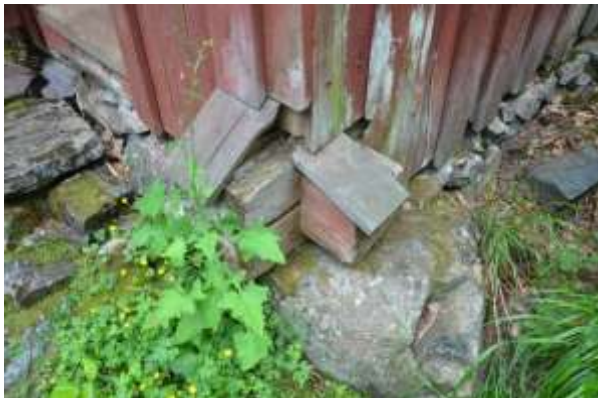
Bild 11. Grunden innan reparationer.
