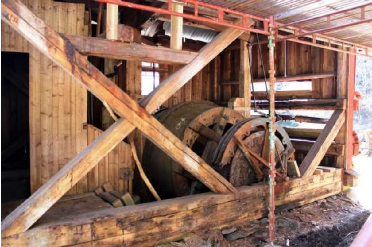
Bild 15. Hakspelets konstruktion blev synlig under åtgärdena. Panelen bortplockad från nordvästra fasaden.
