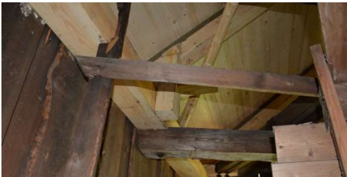
Bild 5. Byggnadens insida efter reparation. Den nya råsponten bör skydda mot framtida fuktproblem.
