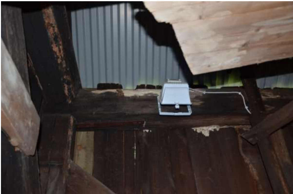
Bild 1. Svampangreppet under plåttaket var koncentrerat till byggnadens östra hörn. Det trapetskorrugerade plåttaket låg på öppen läkt.
