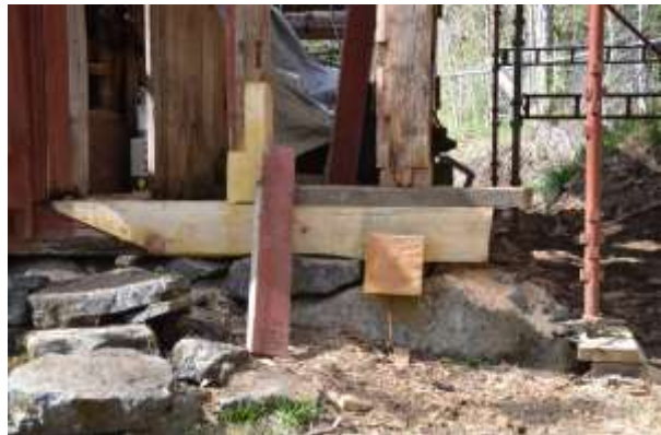
Bild 12. Pågående byte av syll.
