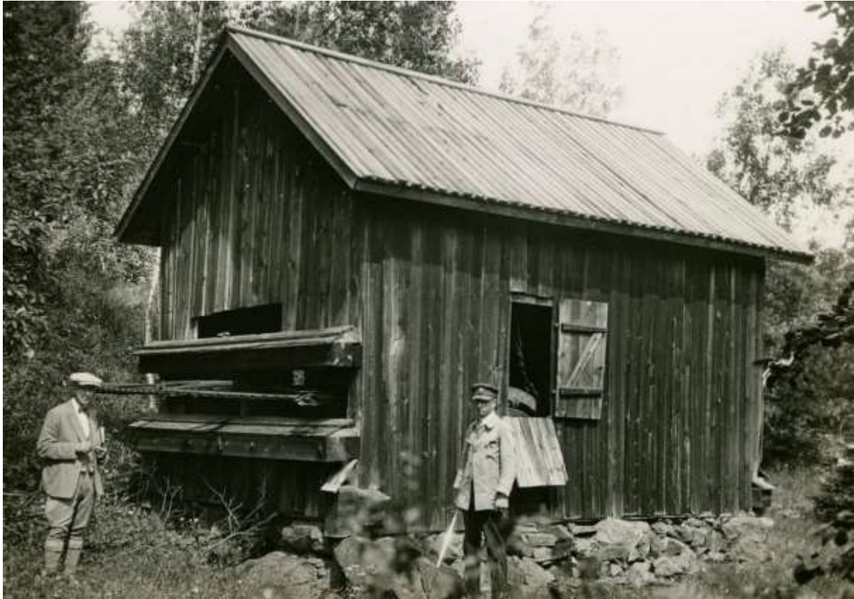
Foto från 1927 på byggnaden med hakspelet vid Bastnäsgruvan. Byggnaden har då ett tak av locklagda brädor. Foto Torsten Althin. 1
