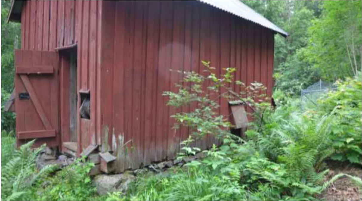
Bild 8. Nordvästra fasaden innan reparationer, rötskador fanns i panelens nederkant. Vegetation växer nära byggnadens fasad.
