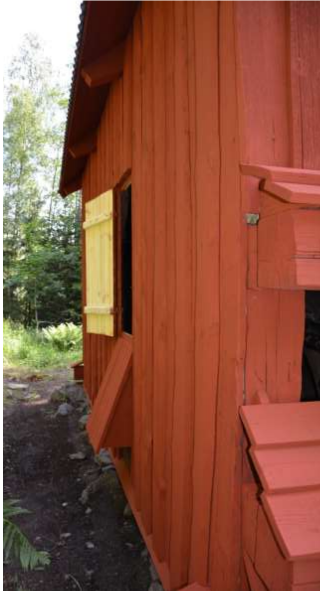
Bild 10. nordvästra fasaden efter reparationer.
