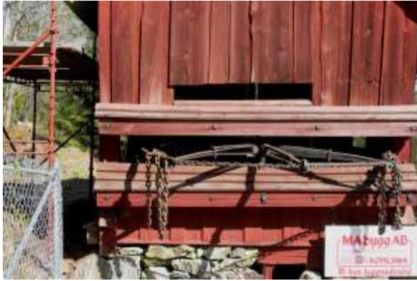
Bild 17. Sydvästra fasaden. Järndetaljerna rostskyddsmålades och fasaden målades med röd slamfärg.
