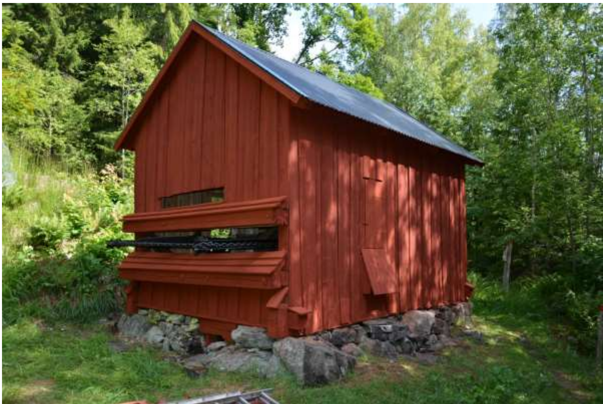
Bild 20. Hakspelet i Bastnäs efter reparation.
