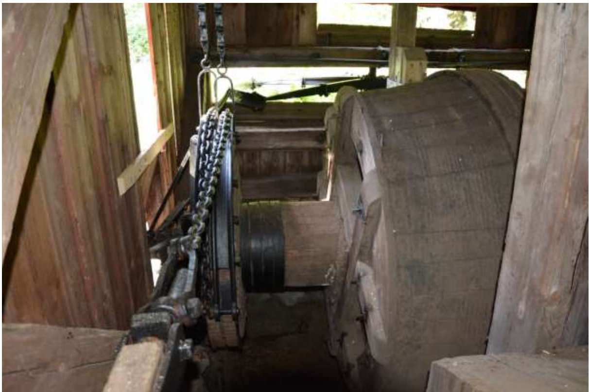
Bild 16. Samtliga järndetaljer borstades och rostskyddsbehandlades. Lintrumman roterades och rengjordes.
