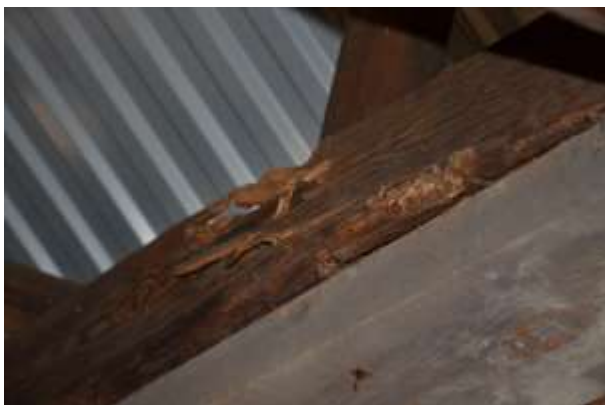
Bild 2. Skada på takkonstruktionen.
