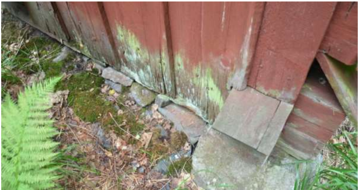
Bild 9. Detaljbild på rötskadad panel.
