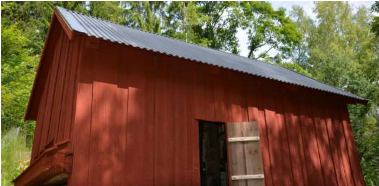
Bild 7. Byggnadens tak efter reparation.
