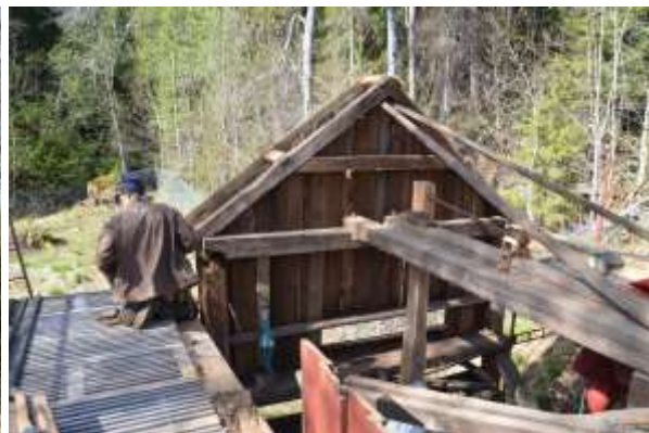
Bild 4. Byte av hammarband.
