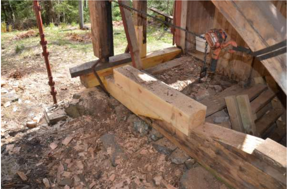
Bild 13. Då den stora lintrumman vilar på syllen var det viktigt att bärigheten blev god vid reparationerna.
