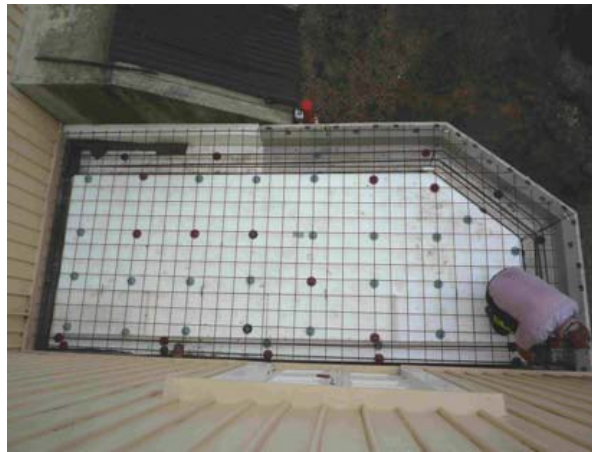
Bild 6. Påbörjad gjutning med armeringsjärn.
