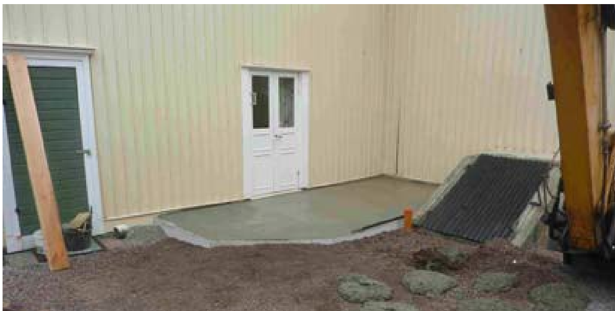
Bild 7. Gjutning av ny grund genomförd.
