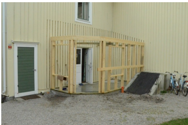
Bild 8. Pågående uppregling av stomme. Locklisterna plockades av från fasaden och återanvändes på tillbyggnaden.
