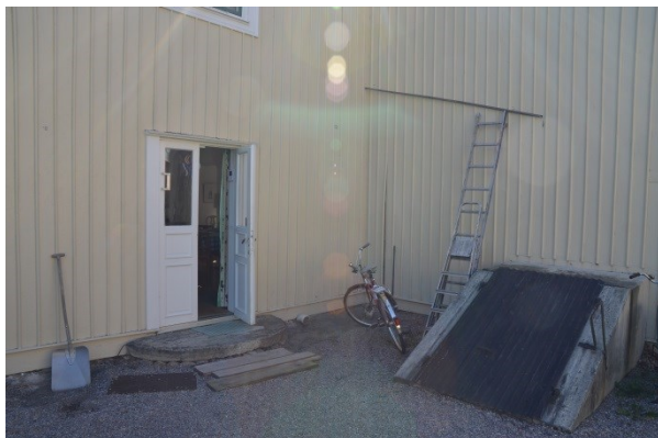
Bild 3. Gårdshuset innan tillbyggnad. Tillbyggnadens taklutning är markerad med läkt på väggen.
