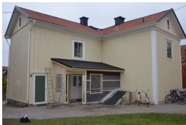
Bild 9. Pågående arbete med takkonstruktion mm.
