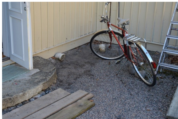
Bild 4. Dagvattenledning som ej var i bruk.
