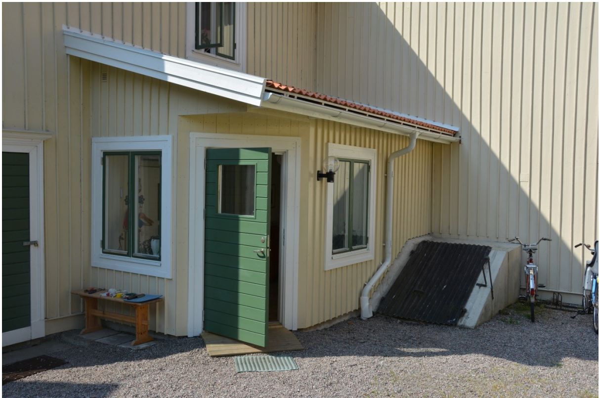
Bild 12. Tillbyggnaden färdig på gårdshuset och färdigstruken med linoljefärg.
