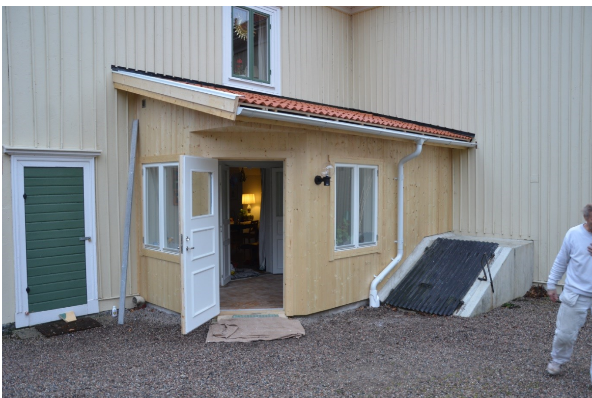
Bild 10. Dörr och fönster har kommit på plats. Som golv lades klinker med en mindre ramp för att göra entrén mer lättillgänglig.
