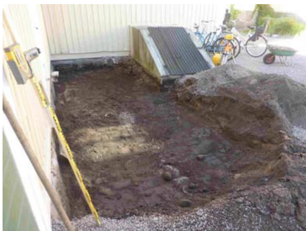
Bild 5. Utgrävning för den nya grunden.
