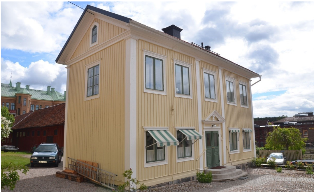
Bild 1. Gärdshuset i kv Kungsgården 3 efter målningsarbeten på fasad mm 2009-2012.
