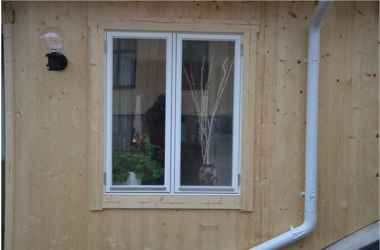
Bild 11. Nya fönster med två lufter likt de befintliga fönstren på gårdshuset.
