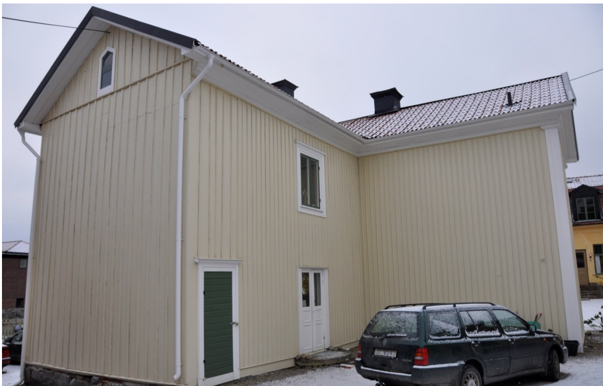
Bild 2. Gårdshusets södra fasad efter målningsarbeten mellan åren 2009-2012.
