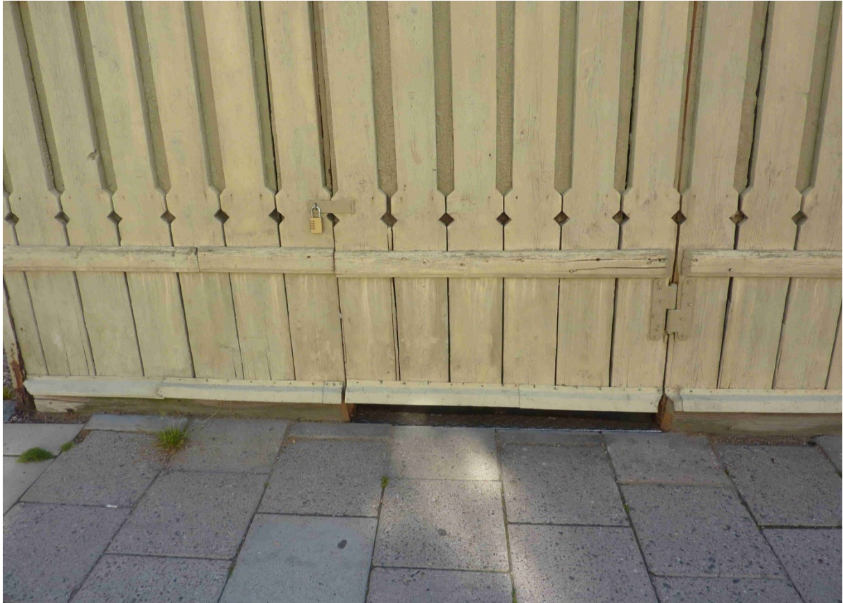
Bild 6. I nederkanten sattes en gummilist för att förhindra drag, men ändå ge ventilation in i sovrummet.
