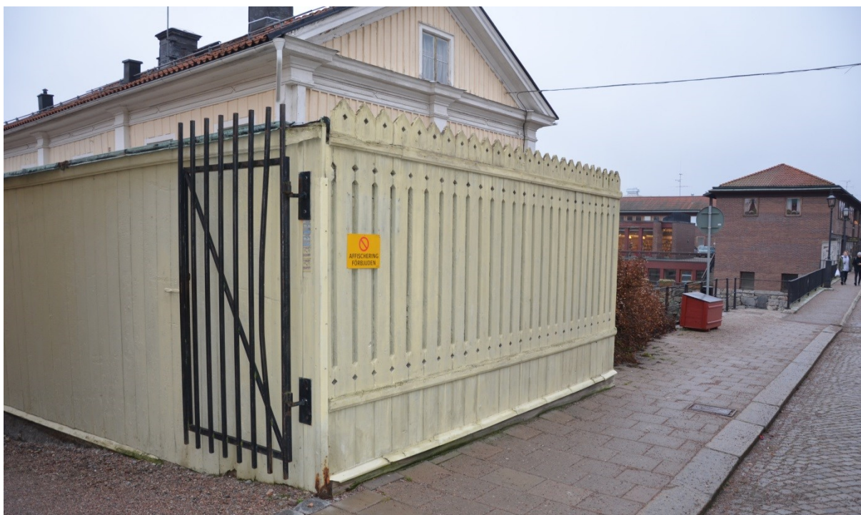
Bild 1. Sophuset innan den nya porten tagits upp. Fasad ut mot Kapellgatan.
