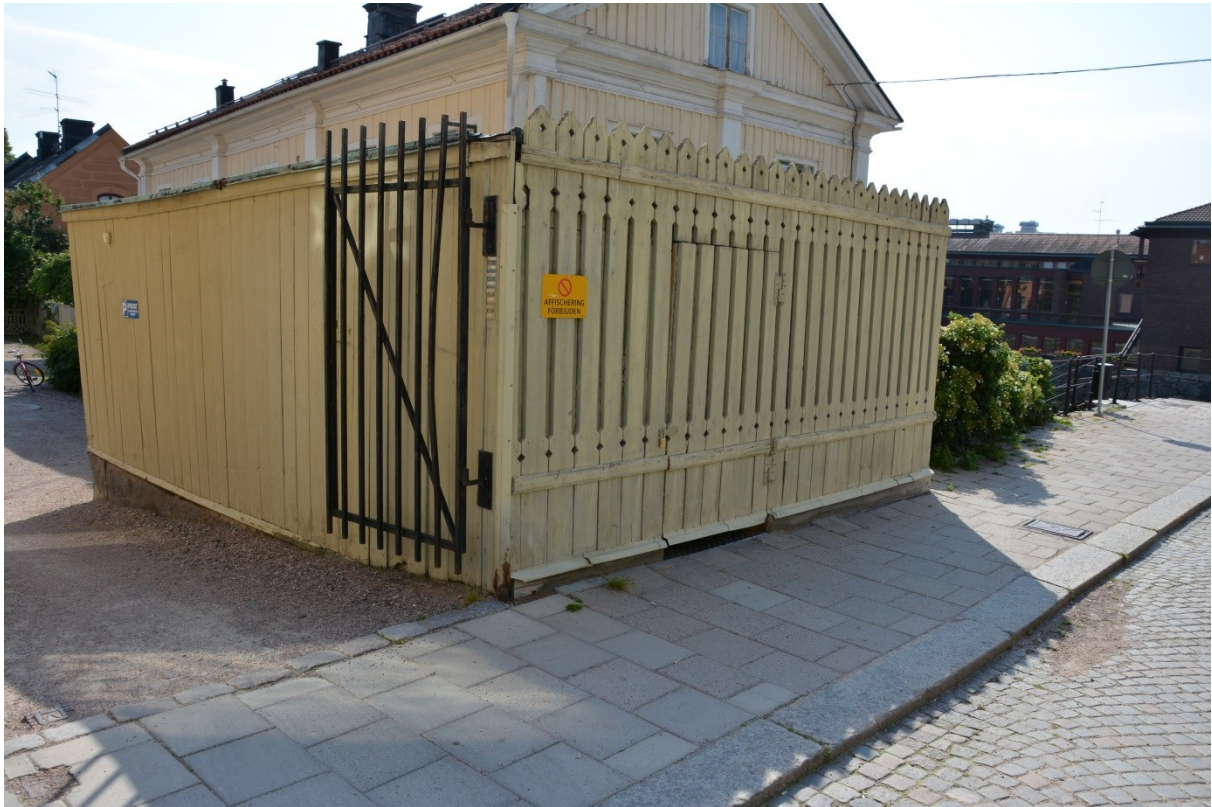
Bild 3. Sophuset efter att den nya porten tagits upp. Åtgärden blev mycket diskret.
