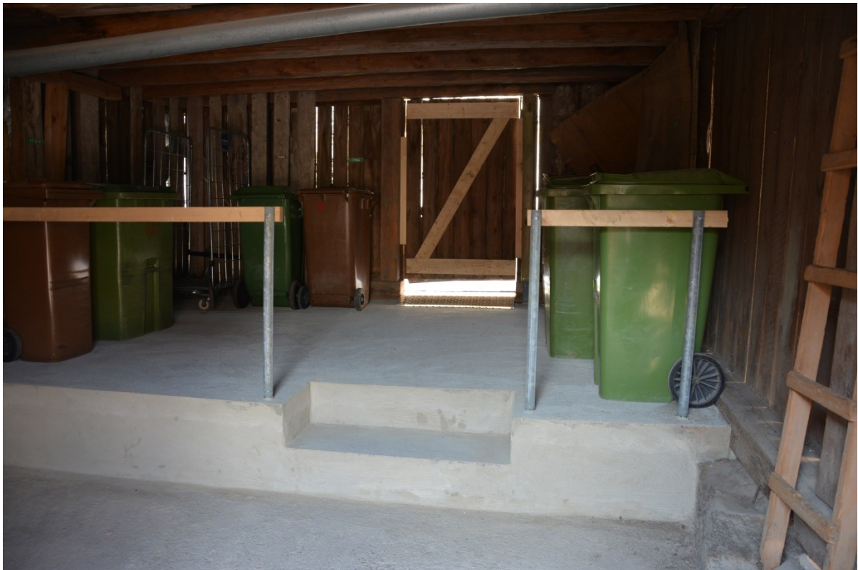
Bild 5. Soporrummet efter att porten tagits upp och golvet höjts.
