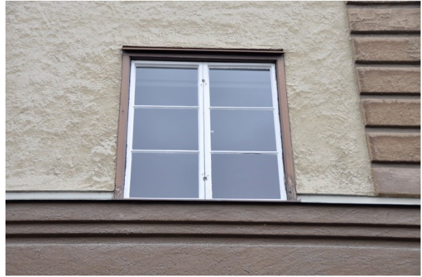
Bild 3: Fönster innan restaurering
