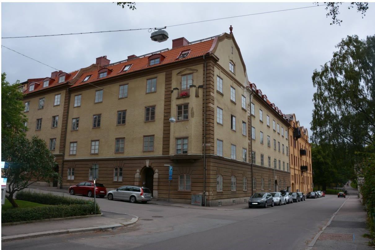
Bild 1: Byggnaden sträcker sig över hörnet i korsningen Källgatan och Västermalmsgatan. Etapp 1 av fönsterrestaureringen är avslutad och etapp 2 är påbörjad, därav de täckta fönstren till höger i bild.
