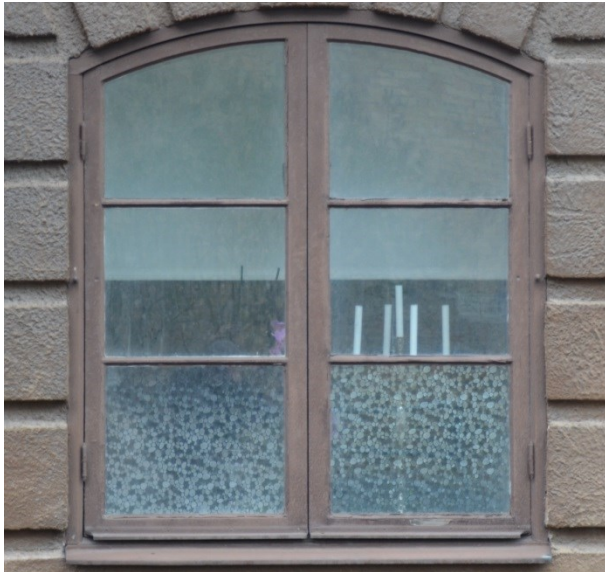
Bild 2 Fönster innan restaurering
