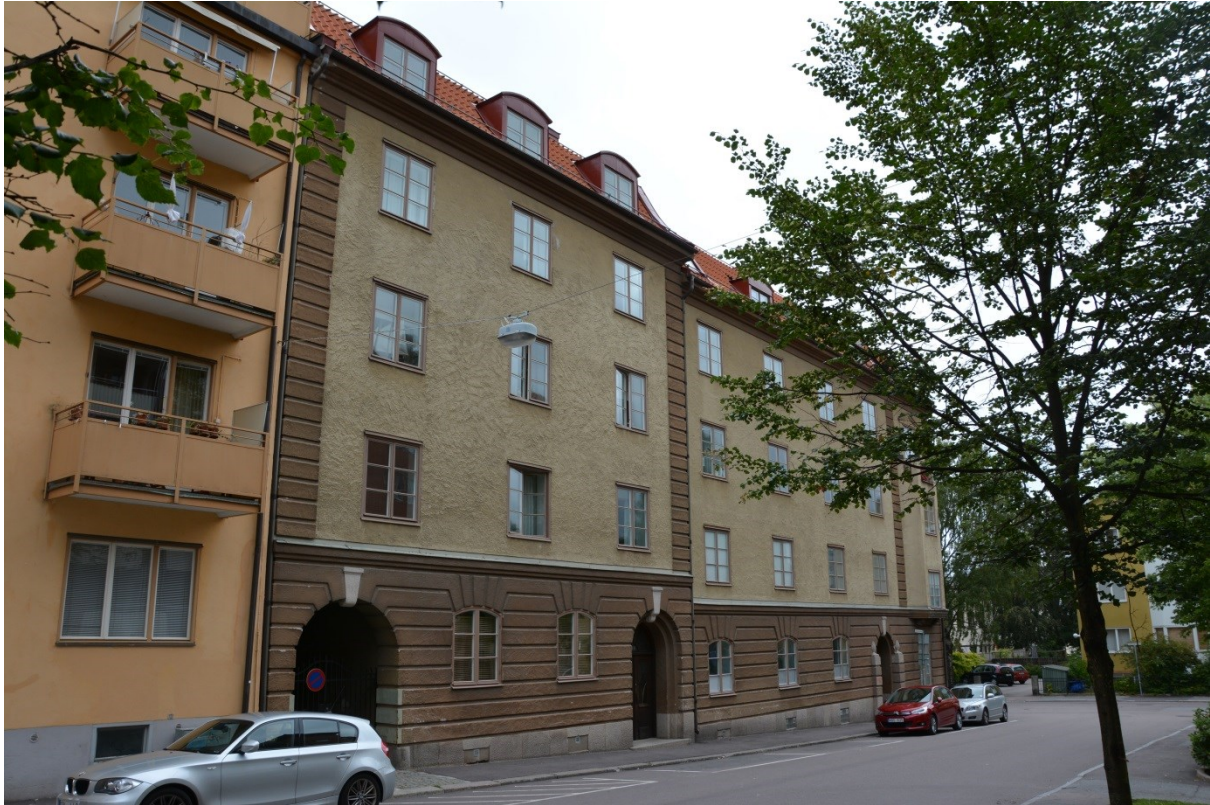
Bild 6: Fasaden ut mot Västermalmsgatan efter restaurering.
