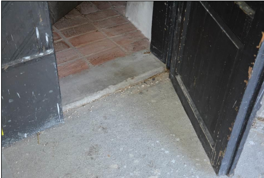
Betongtröskeln innan åtgärd. Vlm_kmvFE-4543.
