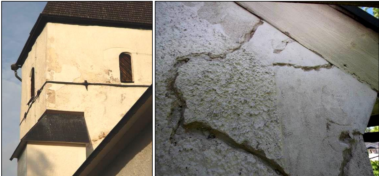
Putsskador på tornets östra fasad samt på korgavel. Foto: L-Å Augustsson.
