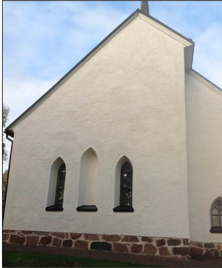
Östra fasaden efter putslagningar och avfärgning. Vlm_kmvSB-2524.
