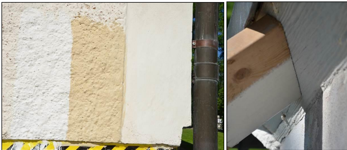
Provstrykning med Ölands- och Gotlandskalk, Vlm_kmvFE -4449 samt provstrykning vindskivor , Vlm_kmvFE -4439
