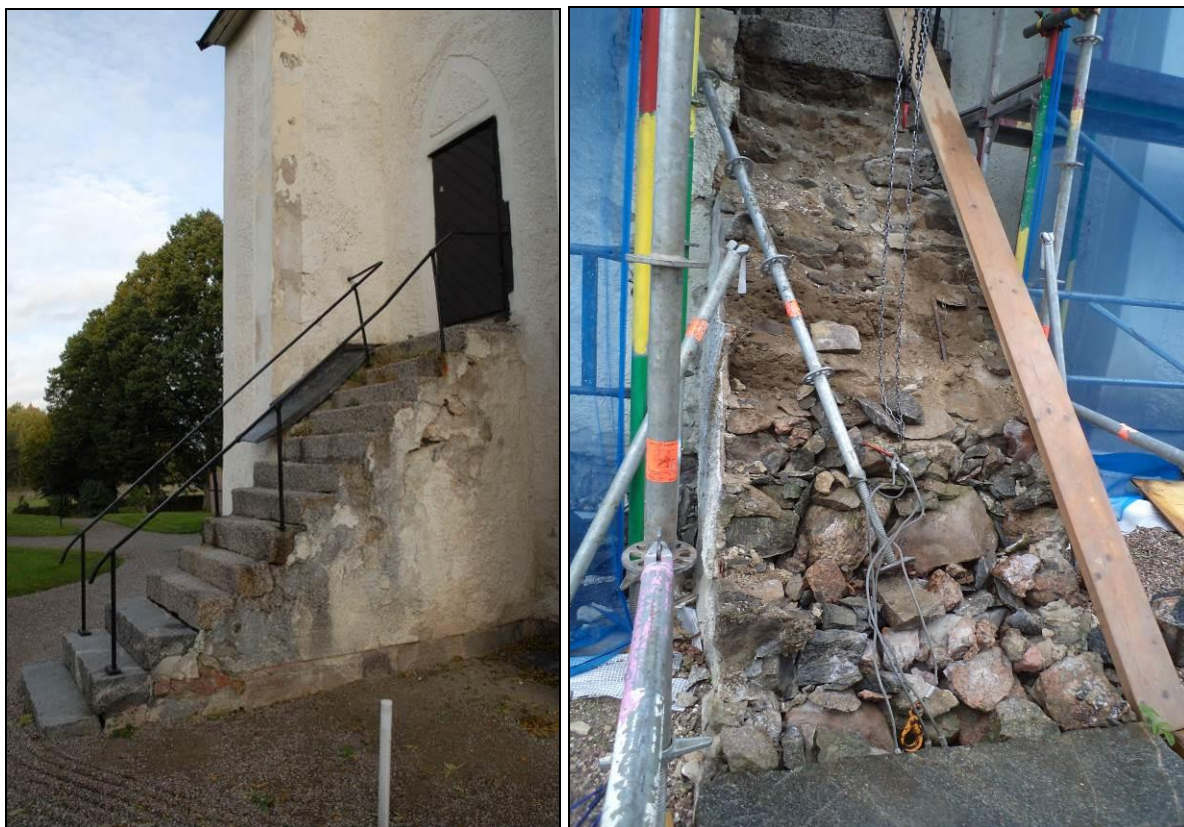
Stentrappans skick före och under arbetet. Foto: Vlm_kmvSB-2307, L-Å Augustsson.
