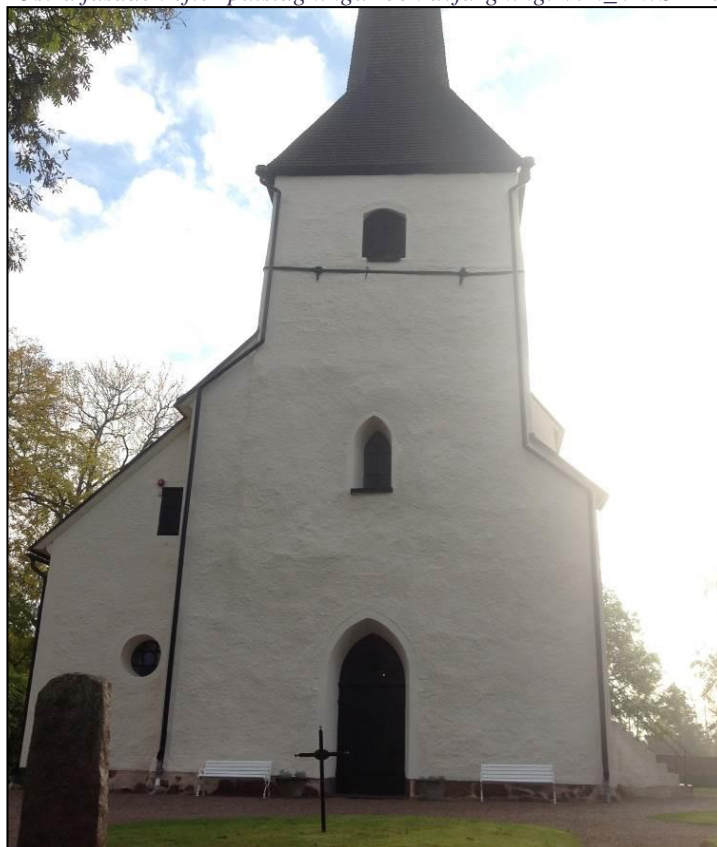
Västra fasaden efter putslagningar, avfärgning samt tjärning av dörrar. Vlm_kmvSB-2525.
