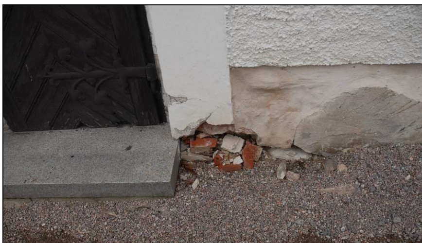
Frostsprängning vid långskeppets portomfattning. Foto: L-Å Augustsson.
