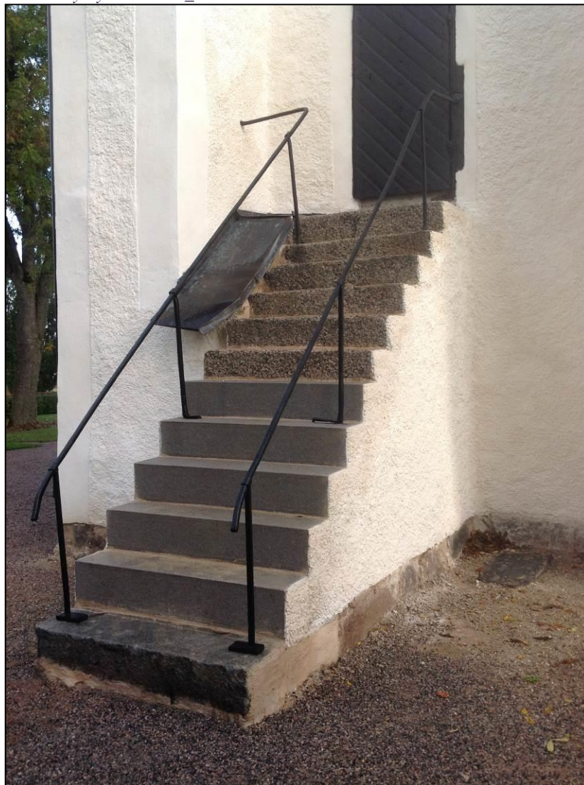
Färdigställd trappa med ny granitsten. Vlm_kmvSB-2521.
