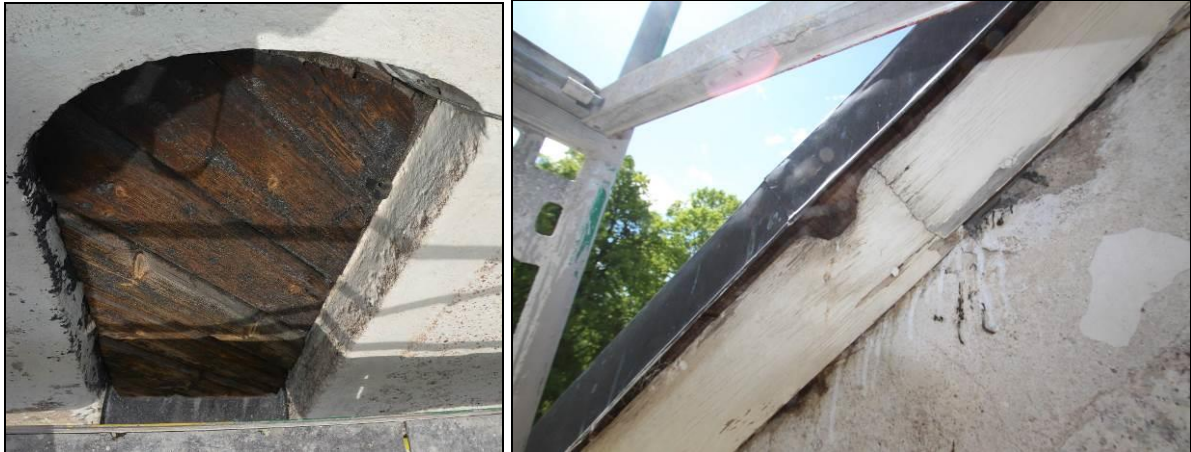
Ljudlucka innan tjärbehandling, Vlm_kmvFE-4550, Vindskiva på östra fasaden innan åtgärd. Foto: Front RK AB.
