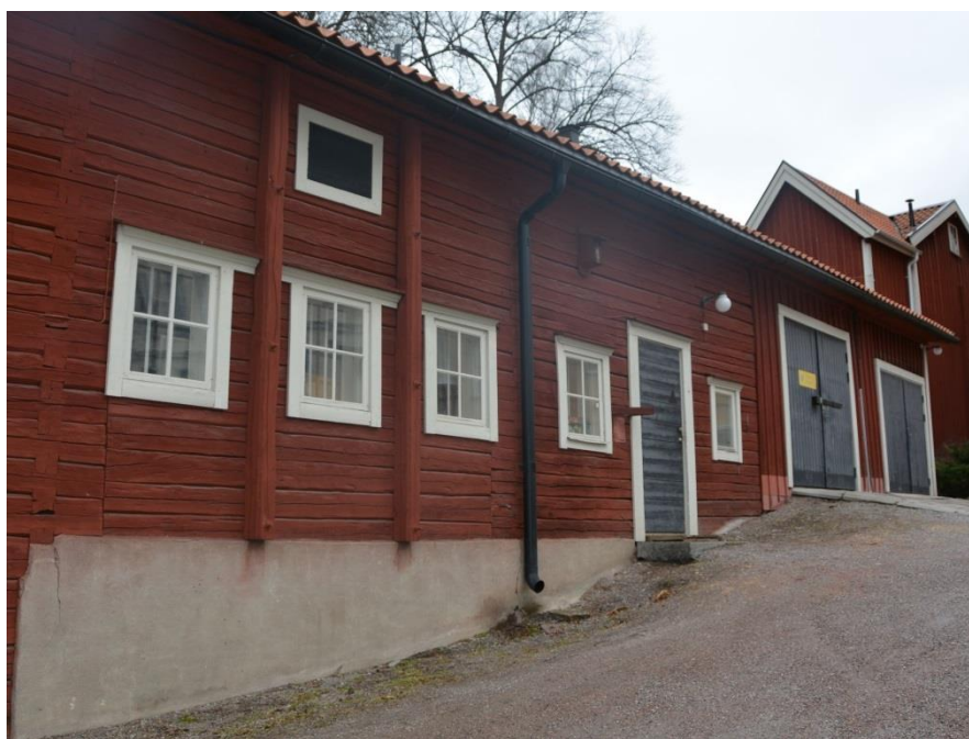
Norra delen av entrefasaden innan åtgärder 2015-13-13.
