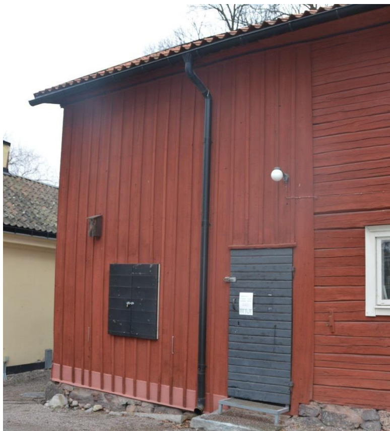
Södra delen av entrefasad mot gården 2015-03-23. BildID: Vlm_kmvSB-3554.
