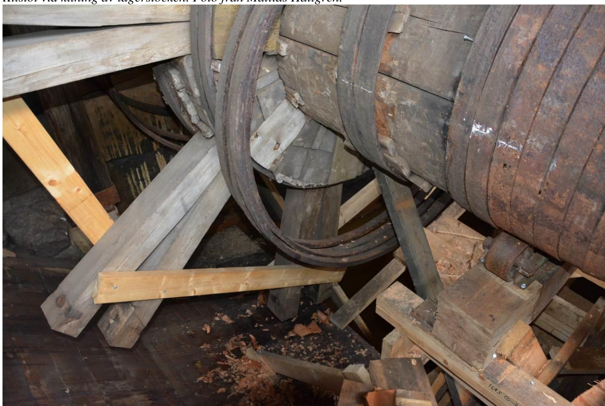
Hjulet under nedmontering. BildID: Vlm_kmvSB 4155.
