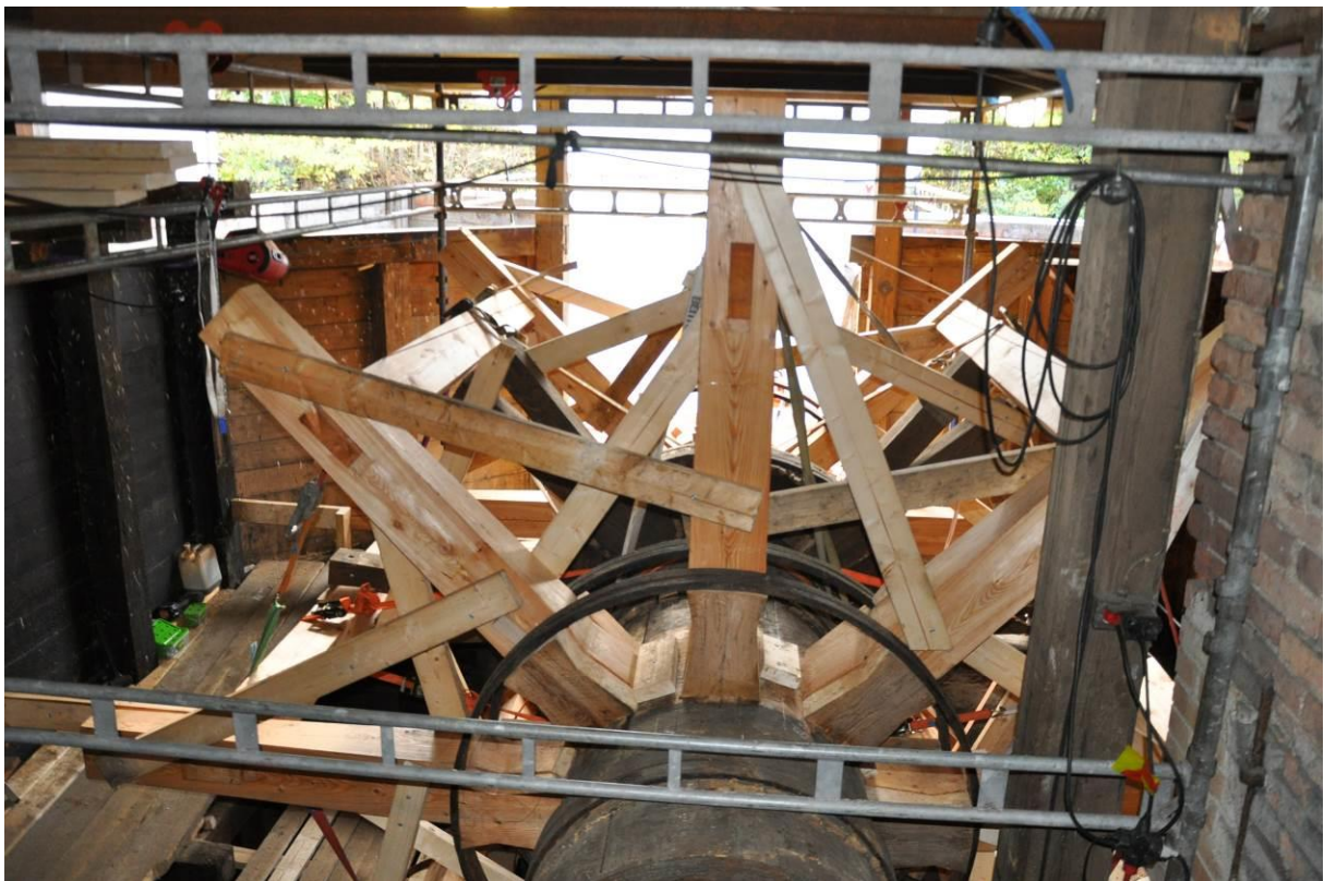
Fortsatt montering under våren 2015. Foto från Mattias Hallgren.
