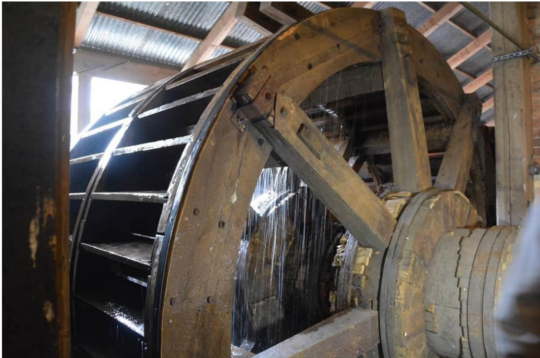
Vattenhjulet inman åtgärder, oktober 2014. BildID: Vlm_kmvSB-2531.
