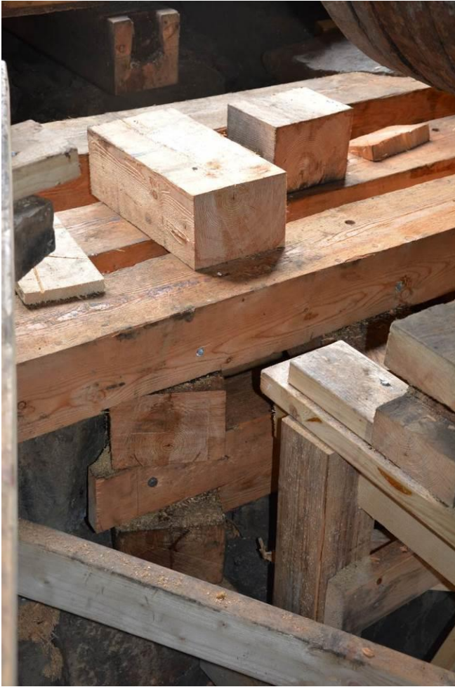
Konstruktionen som bär upp lagerstenen BildID: Vlm_kmvSB-4153.
