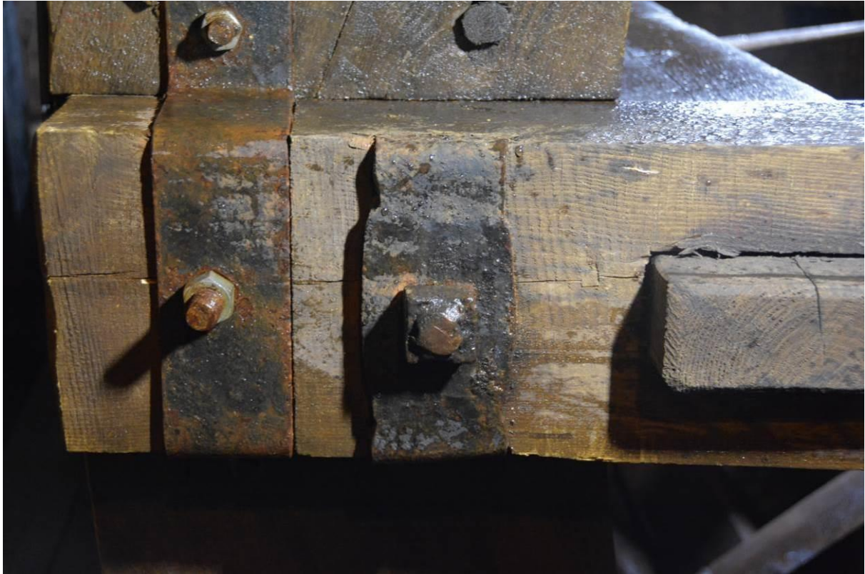
Metallbeslag från olika perioder på det gamla hjulet. BildID: Vlm_kmvSB-2538.
