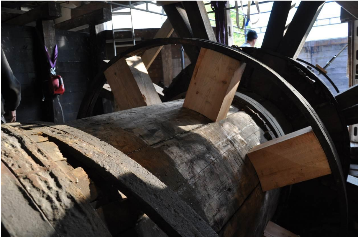
Lagerringarna monteras och kilas. Foto från Mattias Hallgren.
