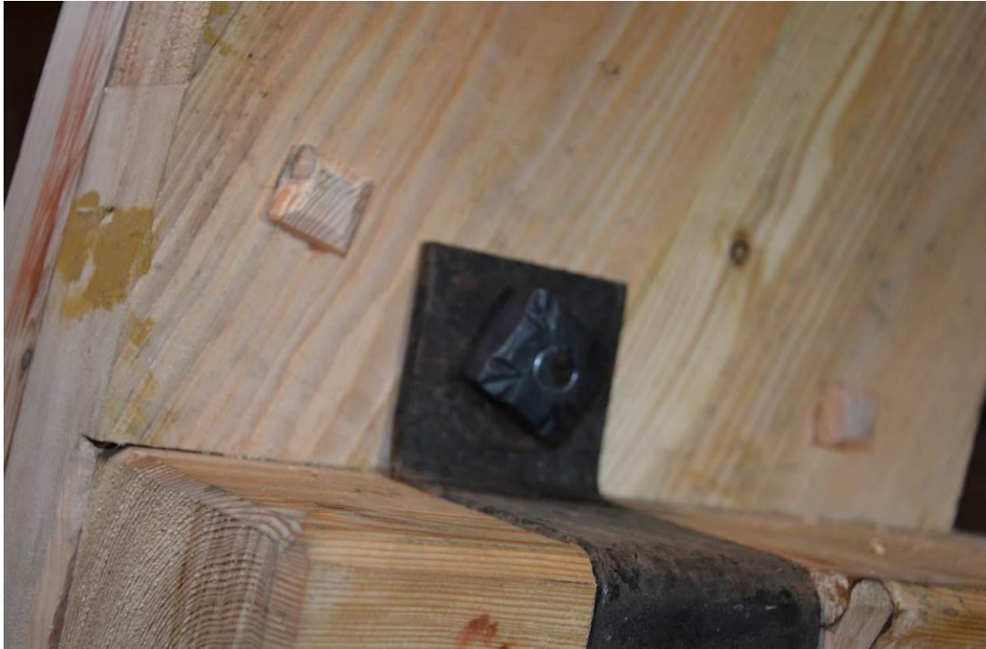
Löten har fäst med dymlingar och konstruktionen har förstärkt med både återanvänt smide och nytt smide. BildID: Vlm_kmvSB-4280.
