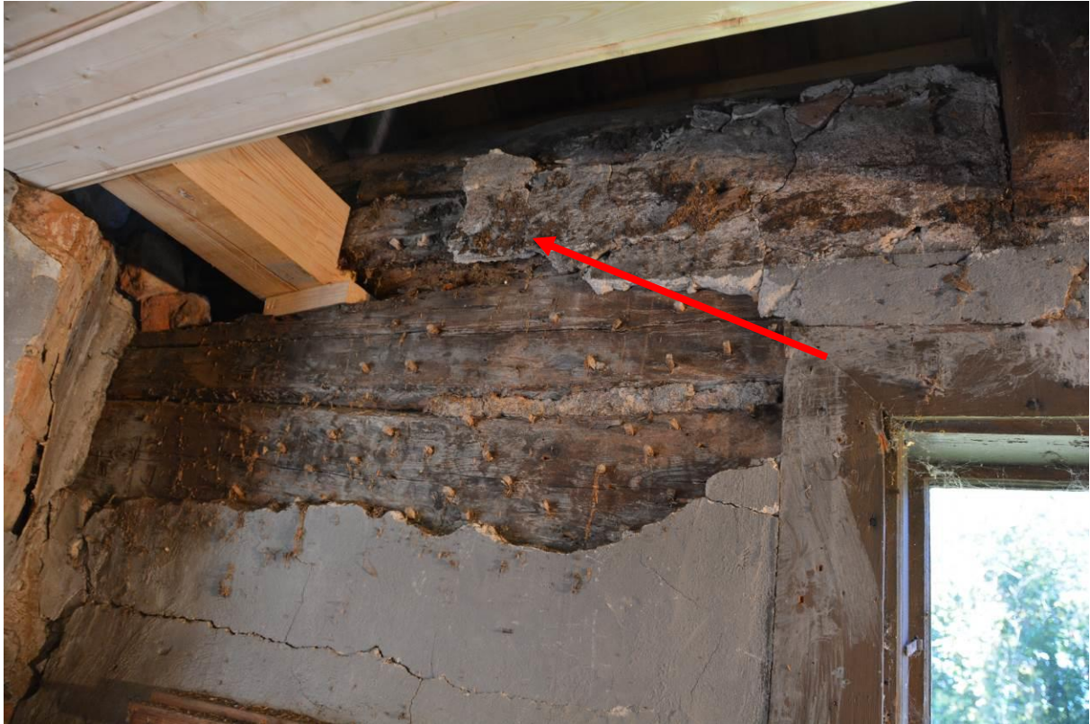
Den nyupptäckta rötskadan i väggen ovanför kvarnkammaren. Det nya taket skruvades fast just över skadan, så att det lätt kan lyftas av vid en eventuell framtida åtgärd. Bild: Vlm_kmvAF-1474.
