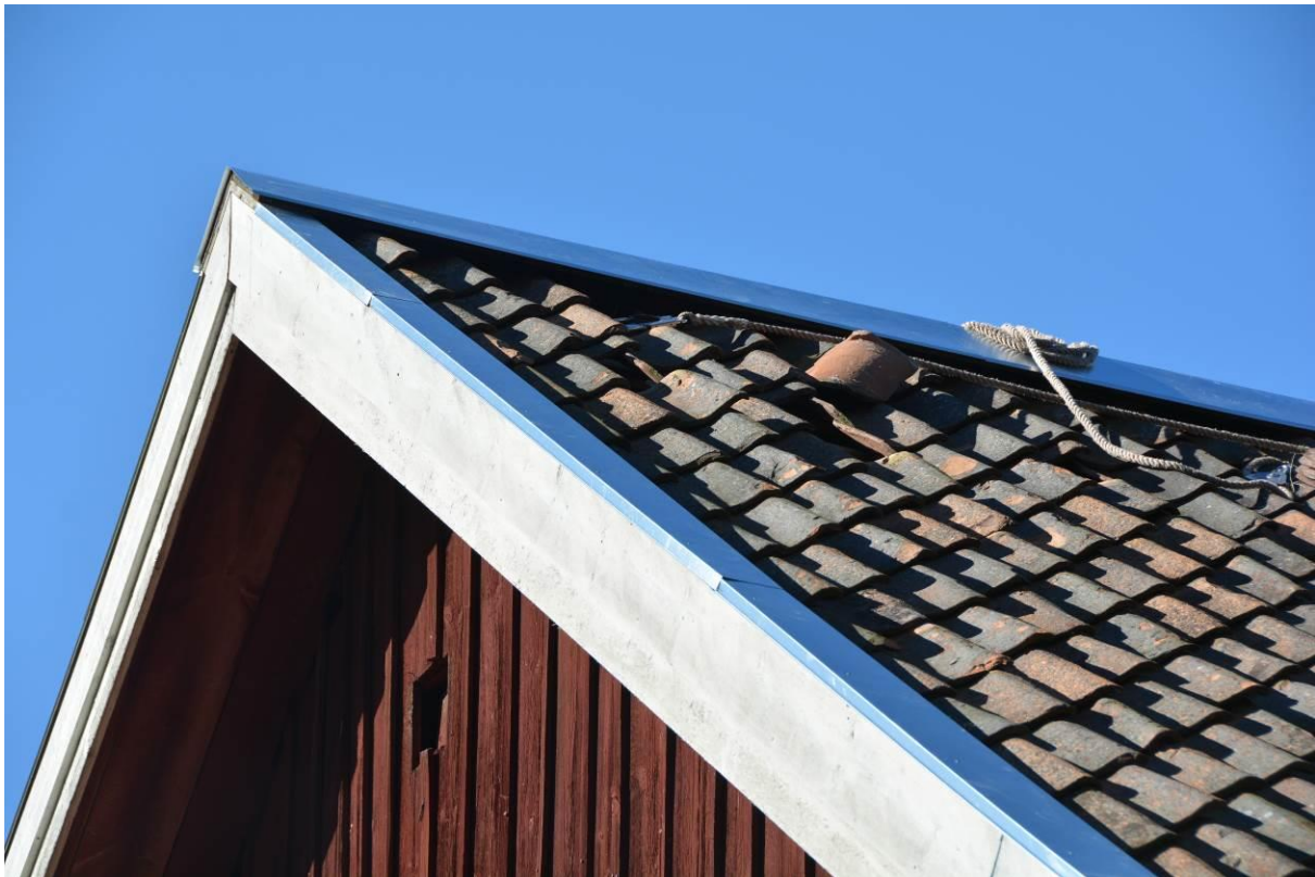
De nya plåtarna över vattbrädan ochnockbrädan på plats. Bild: Vlm_kmvAF-1484.
