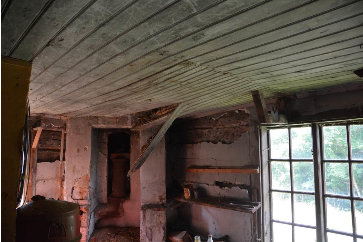
Taket i kvarnkammaren var skadat i hörnet. Hela "rutan" fram till skarven byttes ut. Bild: Vlm_kmvAF-855.
