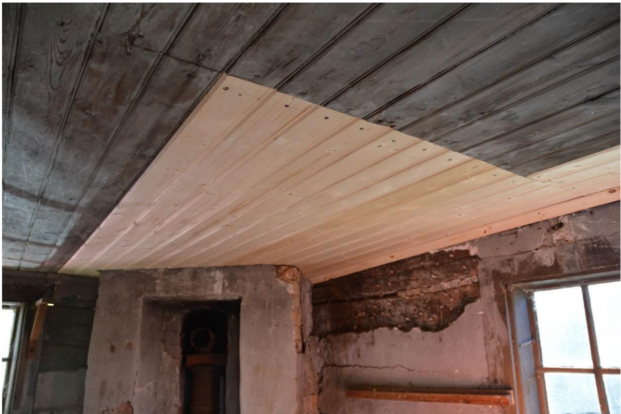
Taket i kammaren efter åtgärd. Bild: Vlm_kmvAF-1537.
