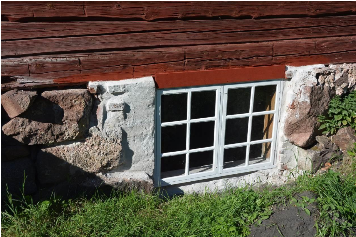
Det lagade fönstret med nytt stabiliserande, hydrauliskt bruk runt. Bild: Vlm_kmvAF-1530.
