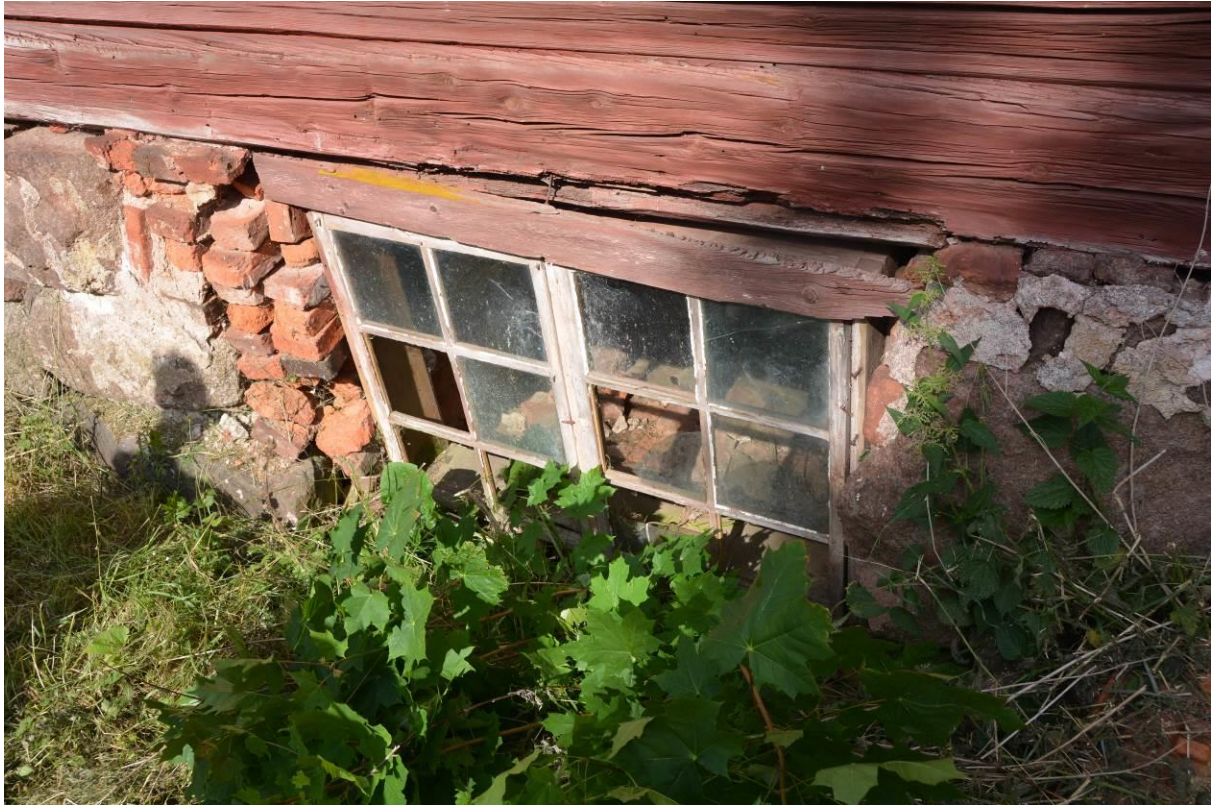
Det skadade fönstret. Bild: Vlm_kmvAF-841.
