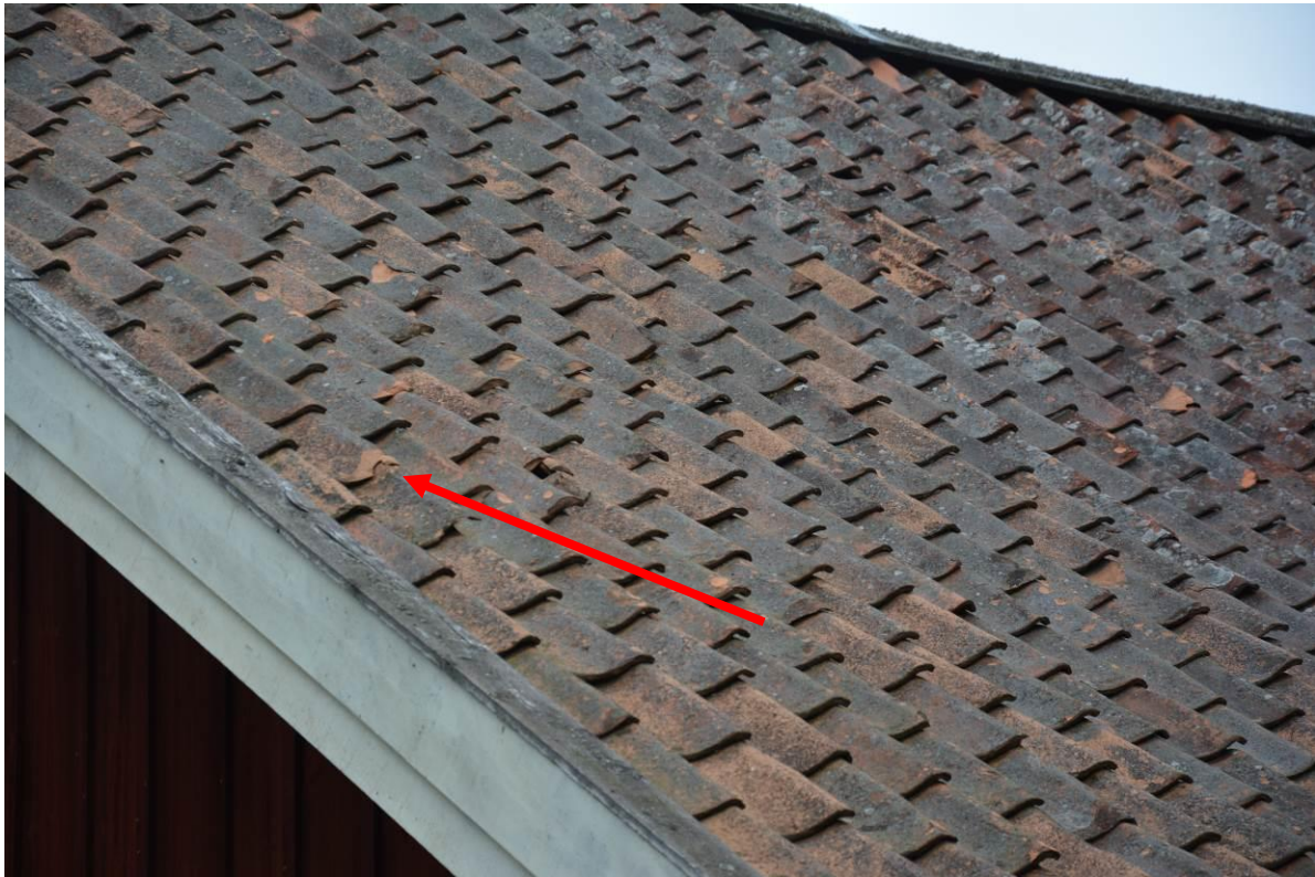
Ett antal takpannor var skadade och byttes ut. Vattbrädan över vindskivan är också sliten. Bild: Ellen Holtermann Wiig, Västmanlands läns museum. Vlm_kmvEHW-1527.
