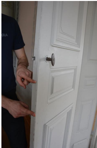
Uppmätning och diskussion om var nytt nödutrymningsbeslag bäst placeras på pardörr mellan rum 306/305. Bildnummer: Vlm_kvmEHW-985
