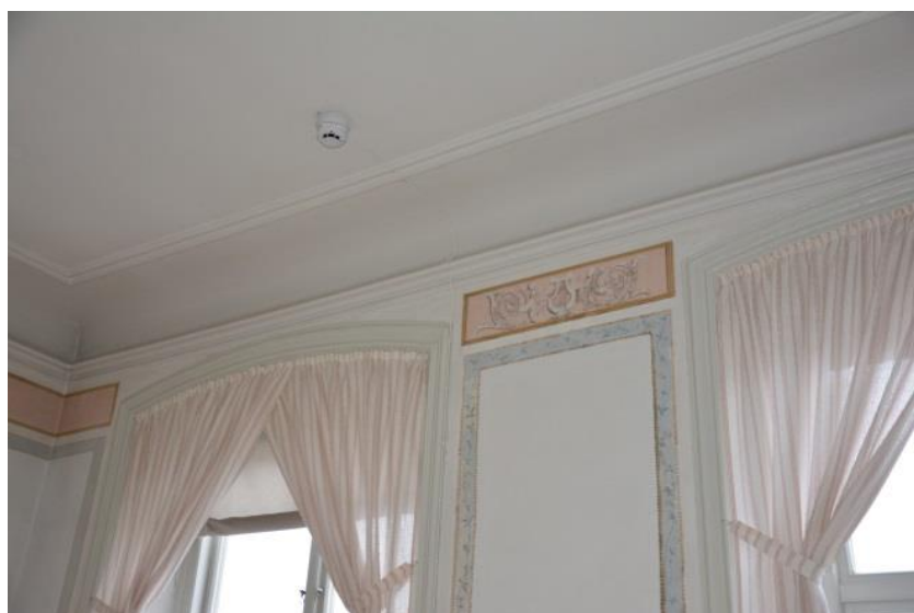
Ny rökdetektor på plats i rum 319, sladdarna är målade i takfärg NCS S 1502-Y och därför knappt synliga. Bildnummer:Vlm_kvmeHW-1359.
