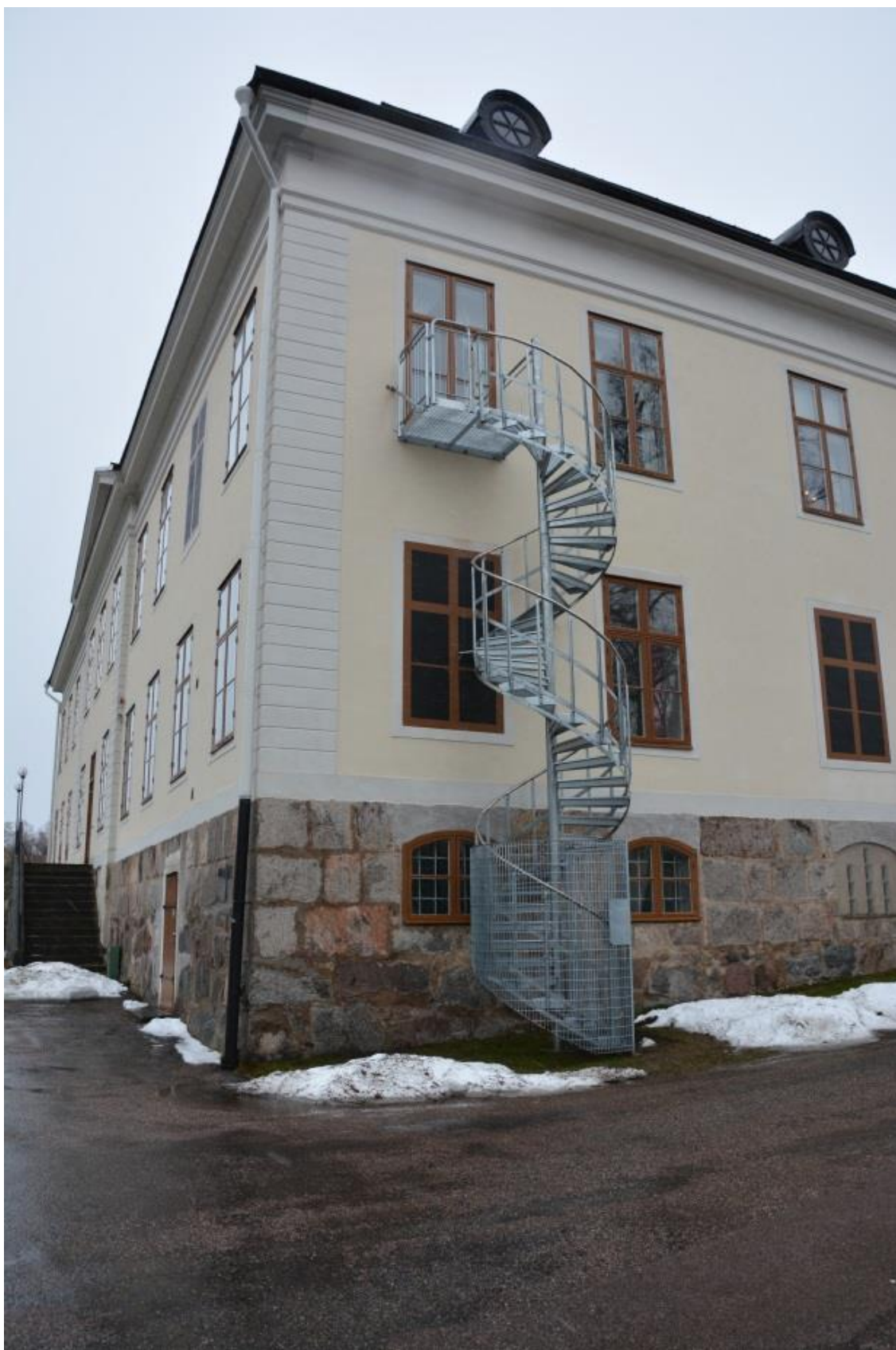
Ny utrymningstrappa på västra gaveln. Fönstret i rum 306 är utbytt mot nytt fönster utan mittpost "fönsterdörr". Även källarfönstren i anslutning till brandtrappan har fått nytt brandsäkert. Bildnummer Vlm_kmvEHW-1376
