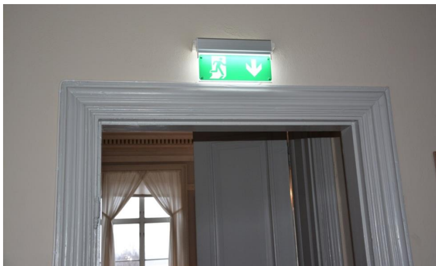
Belyst utrymningsskylt på plats i rum 317, (bibliotek). Bildnummer:Vlm_kvmeHW-1361.
