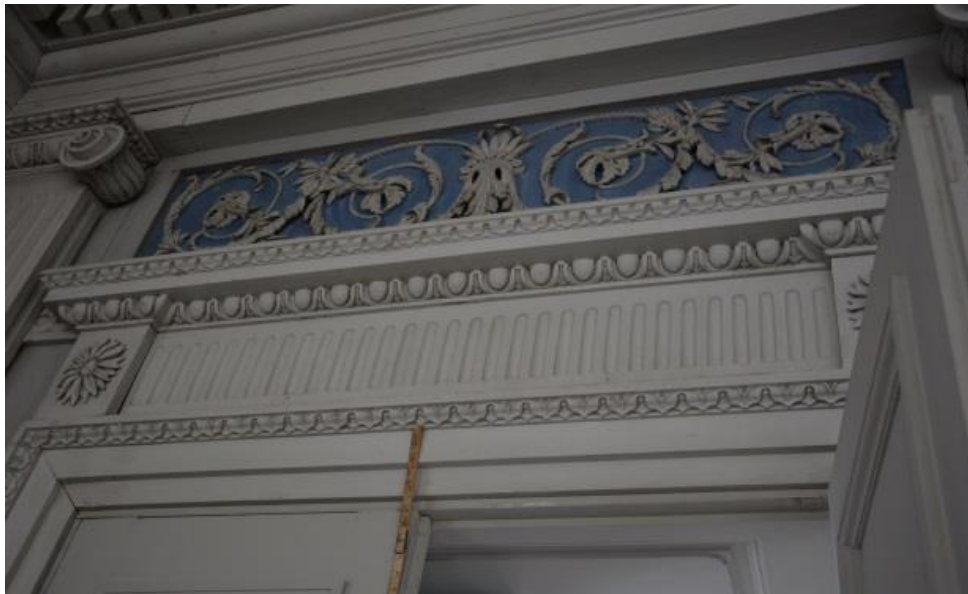
Uppmätning för placering av utrymningskylt. Bildnummer: Vlm_kmvEHW-970.
