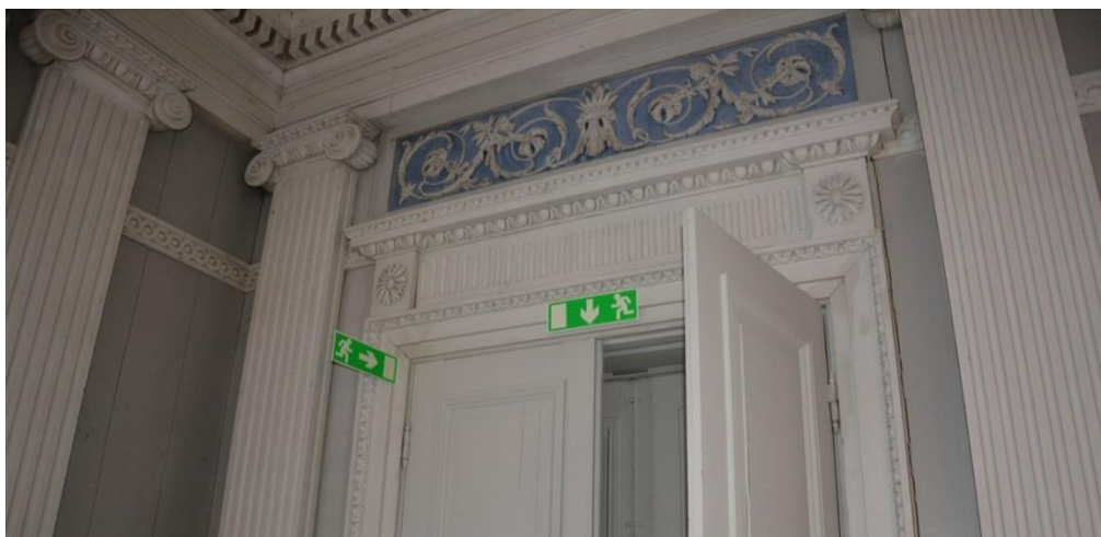
Utrymningskyltar på plats vid och ovan pardörr i Blå salongen. Bildnummer: Vlm_kmvEHW-1365
