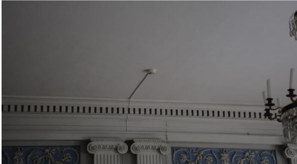
Befintlig rördetektor i blå salongen rum 305 före renovering. Bildnummer: Vlm_kmv-EHW-971.
