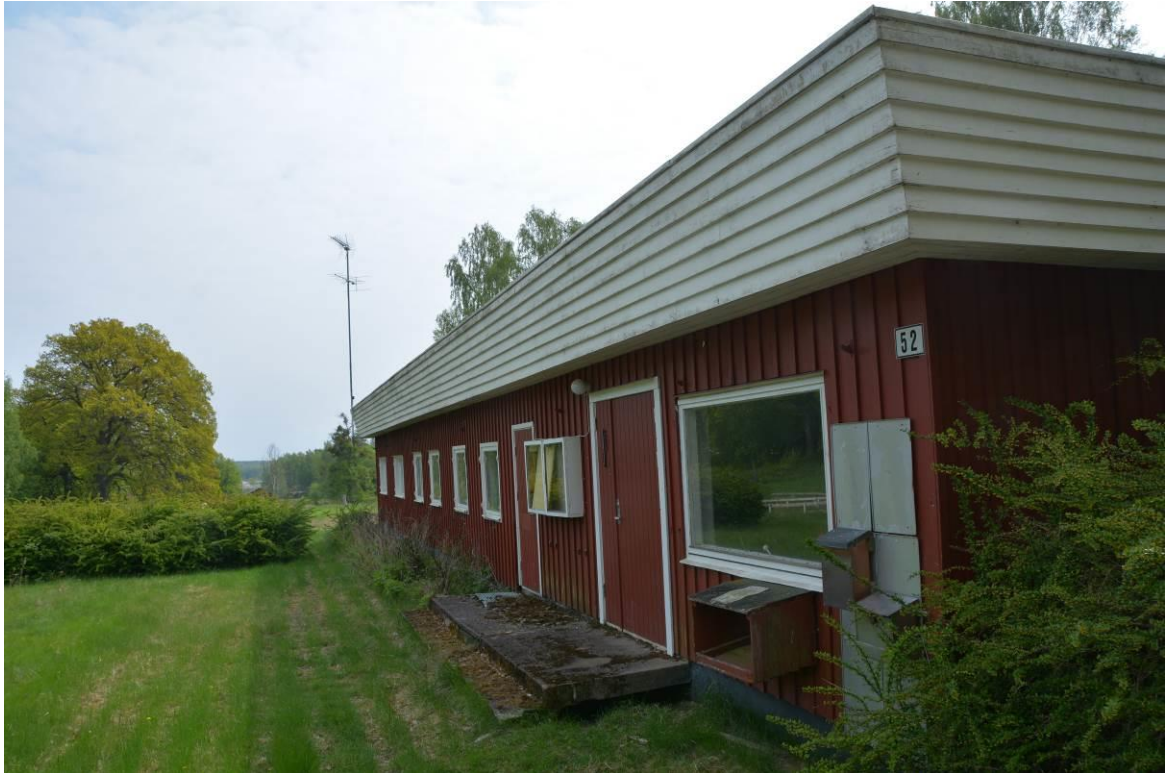
Centralanläggningen, som bär tydliga spår av en renovering i samband med Aseas 100-årsjubileum 1983. Det närmsta fönstret tjänade som matlucka under stugbyns glansdagar på 1950-talet. Bild: Vlm_kmvAF-829.
