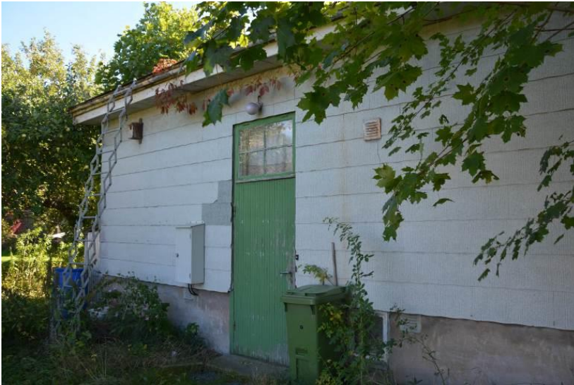
Bild 9: Villa med plant sadeltak som har ursprungsmaterialet siporexplattor bevarat.
