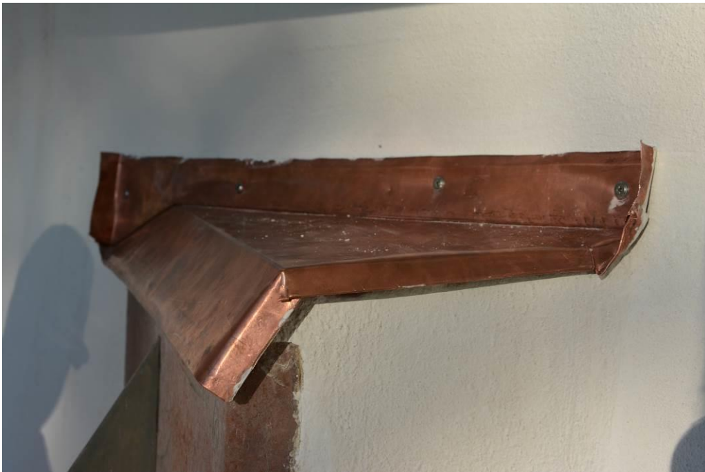
Soluret fick ett kopparbleck som ska hjälpa till med vattenavrinning.
