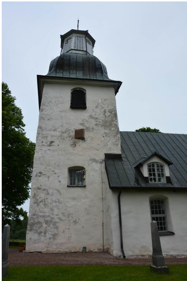
Södra fasaden innan åtgärder.
