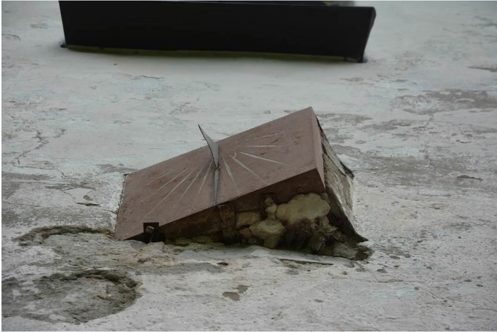
Soluret innan åtgärder. Dålig vattenavrinning hade medfört att bultar som höll soluret på plats hade roststat samt gett putsskador på fasaden.
