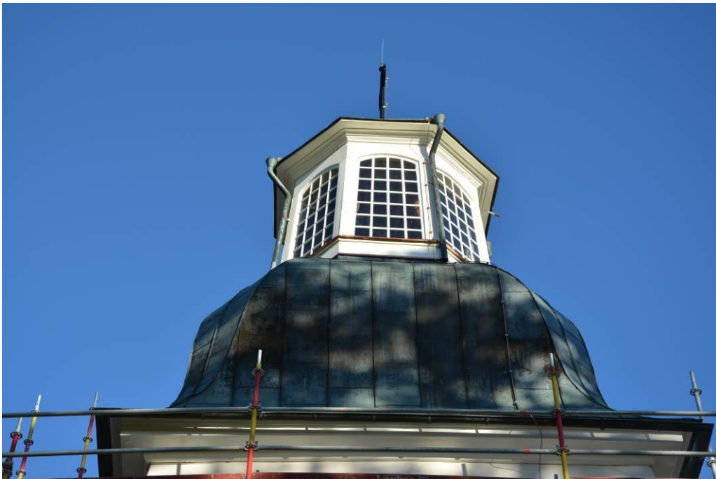
Lanterninen efter att arbetet var färdigt och ställningen nertagen. De nya kopparblecken under fönstren kommer mörkna i ton.
