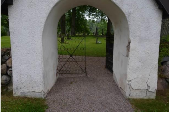
Stigluckan hade stora skador i puts och frostsprängda tegelstenar.
