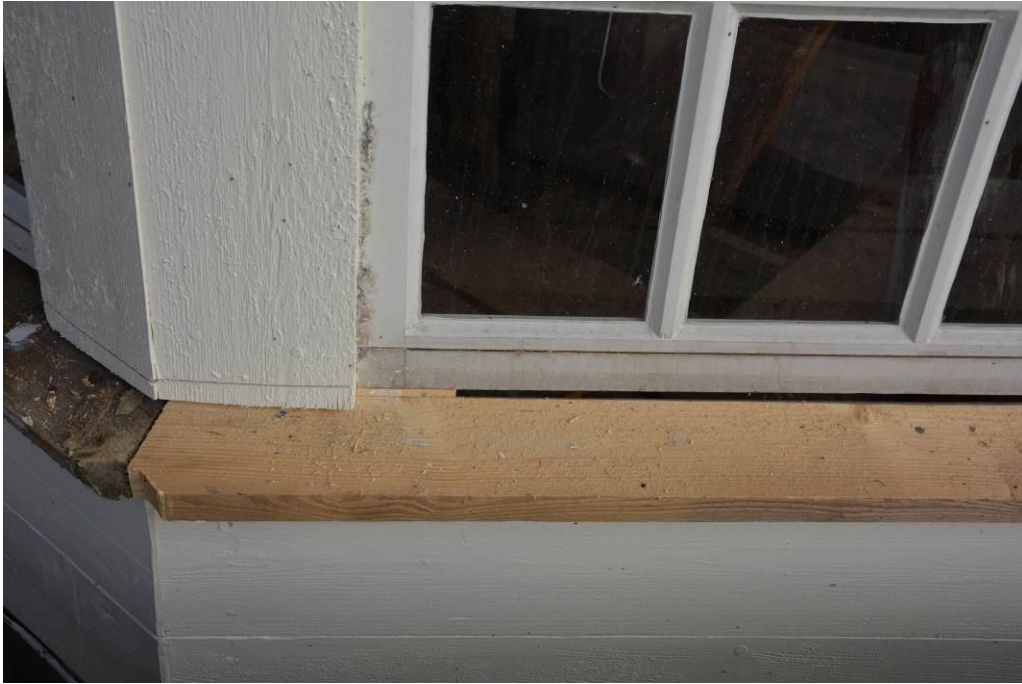
Nytt trämaterial kring lanterninens fönster. Vissa av fönsterbrädorna byttes och formen anpassades till de äldre bräderna.
