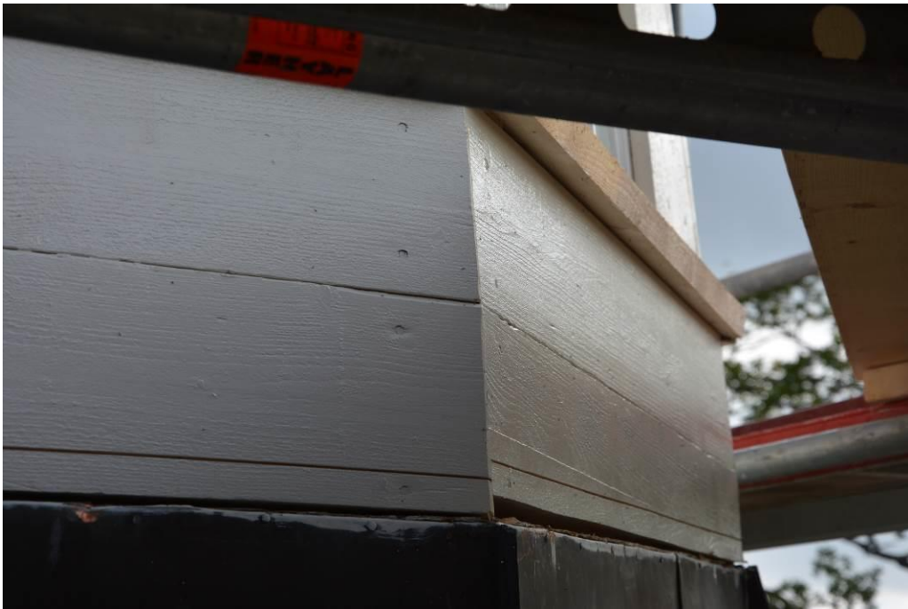
Panelen efter att den bytts ut.
