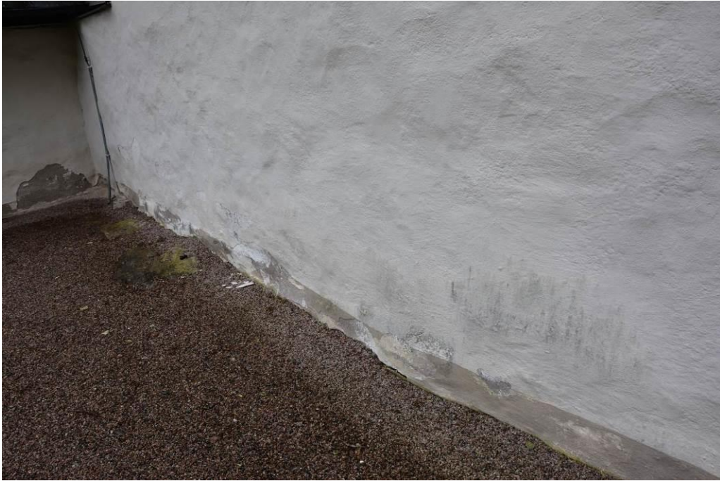
Runt hela fasaden fanns skador som uppkommit av att kalkputsen sugit upp fukt från marken.
