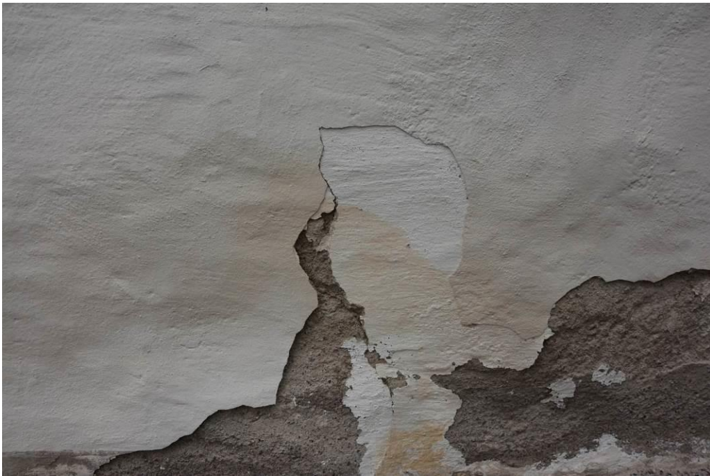
Putsbortfall på södra fasaden.
