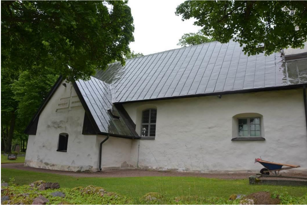
Norra fasaden och sakristians gavel innan åtgärder.
