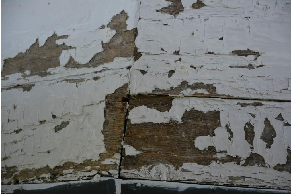
Träpanelen på lanterninen hade stora sprickor och vissa rötskador.
