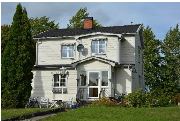
Villa, troligen 1930-tal, ombyggd under sent 1900-tal. BildID: Vlm_kviEHW-765.
