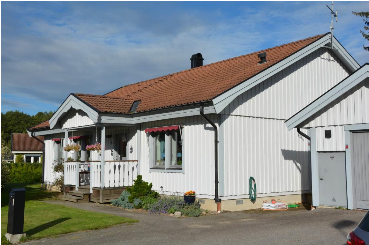
Bostadshus från 1980-talet med vitmålad panel och ljusgråa snickerier, farstukvist och sadeltak med rött betongtegel. Det friliggande garaget ligger något indraget. BildID: Vlm:kviAF-1129
