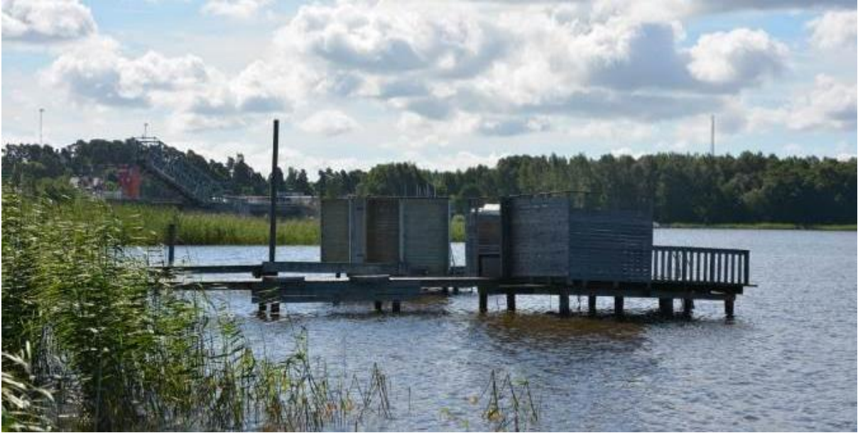
Bryggor med badhytter eller avskärningar. BildID: Vlm_kviSB-724
