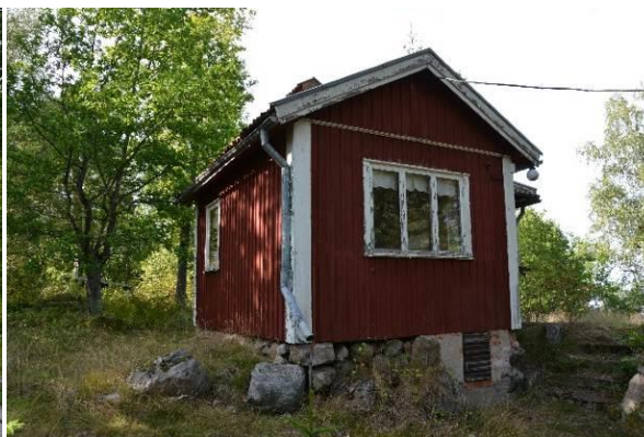
Ursprunglig sommarstuga från 1940-tal. BildID: Vlm_kviEHW-586
