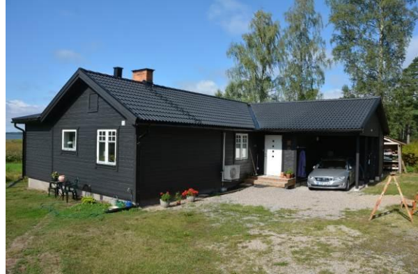
Sportstuga från 1930-talet, ombyggd under 2000-tal. BildID: Vlm_kviAF-699.
