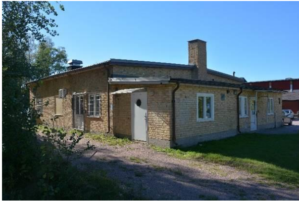
Äldre byggnad från Karlssons cementfabrik, uppförd med gult fasadtegel. BildID: Vlm_kviAF-1322.
