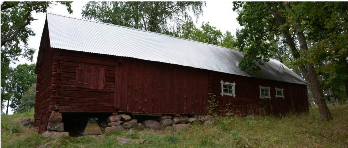
Ekonomibyggnad vid fiskarbostället, troligen från soldattorpet som låg där innan. Byggnaden är timrad och delvis klädd i stående, faluröd panel med vita snickerier. BildID: Vlm_kviEHW-530.
