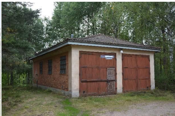
Äldre bussgarage. BildID: Vlm_kviEHW-770.
