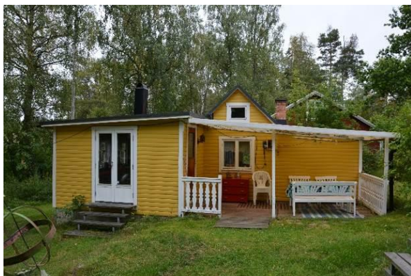
Ursprunglig sommarstuga från 1940-tal. BildID: Vlm_kviEHW-498
