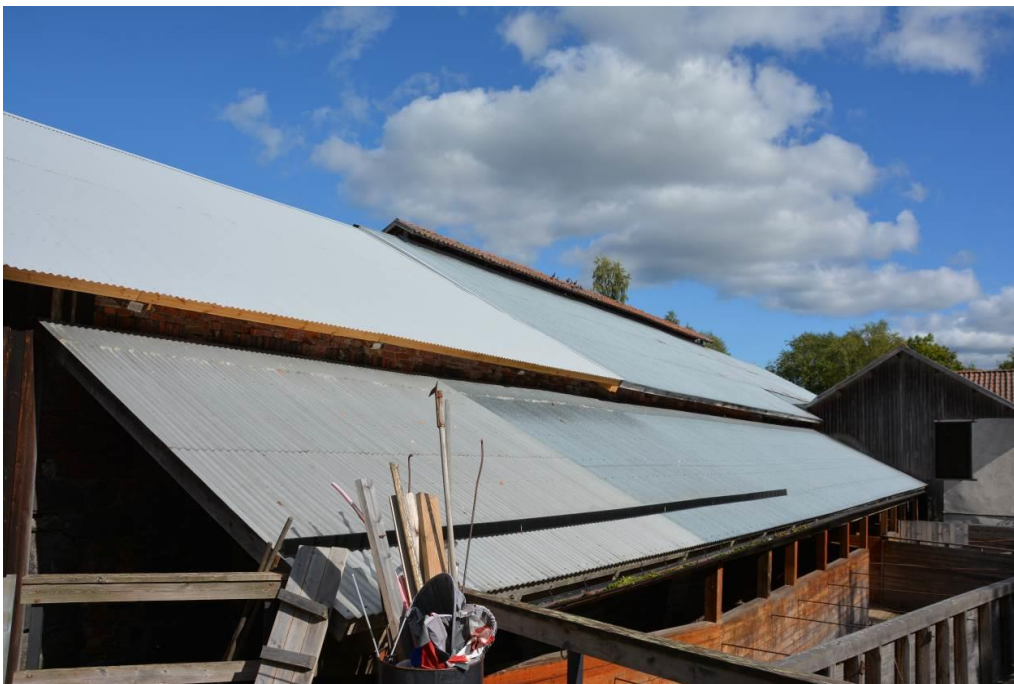
Ny plåt överst till vänster i bild. Plåt från renoveringen 1983 överst till höger. Nedre delen av taket är över vattenhjulen. Vlm_kmvSB-5971.
