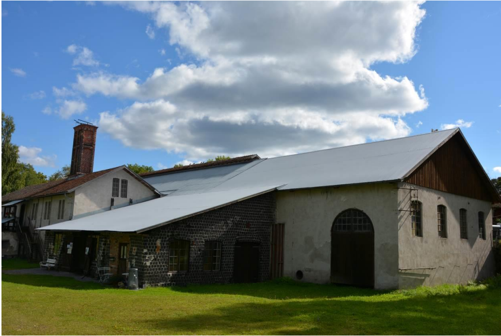
Det nylagda taket sett från norr. Vlm_kmvSB-5973.
