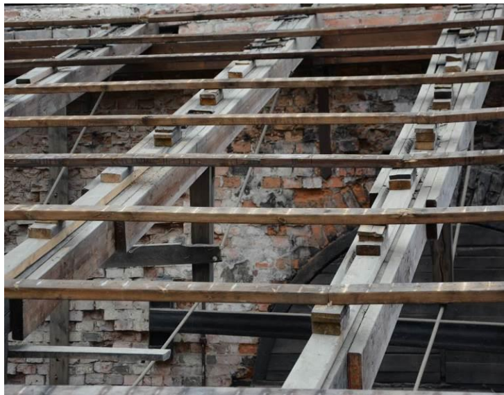
En provisorisk pelare monterades för att stötta upp takstolarna som visar på tidigare förstärkningar. Vlm_kmvSB-5908, -5914.
