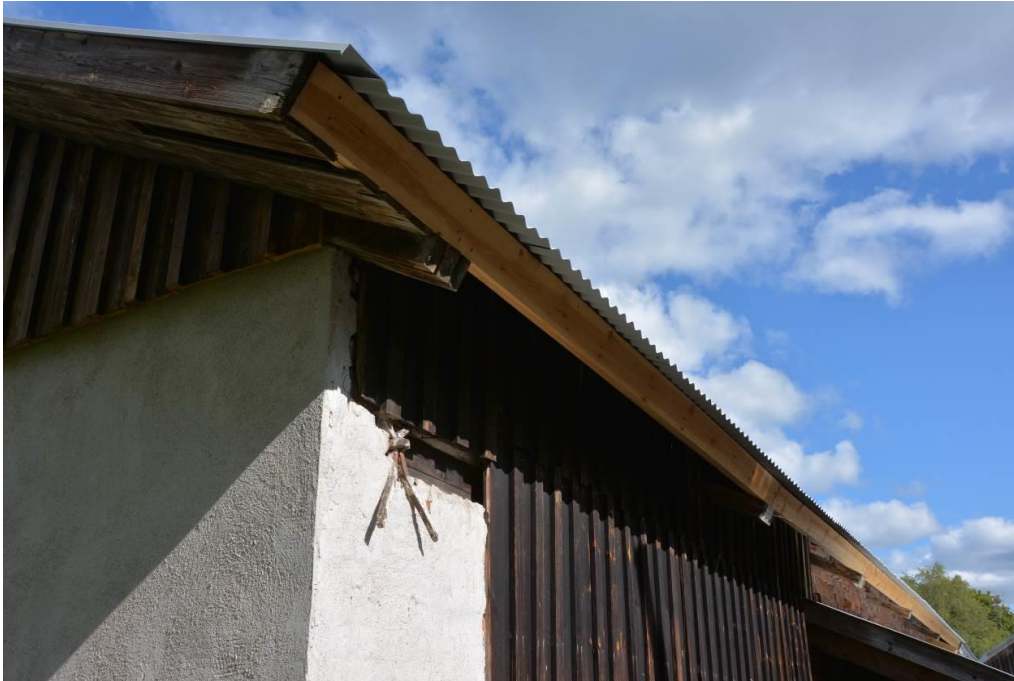
Detalj på ny panel till vänster och äldre panel till höger. Vlm_kmvSB-5970.
