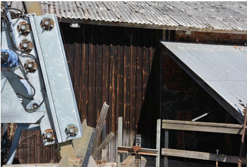
Nordvästra fasaden innan åtgärd. Fasaden var täckt med en locklistpanel som stod som förebild för den kommande täckningen av gavelröset. Vlm_kmvSB-5865.
