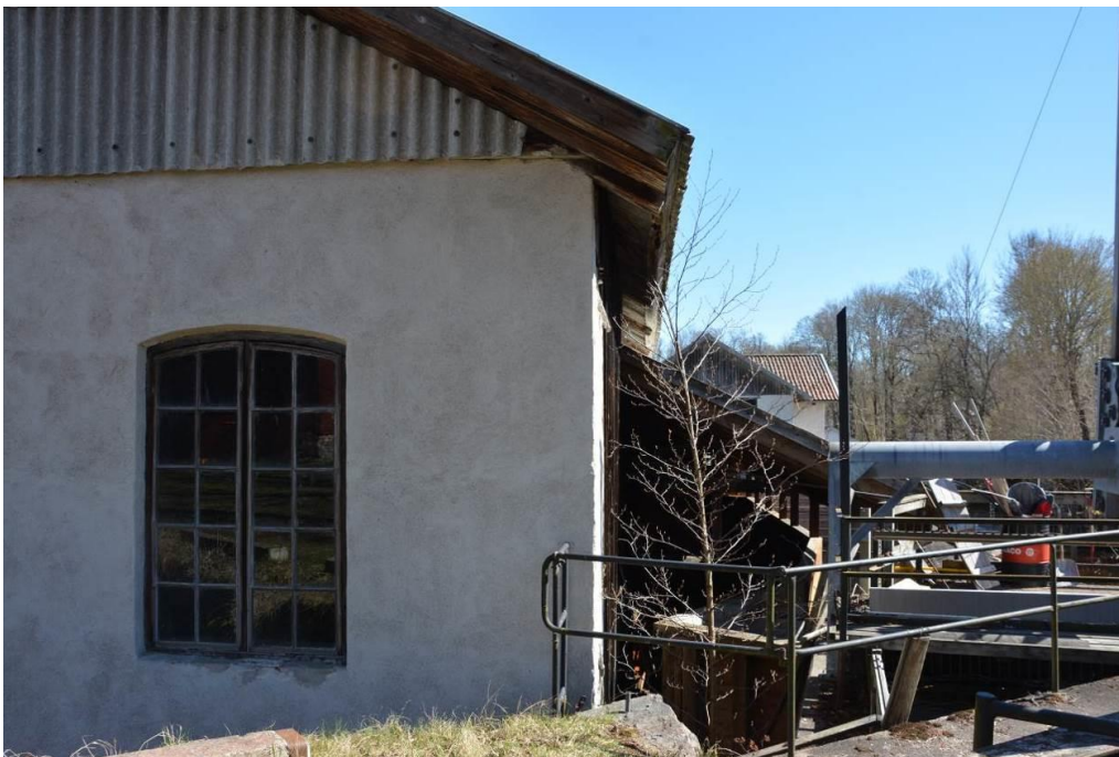
Nordvästra hörnet av smedjan med asbestplattor. Trädet togs ner i samband med arbetet. Vlm_kmvSB-5868.
