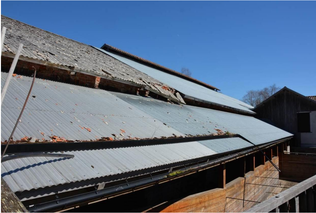
Taket med asbestplattor och galvaniserade plåt från renoveringen 1983. Vlm_kmvSB-5867
