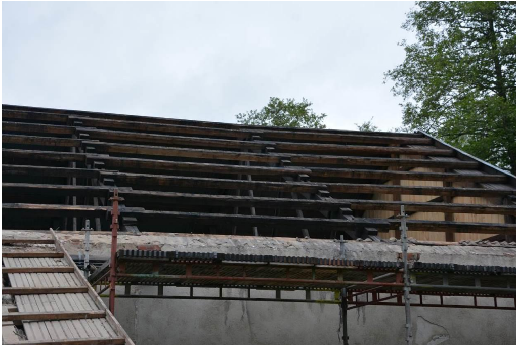
Plåten monterades på öppen läkt. Träkonstruktionen var i gott skick och behövde inte bytas ut. Vlm_kmvSB-5912
