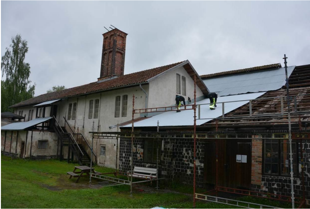
Östra inlastningsrummet med ny taktäckning under montering. Vlm_kmvSB-5909.
