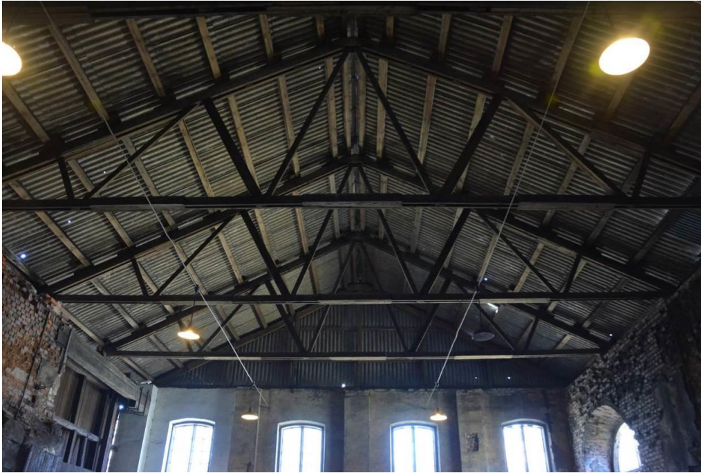
Interiör bild med taktäckning och gavelröset täckt med asbestplattor. Vlm_kmvSB-5861
