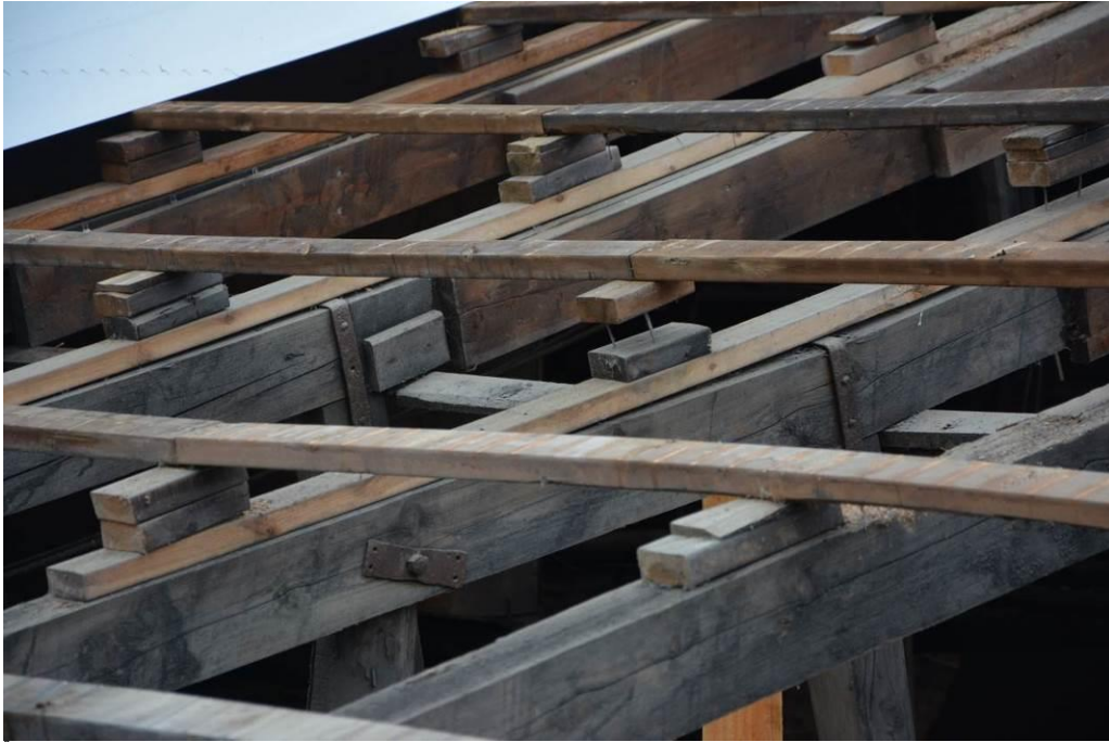
Åtgärder på takkonstruktionen över östra inlastningsrummet har gjorts tidigare och kompletterades under arbet 2017. Vlm_kmvSB-5913.
