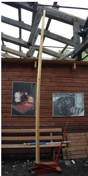
En provisorisk pelare monterades för att stötta upp takstolarna som visar på tidigare förstärkningar. Vlm_kmvSB-5908, -5914.
