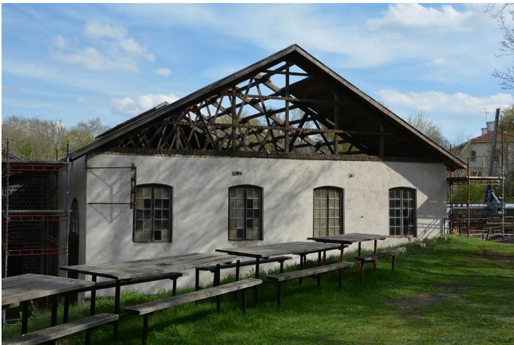
Samiliga plattor på tak och gavelröste nedmonterade och plåt pålagd på västra takfallet. Vlm_kmvVB-585.
