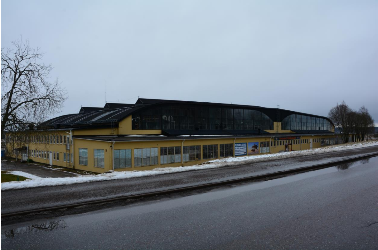
Bild 8. Hangarbyggnaden sedd från nordväst. Ursprungliga fönsterpartier i lägre byggnadsdel och i den övre som vetter in mot hangarrummet. Vlm-kmvVB-128.
