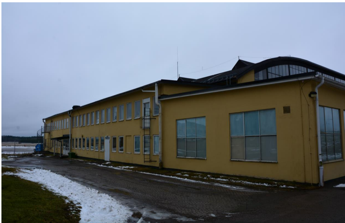
Bild 6. Hangarbyggnaden sedd från nordväst. Kontorslokal till vänster i bild och f.d. verkstadslokal till höger. Vlm-kmvVB-142.
