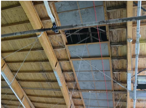
Bild 11 och 12. Hangarbyggnadens innertak som blivit utsatt för fukt till vänster och det lapplagade betonggolvet till höger. Vlm-kmvVB-681 Vlm-kmvVB-662.
