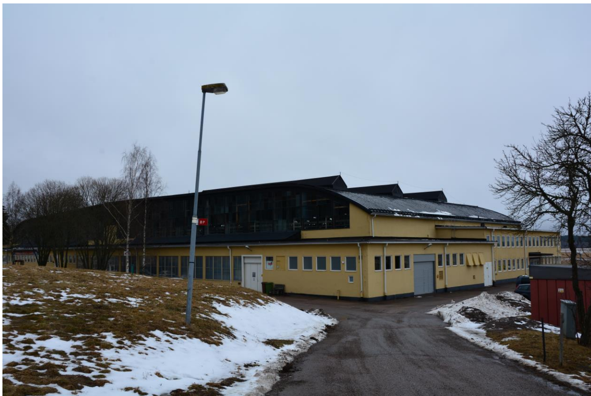
Bild 7. Hangarbyggnaden sedd från sydväst. Kontorslokaler till höger i bild och verkstadslokaler med ursprungliga fönsterpartier till vänster. Vlm-kmvVB-138.
