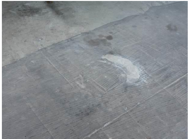
Bild 11 och 12. Hangarbyggnadens innertak som blivit utsatt för fukt till vänster och det lapplagade betonggolvet till höger. Vlm-kmvVB-681 Vlm-kmvVB-662.
