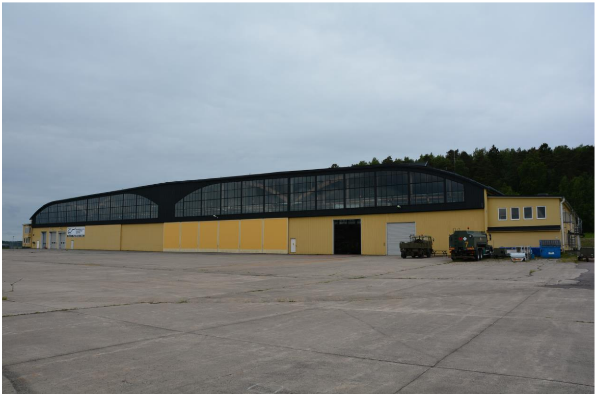
Bild 9. Hangarbyggnaden sedd från nordöst med hangarportarna som vetter ut mot flygfältet och startbanan. Vlm-kmvVB-685.
