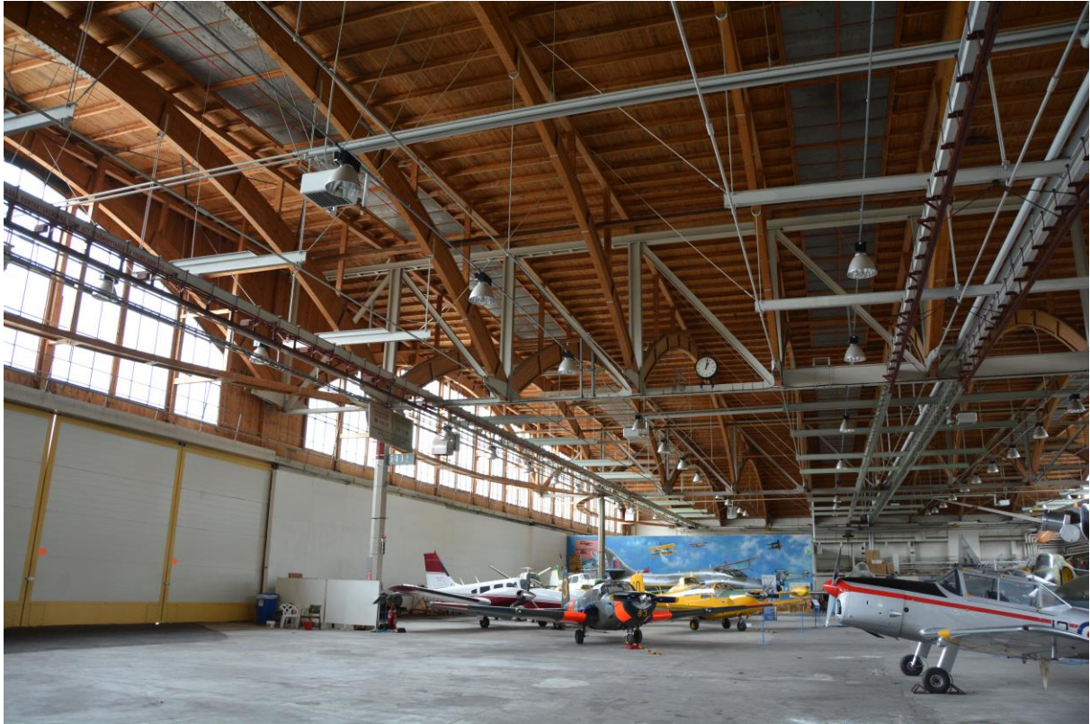
Bild 10. Hangarbyggnadens takkonstruktion med fackverk och limträbalkar. Vlm-kmvVB-657.
