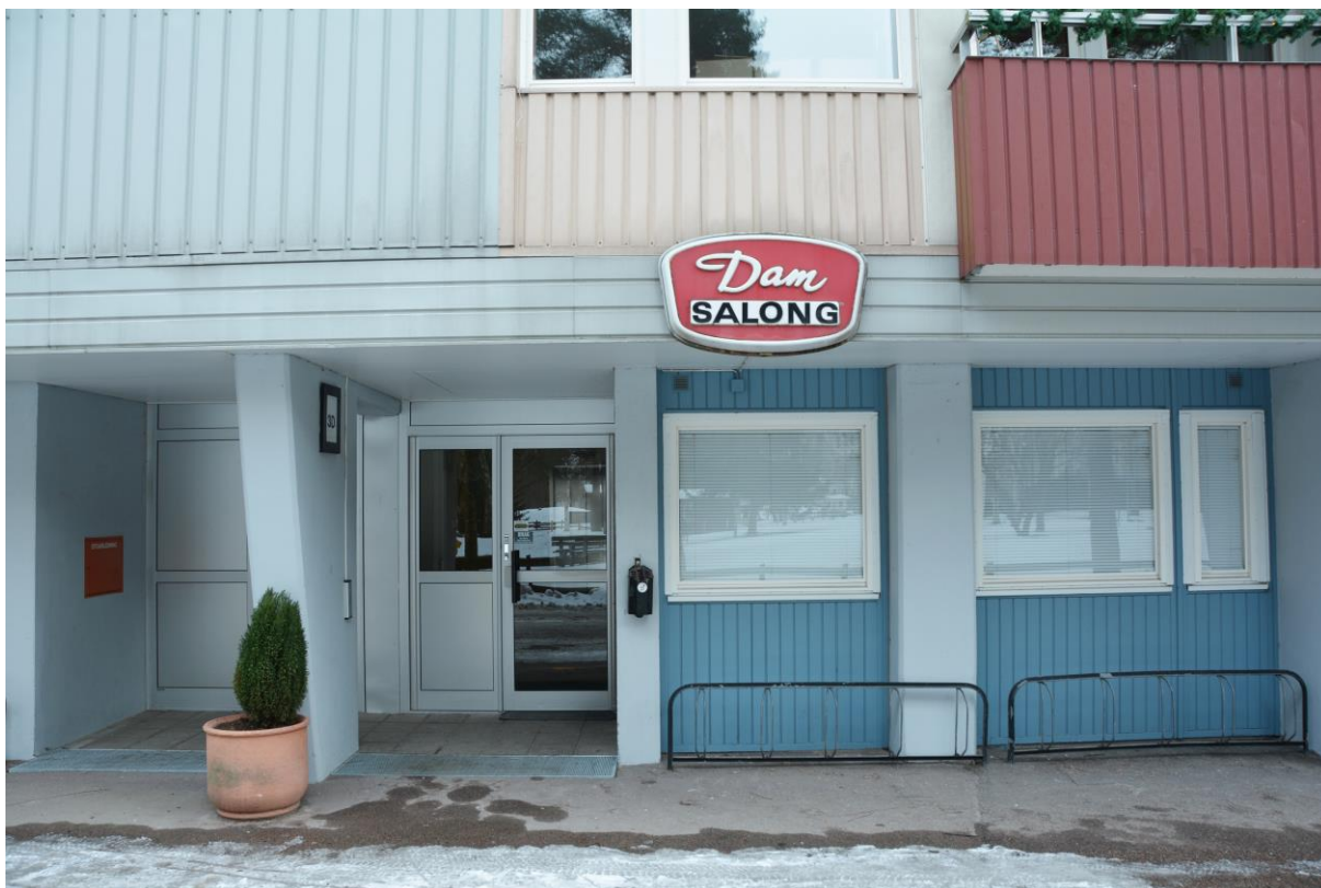
I sockelvåningen på skivhuset fanns förr bl.a. en frisersalong. Vissa delar är panelade och målade i en blå kulör. Vlm-kmvb-1130.
