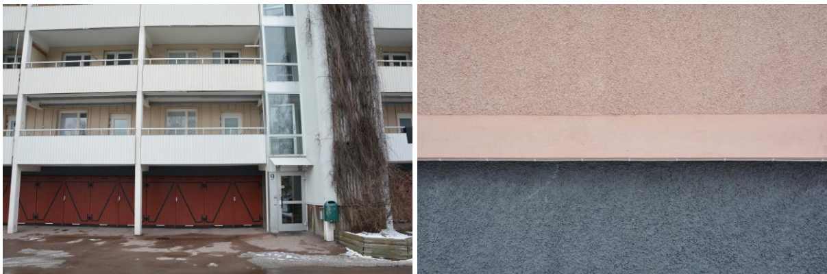
T.v. På varannan våning finns loftgångar och varannan finns balkonger. I sockelvåningen finns röda garageportar. Vlm-kmvvb-1099.
