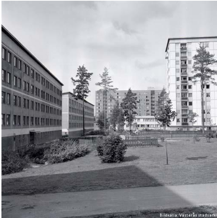
Östra Malmaberg växte fram i mitten på 1950-talet. Loftgångshuset till vänster i bild hade fältindelad fasad, och punkthusen, varav ett till höger i bild, hade fasad med vita klinkerplattor. Källa: Västerås stadsarkiv, AVL2180.
