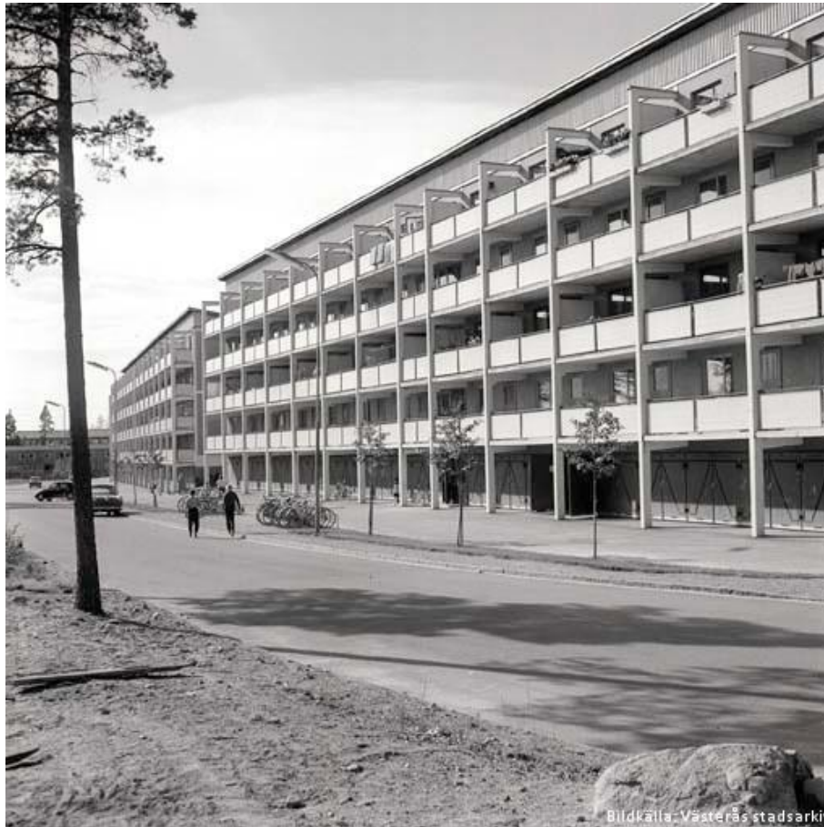
Lägenheterna i loftgångshusen inom Trädkronan 1 har två våningar, vilket resulterar i att varje lägenhet har en våning med loftgång och en våning med balkong. Källa: Västerås stadsarkiv, AVL1583.
