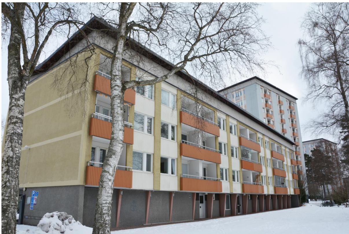
En av de två lamellhusstyperna har gröngul puts, orangea balkonger, vita plåtpartier vid fönstren och rosa snedskurna betongfundament mot den grå grovputsade sockelväningen. Vlm-kmvvb-1005.
