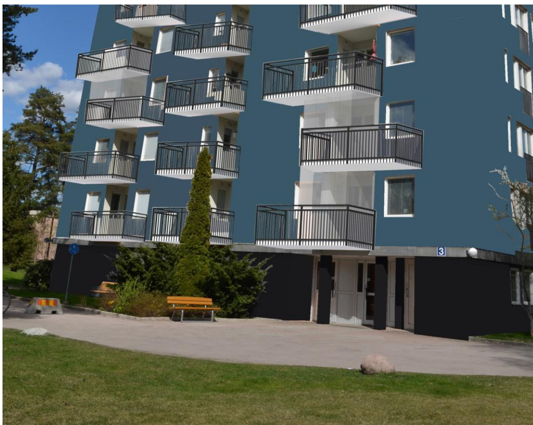
Förslaget till utbyggda balkonger, nya balkongfronter och ny fasadkulör på punkthusen inom Barrträdet 1 och Trädkronan 2. Utdrag från: Balkongrenovering. Brf. Kolarhagen, Anders Holmberg arkitekter, 170616.
