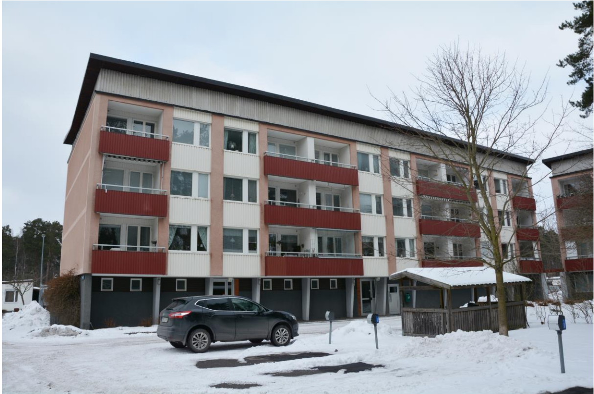
Lamellhus i röd/rosa spritputsad fasad och slätputsade konturer. De indragna balkongerna är klädda med röd trapetskorrugerad plåt. Vlm-kmvvb-1026.
