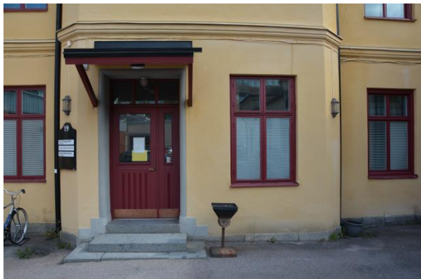
Entrédörr efter renovering. vlm-kmrvb-912.
