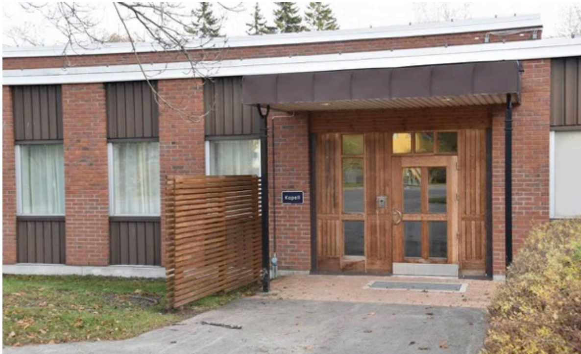
Bild 11. Kapellet i rött tegel och fönsterbröstningar i trapetskorrigerad plåt. BildID: vlm-kmvca-0234
