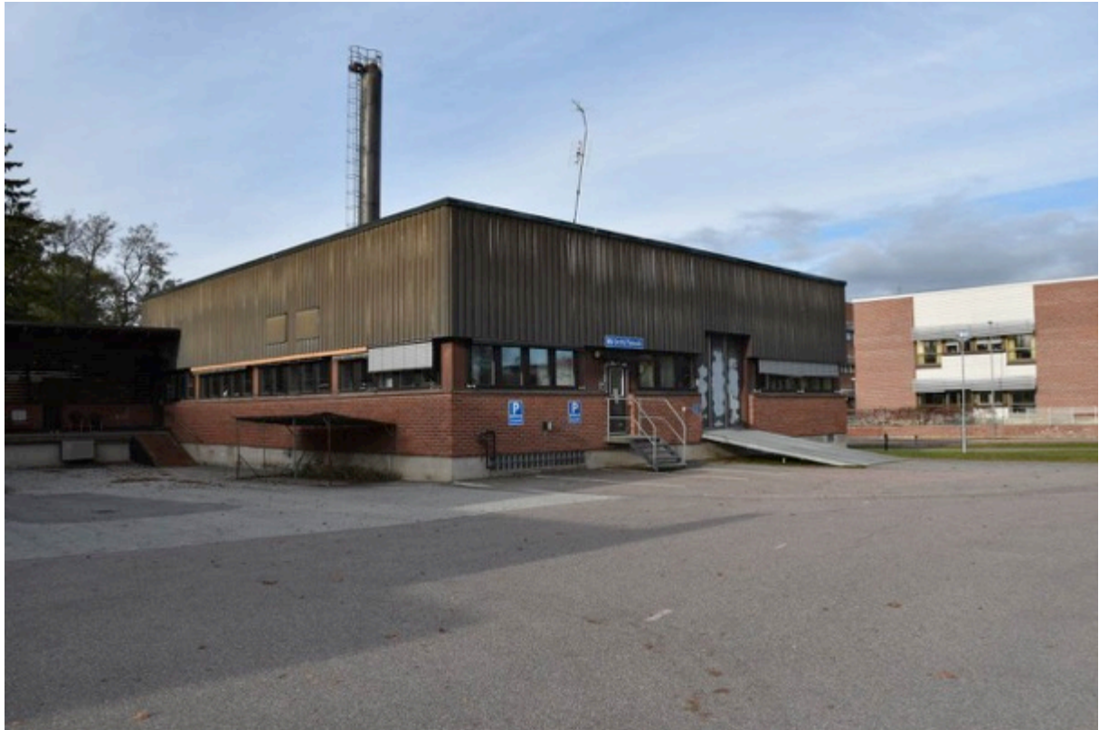
Bild 24. Panncentralen (Driftens lokaler), samspelar arkitektoniskt med matsalsbyggnaden. BildID: vlm-kmvca-0171
