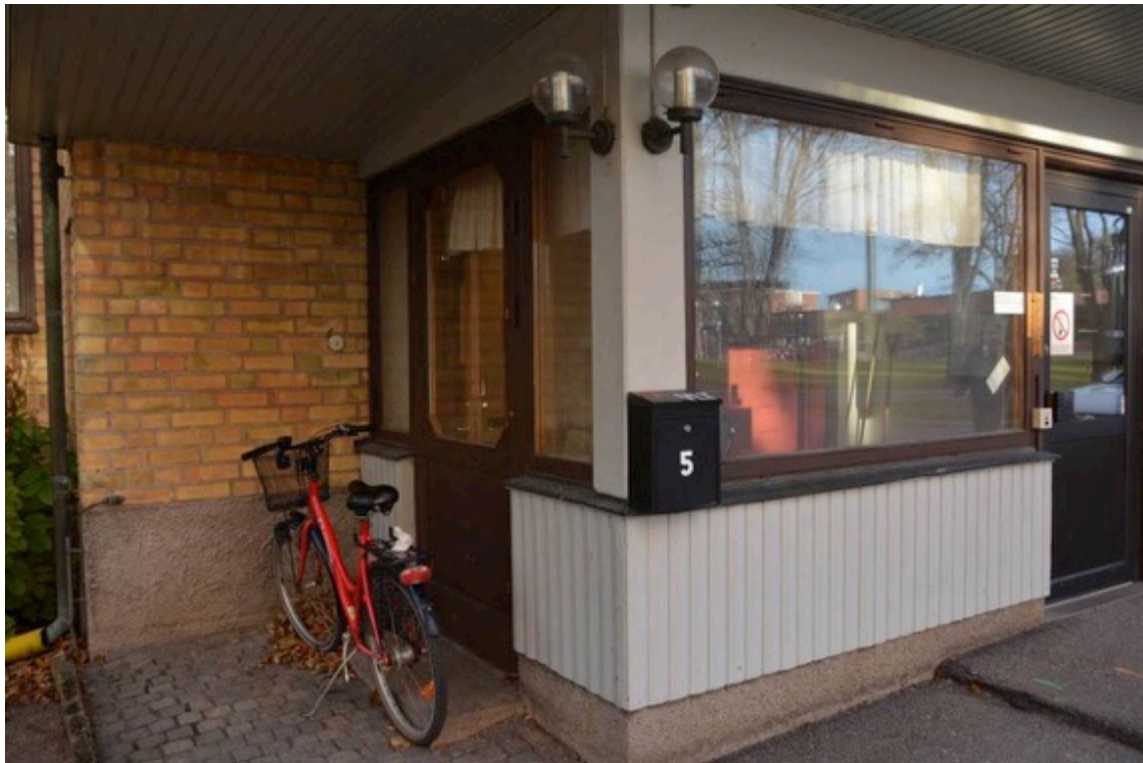
Bild 32. Entrépartiet, lägg märke till att gaveln fortfarande bevarar ursprunglig glasad trädörr. BildID: vlm-kmvca-0343
