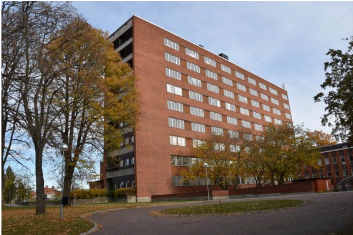
Bild 7. Sala sjukhus södra fasad och västra gavel. BildID: vlm-kmvca-0186
