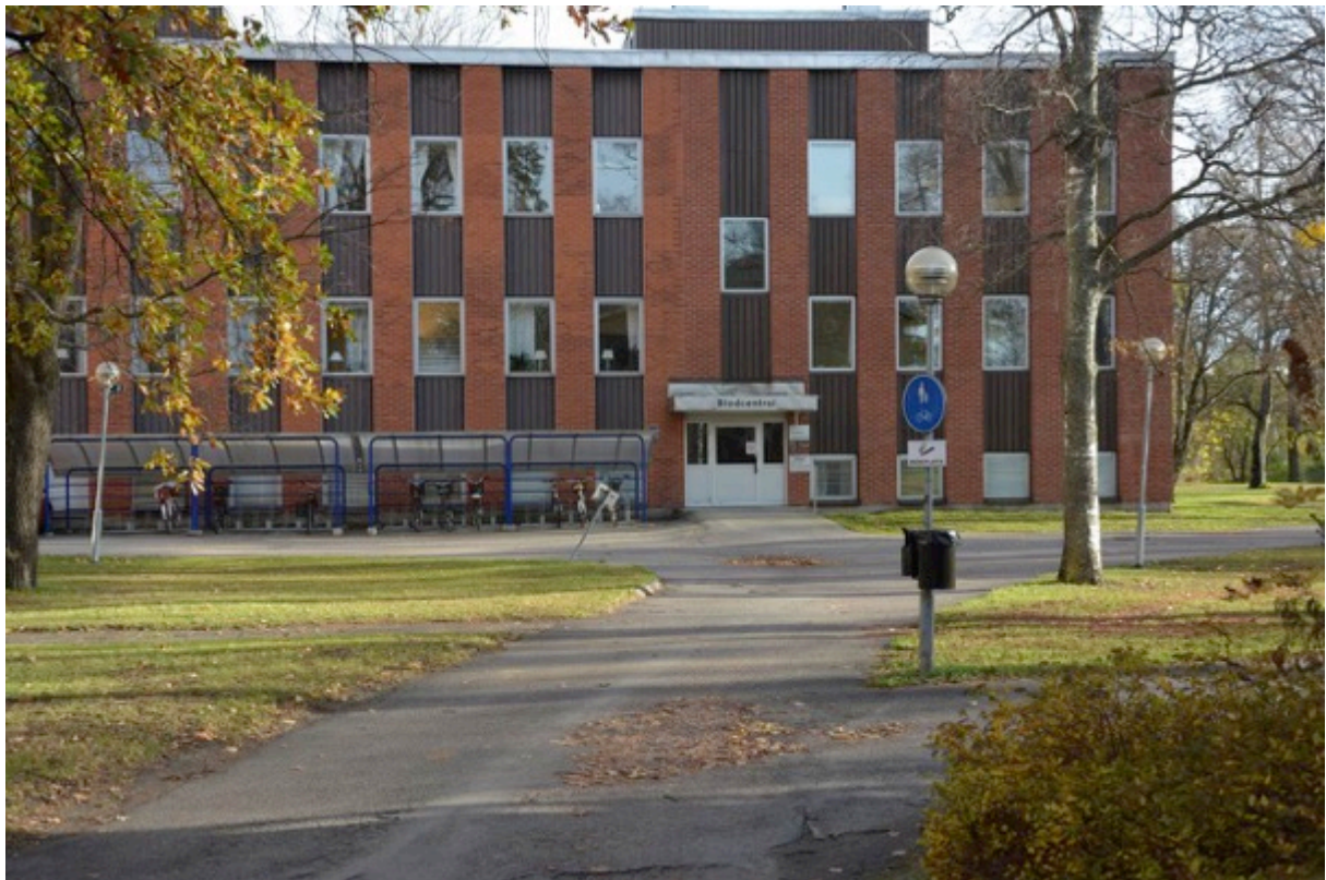
Bild 9. Låghusdelen karaktäriseras av enluftsfönster i aluminium, med fönsterbröstningar i trapetskorrigerad plåt. Plåtpartierna binder samman fönstren vertikalt. Mellan fönstren har fasaden lisener i rött tegel. BildID: vlm-kmvca-0346
