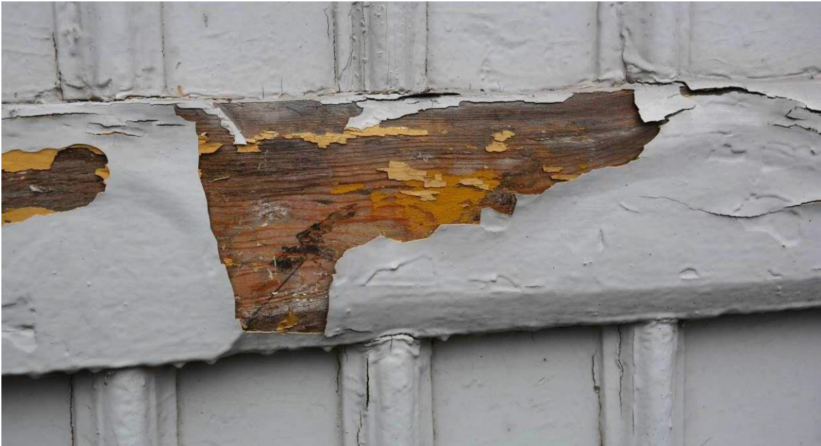
Bild 6 Liggande bred panelbräda har färglagren klargul och ljusgul. Vlm_kmvEK-725.
