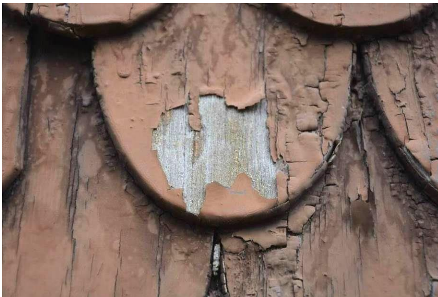
Bild 10 Linoljefärg i ockra nyans kan ses under den bruna plastfärgen. Vlm_kmvEK-736.
