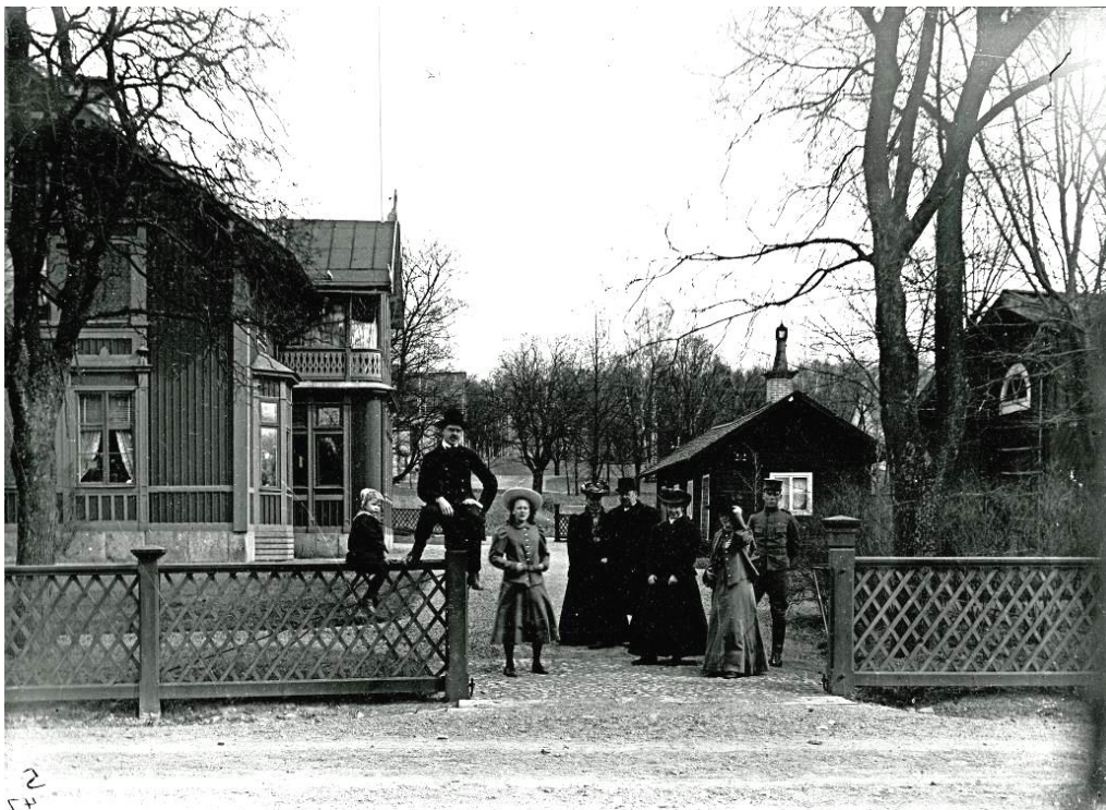
Bild 15 Mörk färgsättning på fasaden, antingen svartbrun eller röd. Snickerier har en ljusare kulör, antingen grå eller rödbrun. Källa: Digitalt Museum.
