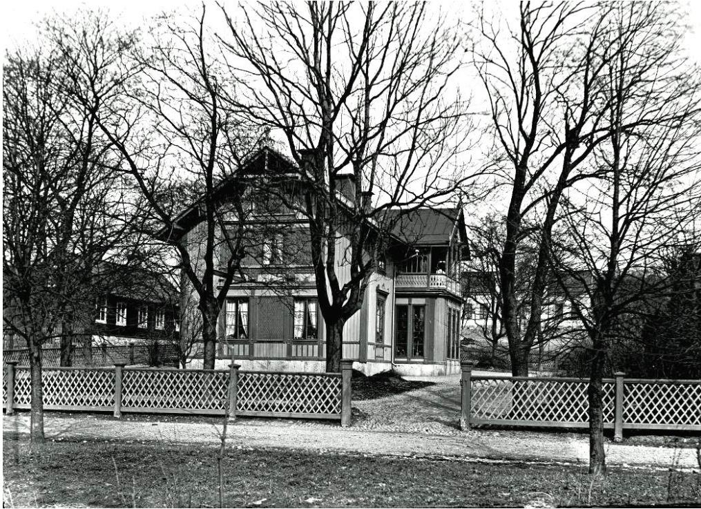
Bild 16 Fasaden i en ljus kulör, troligen ljusgul. Snickerier i mörkare kulör än fasaden, troligen ockrafärgade. Verandaräcke i vit kulör. Källa: digitalt museum.
