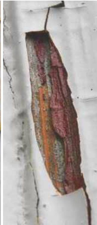
Bild 5 Färglagret engelskt rött följt av en ljus gul kulör hittades på en locklist på den norra fasaden. Vlm_kmvEK-726.
