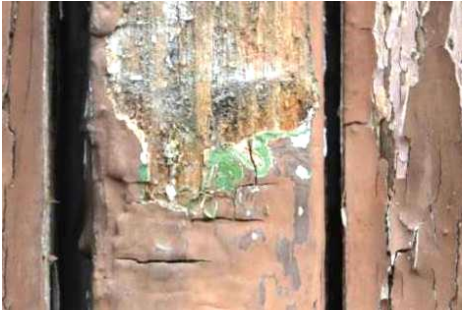
Bild 9 Äldre fönster med färgskikten mossgrön och gammelrosa. Vlm_kmvEK-760.
