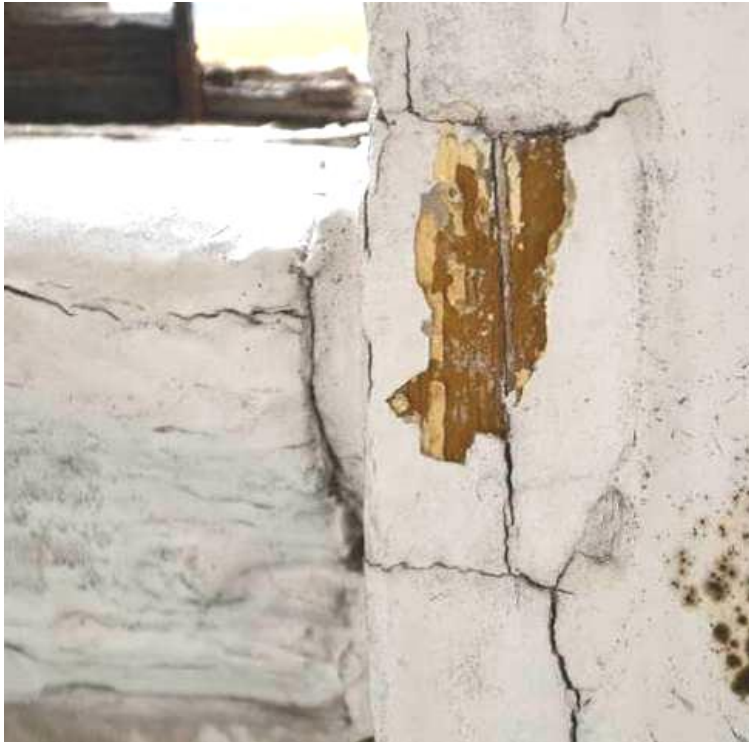
Bild 11 Färglagren ockra, ljusgul och grå. Vlm_kmvEK-745.
