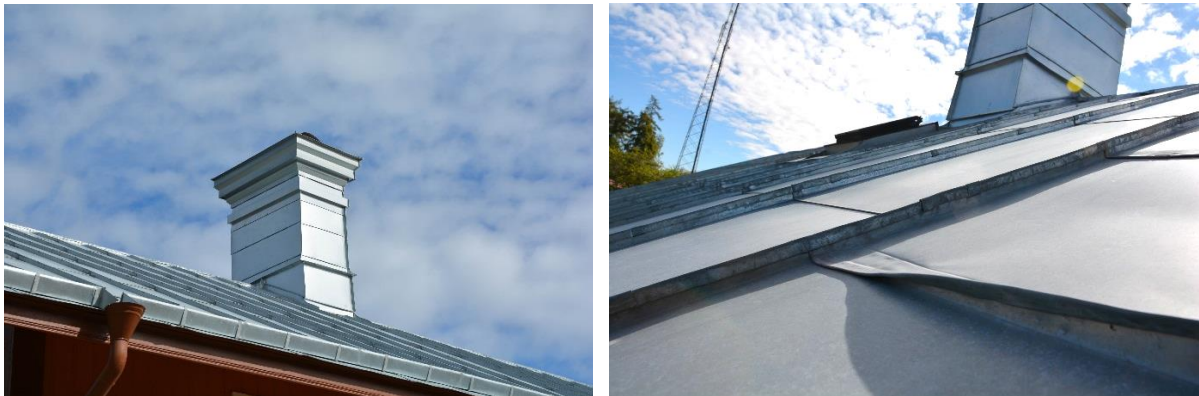
T. v: Det omålade taket med skorsten från södra sidan. Bild-ID: vlm-kmvcm-0008.
