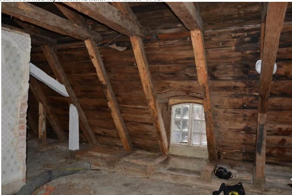
Synlig träkonstruktion efter demontering. Bildid: vlm-kmvsb-6703.
