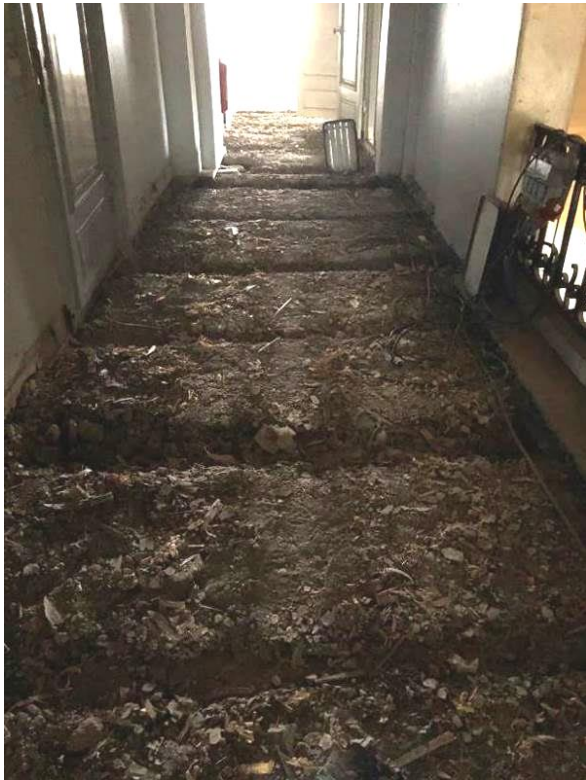
T.v: Golvet med dess fyllning som bestod av grus, sand, näver och träbitar. T.h: Skador i det underliggande bjälklaget. Bildid: vlm-kmvsb-6439, -6921..
