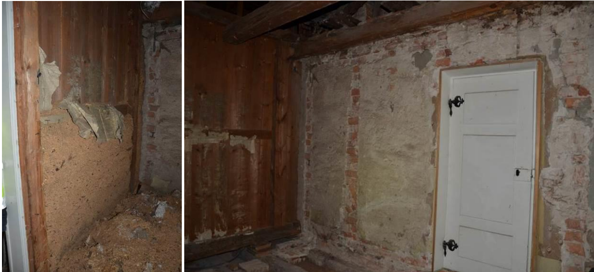
T.v: Plankväggarna var fyllda med sågspån och tidningspapper. T.h: Den murade väggen och dörren in till rum 302. Bildid: vlmkmvsb-6498,- 6708.
