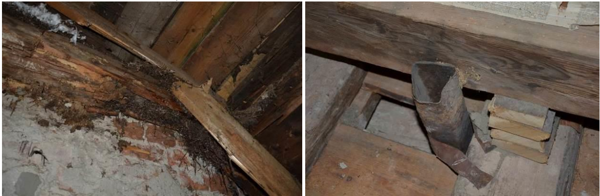
T.v: Skador i takkonstruktionen. T.h: Rör mellan våningsplanen. Bildid: vlmkmvsb-6502, -6707.
