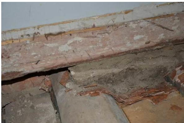
T.v: Rester av packningen under golvbrädorna i korridoren. Underst ett lager med näver. T.h: Blottlagt golvkonstruktion. Bildid: vlm-kmvsb-6552,-6815.
