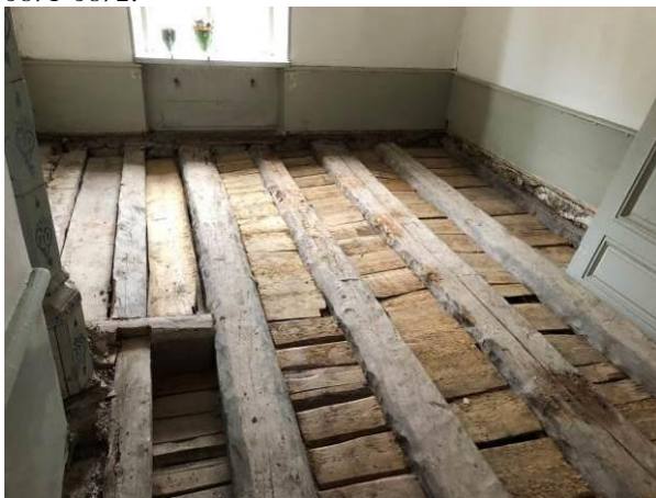
T.v: Rum 313 med blottlagd golvkonstruktion. T.h: Rum 314 med blottlagd golvkonstruktion. Bildid: vlm-kmvsb-6928-29.
