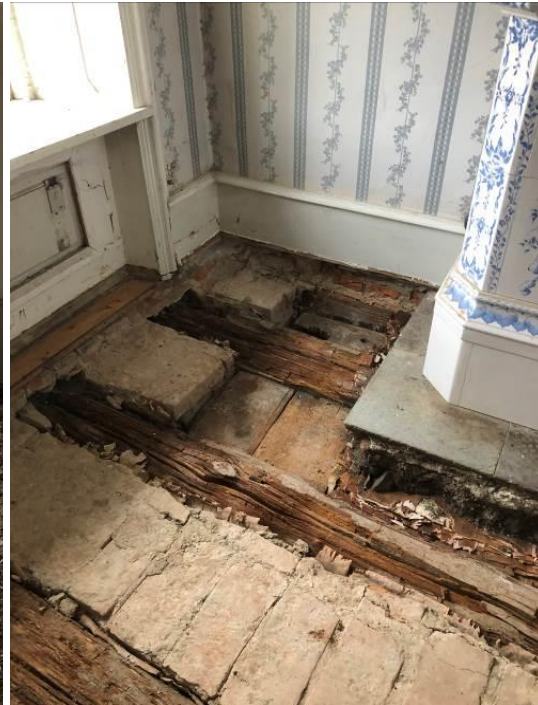
T.v: Fyllningen i rum 302. T.h: En skada i bjälklaget upptäcktes. Bildid: vlm-kmvsb-6872, - 6923.
