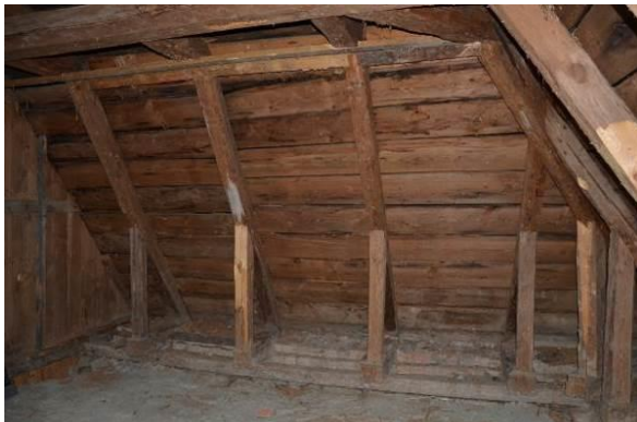
T.v: Blottlagd träkonstruktion under tak mot öst. T.h: Murstock med sentida hål för kamin/vedspis. Bildid: vlmkmvsb-6696, -98.
