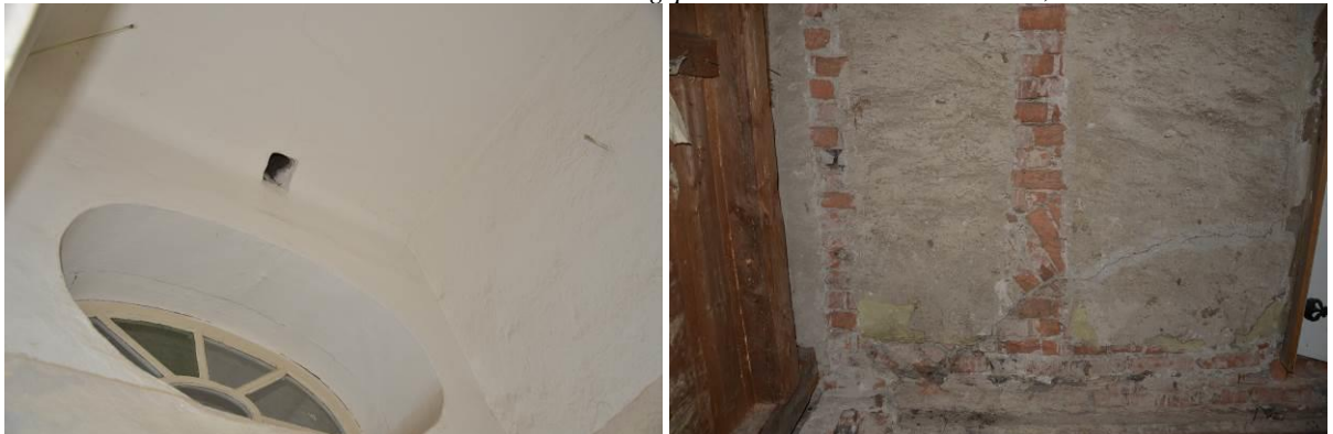
T.v: Plan 1 där röret mynnar ut. T.h: Valv i väggen mot rum 302. Bildid: vlmkmvsb-6716,-13.
