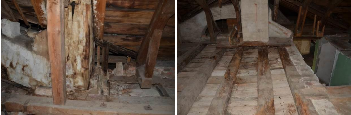
T.v: Skador på stockar i anslutning till murstock. T.h: Skador på takbjälkar. Bildid: vlm-kmvsb-6735,37.
