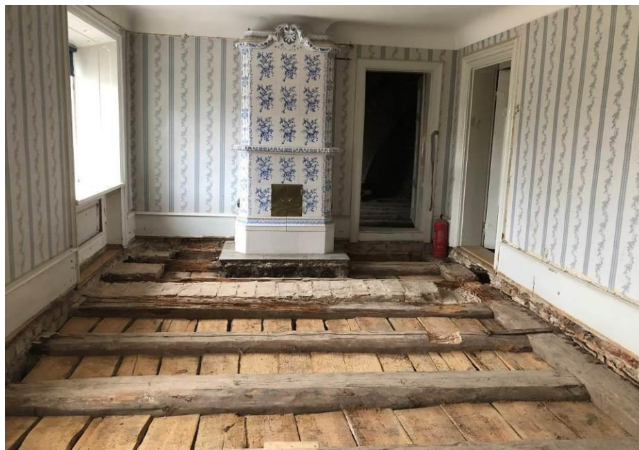
Blottlagd golvkonstruktion i rum 302. Bildid: vlm-kmvsb-6926.
