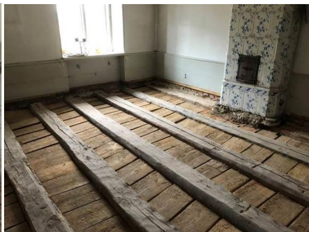
T.v: Rum 313 med blottlagd golvkonstruktion. T.h: Rum 314 med blottlagd golvkonstruktion. Bildid: vlm-kmvsb-6928-29.
