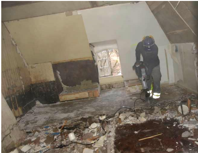
T.v: Badrummets golv bilades bort. T.h: Murad kanel ner till kök. Bildid: vlm-kmvsb-6524,- 6860.
