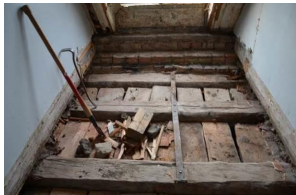
T.v: Rester av packningen under golvbrädorna i korridoren. Underst ett lager med näver. T.h: Blottlagt golvkonstruktion. Bildid: vlm-kmvsb-6552,-6815.
