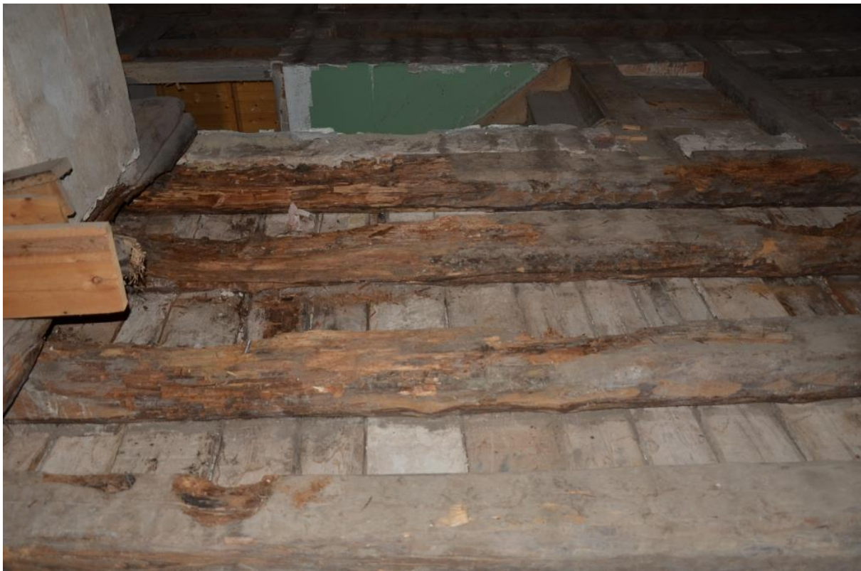
Skador på bjälklag, samma som bild ovan till höger. Bildid: vlm-kmvsb-6741.
