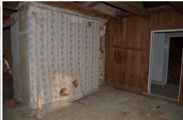
T.v: Blottlagd träkonstruktion under tak mot öst. T.h: Murstock med sentida hål för kamin/vedspis. Bildid: vlmkmvsb-6696, -98.
