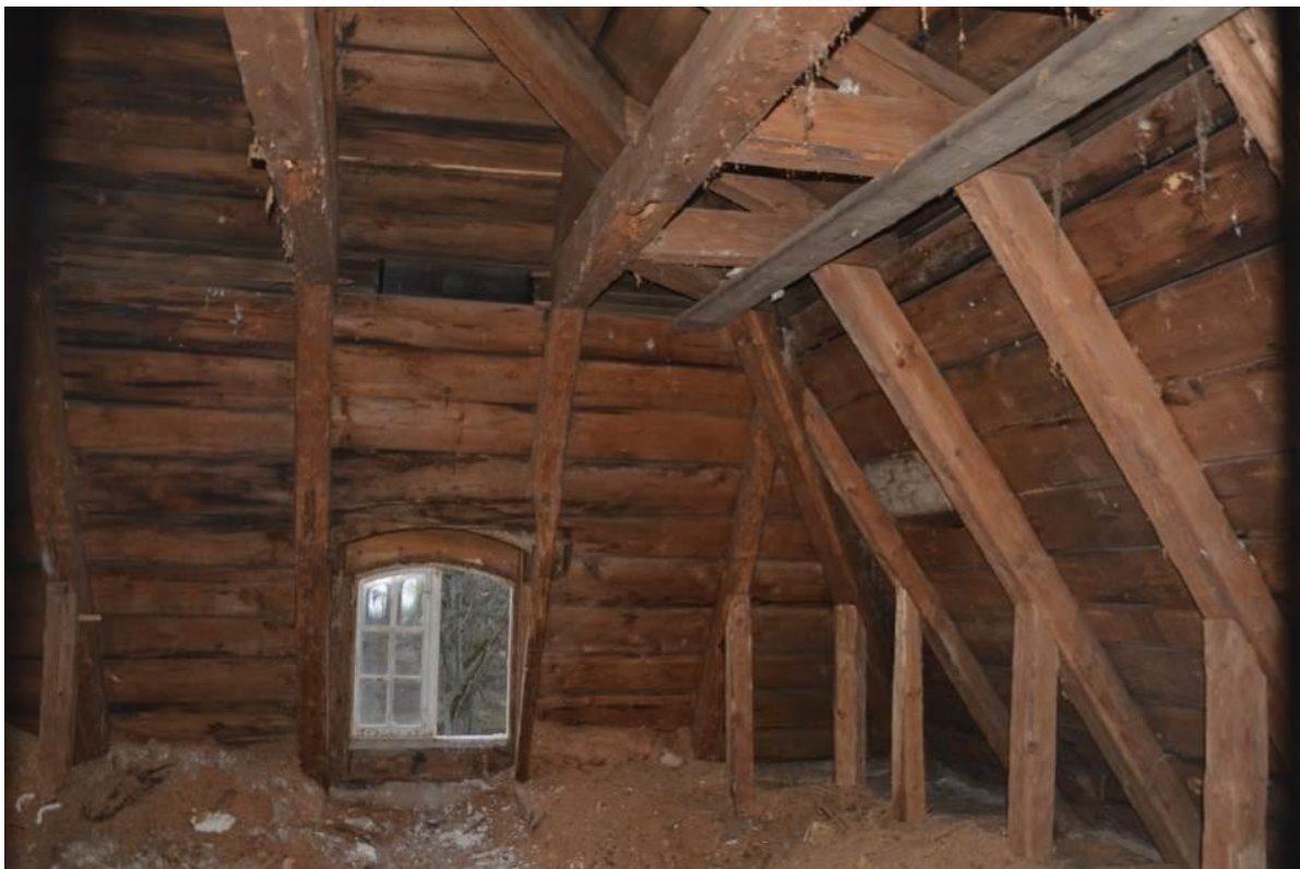
Rummet med väggarnas sågspånsfyllning nerriven. Bildid: vlmkmvsb-6511.
