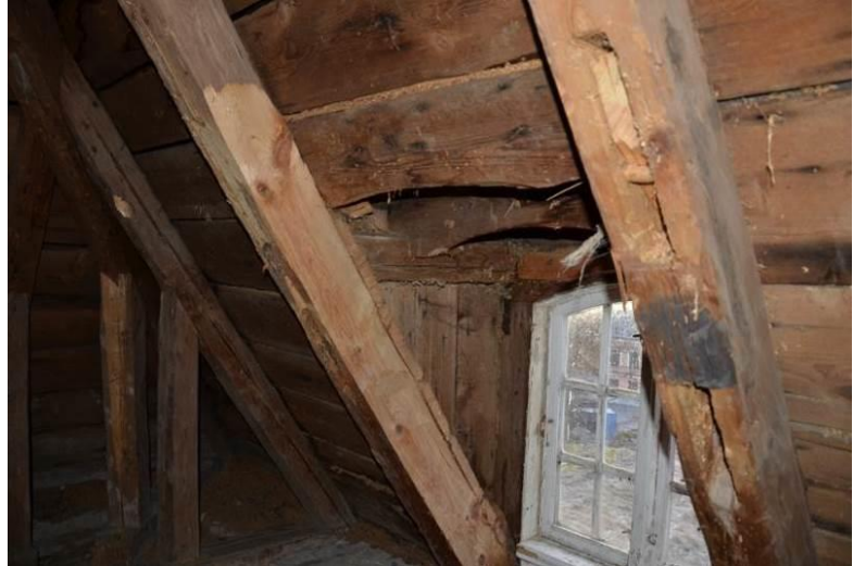
T.v: Fönsterbågar som fanns i rummet innan rivning. T.h: Bakomliggande träkonstruktion var i bra skick. Bildid: vlmkmvsb-6486, -95.
