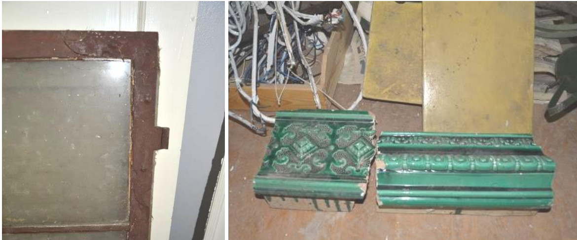
T.v: Ett fönster hittades vid rivningen. T.h: Delar till rivna kakelugnar. Bildid: vlm-kmvsb-6527, -37
