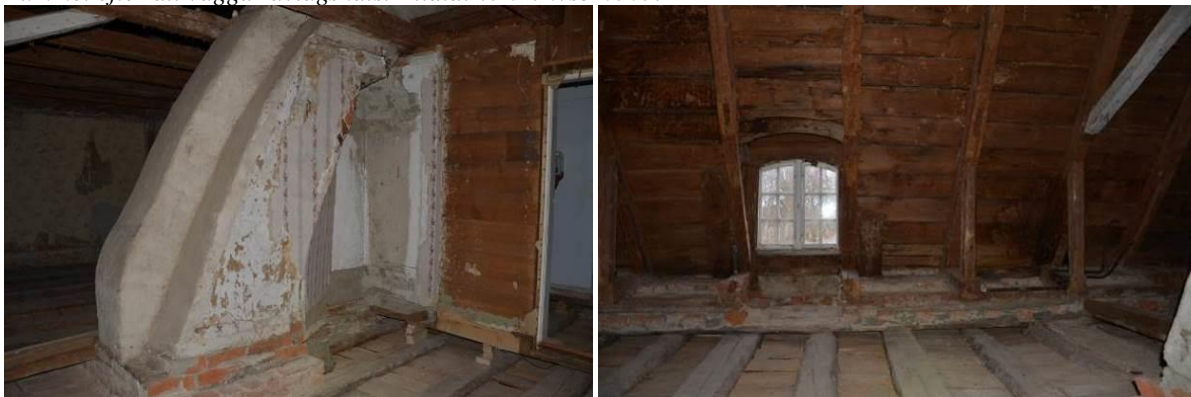
T.v: Röckanal och platsen där det tidigare stått en kakelugn. T.h: Blottlagt golvbjälklag. Bildid: vlmkmvsb-6723, -26
