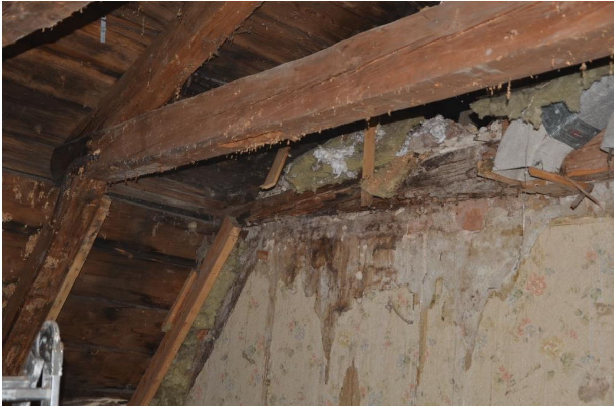
Skador på ovanliggande bjälk. Bildid: vlmkmvsb-6994
