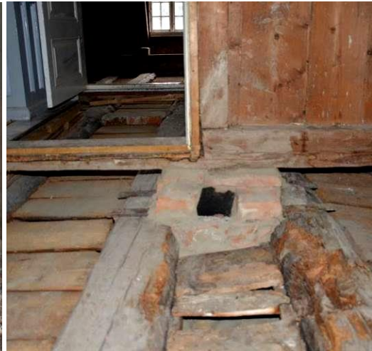
T.v: Badrummets golv bilades bort. T.h: Murad kanel ner till kök. Bildid: vlm-kmvsb-6524,- 6860.
