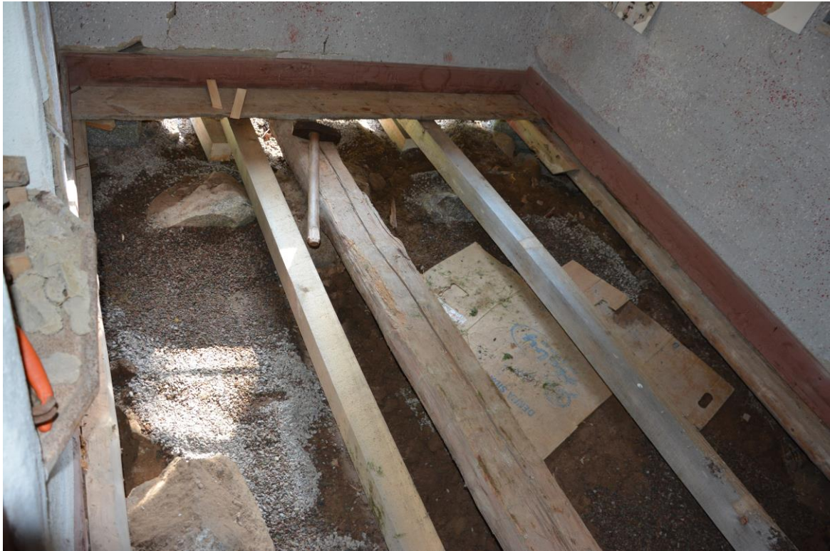
Pågående arbete med att stötta upp golvet i kammaren. Vlm-kmvat-0308
