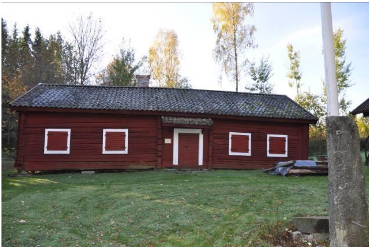
Storstugan med tydliga sättningar. Foto: Anita Forsgren
