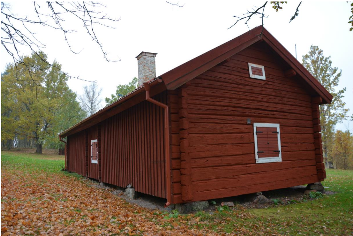
Storstugan vid slutbesiktning. Vlm-kmvab-0286
