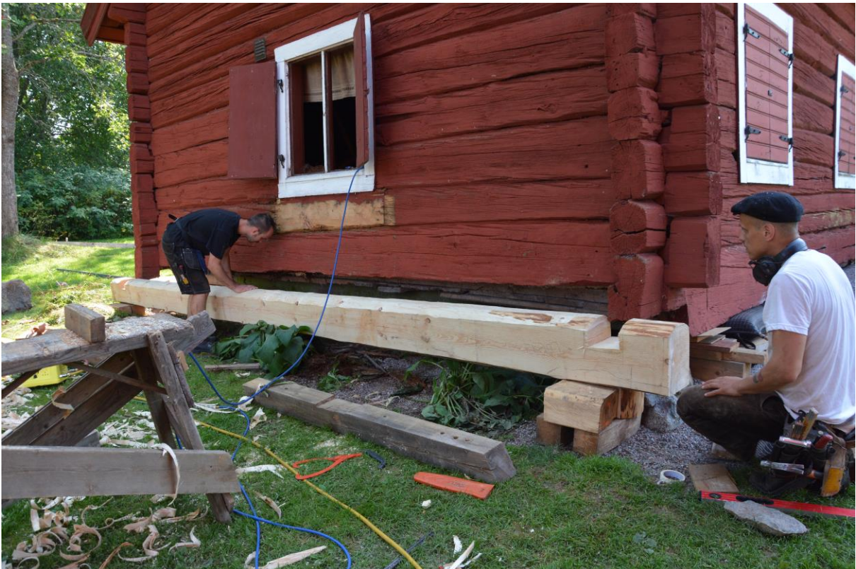
Byte av syllstock. Marcus och medhjälpare i bild. Vlm-kmvat-0315
