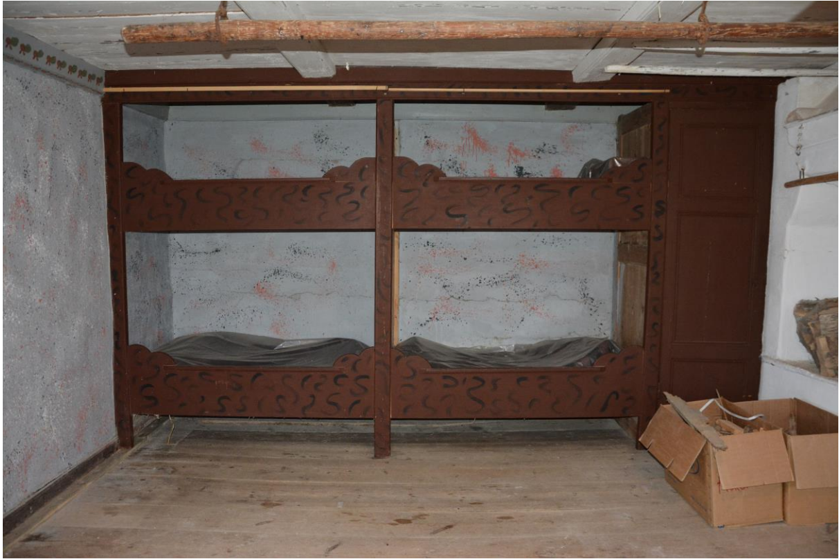
Platsbyggda sängar har riktats. Vlm-kmvat-0520
