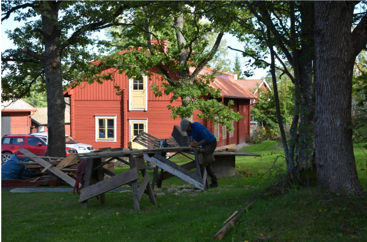
Arbetet har utförts med lokala material och med traditionella metoder. Här genom handhyvling. Vlm-kmvat-0356
