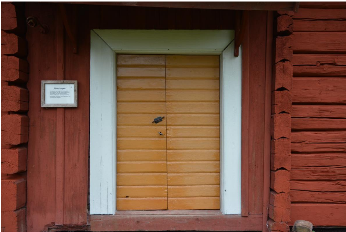
Storstugan vid slutbesiktning. Vlm-kmvab-0277
