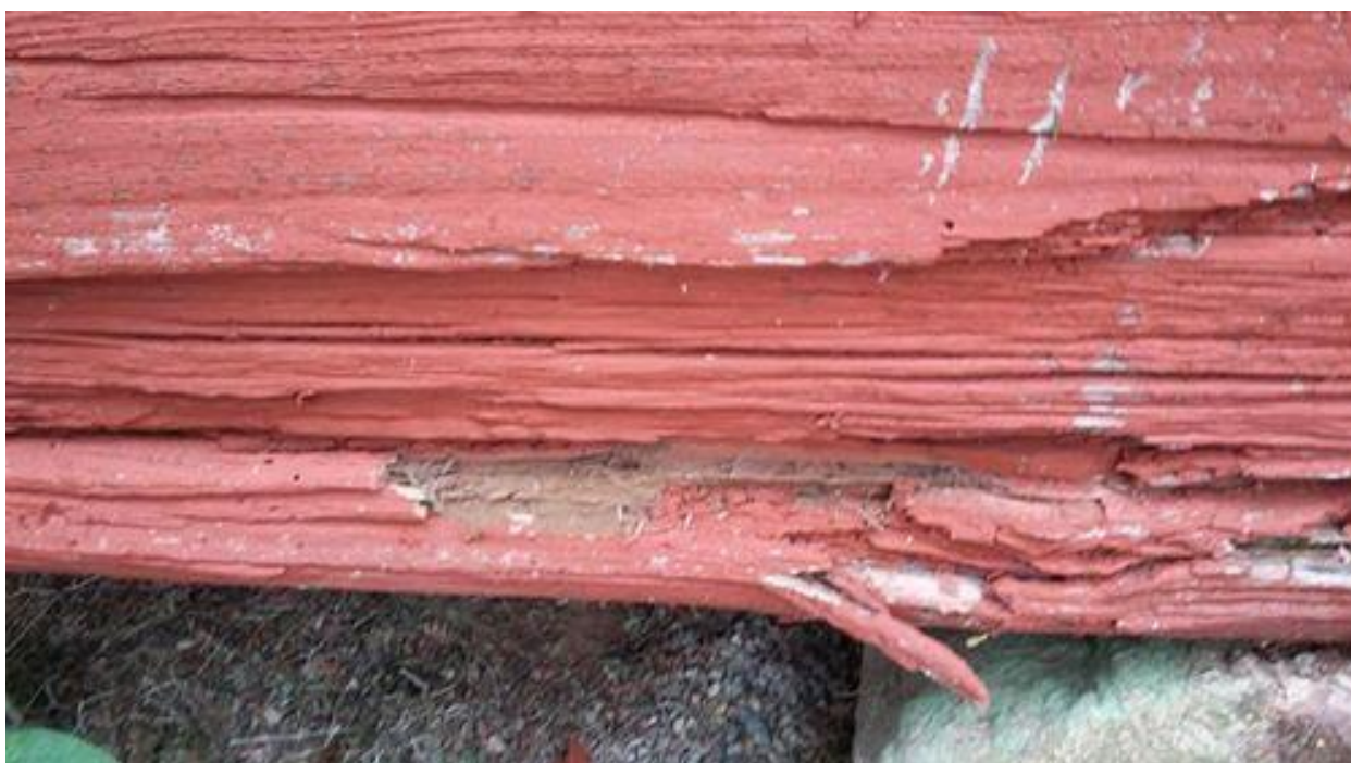
Rötskadad sällstock. Foto: Anita Forsgren
