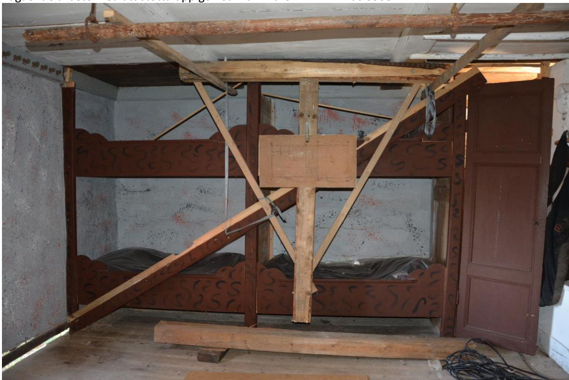
Platsbyggda sängar som tillfälligt stöttades upp under tiden riktning av huset pågick. Vlm-kmvat-0312
