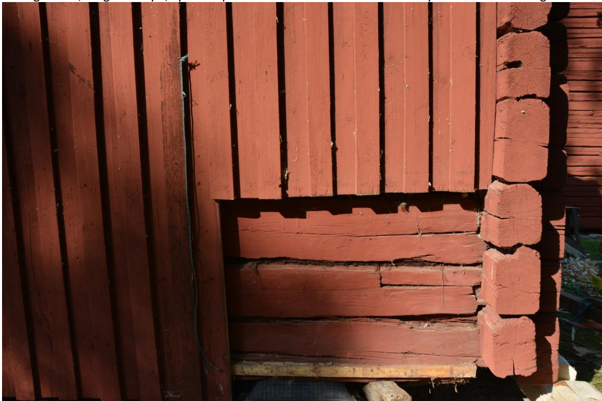
Avsågad fasadpanel för att undersöka timmerstockars skick. Dessa var i gott skick och panelen sattes tillbaka. Vlm-kmvat-0325
