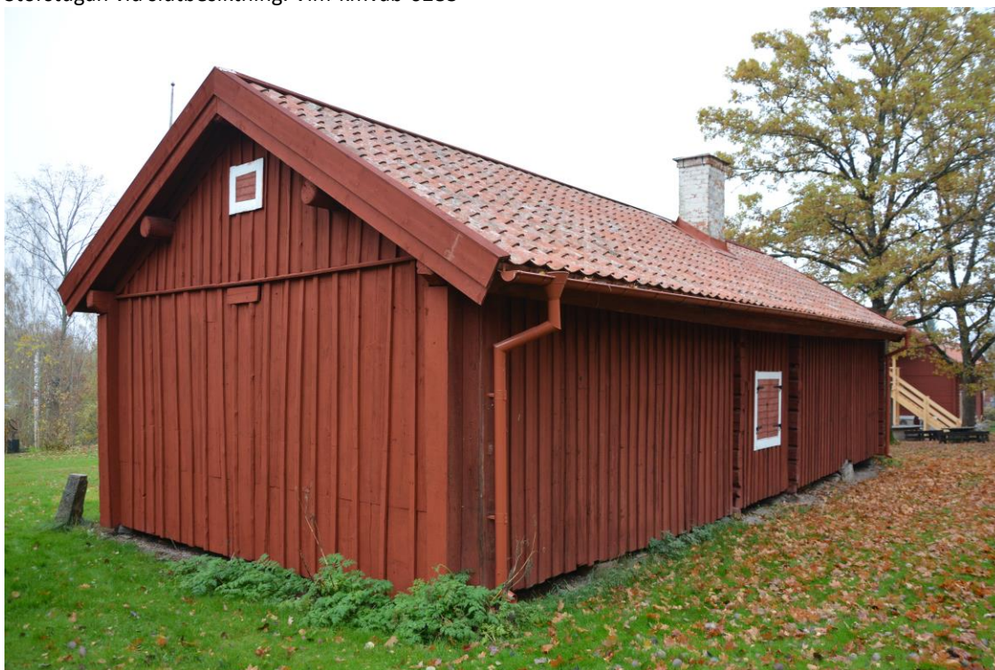
Storstugan vid slutbesiktning. Vlm-kmvab-0285
