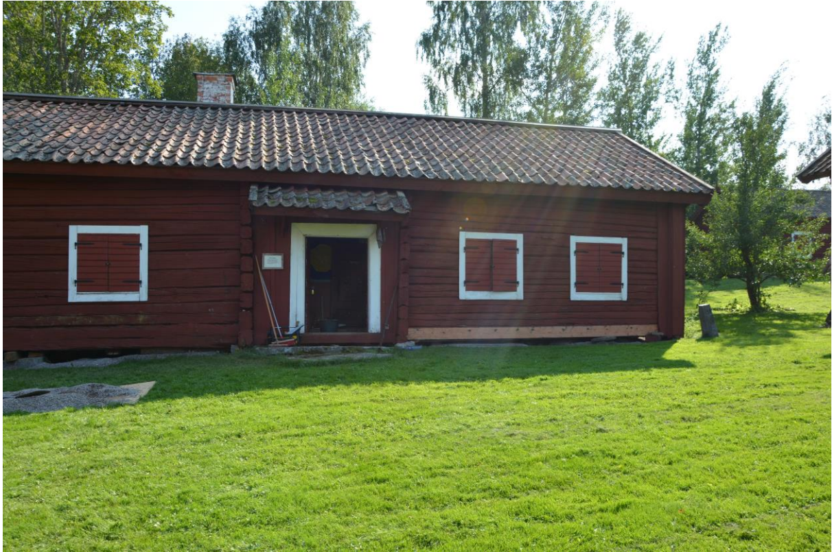
Bilning av slät, tidigare utbytt, syllstock på framsidan för ett traditionellt uttryck. Foto: Anita Forsgren
