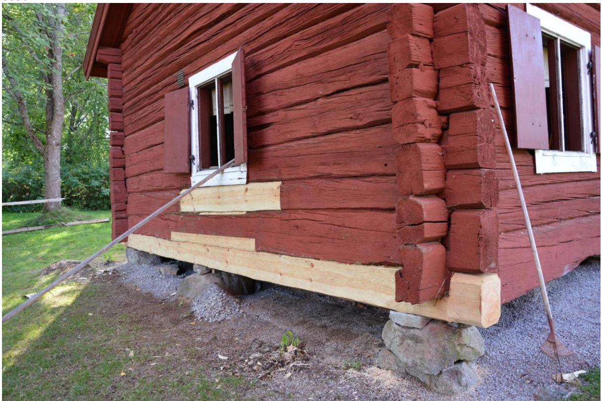
Under pågående arbete med bilning av en äldre sulning under fönster upptäcktes det att sulningen täckt en rötskada. Stocken byttes därför ut i sin helhet. Vlm-kmvat-0350
