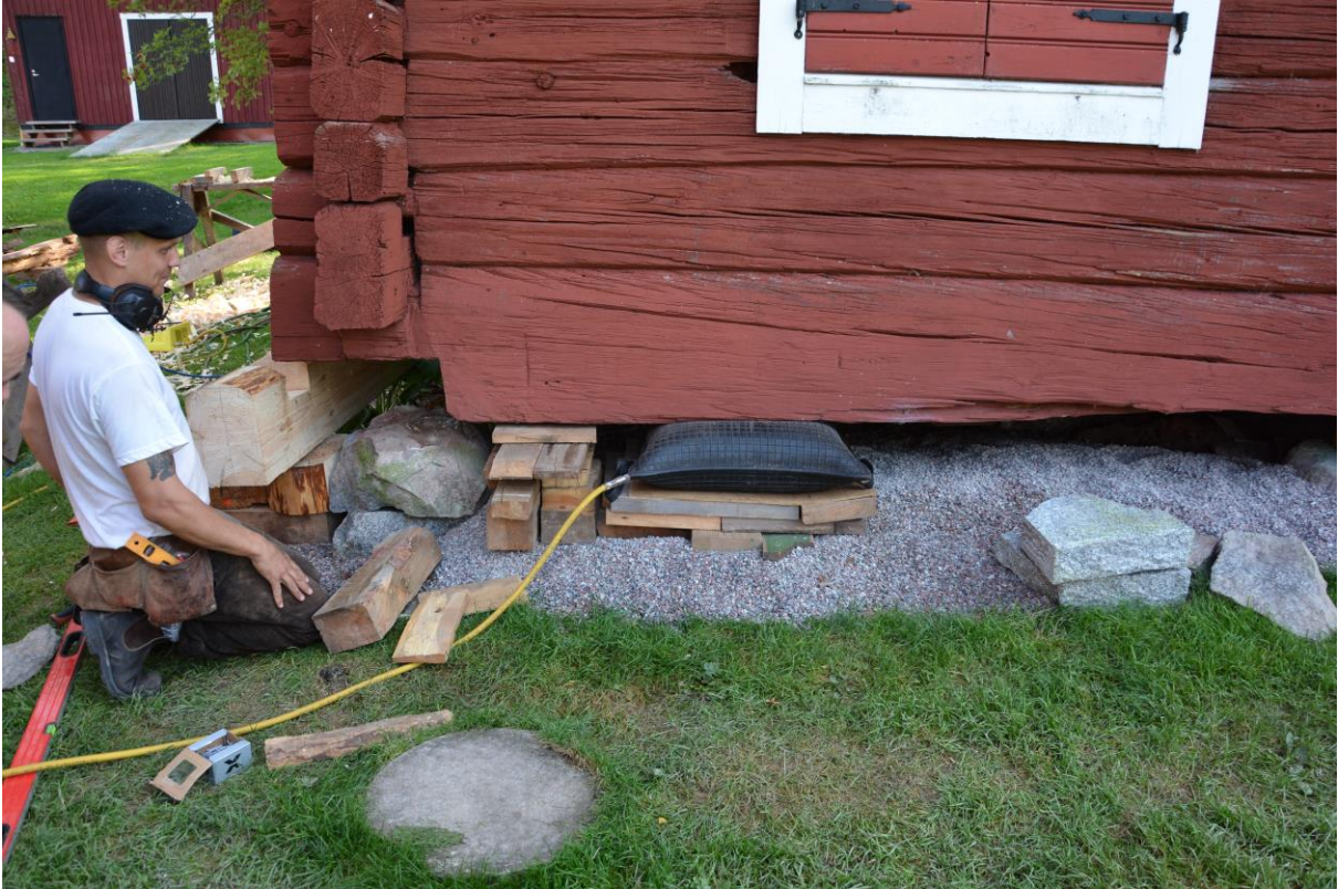
Lyft av huset inför byte av syllstock. Marcus från Illmyra timmerhusvärd i bild. Vlm-kmvat-0327
