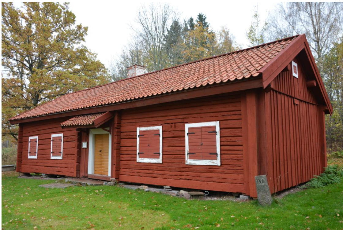
Storstugan vid slutbesiktning. Vlm-kmvab-0283
