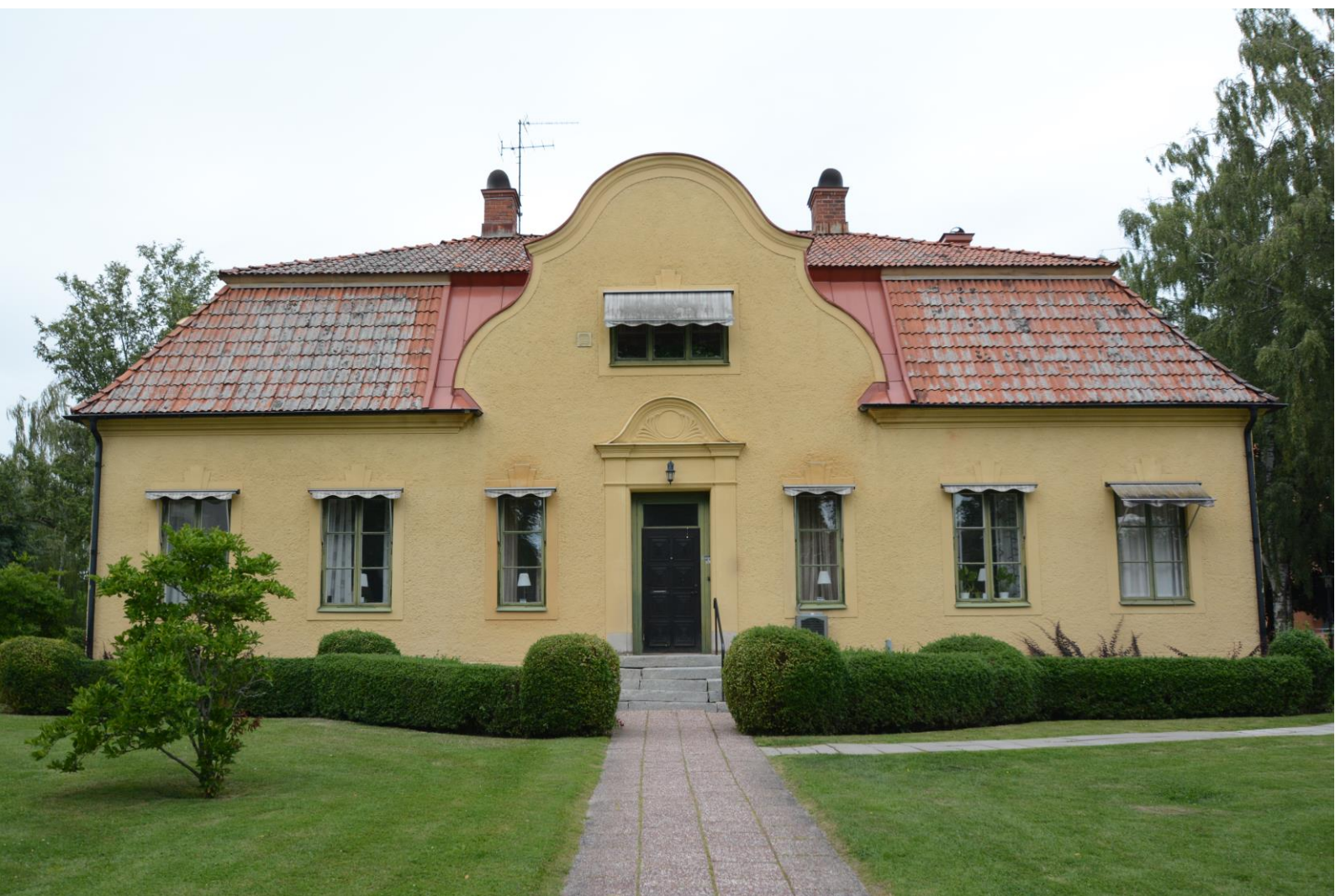
Fasad åt syd. Framför byggnadens huvudingång finns planteringar, gräsmatta och gångar med plattsättning. Bild-id: vlm-kmvab- 0159
