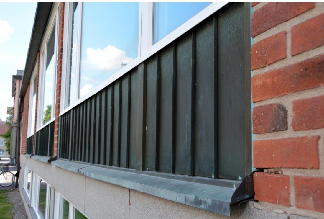
Parti med kopparplåt nedan fönster på församlingsflygelns östra fasad. Bild-id: vlm-kmvab-0235
