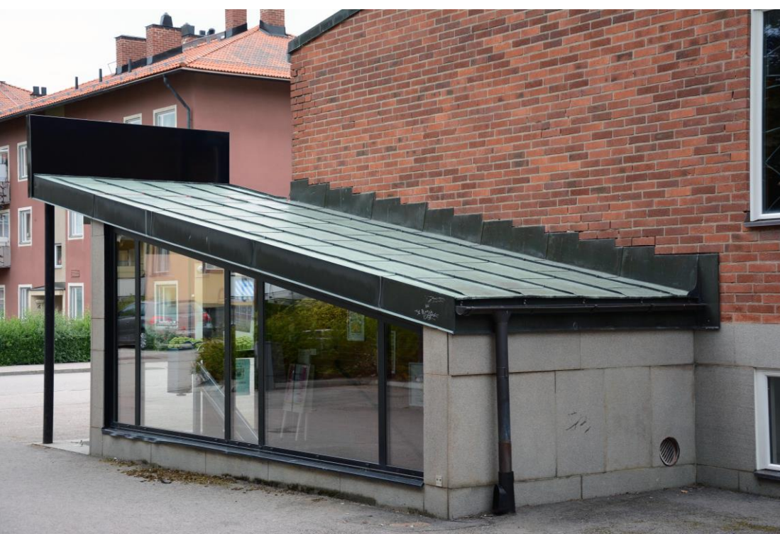
Sidoentré till källaren vid församlingsflygeln. Sluttande tak täckt med kopparplåt, samt trappformat stänkskydd mot fasad. Bild-id: vlm-kmvab-0066
