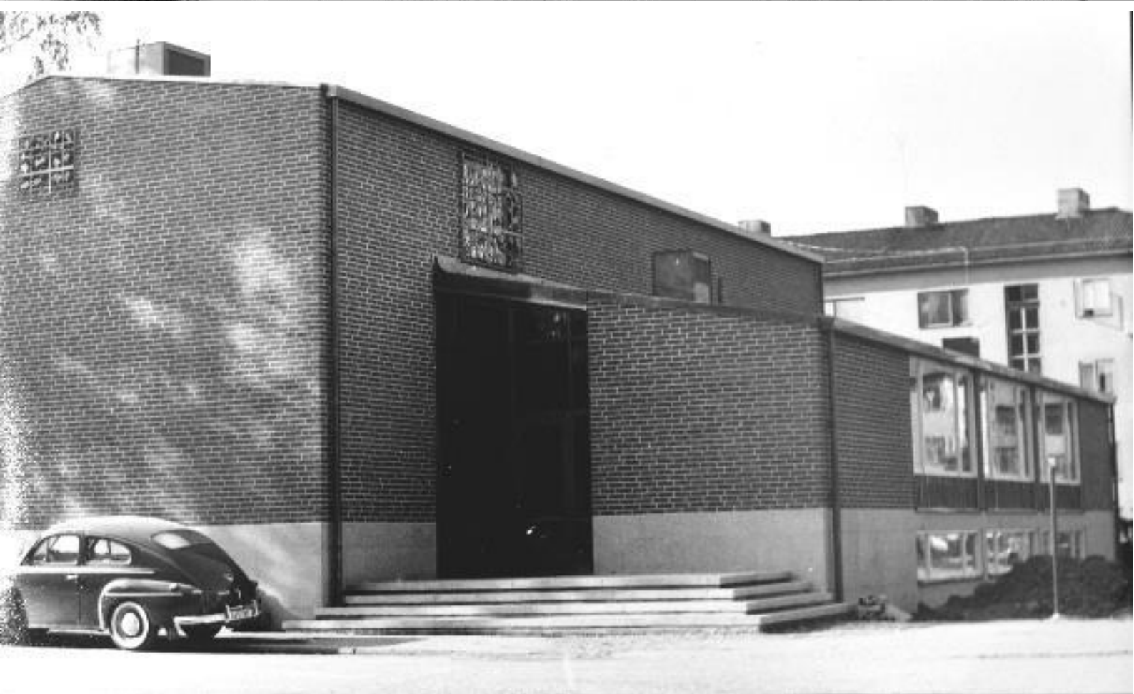
Församlingshemmets ursprungliga utseende. Fotografier är troligen från tidigt 1960-tal. Källa: Landsarkivet Uppsala
