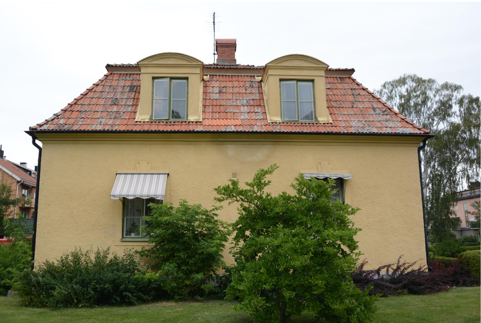
Nedan: Fasad mot väst, mot Stora Kyrkogatan. Byggnadens enklaste fasad, utan ingång. Bild-id: vlm-kmvab-0168
