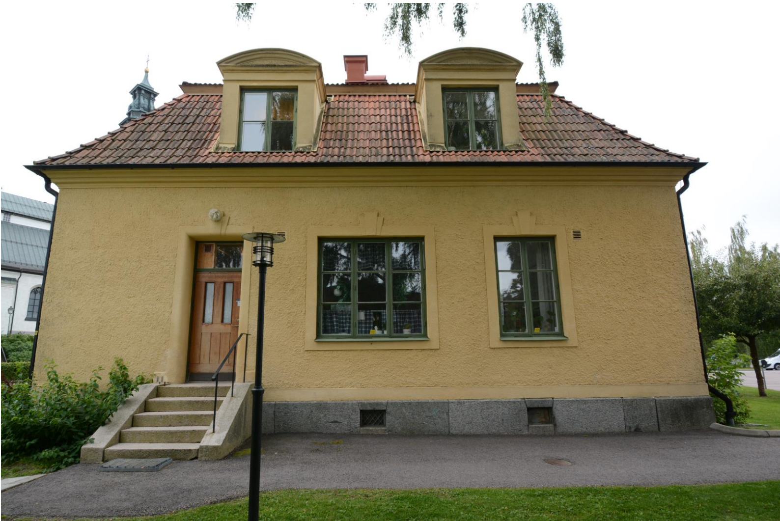
Fasad åt öst som vetter mot församlingshemmet. Till vänster är köksingången. Bild-id: vlm-kmvab-0182
