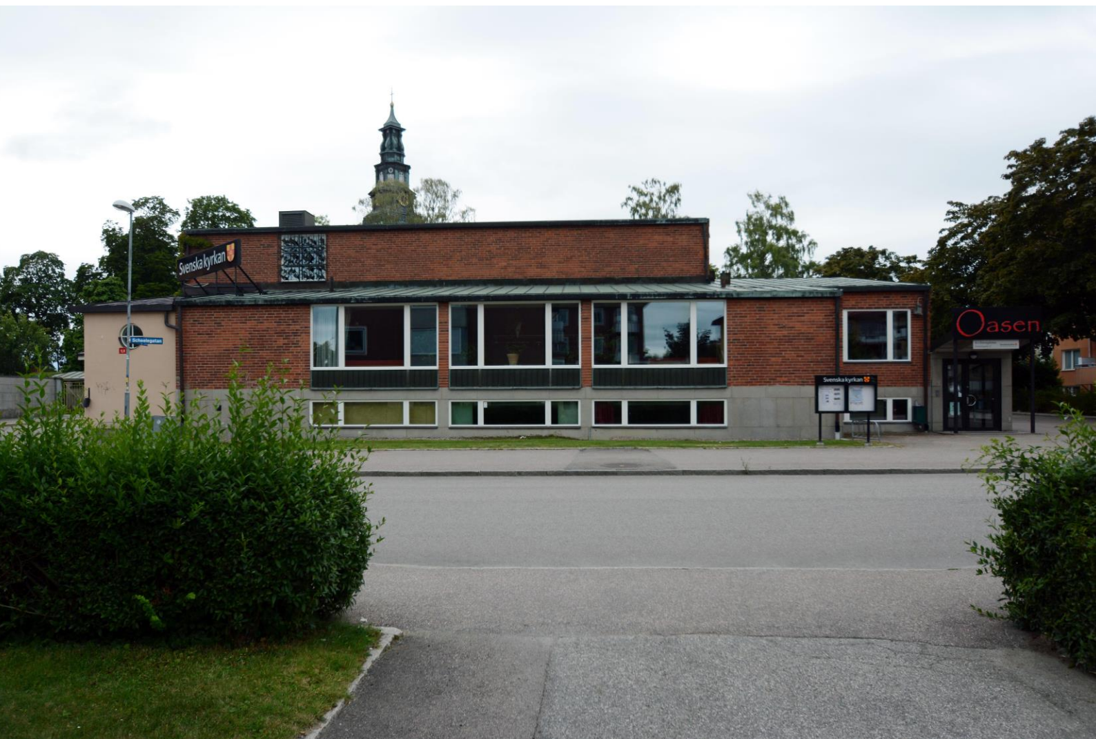
Församlingsflygelns fasad mot öst. Till vänster syns senare påbyggda entré i ljus puts. Bild-id: vlm-kmvab-0075
