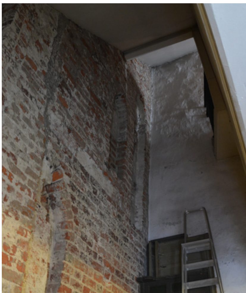
Sparad tegelvägg som visar kyrkans tidigare ytttermur. Vlm-modkaVB-1392.
