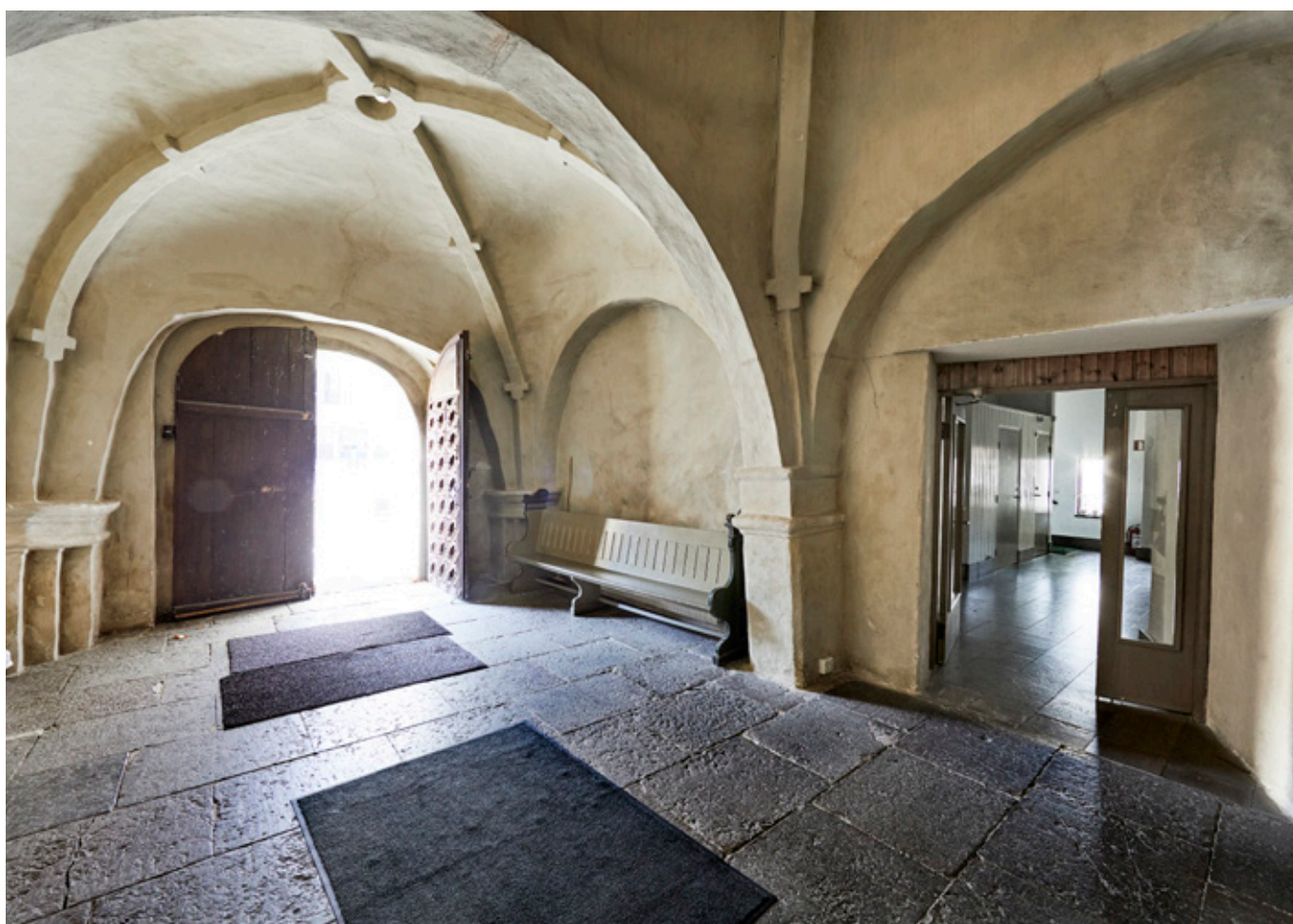
Grönmålad bänk i vapenhuset. Dörren till höger leder in till tillbyggnaden i nordväst.
