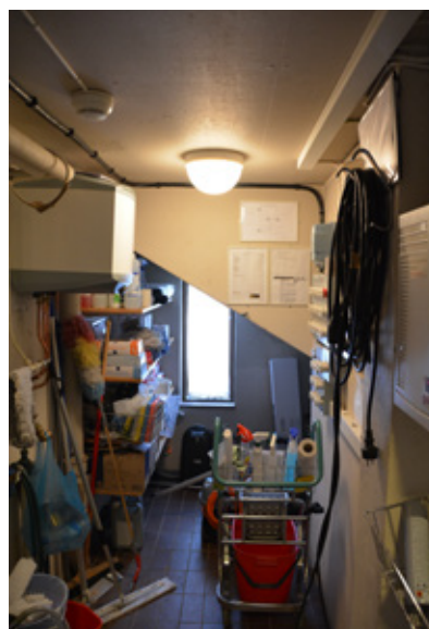
Golv av rödbrunt höganäsklinker. Vlm-modkaVB-1434. Städförråd i tillbyggnaden. Vlm-modkaVB-1435.
