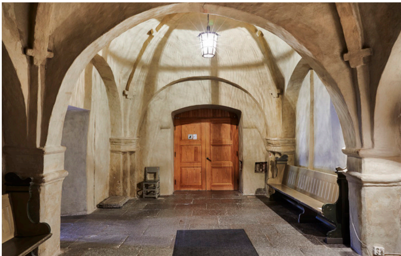
Vapenhuset med pardörr av lackad furu och handtrycke av järnsmide.
