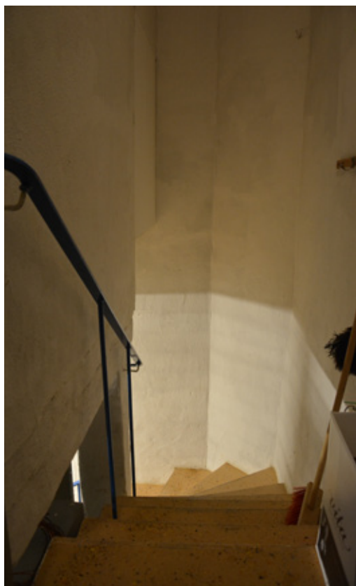
Trappan ner som leder till pannrummet. Vlm-modkaEK-4012.
