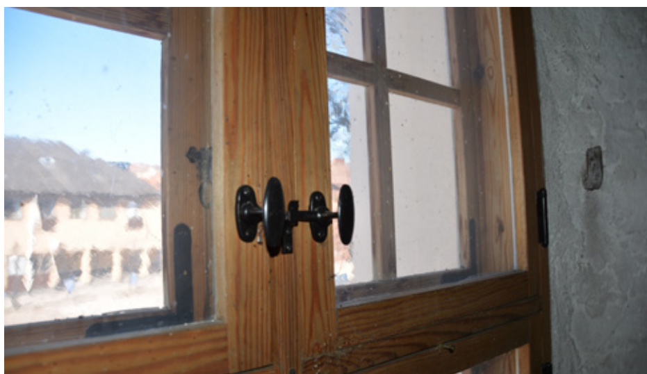
Fönster av trä med svartmålade metallhandtag. Vlm-modkaVB-1286.
