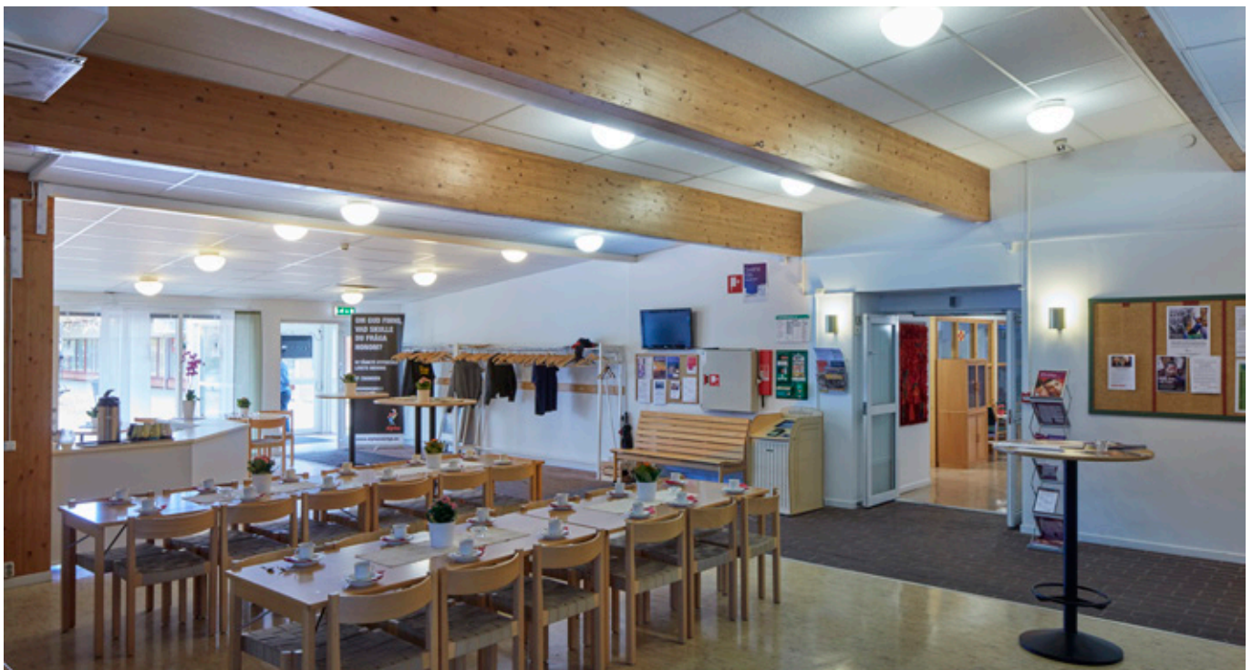
Vy över kyrktogets serveringsdel. I taket syns mineralullabsorbenter mellan limträbalkar. I bildens syns tegelgolvet som leder från entrén till kyrksalen.
