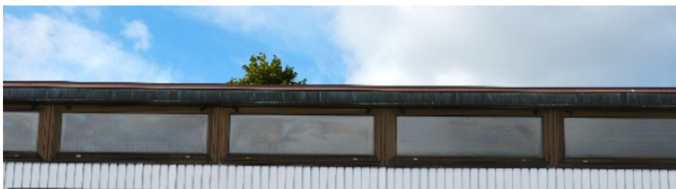
Fönsterrad under tak. Vlm_modkaEK-450.
