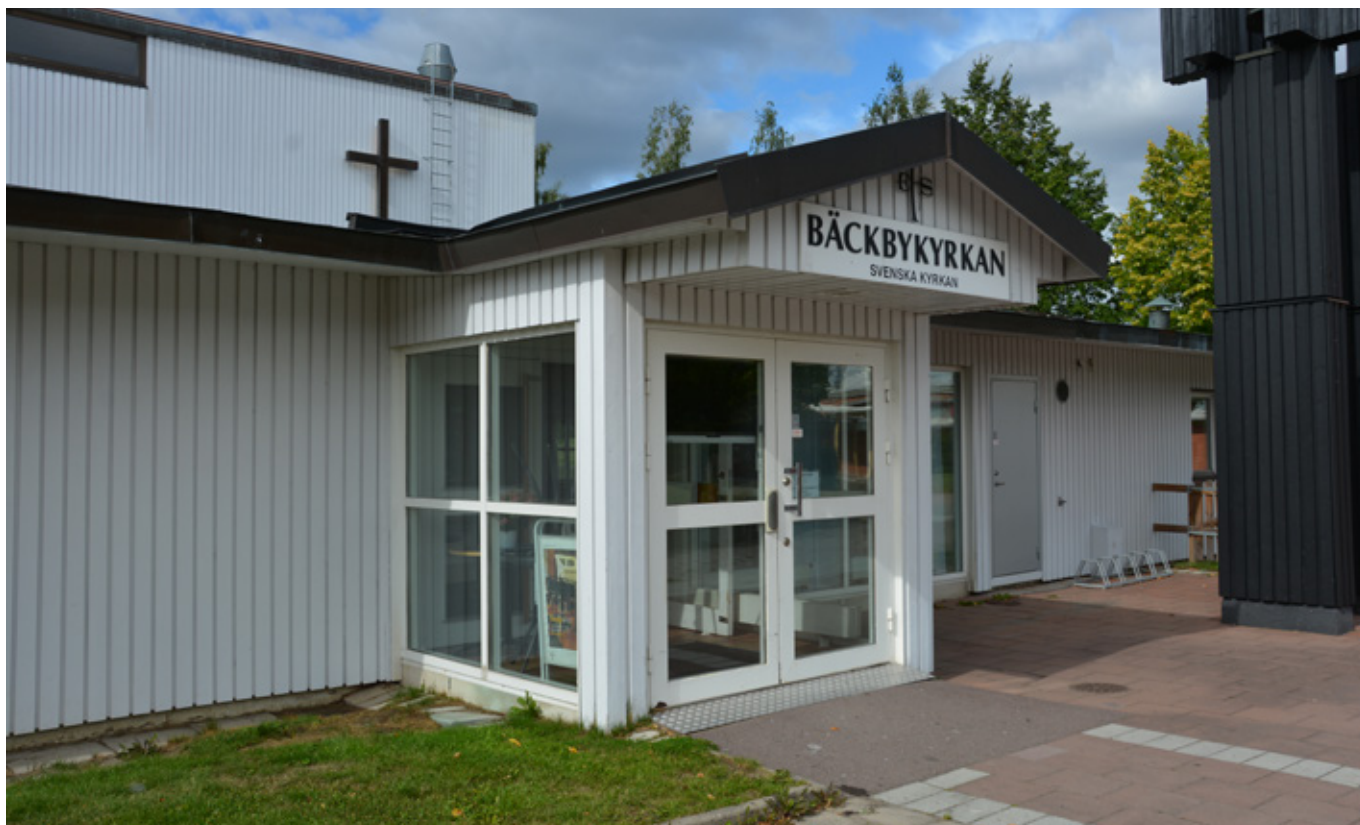
Vindfånget sett utifrån. Vlm_modkaEK-435.
