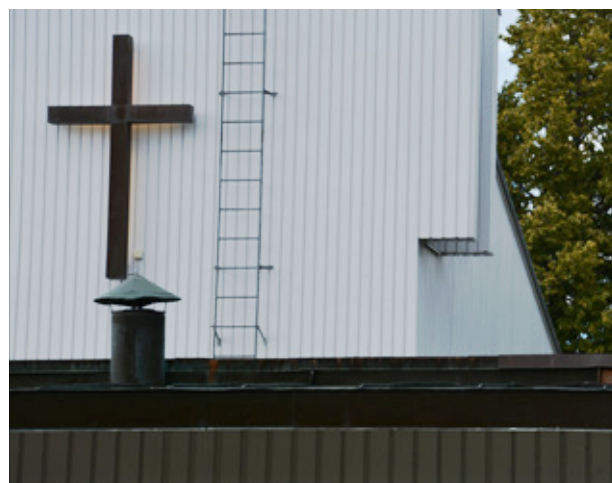
Kors på södra fasaden. Vlm_modkaEK-462.
