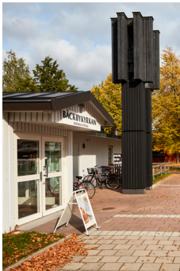
Klockstapeln framför kyrkans södra fasad med markbelägningen gräsmatta och röda cementplattor.
