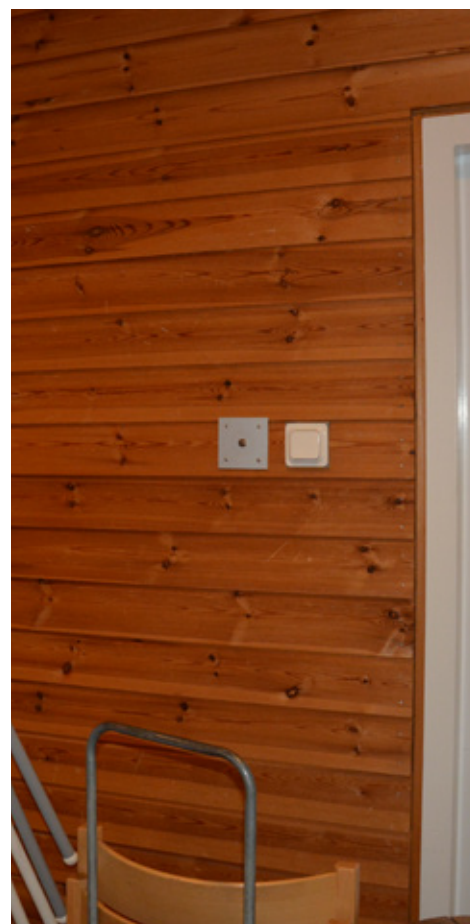
Teknikrummets vägg i samma utförande som kyrksalen. Vlm_modkaEK-135.
