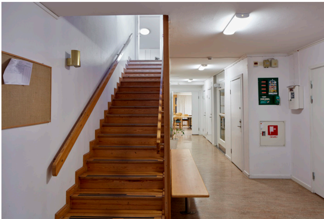
Trappa i lackad furu. Mässingslampa till vänster i bilden.
