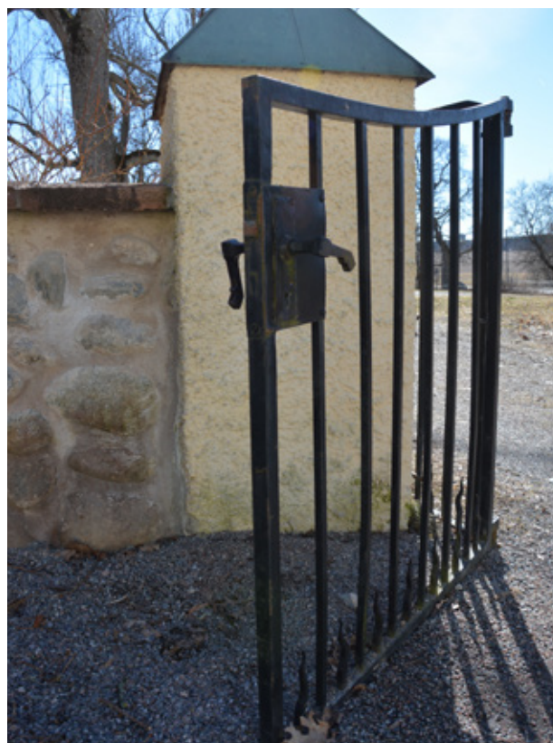
Grind och grindstolpar med huvor av kopparplåt. Vlm-modkaEK-3774.
