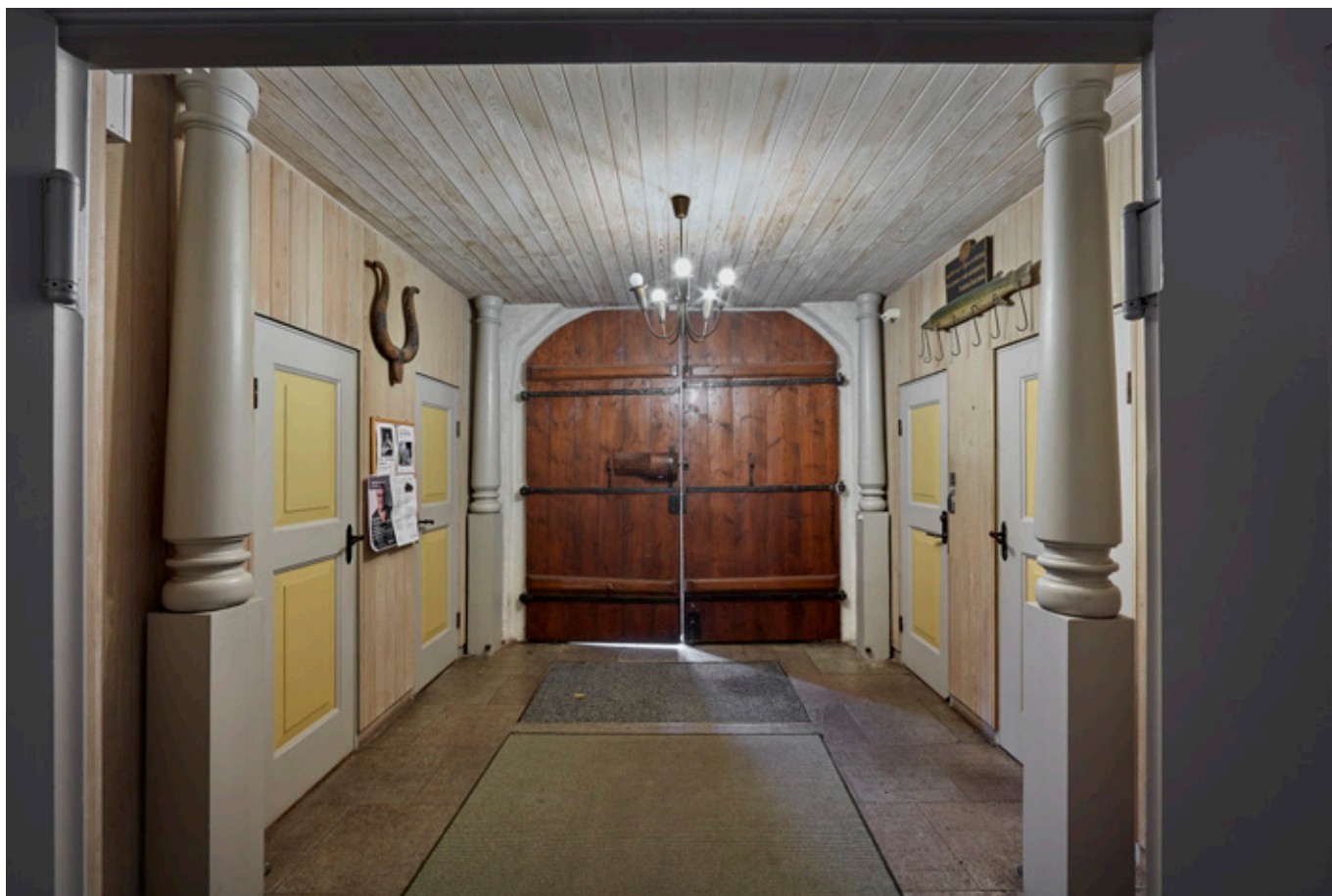
I vapenhuset inreddes toalett och städförråd.
