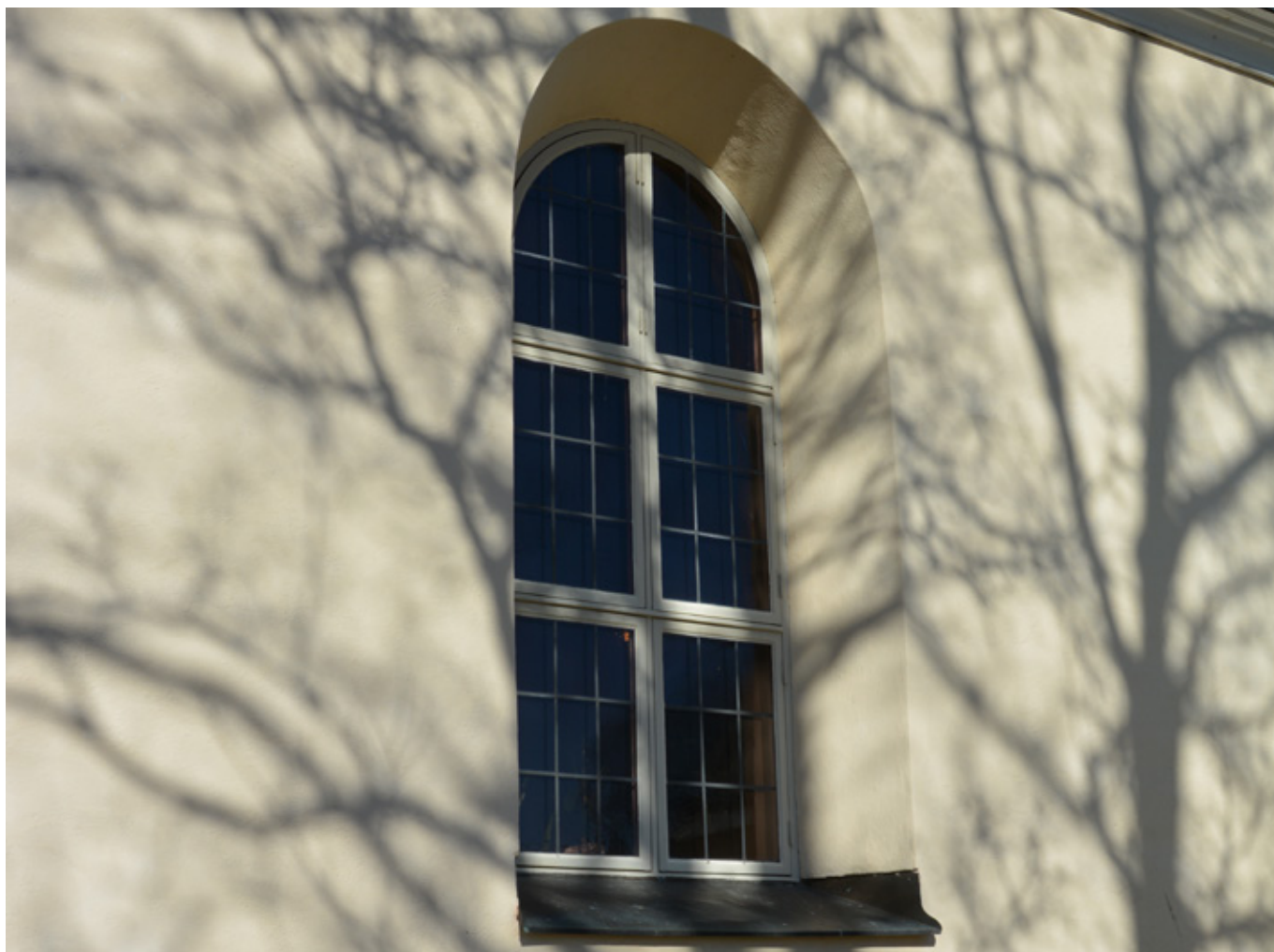
I restaureringen förminskades kyrkans rundbågiga fönster. Vlm-modkaEK-3794.
