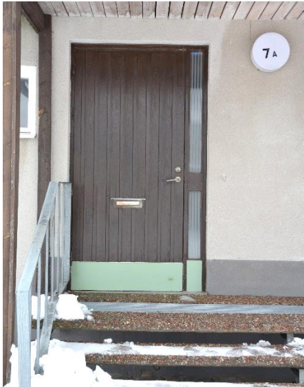
Ytterdörr med sidoljus mot övervåning i södra radhuset. Bild-ID: Vlm-kmvcm-1001
