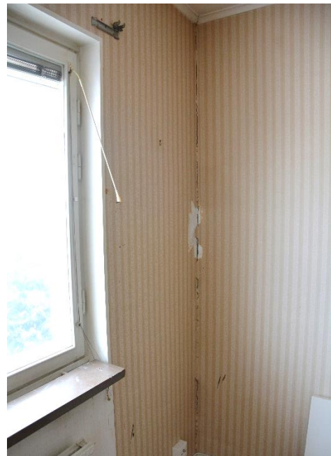
Sprickbildning som även syns interiört. Vlm-kmvcm-0886
