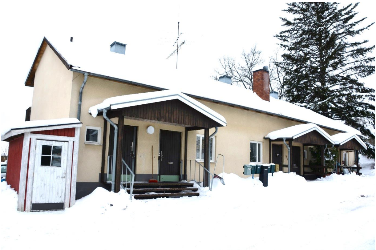
Det norra husets fasad mot Lars Uno Lindbergs gata. Bild-ID: Vlm-kmvcm-0974
