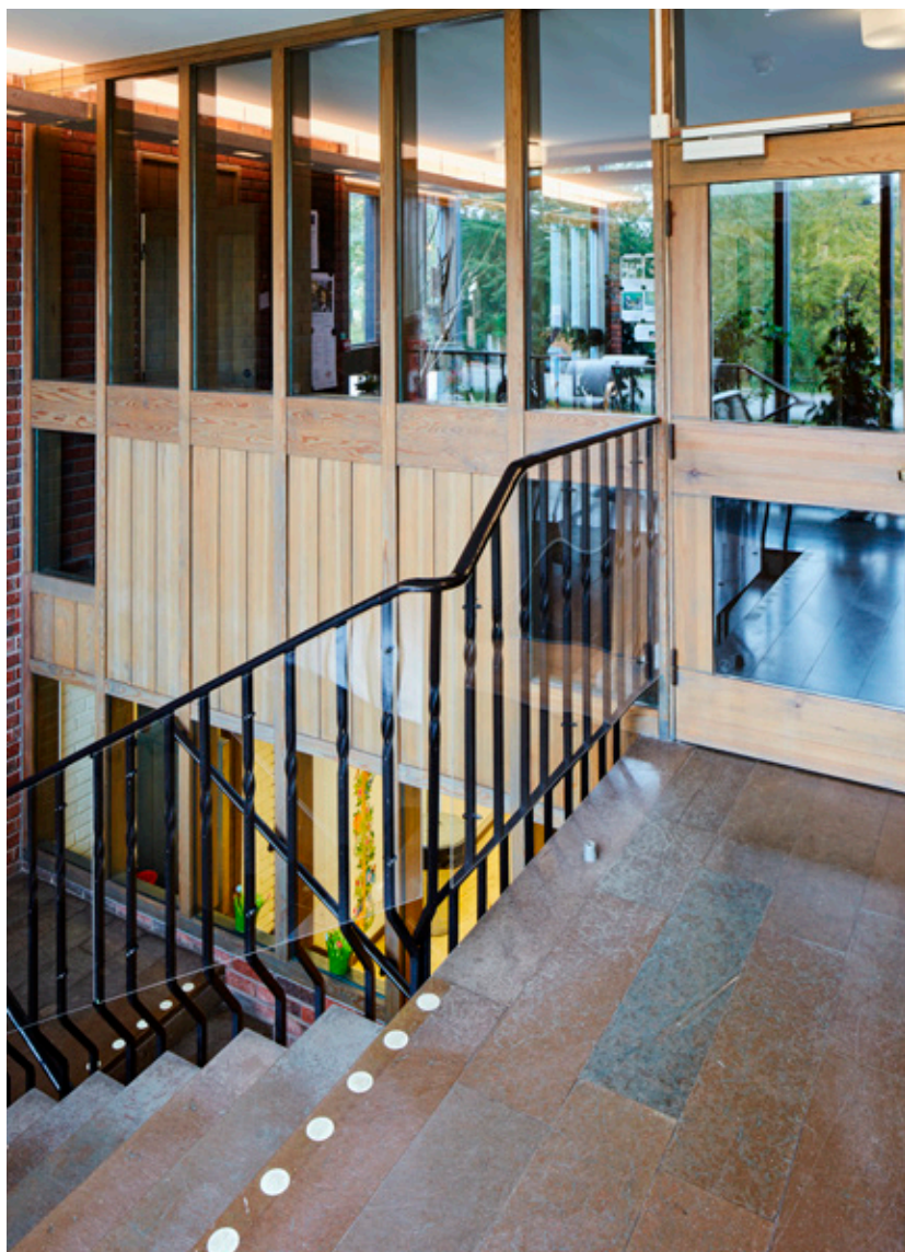
Räcke av smide. Skiljevägg mot entrén.
