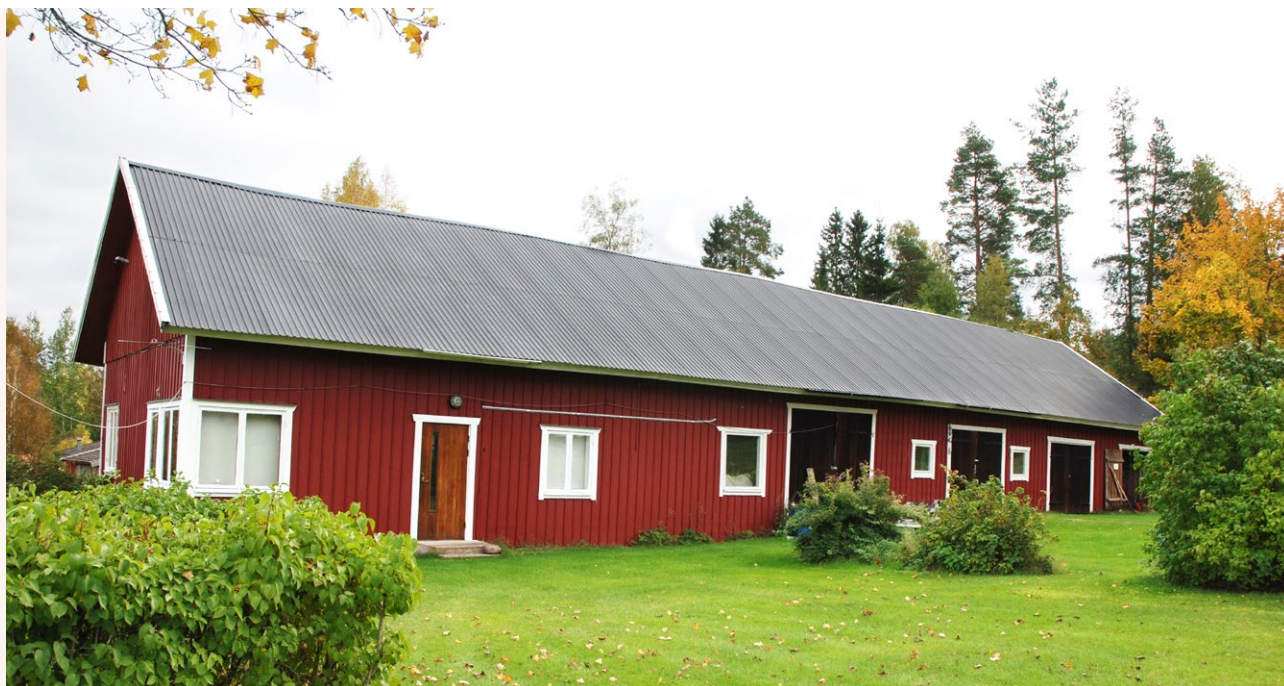
■ Ombygd ladugård tillhörande Åtorps jordbruksfastighet. Foto: Vlm-abgfe-731.
