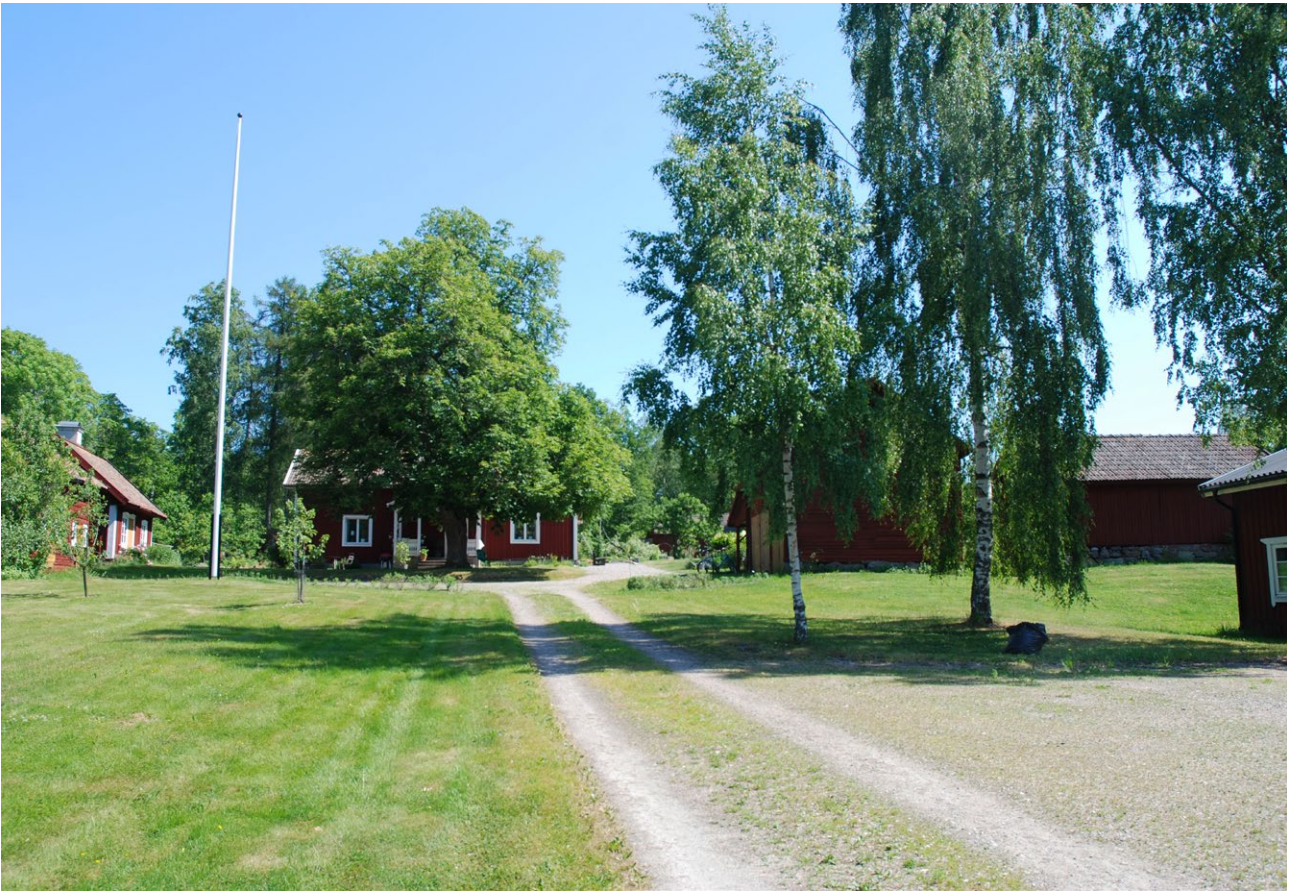
■ Gårdsmiljö i norra Näsby som fick stå kvar efter laga skiftet 1839-1841. Huvudbyggnaden flankeras av flygelbyggnaderna drängstuga, magasin och lider vid en grusad gårdsplan med äldre lövträd. Foto: Vlm-abgls-1329.
