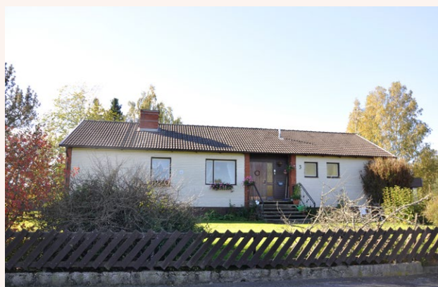
■ Villa i rött tegel och vit kalksandsten samt en dörr av trä med sidoställt fönsterparti. Foto: Vlm-abgls-106.
