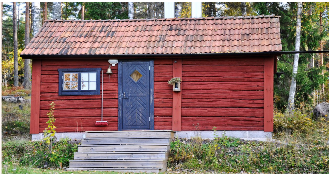
■ Falurödfärgad timrad byggnad i skogsmark. Ombyggd till bostad. Foto: Vlm-abgim-330.
