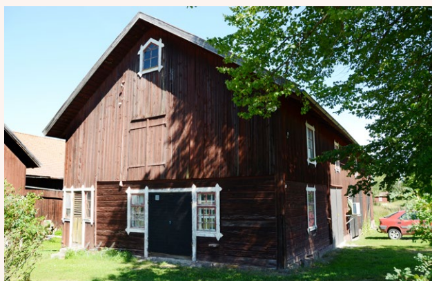
■ Magasin med dekorativt utformade fönsterfoder och vitmålade småspröjsade fönster. Foto: Vlm-abgls-1447.
