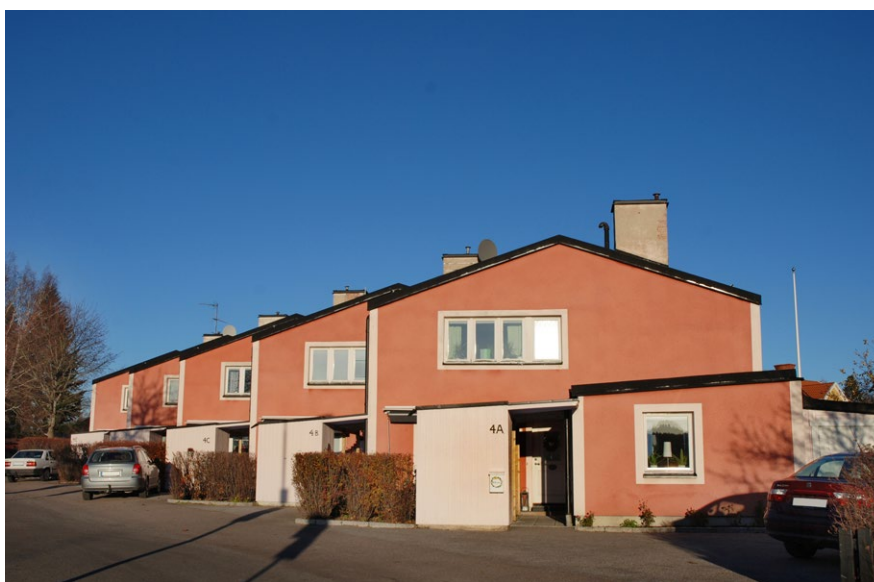
■ Radhus om fem fastigheter med förskjuten byggnadskropp. Byggnaderna har rödputsade fasader med ljusa putsdetaljer och plåttäckta sadeltak. Foto: Vlm-abgis-1125.
