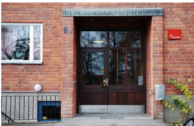
■ Ursprunglig entrédörr av teak med glasade rutor. Foto: Vlm-abgls-844.
