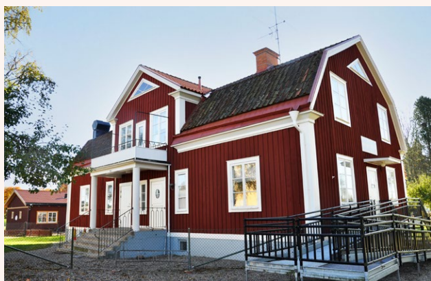
■ Lärbostad från 1920-talet med faluröd träpanel, vita snickerier och brutet tegeltäckt tak. Har på senare tid inrymt bibliotek. Foto: Vlm-abgls-65.
