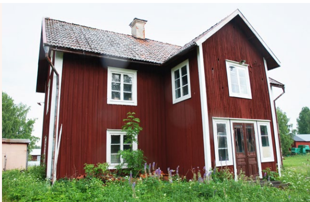
■ Ett av byns äldre välbevarade bostadshus. Byggnaden har rödfärgad locklistpanel, vitmålade snickerier och ett tegeltäckt sadeltak. Entrépartiet tillkom i början av 1900-talet. Foto: Vlm-abgls-1269.
