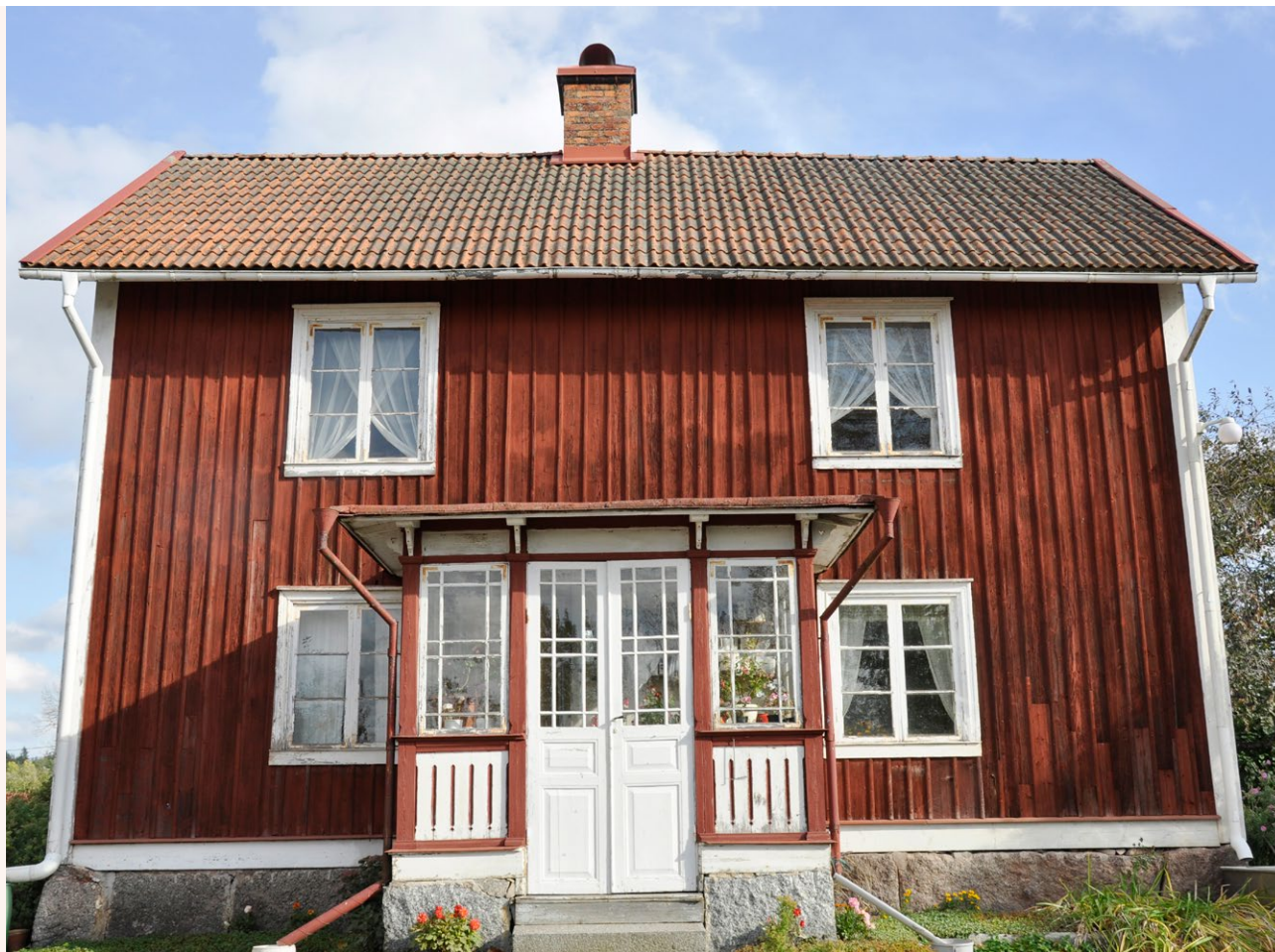
■ Timrat falurött bostadshus från början av 1800-talet. Byggnaden har inglasad veranda, vitmålade snickerier och tegeltäckt sadeltak. Foto: Vlm-abgim-63.
