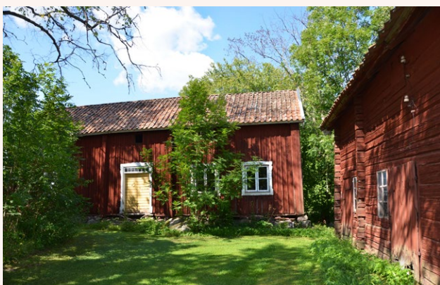
■ Falurött bostadshus troligen uppförd omkring 1800. Byggnaden har en entré med överljusfönster och fasaden på baksidan är klädd med spån. Foto: Vlm-abgls-1387.
