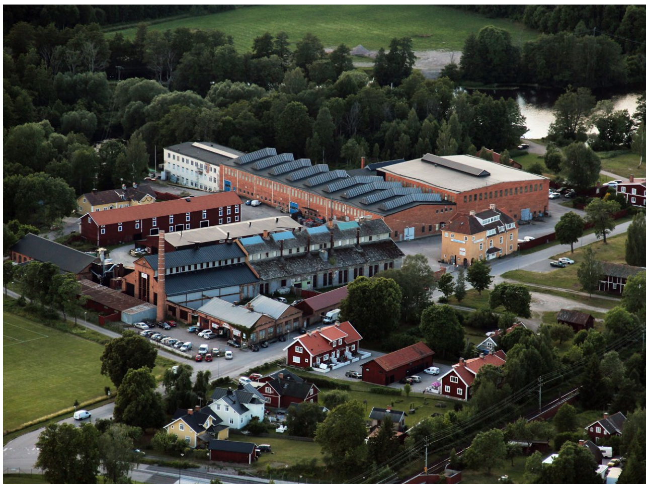
■ Arboga Mekaniska Verkstad (Meken) mot väster. Flera byggnader är uppförda i rött tegel eller med rödfärgad träpanel. Foto: Hans Spritt, 2016.
