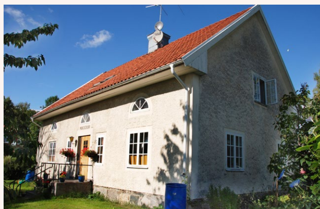
■ Bostadshus från 1866 med ljus spritputs. Huset har tidigare tillhört Uppsala Akademi. Foto: Vlm-abgfe-214.
