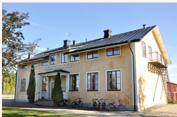
■ Skolbyggnad från 1884 i gul puts placerad invid väg. Foto: Vlm-abgls-66.
