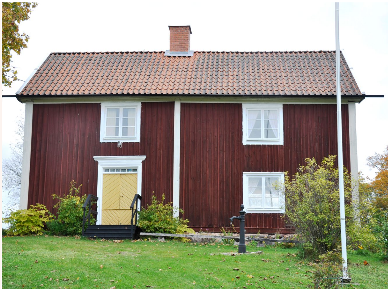
■ Abrahamsgården uppfördes under första halvan av 1800-talet och används idag som hembygdsgård. Foto: Vlm-abgim-169.
