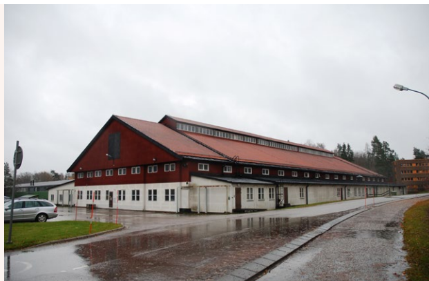
■ Före detta hangar, nuvarande telehall, är bygd för att efterlikna en ladugård. Gaveln är öppningsbar så att flygplan kunde rullas in. Foto: Vlm-abgls-973.
