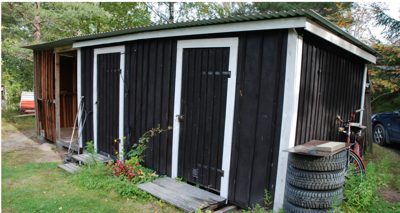
■ Svartmålat förråd till fritidshusfastighet. Foto: Vlm-abgfe-736.
