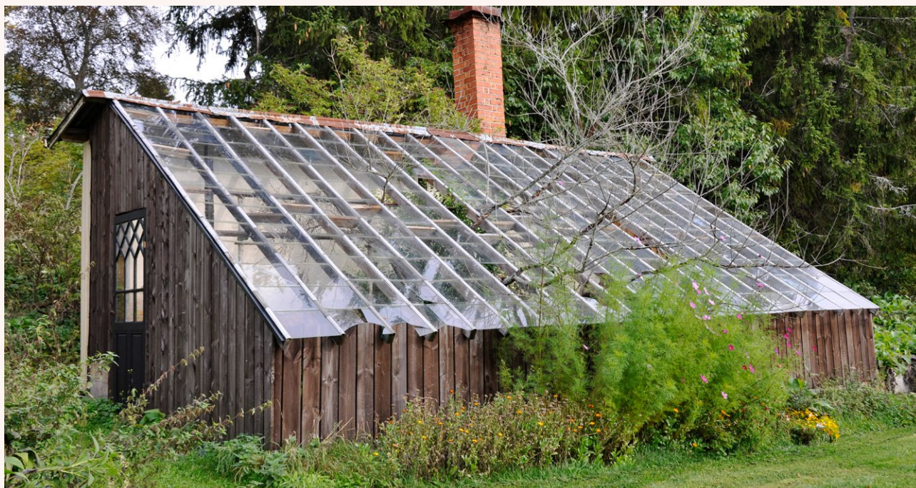
■ Vinkastet med pulpettak var ett uppvärmt växthus och värmdes genom rökkanaler. Foto: Vlm-abgls-2088.
