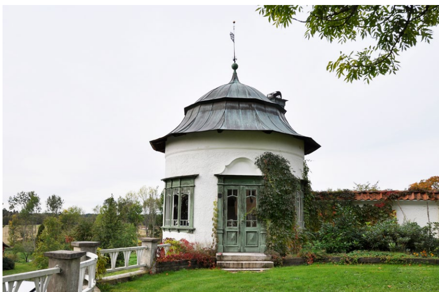
■ Lusthus från 1903 vid Sickelsjö herrgård med ljusst putsade fasader, grönmalade dörrar och fönster med dekorativ småspröjs samt tak av kopparplåt. Foto: Vlm-abgls-2077.
