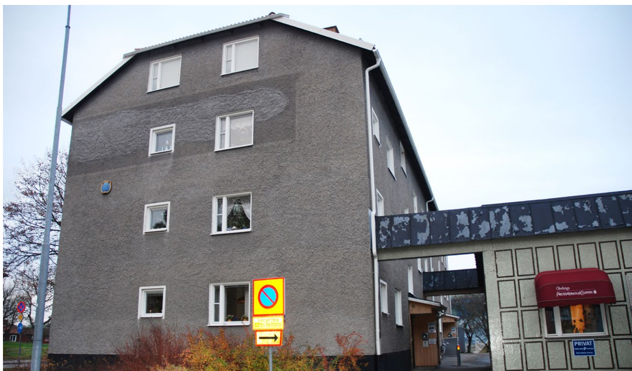
■ Lägre byggnadsdel som inrymmer butik mellan flerbostadshusen, kvarteret Gäddgården 4. Foto: Vlm-abgls-925 och Vlm-abgls-926.
