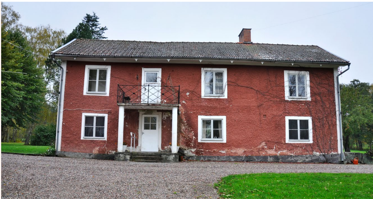
■ Byggnad med rosafärgad reveterad fasad och vita slätputsade hörnkedjor och fönsteromfattningar. Byggnaden har varit kontor. Foto: Vlm-abgim-250.
