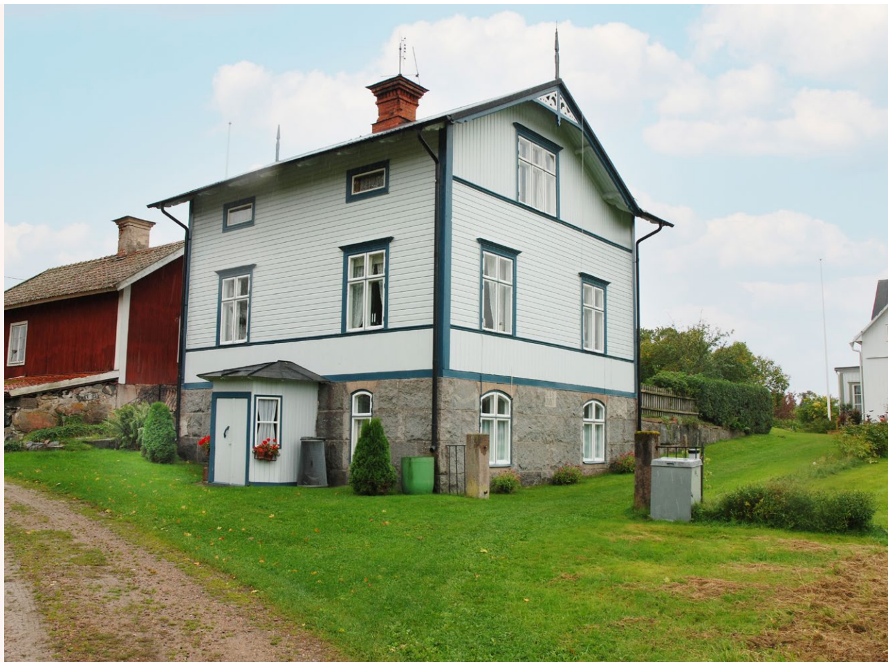
■ Fritidshus från 1900-talets början. Byggnaden har ljusmålad träpanel, korspostfönster och ett dekorativ gavelornament. Foto: Vlm-abgfe-617.
