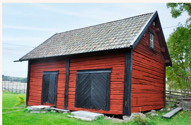
■ Timrat magasin och stall från första halvan av 1800-talet. Dörrar är svartmålade och sadeltak täckt av tegel. Foto: Vlm-abgim-172.
