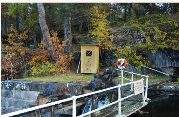
■ Vaktkur med gulmålad träpanel vid en av Hjälmare kanals slussar. Vaktkuren är troligen från senare delen av 1800-talet och är en av två bevarade. Foto: Vlm-abgls-423.
