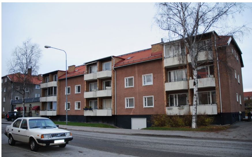
Flerbostadshus i puts med tegeldetaljer och garage i källarplan, kvarteret Gäddgården 4. Foto: Vlm-abgls-923.
