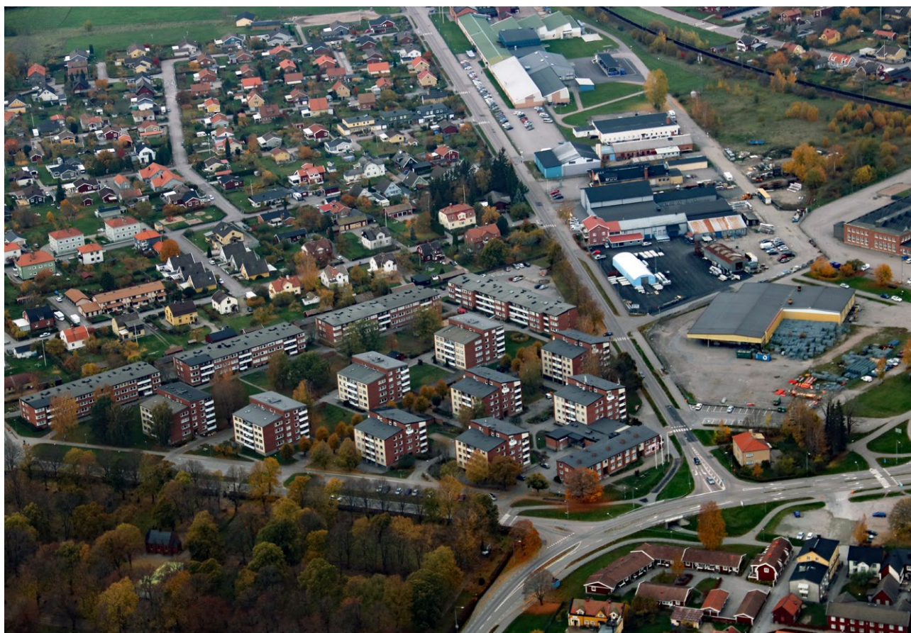
■ Nästkvam och Vilsta med strikt uppradad flerbostadsbebyggelse uppfördes på 1960- och 1970-talet. Foto: Hans Spritt, 2018.
