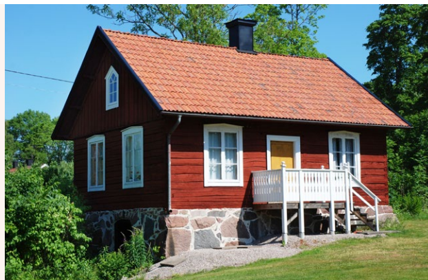
■ Drängstuga från 1850-talet med grund av natursten och fasader av rödfärgat timmer. Foto: Vlm-abgls-1307.
