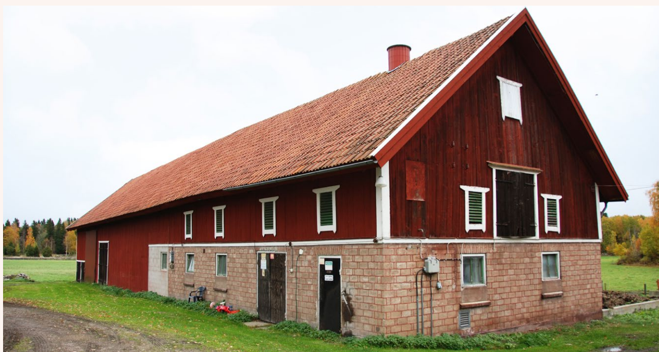
■ Ladugård uppförd på 1930-talet efter mönsterritningar. Detta är en vanligt förekommande ladugårdsyp i området. Foto: Vlm-abgsb-456.
