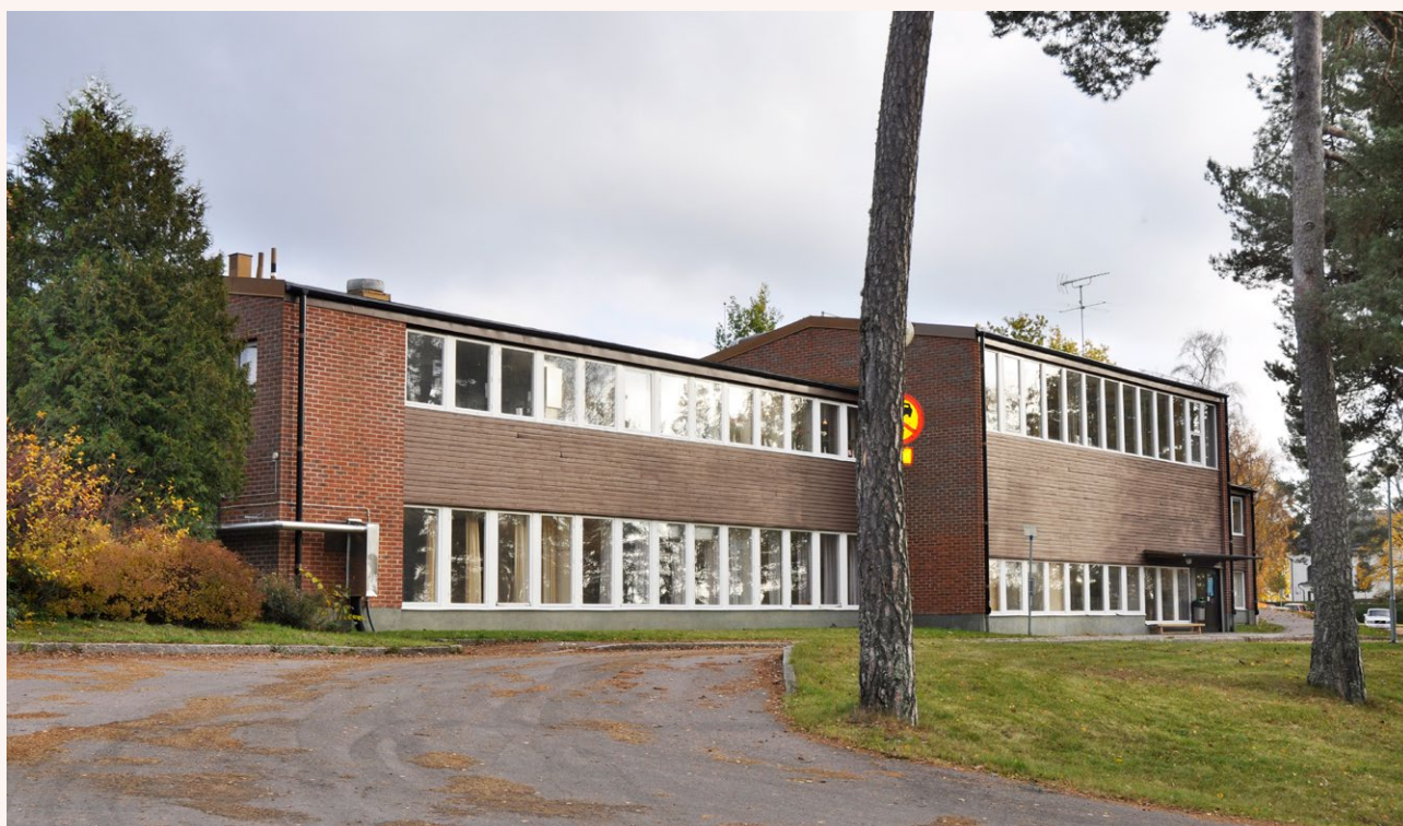
■ Götlunda grundskola byggd i rött tegel kombinerat med brunmålad träpanel. Uppförd på 1960-talet och utbyggd på 1970-talet. Foto: Vlm-abgfe-959.
