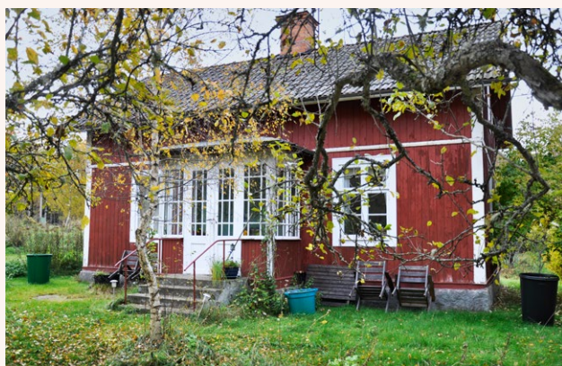
■ Falurött torp med inglasad veranda, uppfört i början av 1900-talet. Foto: Vlm-abgim-356.
