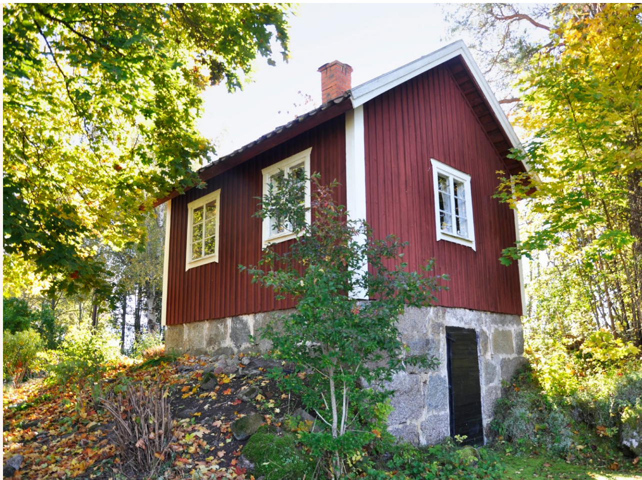
■ Byggnad med välbevarad och ålderdomlig karaktär med källare i huggen sten och faluröd locklistpanel. Foto: Vlm-abgls-77.
