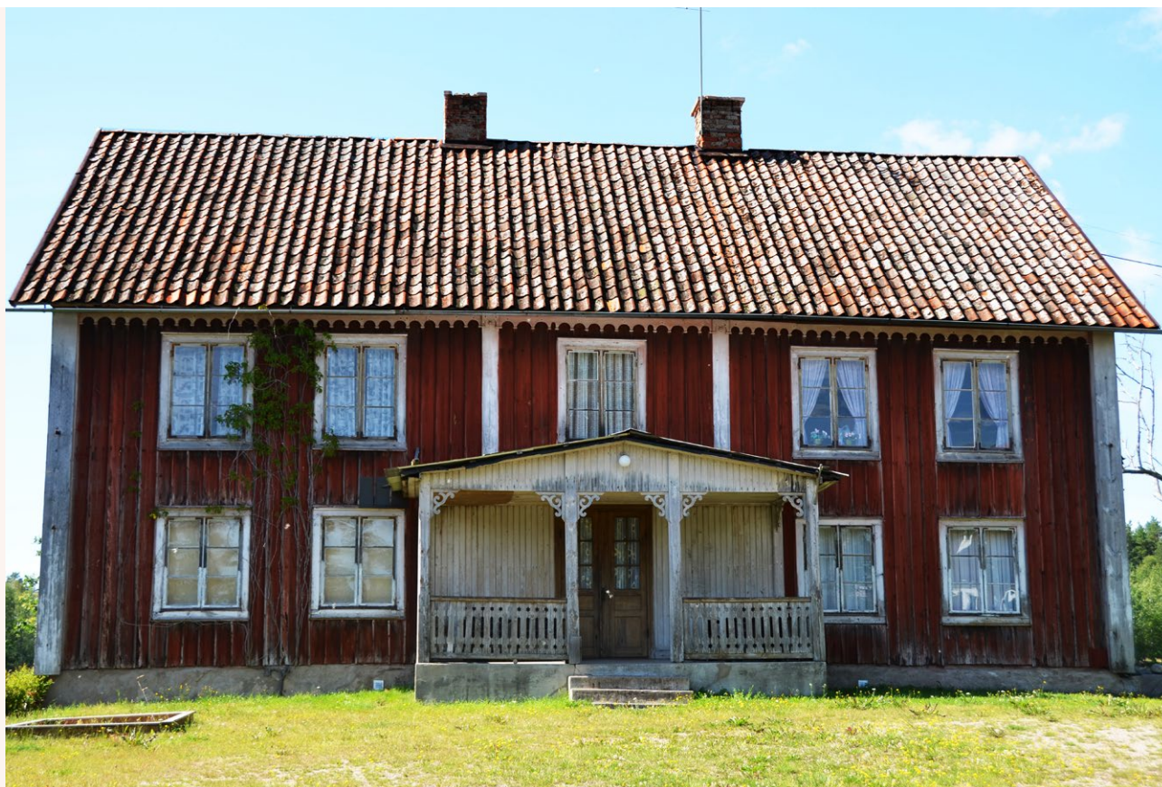
■ Ståtlig mangårdsbyggnad från 1854 i Viby med faluröd locklistpanel, tät och symmetrisk fönstersättning och en veranda med snickarglädje. Taket är belagt med enkupigt taktegel. Foto: Vlm-abgls-1436.
