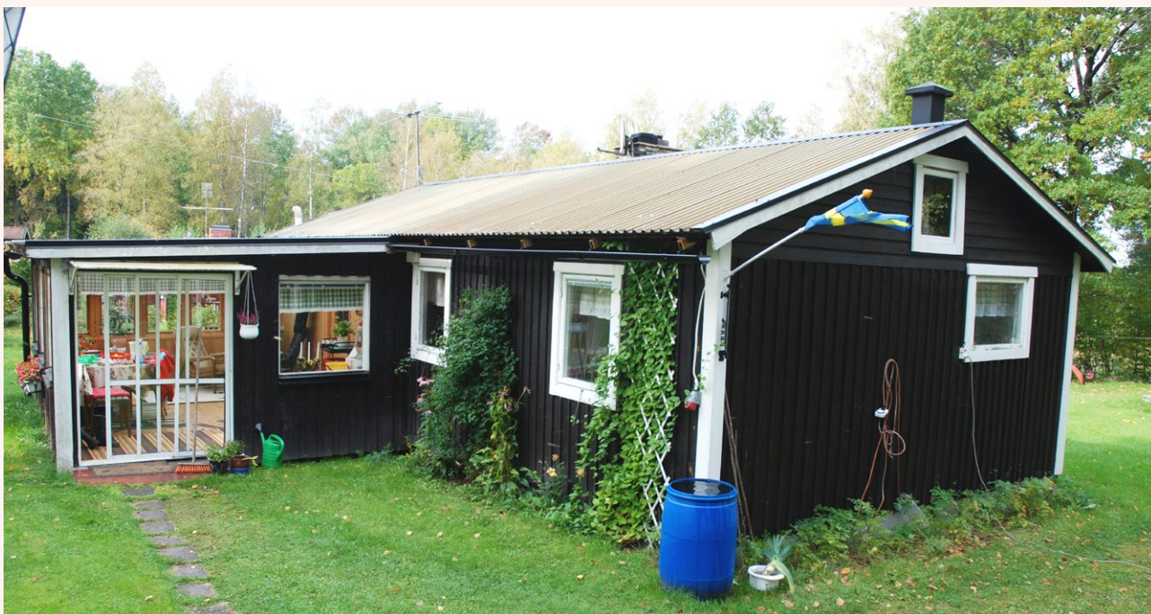
■ Svartmålat fritidshus byggt under 1960-1970-talet. Foto: Vlm-abgfe-735.
