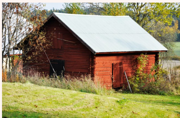
■ Timrad bod från 1800-talet. Sadeltaket är täckt med plåt. Foto: Vlm-abgim-193.
