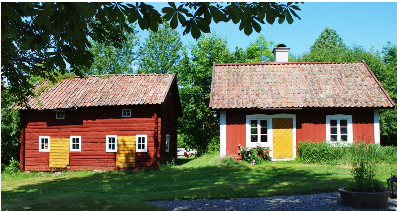
■ Magasin och drängstuga, troligen från 1850, med faluröda träfasader och enkupigt tegeltäckt sadeltak. Foto: Vlm-abgls-1325.
