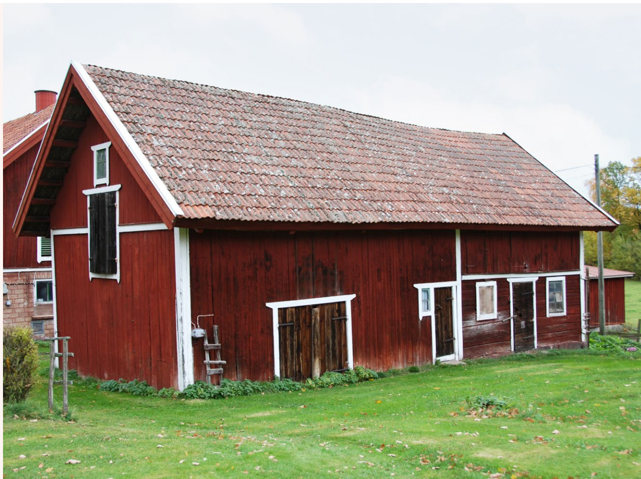
■ Ladugård med faluröd träpanel, tjärade bräddörrar, vitmålade snickerier och ett tegeltäckt sadeltak. Ladugårdens äldsta del är från 1800-talet och är tillbyggd runt 1900. Foto: Vlm-abgsb-455.
