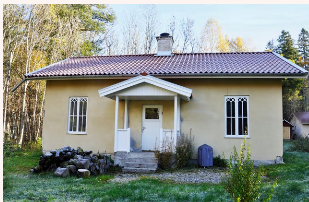
■ Slussvaktarbostad i mitten av området med gul slätputsad fasad och fönster med dekorativ småspröjs. Foto: Vlm-abgim-303.
