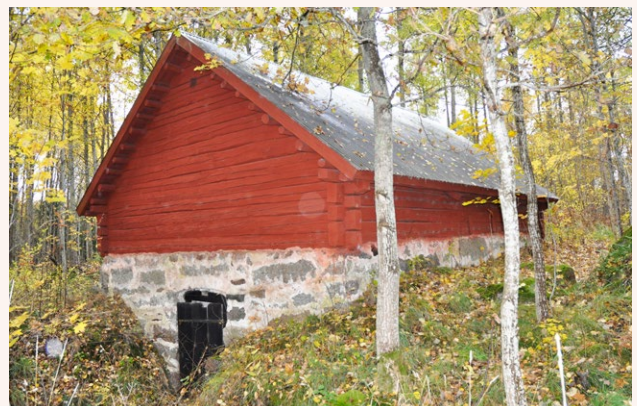
■ Jordkällare med naturstensgrund och faluröd timrad överdel och sadeltak. Foto: Vlm-abgsb-11.
