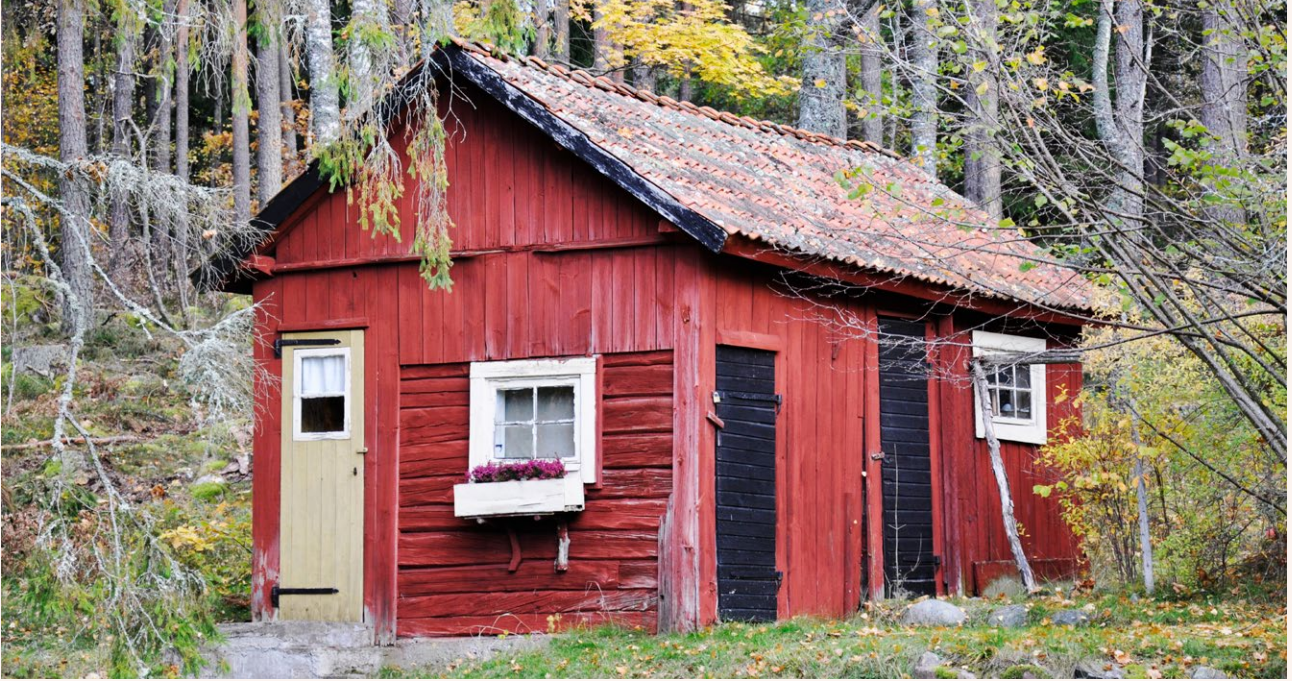
■ Faluröd uthusbyggnad med sadeltak täckt av tegel. Foto: Vlm-abgjm-341.
