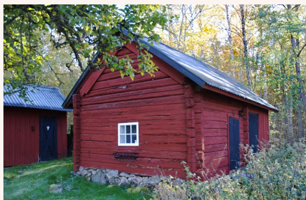
Rödfärgad timrad ekonomibygnad bland torpbebyggelsen i närheten av Hällby gård. Grunden är av natursten och dörrar svartmålade. Foto: Vlm-abgls-496.
