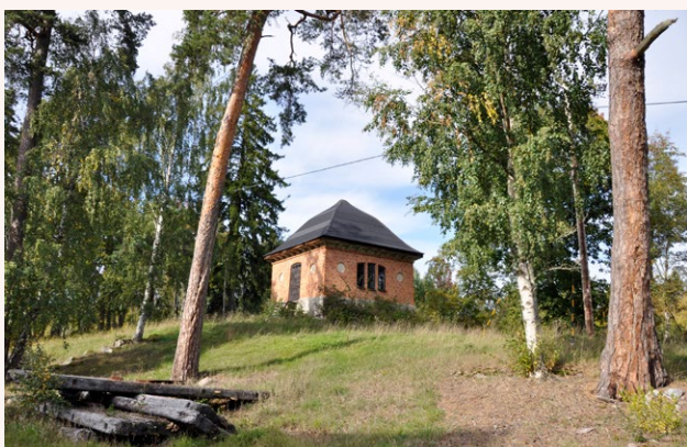
■ Vattentorn från 1800-talets slut uppförd i tegel med ett pyramidtak täckt av papp. Foto: Vlm-abgls-2136.
