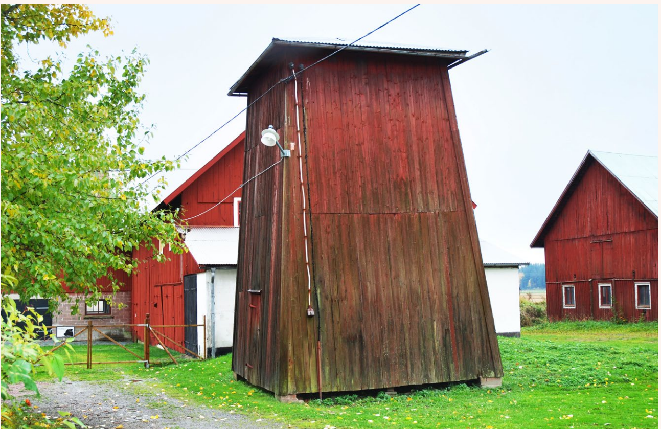
■ Vedtorn, uppförd kring 1950, är ett exempel på en för Medåker unik byggnadskategori. Vedtornet har en falurödfärgad stående slät träpanel och ett plåttäckt pyramidtak. Foto: Vlm-abgls-249.
