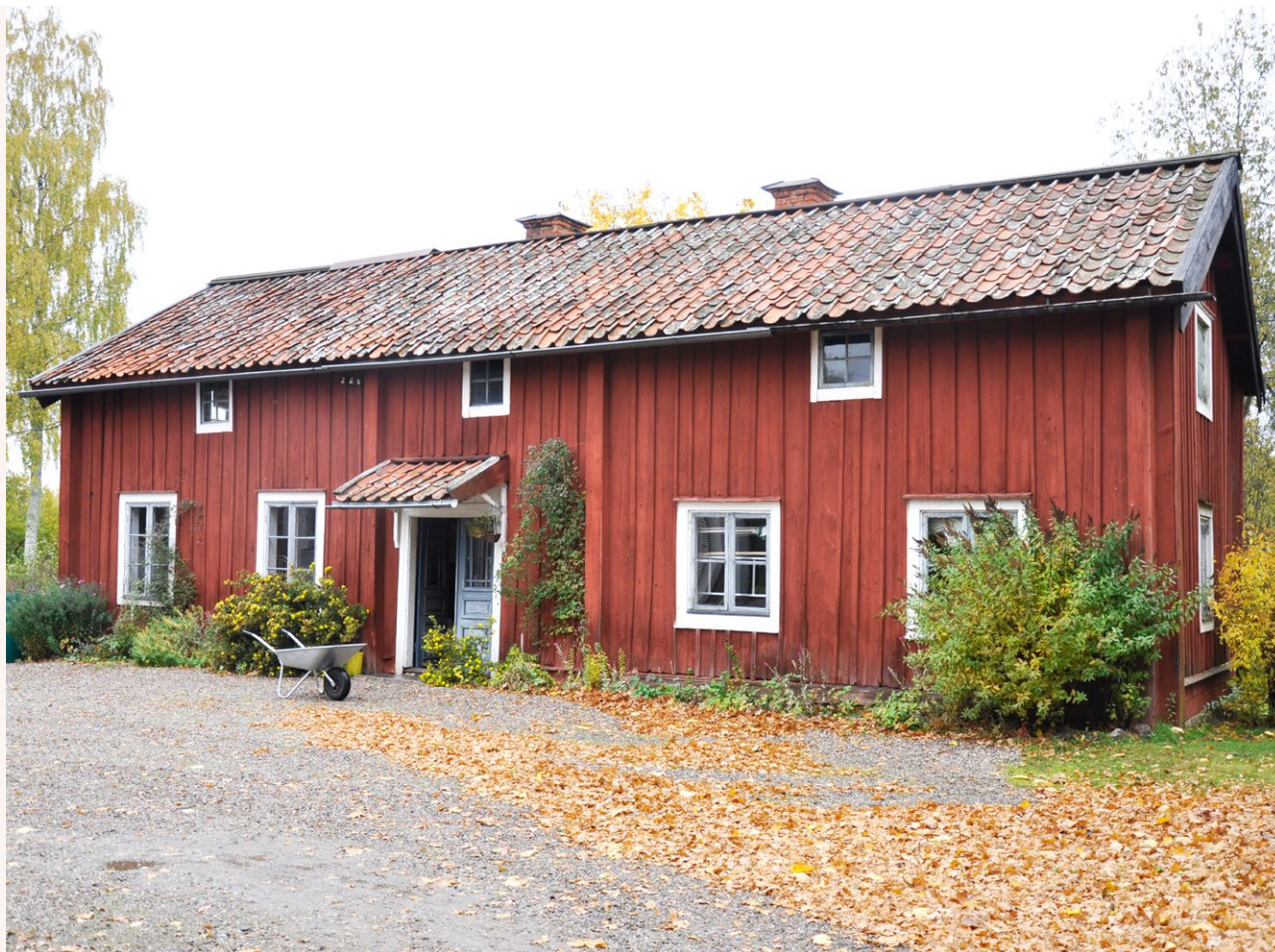
■ Timrad flygelbyggnad klädd med falurödfärgad locklistpanel, troligen från 1880-tal. Snickerier är blå- och vitmålade och sadeltaket täckt av enkupigt tegel. Foto: Vlm-abgim-294.
