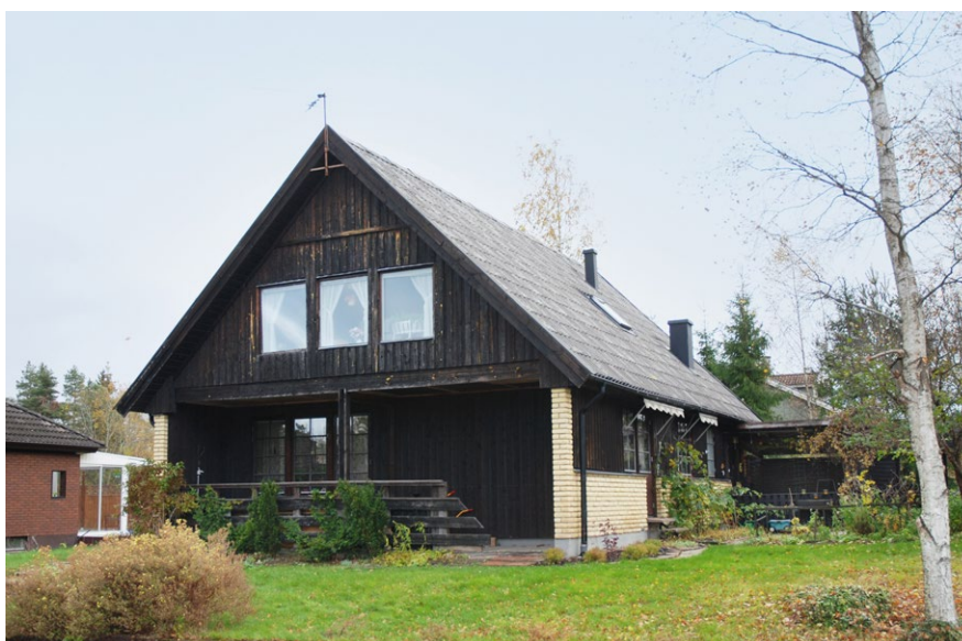
■ Villor i ett och ett halvt plan uppförda i mexisten eller tegel med mörklaserade gavelrösten och trädetaljer. Foto: Vlm-abgls-769 och Vlm-abgls-764.
