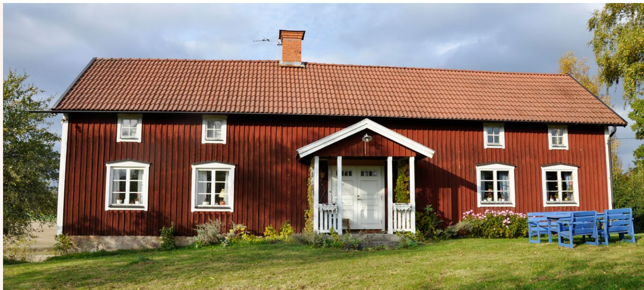
■ Mangårdsbyggnad från 1800-talets början. Uppförd i en och en halv våning med faluröd locklistpanel, farstukvist och tegeltäckt sadeltak. Foto: Vlm-abgim-189.
