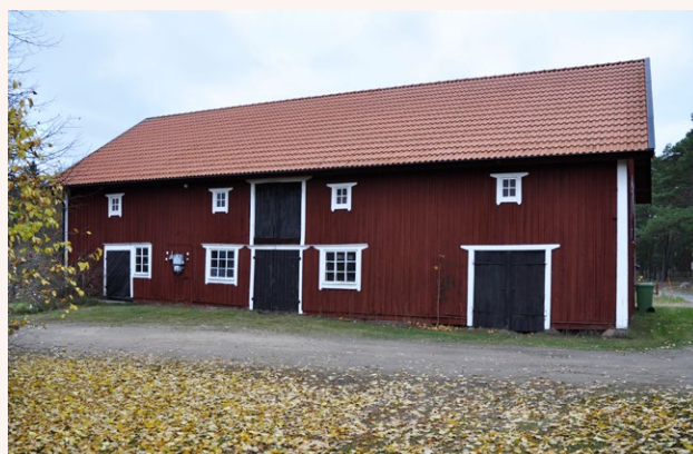
■ Loge i Åsen. Används idag som förråd och har en bevarad traditionell utformning med rödmålad locklistpanel, vitmålade snickerier och tegeltäckt sadeltak. Foto: Vlm-abgfe-1188.
