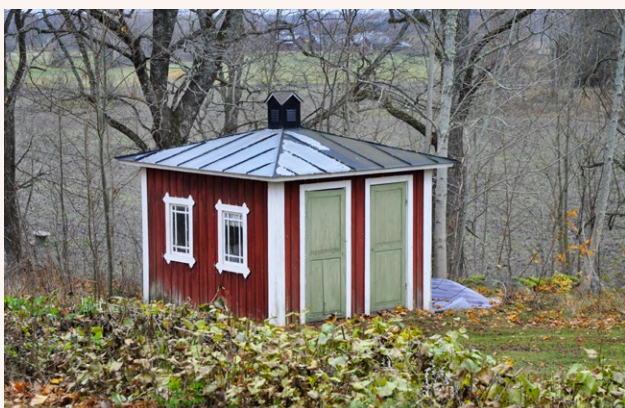
■ Dubbeldass i Åsen. Fasaden är klädd i stående locklistpanel och taket lagt med svartmålad bandplåt. Foto: Vlm-abgfe-1187.
