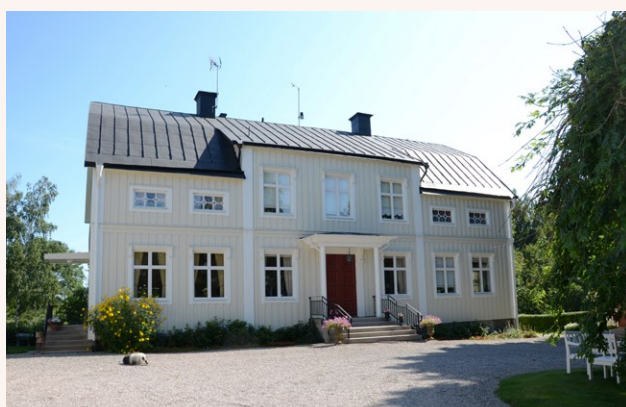
■ Mangårdsbyggnad uppförd 1871-1872 under ledning av byggmästare Söderlund. Byggnaden har ljusmålad träpanel, frontespis och brutet plåttäckt tak. Foto: VIm-abgls-1349.
