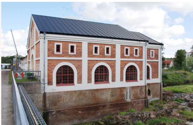
■ Kraftstationen från 1914 vid Jädersbruk uppförd i rött tegel med ljusputsade fönsteromfattningar, listverk och pilastrar. Foto: Vlm-abgfe-373.
