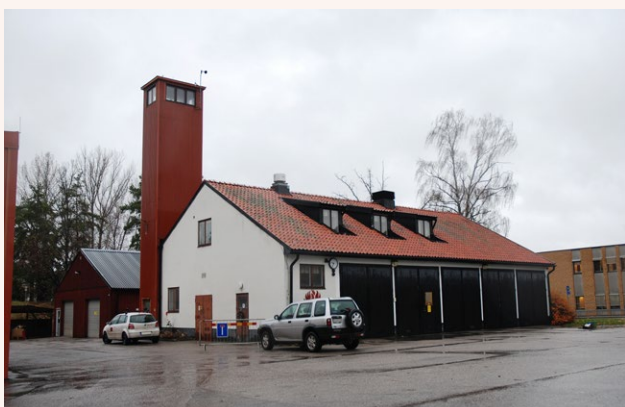
■ Brandstation från 1950-talet. Används idag som förrådsbyggnad. Foto: Vlm-abgls-978.
