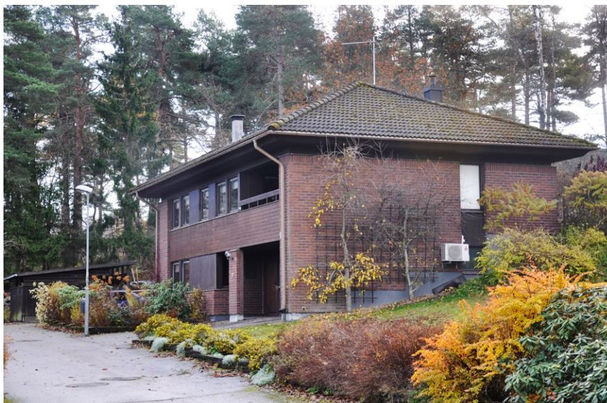
■ Villor i brunt tegel och brunmålad träpanel. Villorna är anpassade efter terrängen och på tomterna finns besparade tallar. Foto: Vlm-abgim-468 och Vlm-abgim-467.
