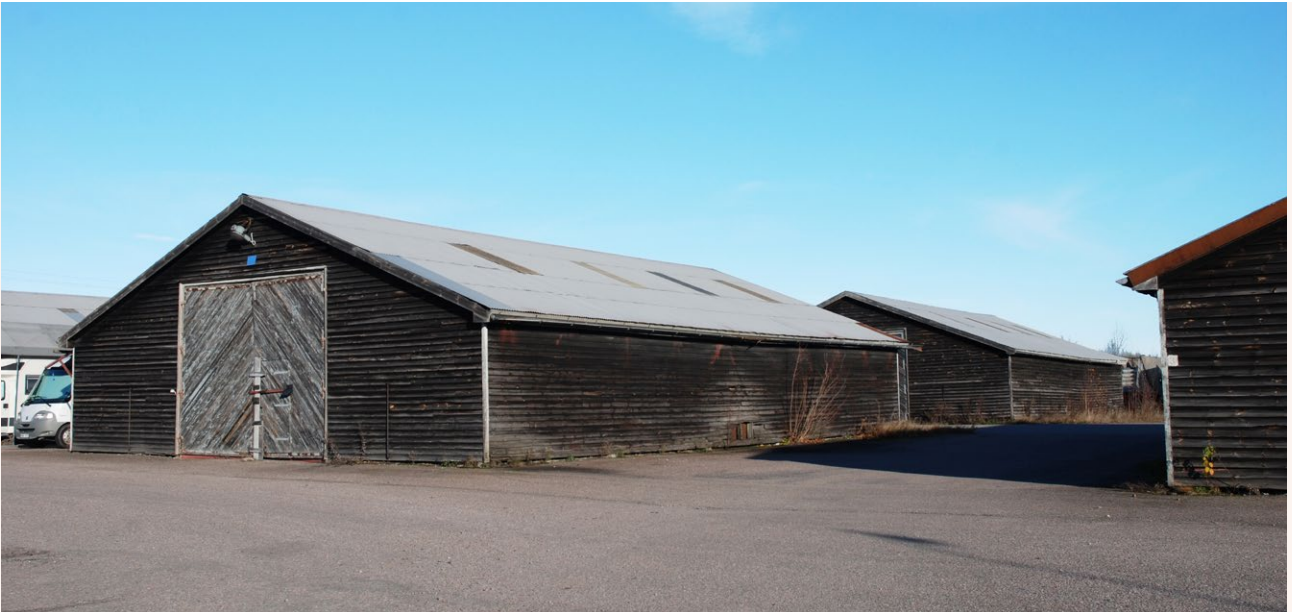
■ Större förrådsbyggnader inom kvarteret Braxen med liggande träpanel och flacka sadeltak täckta med plåt. Foto: Vlm-abgls-1212.
