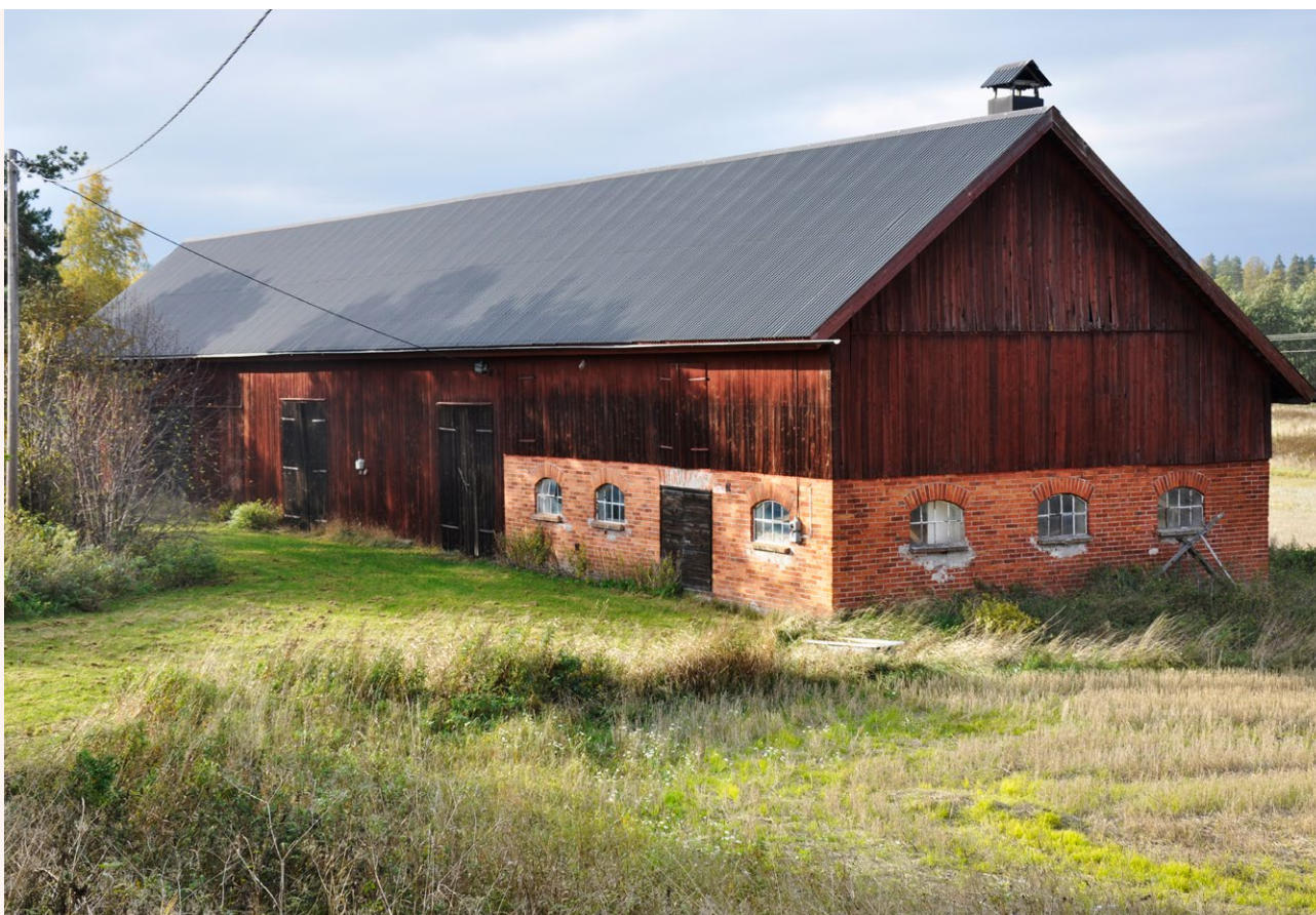
■ Ladugård och loge med del för djurhållningen i murat rött tegel och med småspröjsade fönster. Sadeltaket är plåttäckt. Foto: Vlm-abgim-191.
