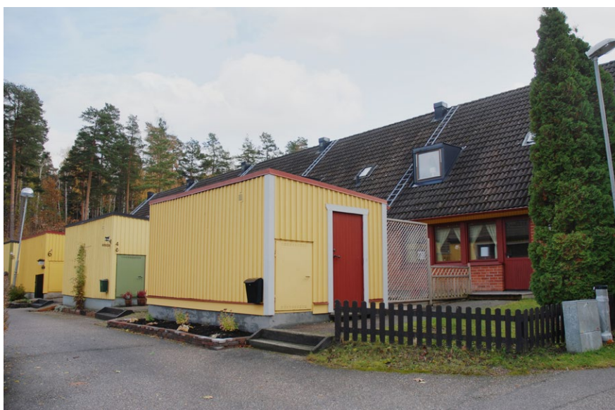
■ Radhus och friliggande villor med tillhörande förråd och garage. Byggnaderna har röd- eller gulmålad träpanel i kombination med rött tegel. De branta sadeltaken har betongtegel. Foto: Vlm-abgls-806 och 809.
