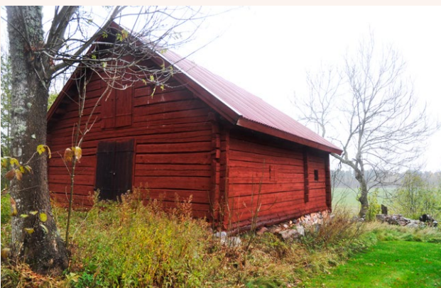
■ Bod i rödfärgat liggtimmer med utknutar och ett sadeltak täckt av plåt. Foto: Vlm-abgsb-29.
