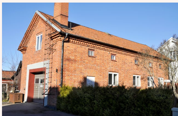
■ Byggnader med koppling till industriell verksamhet uppförda med falurödfärgad träpanel eller rött tegel med dekorativ mönstertegling vid takfot. Foto: Vlm-abgim-550 och Vlm-abgim-558.
