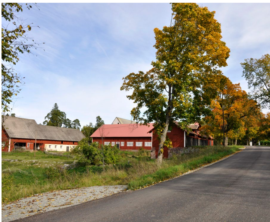
■ Faluröda ekonomibygnader rätvinkligt placerade i Sickelsjö. Den asfalterade vägen är kantad av stora lövträd. Foto: Vlm-abgls-2132.
