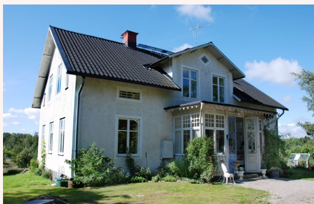
■ Bostadshus med ljus spritputs i Jädersby, uppfört 1890-1900. Foto: Vlm-abgfe-198.
