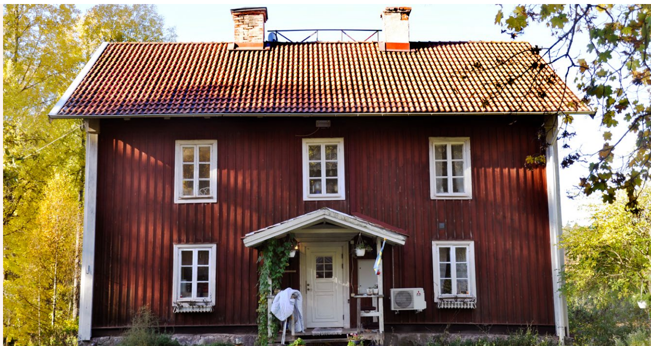
■ Vallbytorp troligen uppförd under andra halvan av 1800-talet. Byggnaden har rödfärgad locklistpanel, vitmålade snickerier och ett tegeltäckt sadeltak. Foto: Vlm-abgim-300.
