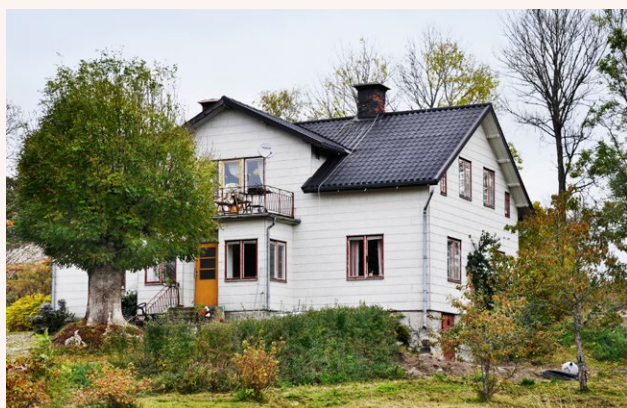
■ Mangårdsbyggnad med fasad av eternit. Foto: Vlm-abgim-175.
