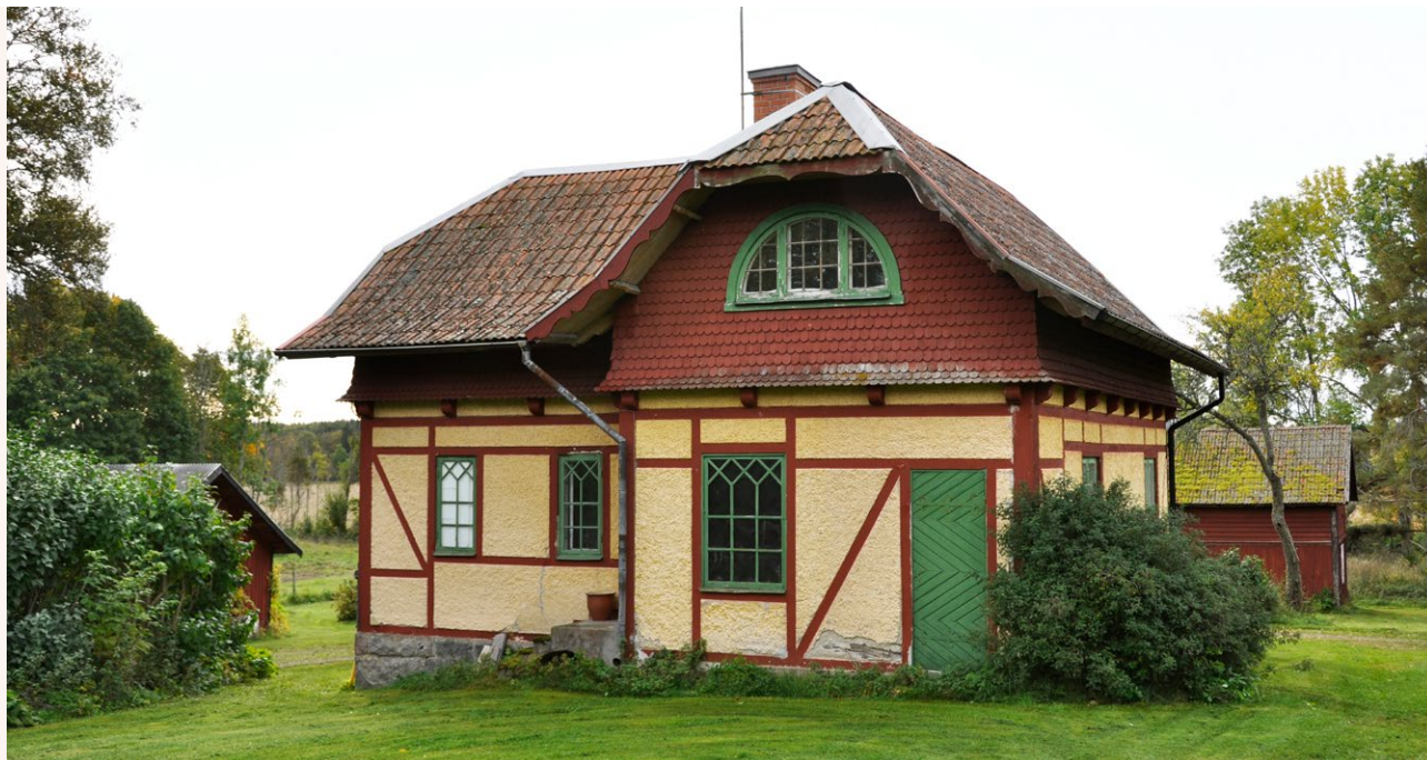
■ Trädgårdsmästarebostad uppförd vid 1900-talets början i nationalromantisk stil och falskt korsvirke. Bygganden har gul puts med rödfärgade putsdetaljer, dekorativa snickerier och rödfärgat träspån. Arkitekt: Albert Teodor Gellerstedt. Foto: Vlm-abgls-2082.
