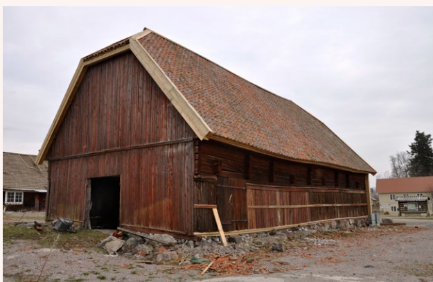
■ År 2011 genomfördes stora restaureringsåtgärder för att bevara vedboden/kolladan. Här med renoverad konstruktion och nylagt tak. Foto: Vlm-kmvfe-1105.
