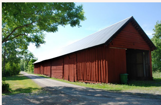
■ Längs byvägen ligger en timmrad faluröd loge från omkring 1850. Sadeltaket är täckt med plåt. Foto: Vlm-abgls-1311.
