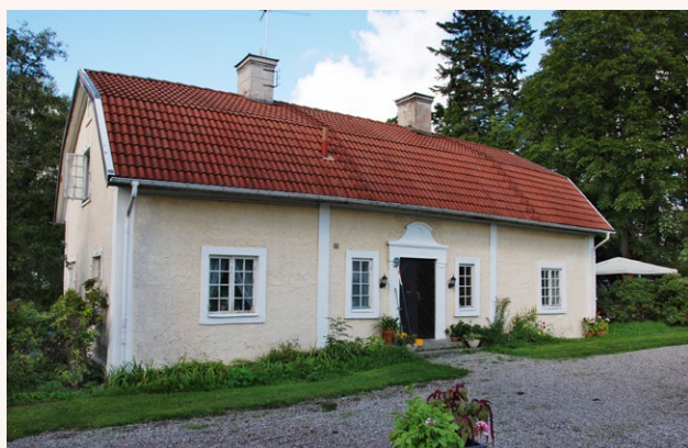
■ Flygelbyggnad till Jädersbruks herrgård. Byggnaden är troligen uppförd i slutet av 1600-talet och har spritputsade fasader och brutet tegeltak. Foto: Vlm-abgfe-360.
