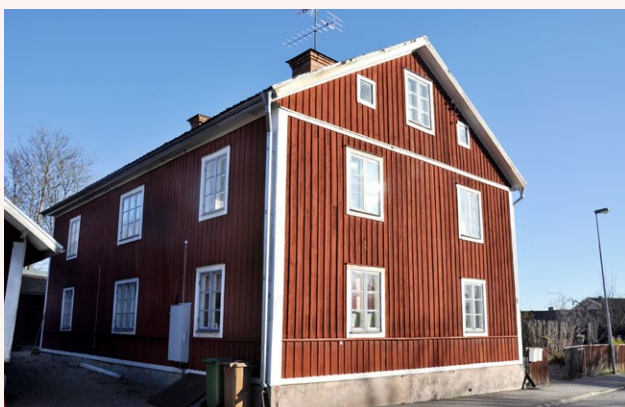
■ Byggnader med koppling till industriell verksamhet uppförda med falurödfärgad träpanel eller rött tegel med dekorativ mönstertegling vid takfot. Foto: Vlm-abgim-550 och Vlm-abgim-558.
