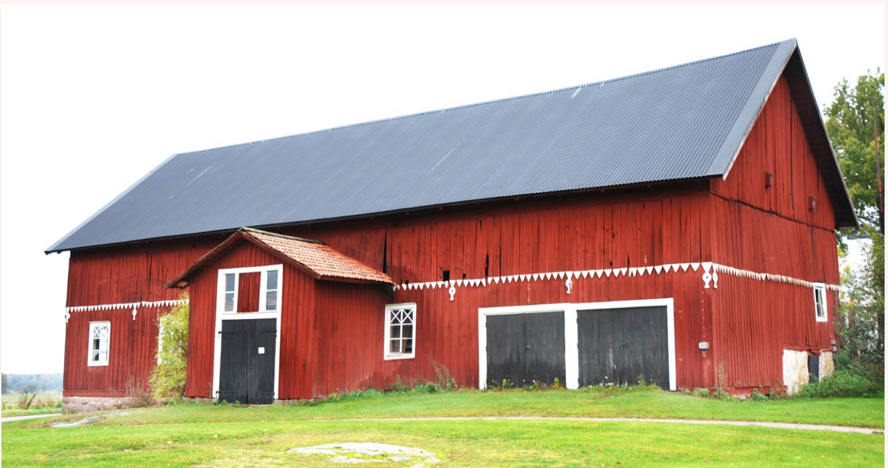
■ Ladugård uppförd på 1870-talet med faluröd träpanel, vitmålade dekorativa snickerier, svartmålade dörrar och plåttäckt sadeltak. Notera den ovanliga utformningen på de vita dekorativa snickerierna. Foto: Vlm-abgls-264.
