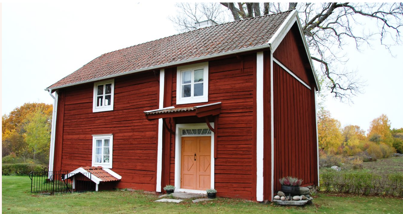
■ "Närkestuga" från cirka 1790–1820. Uppförd i liggtimmer och delvis klädd med falurödfärgad stående panel. Foto: Vlm-abgsb-451.
