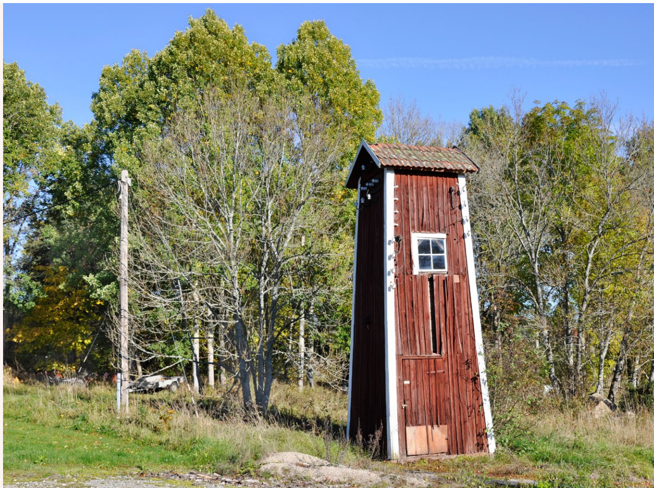
■ Äldre transformatorstation med faluröd träpanel placerad i höjdläge invid Medåkers kyrka. Transformatorstationen är en av tre kvarvarande i Medåker och en av få bevarade i kommunen. Foto: Vlm-abgls-60.
