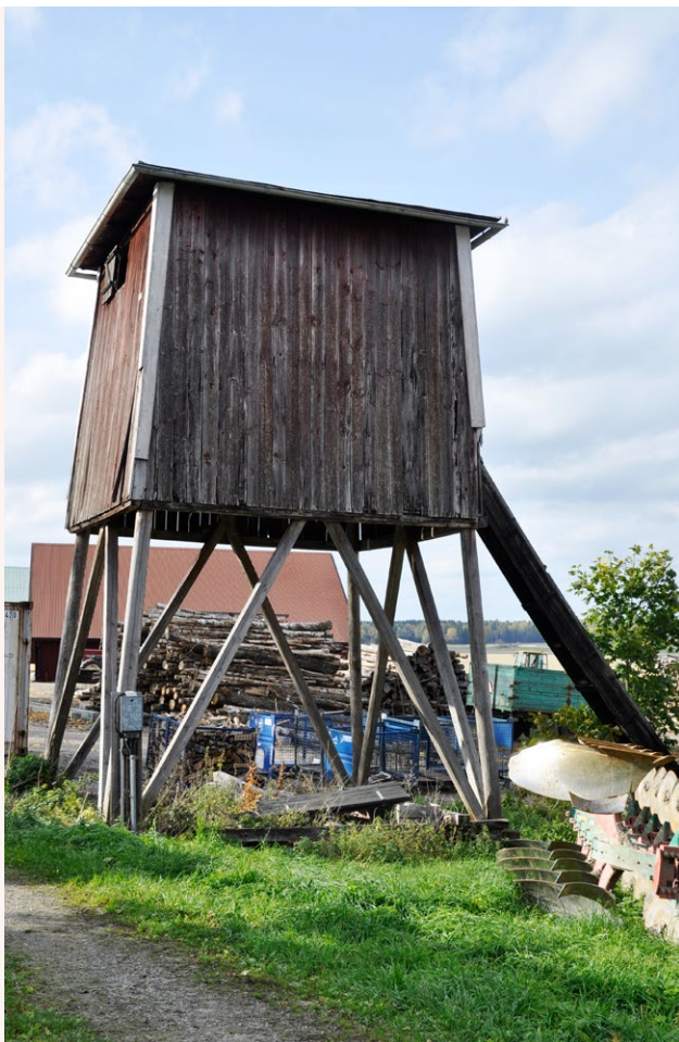
■ Vedtorn byggt omkring 1950 för förvaring av ved. Vedtorn förekommer på flera platser i Medåker och är ett exempel på en för Medåker unik byggnadskategori. Foto: Vlm-abgim-81.
