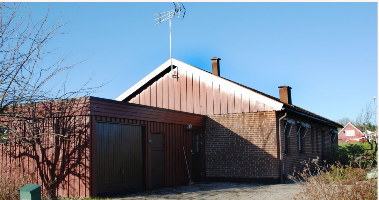
■ Garage med platt papptak och bostadshus med sadeltak lagt med betongpannor. Foto: Vlm-abgls-1077.
