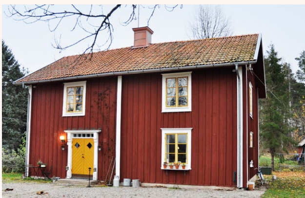
■ Bostadshus uppfört 1862 i timmer med rödmålad locklistpanel, dörr med överljusfönster och vitmålade snickerier. Foto: Vlm-abgfe-1209.
