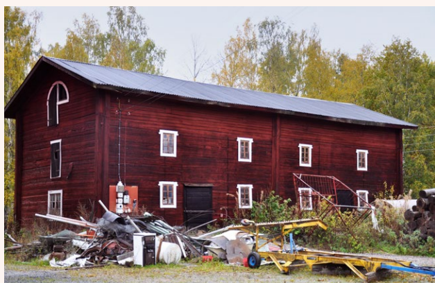
■ Timrat falurött magasin med svartmålade dörrar, vitmålade snickerier och sadeltak täckt av plåt. Foto: Vlm-abgim-237.
