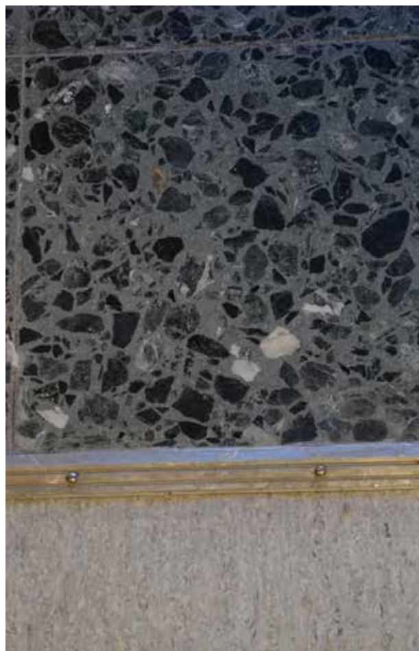
Golv och tröskel i metall in mot kontor.
