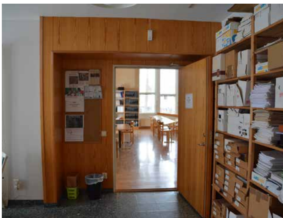
Ingång från korridor till musiksals med överstycke i laserad furu. Vlm_kmvSB-3272.
