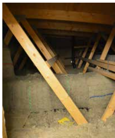
Vindsutrymme i tillbyggnadens. VIm-modkaVB-1231.
