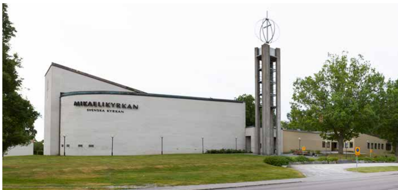
Kyrkobyggnaden sedd från nordväst. Här syns tydligt hur tillbyggnaden från 1980-talet är anpassad i volym och material till den äldre byggnadsdelen, men har en annan färgsättning.
