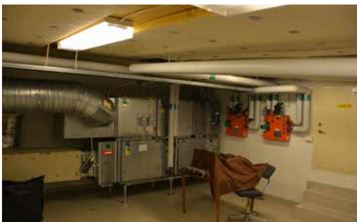
Fläktrum i tillbyggnadens vind. Vlm-modkaVB-1221.
