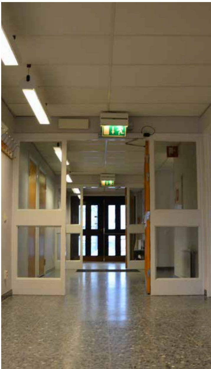
Korridor och entré i kyrkans tillbyggnad. Vlm_kmvSB-3276.
