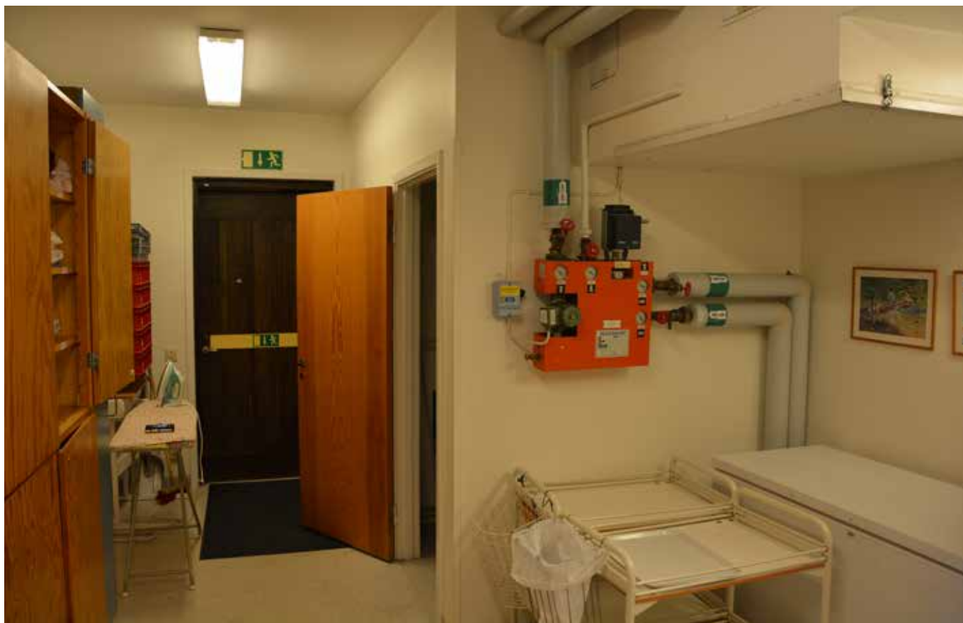
Hall med nödutgång som ansluter till städskrubb, WC, kök, förråd samt kontor. Vlm-modkaVB-839.
