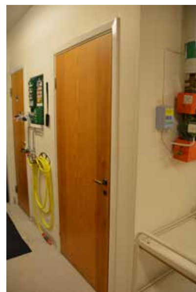
Dörr i in till städskrubb i hall. Vlm_kmvSB-3257.
