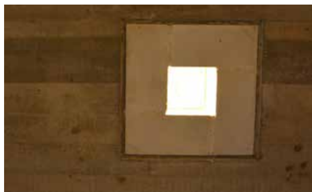
Betongtak med synligt mönster efter träform och armturanordning. Vlm-modkaEK-3818.
