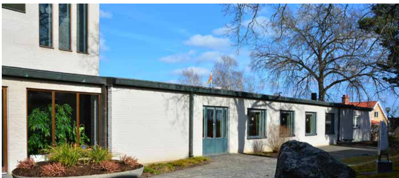
Kyrkobyggnadens äldre del med den tillbyggda köksdelen sedd från innergården. Vlm-modkaVB-1103.
