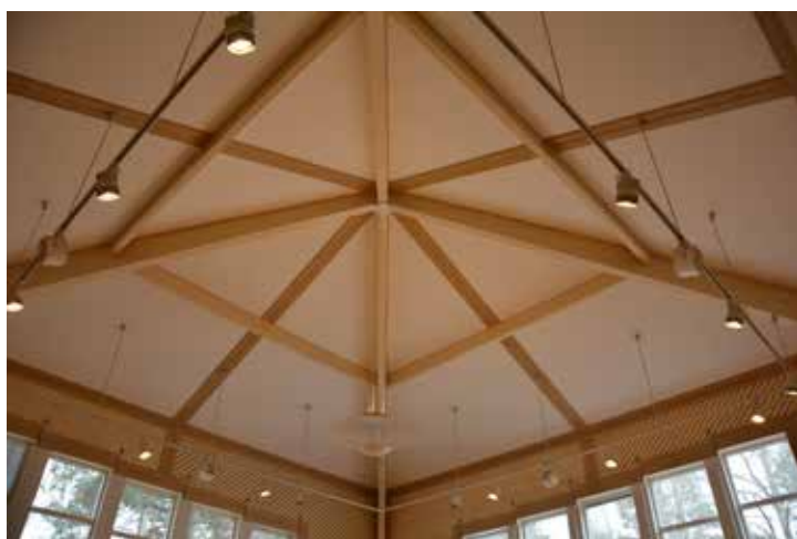
Musiksalens tak med limträbalkar och en kvadratisk armaturanordning med stora spotlights riktade åt olika håll. Vlm-modkaVB-1108.
