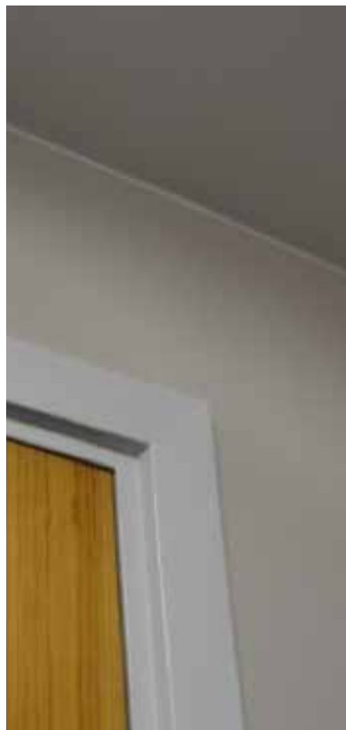
Vägg, tak, dörr och dörrlist. Vlm_kmvSB-3262.
