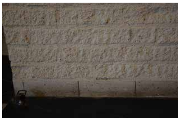
Vägg av råhuggen kalksandsten och sockel av ljusgrå specialbetongsten i cementmosaik. Vlm-modkaEK-3828.
