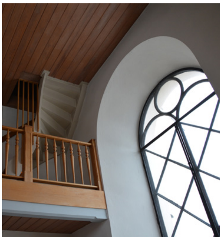
Fönster med innerfönster av svartmålat järn samt balkong med trapp som leder upp till tornkammaren. Vlm-modkaVB-799.
