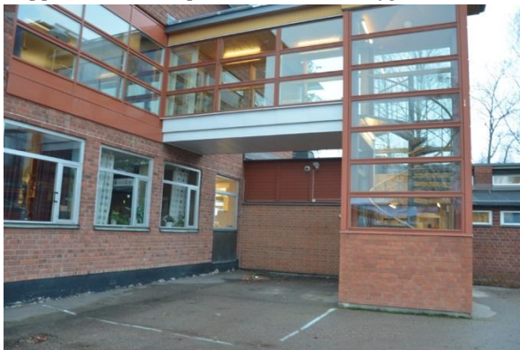
T.v: Den igensatta balkongen täckts at tegelfärgad plåt. T.h: En vägg skymmer naturligt ljus att komma in i trapphallen. Bild: vlm-kmvjg-6554, vlm-kmvjg-0303.
