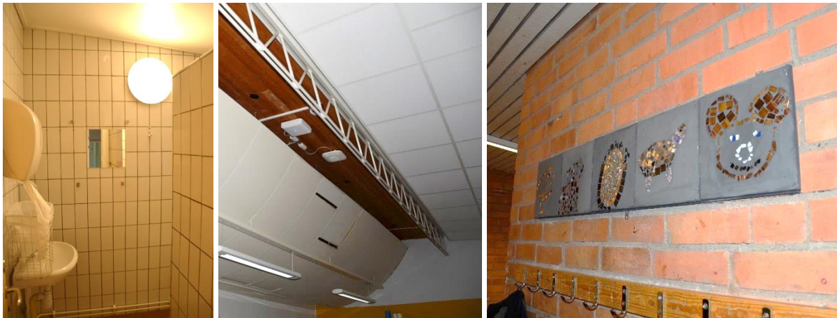
T.v: Toalett med Höganäskakel. Mitt: Fackverksbalk i klassrum. T.h: Konstutsmyckning i kapprum. Foto: Vlm-kmvsb-6593, -6597, -6598
