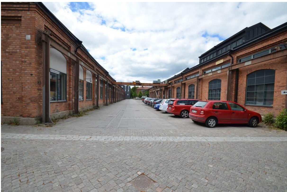
Industribyggnaderna används idag som kontorslokaler, restaurang, bageri och kulturhus.
