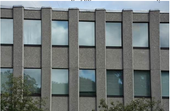
Polishusets fasad i prefabricerade betongelement.
