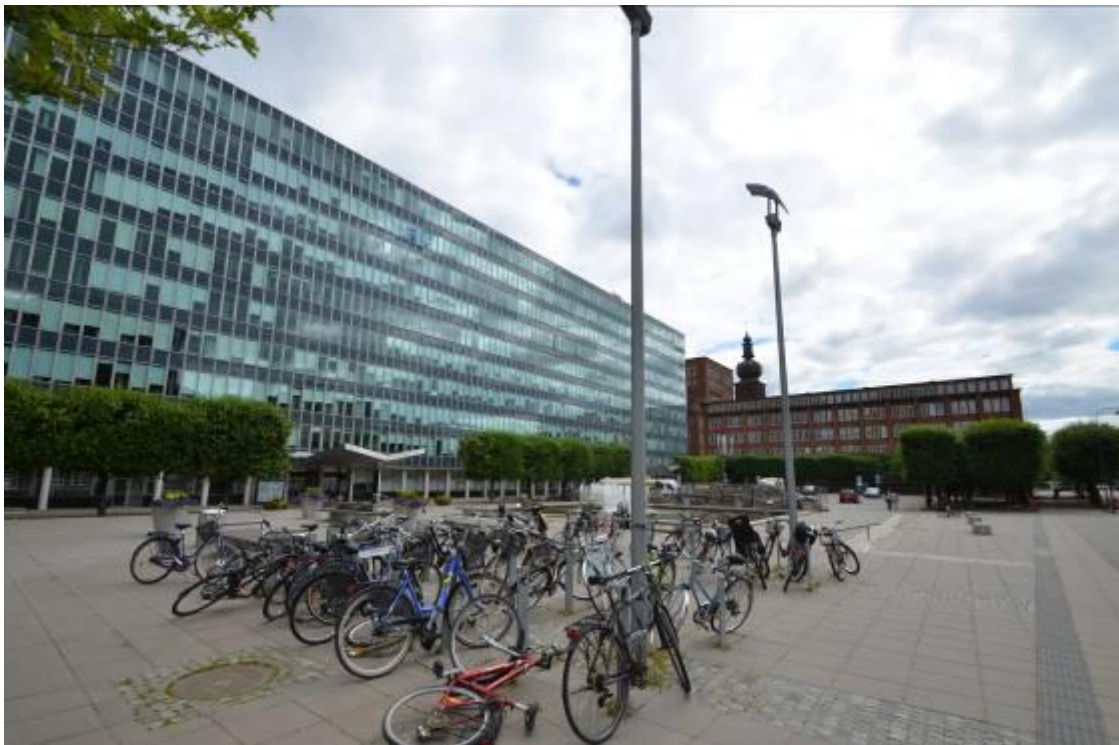
Melkerkontorets modernistiska fasad med det öppna stadsrummet framför. Bakom ritkontoret som uppfördes på 1940-talet synt ASEA-tornet.
