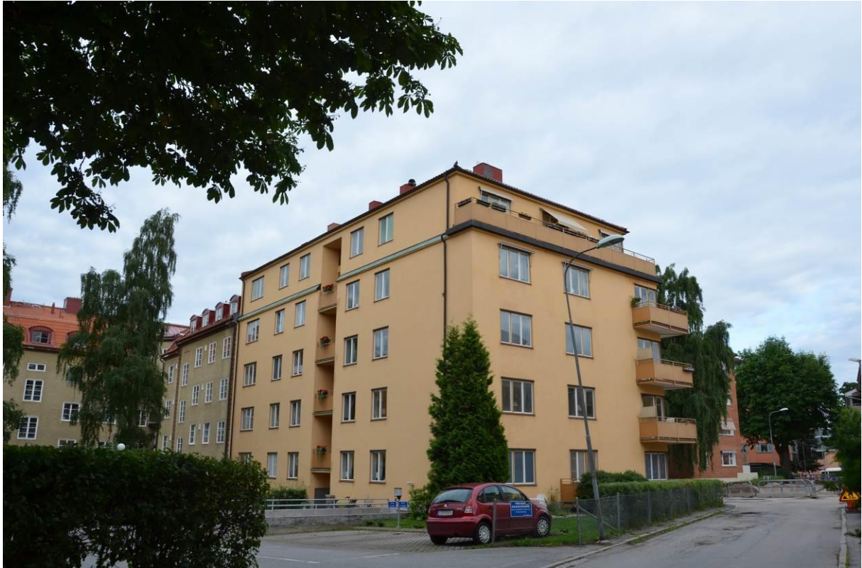
Halvöppna bostadskvarter med tidstypiska arkitektoniskt uttryck vid Djäknebergsgatan.
