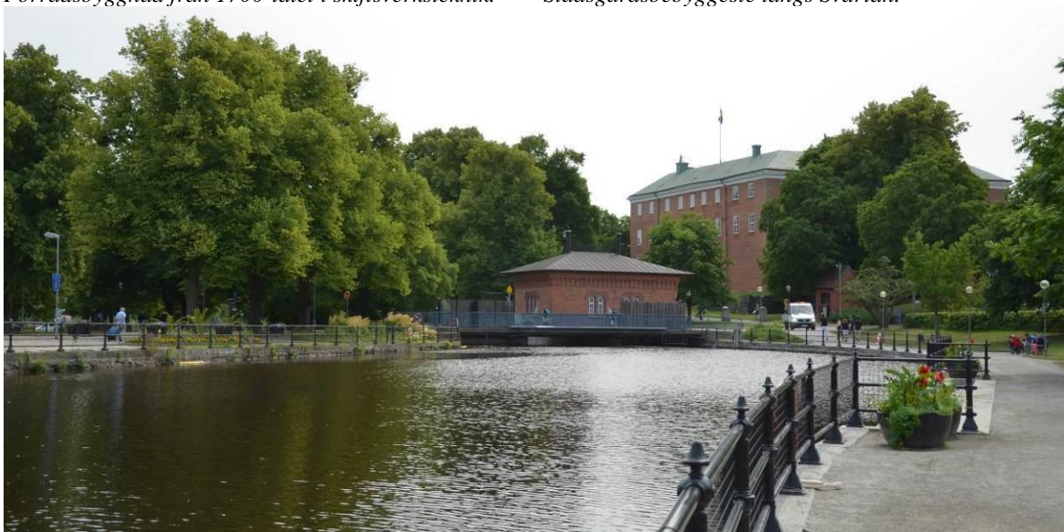
Svartåns kraftverksdam med turbinhus och omgivande parkområde.
