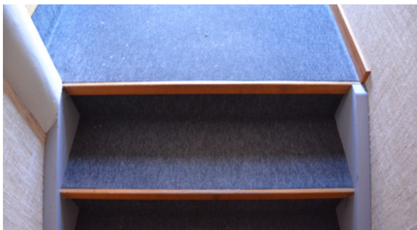
Detalj av heltäckande matta lagd i passage, trapp samt förråd. Vlm-modkaVB-510.
