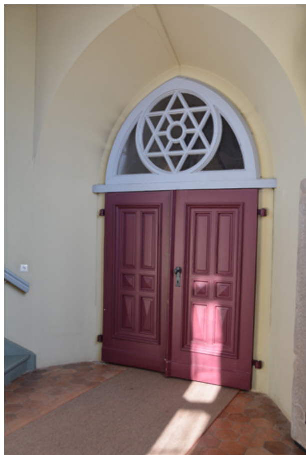
Ny dörr som tillverkades efter äldre förlaga. Vlm-modkaVB-437.
