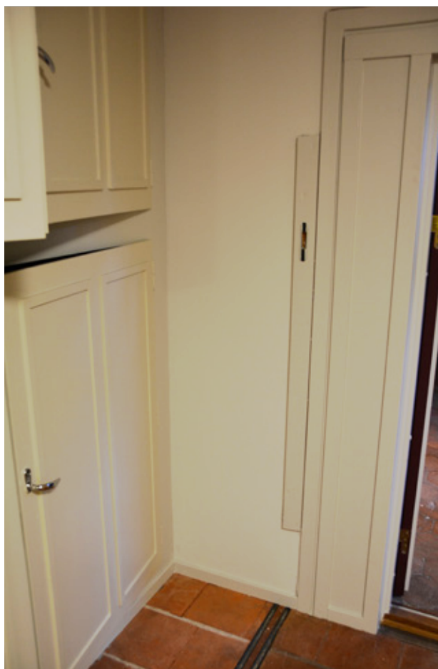
Spår och lås för skjutdörr. Vlm-modkaVB-369.
