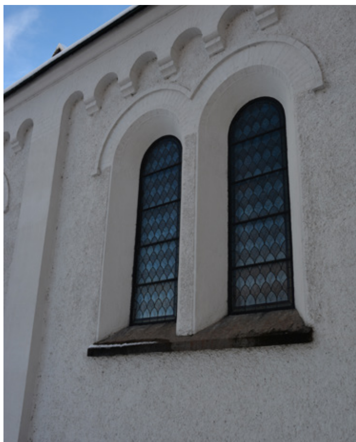
Spritputsat väggfält och slätputsade omfattningar, samt pilaster och rundbågefris. Vlm-modkaEK-3341.
