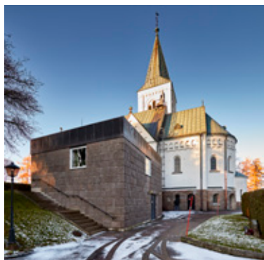
Åren 1968-1969 uppfördes en tillbyggnaden i söder efter ritningar av arkitekt Claes Laurent. Här finns sakristia, rum för samtal och lokaler för bisättning.
