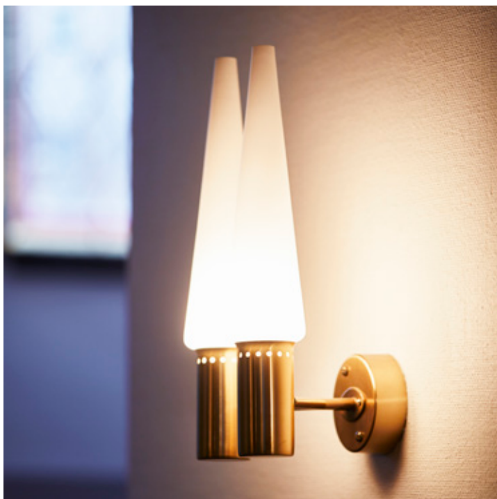
Armaturer under den västra läktaren.
