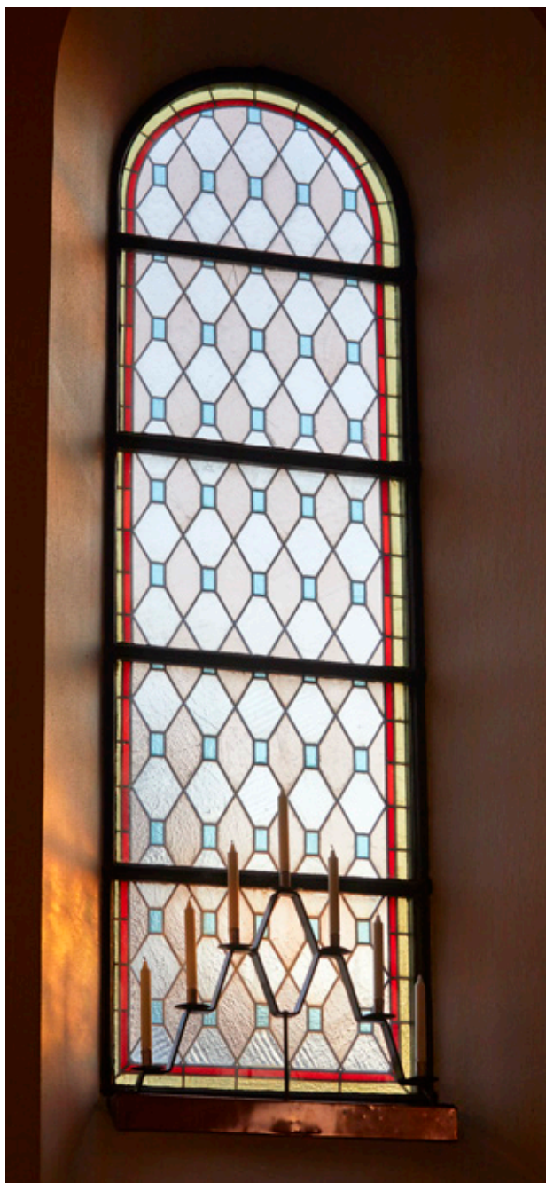
Fönster mot norr.
