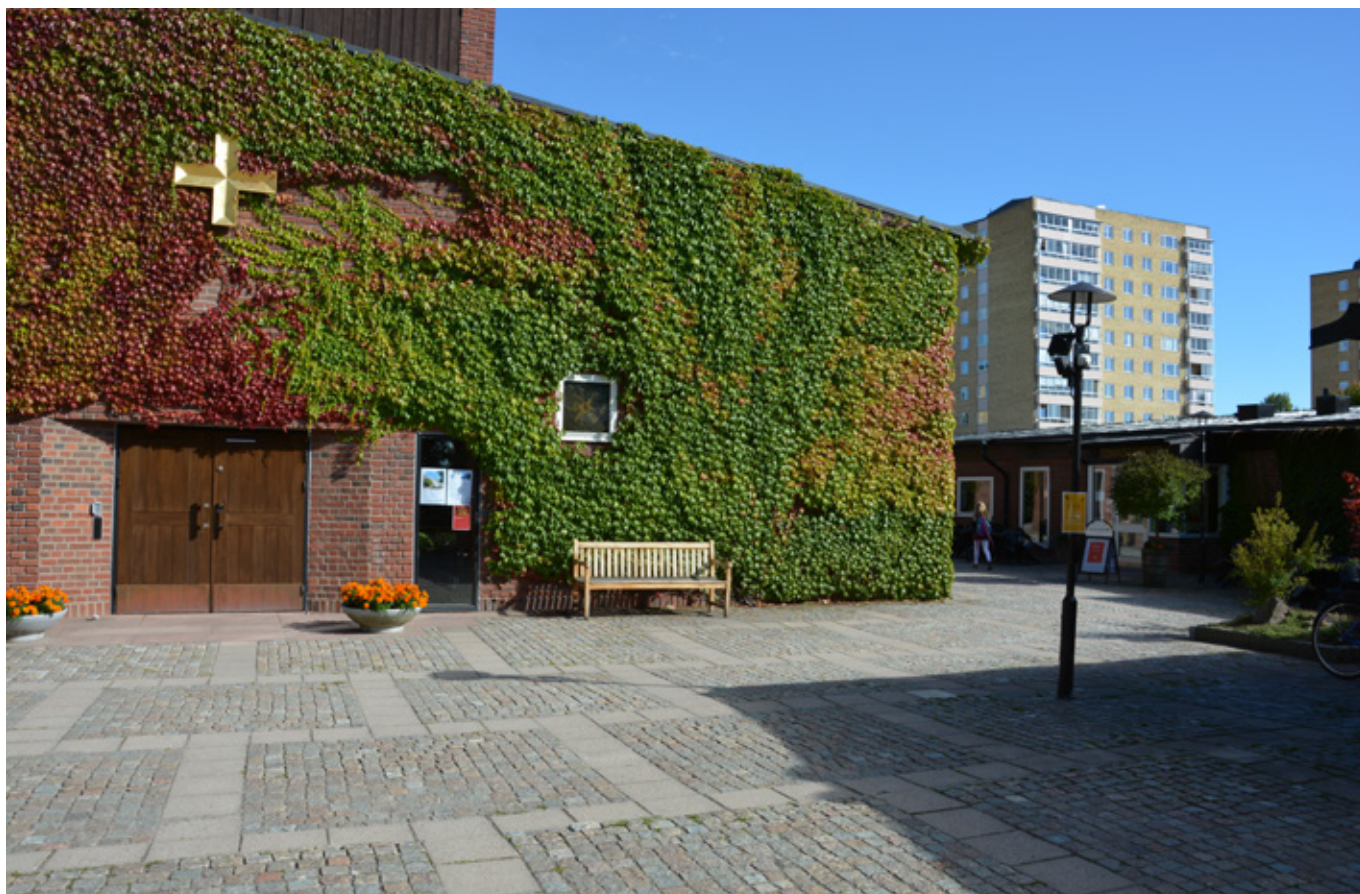
Huvudentré, västfasad, med gårdsutrymmet och södra flygelbyggnaden. Vlm_modkaEK-2818.
