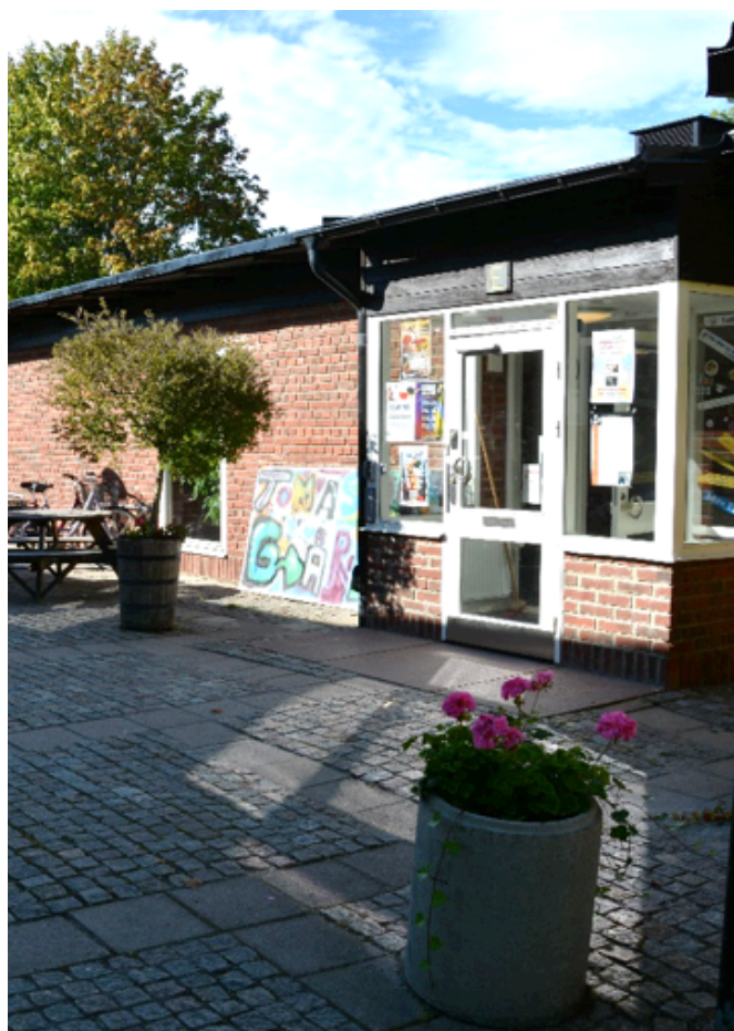
Norra flygelbyggnaden. Vlm_modkaEK-2891.
