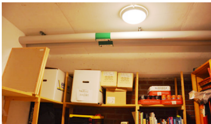
Plafond och tegelvägg i förråd 054. Vlm_modkaEK-2283.
