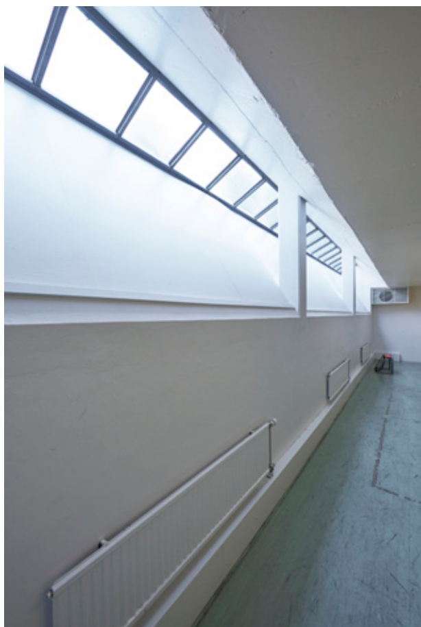
Fönster i idrottslokalen.
