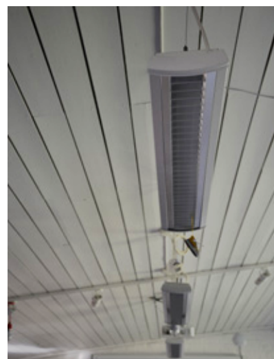
Hängande lysrörsarmaturarmaturer. Vlm_modkaEK-2083.
