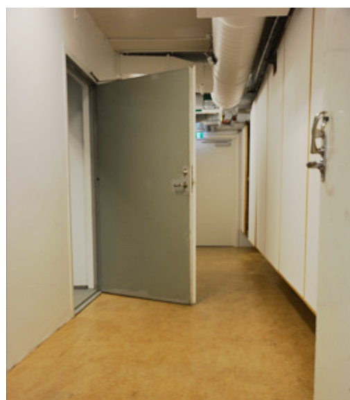
Korridor med öppen dörr fläktrum. Vlm_modkaEK-2304.
