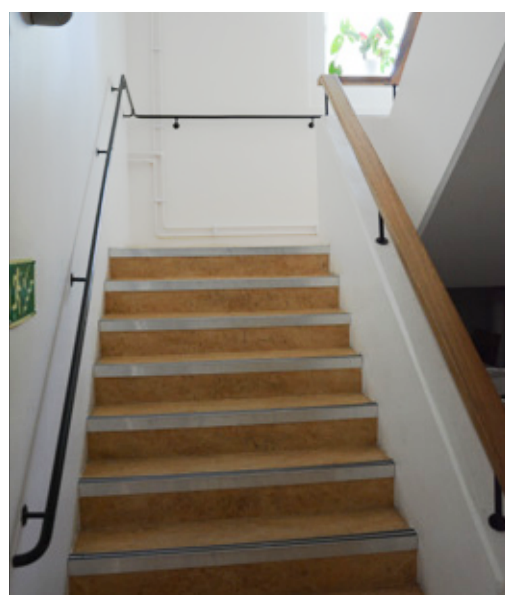
Trappan vid avdelning för ungdomslokaler. Vlm_modkaEK-2279.
