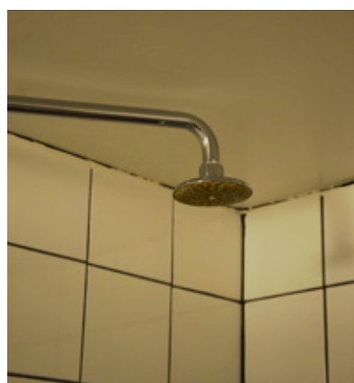
Kaklat väggparti med handfat. Vlm_modkaEK-1828. Äldre dusch. Vlm_modkaEK-1829.
