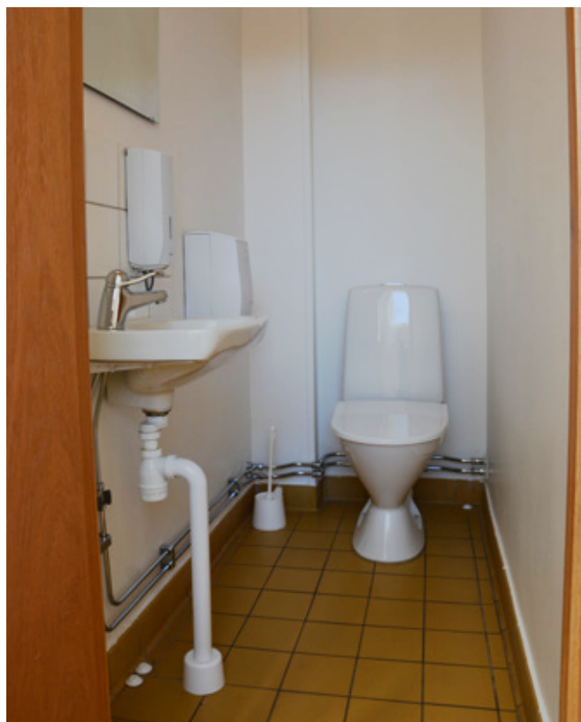
Kaklade golv och golvlister. Vlm_modkaEK-1522.
