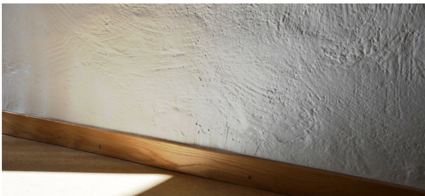
Vägg i konferensrum. Vlm_modkaEK-1599.
