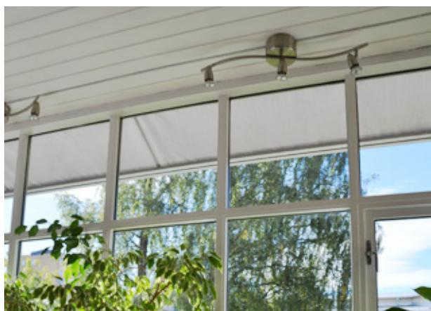
Nyare spotlights i burspråket. Vlm_modkaEK-1383.
