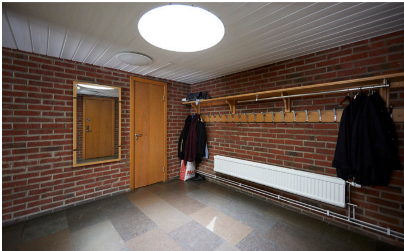
Ljusinsläpp i kapprummet. Senare tillkommen plafond, dörr till toalett och kapphängare.
