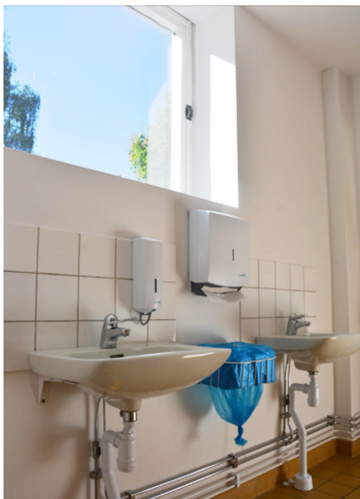
Stort ljusinsläpp i förrummet. Vlm_modkaEK-1503.
