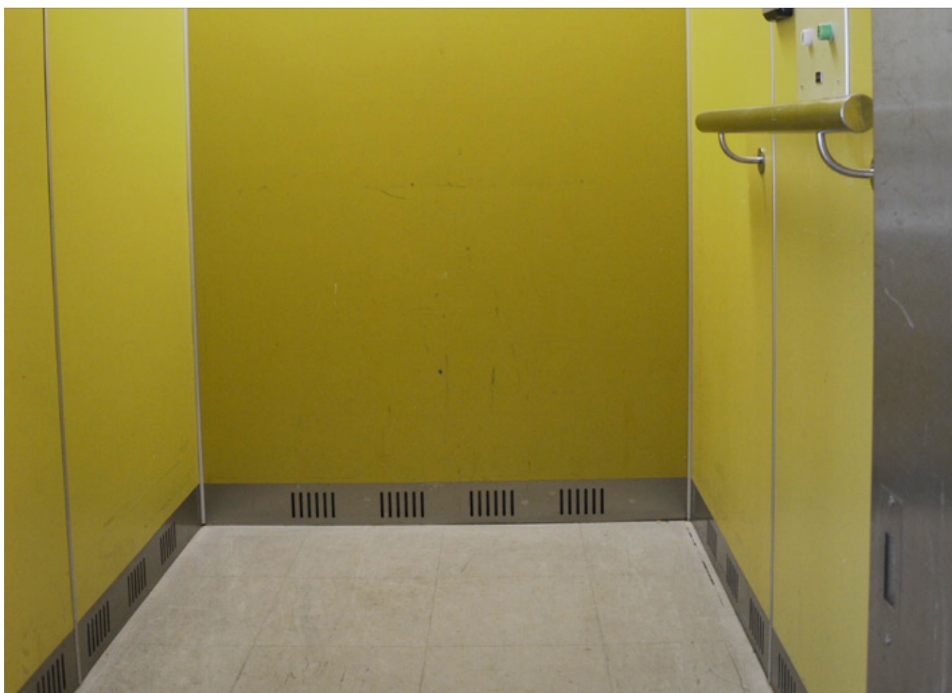
Ursprungliga vägg- och golvmaterial i hissen. Vlm_modkaEK-1527.
