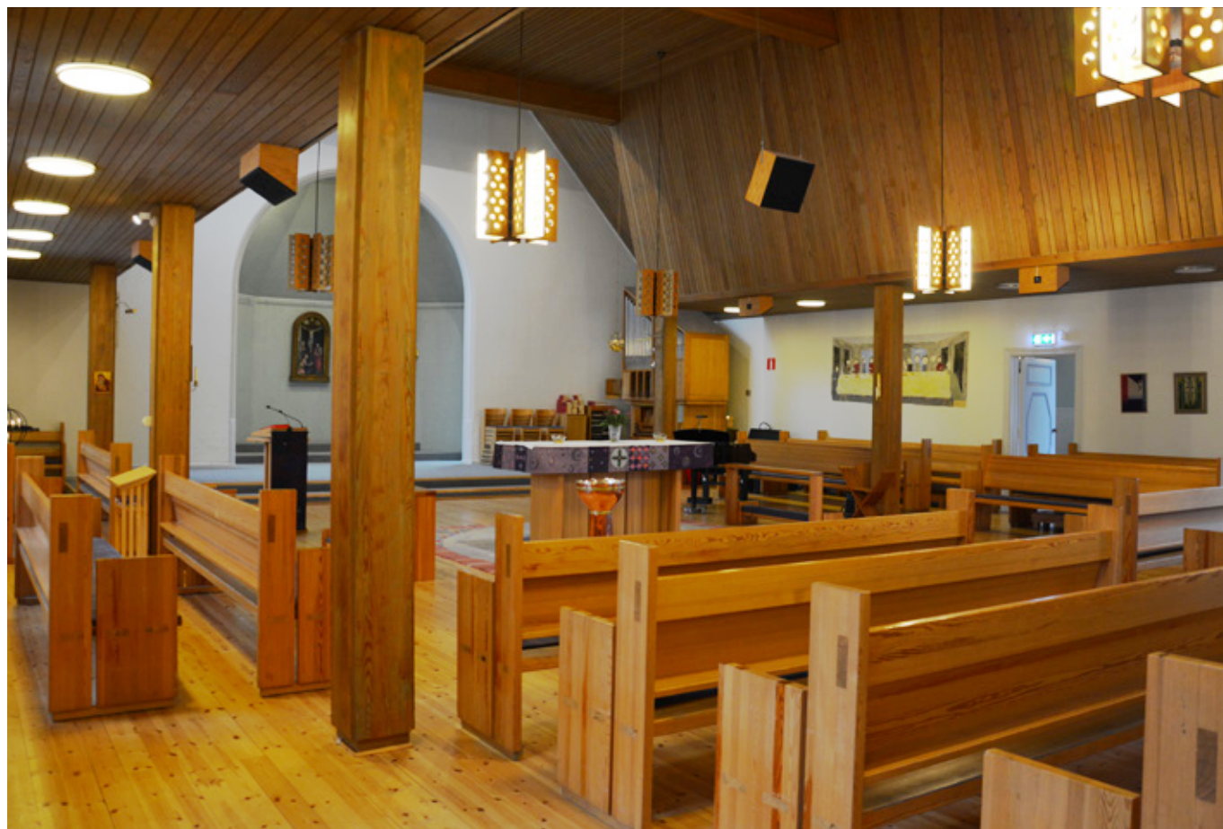
Kyrkorummet med golv, bänkar, inklädda pelare, armaturer och tak av lackad furu. Vlm-modkaEK-3522.
