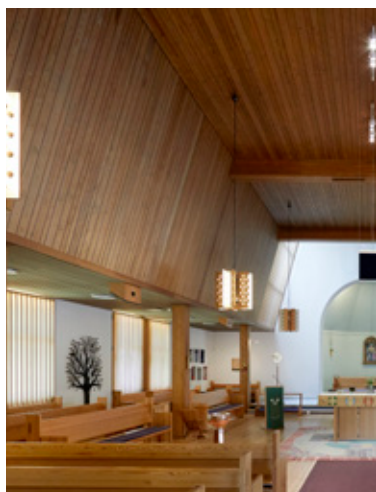
Tresidigt brutet tak av furupanel.
