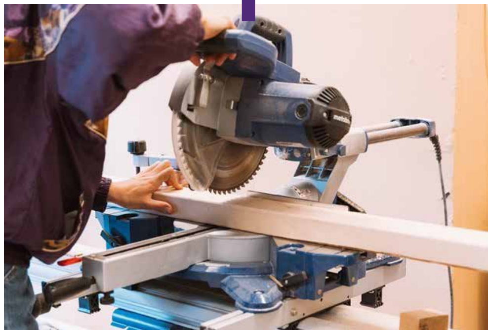
Bild 20: En av gruppens medlemmar använder kapsåg under byggprocessen.
