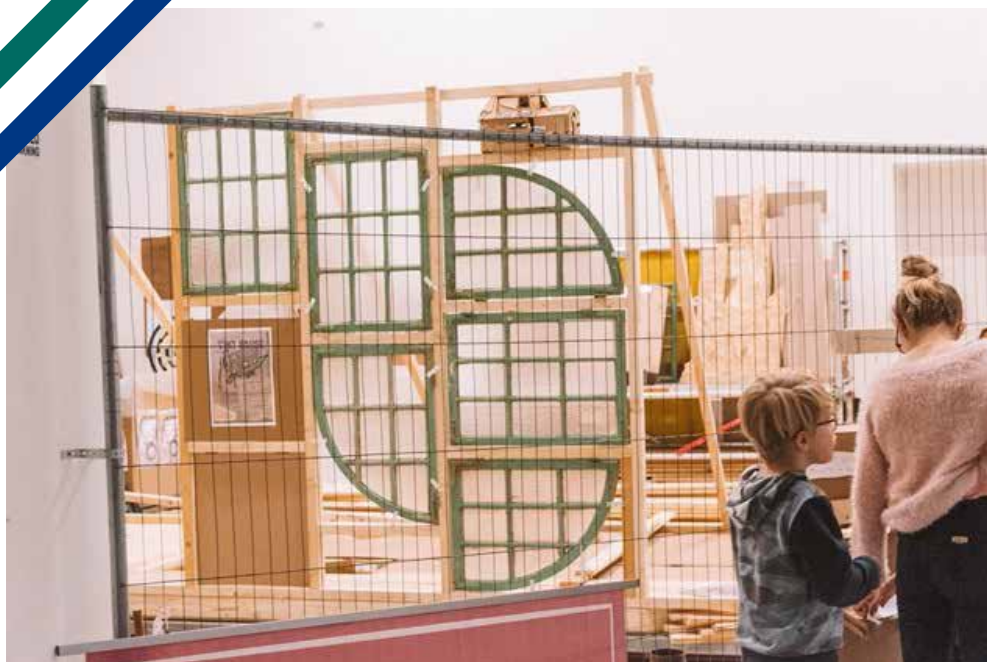
Bild 4: Återanvända fönster som används till en av husets väggar. Fotot är taget under öppningsdagen.
