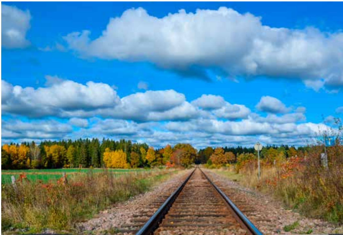
^ Mälarbanan ska fungera som testspår för nya och befintliga produkter, och även som utbildningsplats. Foto: Adobe Stock.
