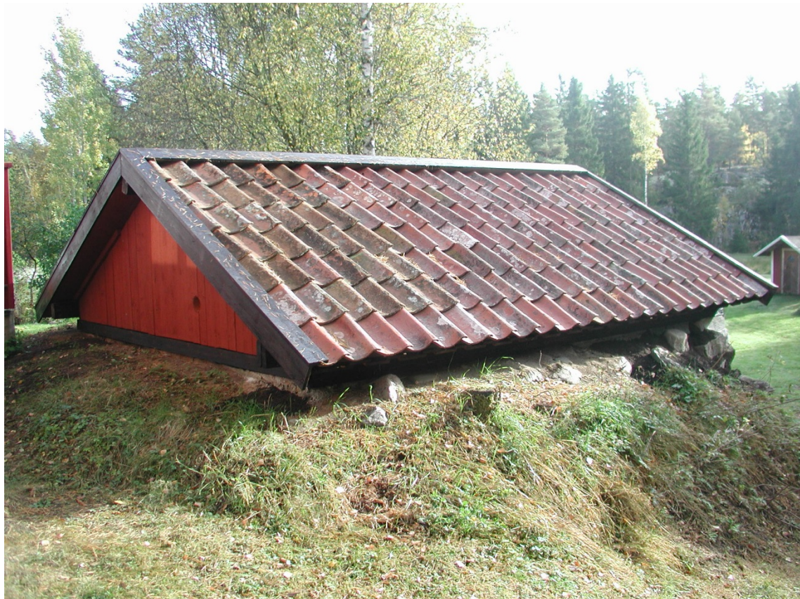
Överbyggnaden är täckt med ett enkupigt lertegel.
