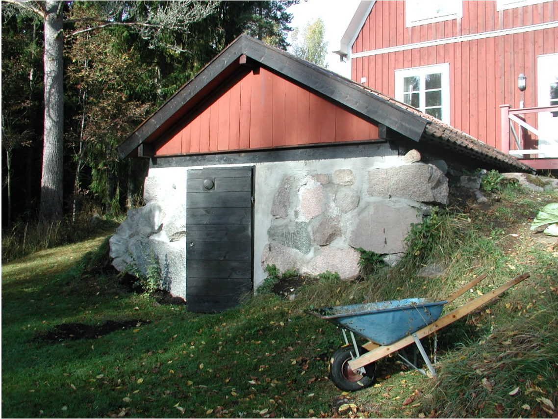
Jordkällarens mur är fogad med kalkbruk.
