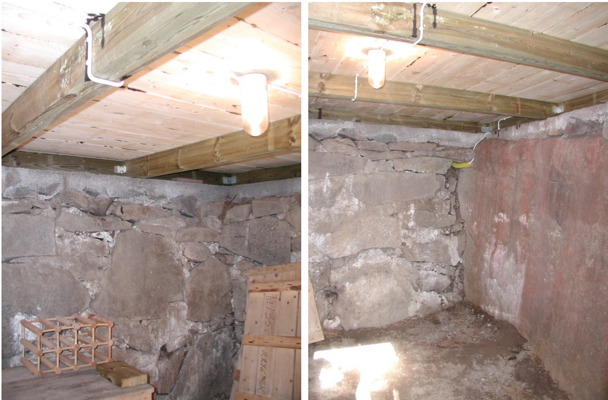
Jordkällaren mur är kallmurad, lagningar i fog är på vissa ställen av grovt cementlikanden bruk.
