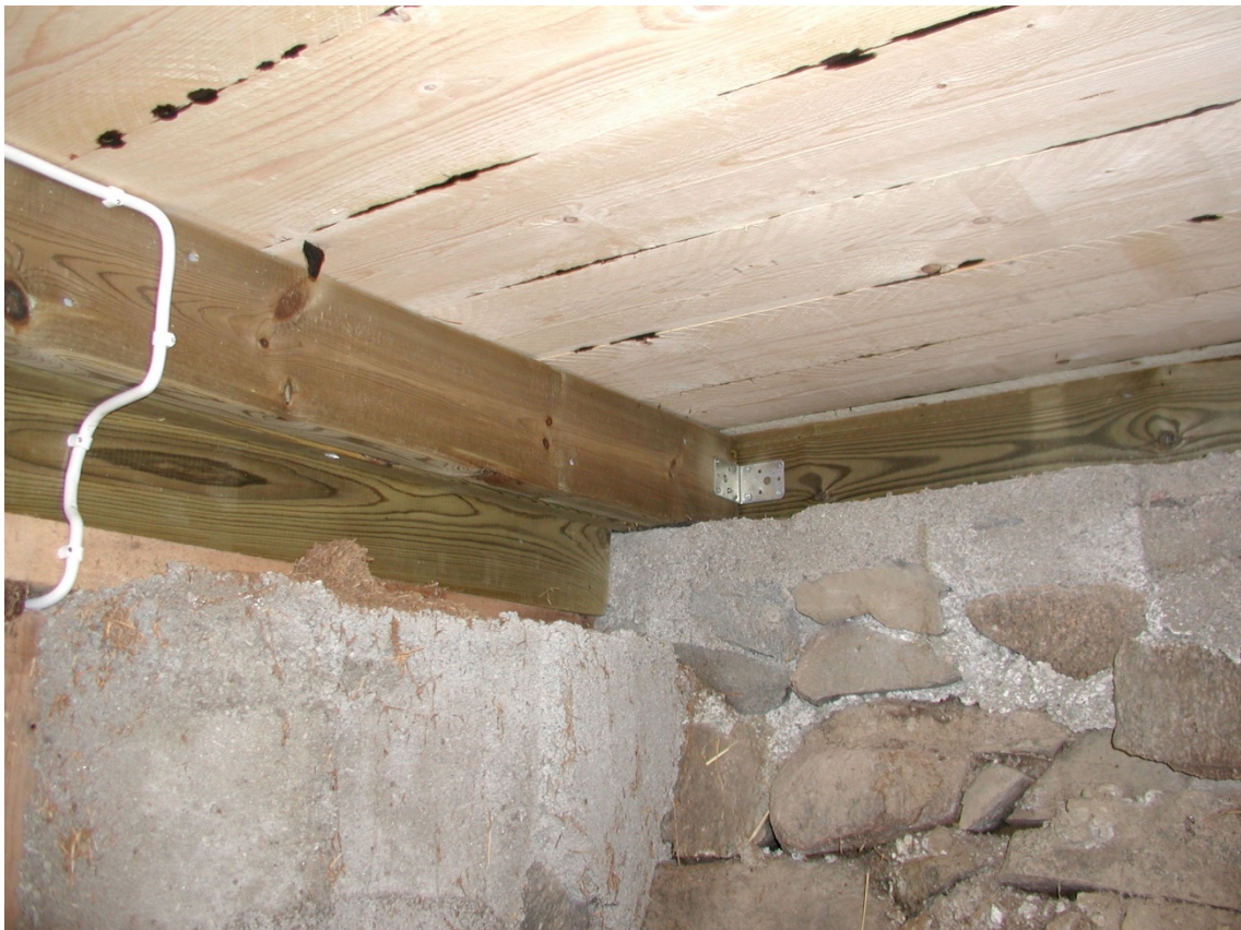
Syllar och takbjälkar ersatt med tryckimpregnerat trä.
