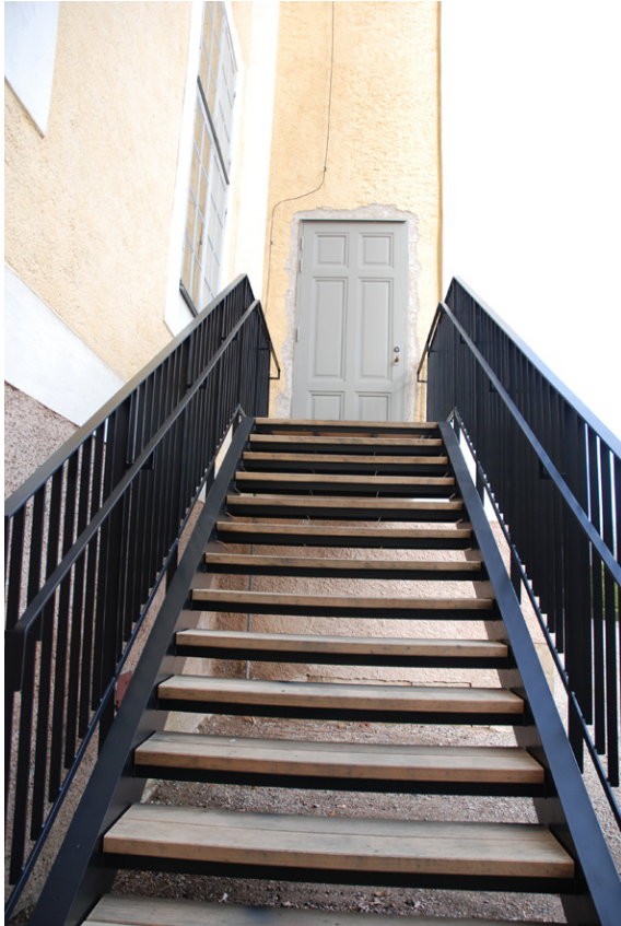
Trappan monterades på fasaden och det nedersta trappsteget vilar på en gjuten plint.
