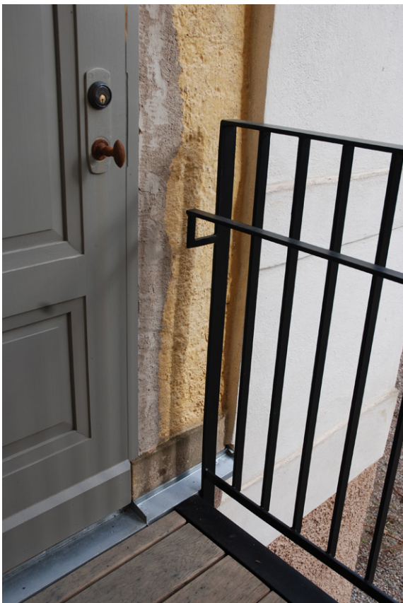
En ytterdörr i ramverk monterades. Trappan fästes med bultar i väggen.
