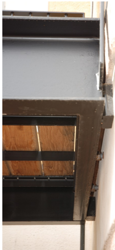
En ytterdörr i ramverk monterades. Trappan fästes med bultar i väggen.
