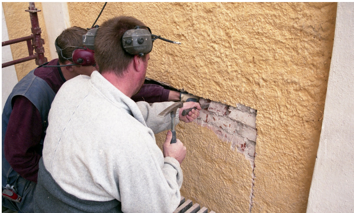
Håltagning i fasaden för dörröppningen.
