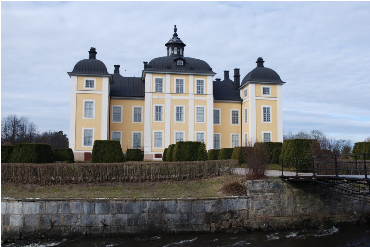
Strömsholms slott mot öster, med nya utrymningstrappan.
