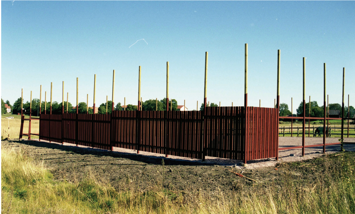
Bild 5: Miljöstationen under uppförande.
