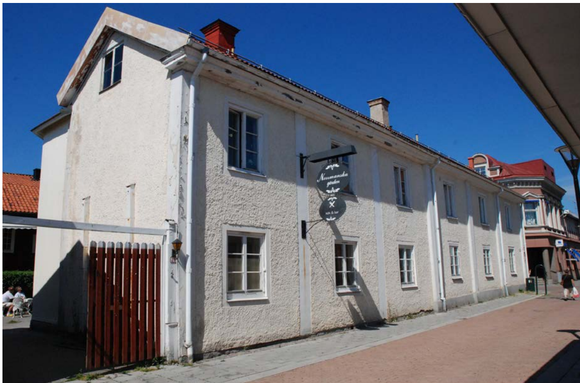
Normanska gården innan ommålning av fasad och fönster.
