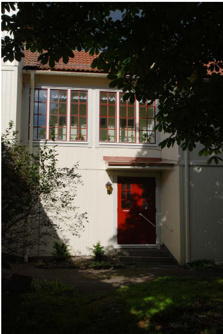
Innergården efter ommålning. Fasaden är målad med linoljefärg. Dörrar och fönster målades röda och foder i ljus grå efter fastighetsägarens önskemål. Balkongerna målades svarta.
