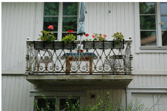
En av balkongerna innan och under ommålning. Överliggaren skrapades trären och oljades.
