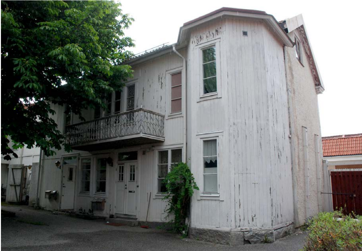
Norrmanska gårdens innergård innan ommålning. Plastfärgen på fasaden flagnar kraftigt.
