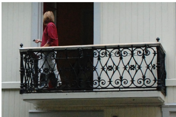
En av balkongerna innan och under ommålning. Överliggaren skrapades trären och oljades.
