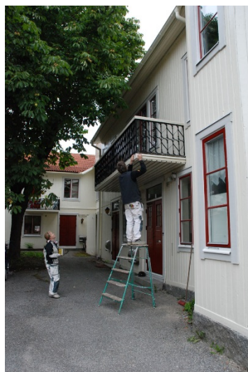
Innergården efter ommålning. Fasaden är målad med linoljefärg. Dörrar och fönster målades röda och foder i ljus grå efter fastighetsägarens önskemål. Balkongerna målades svarta.
