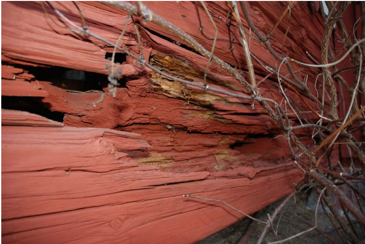
Detalj av det skadade timret på södra fasaden.
