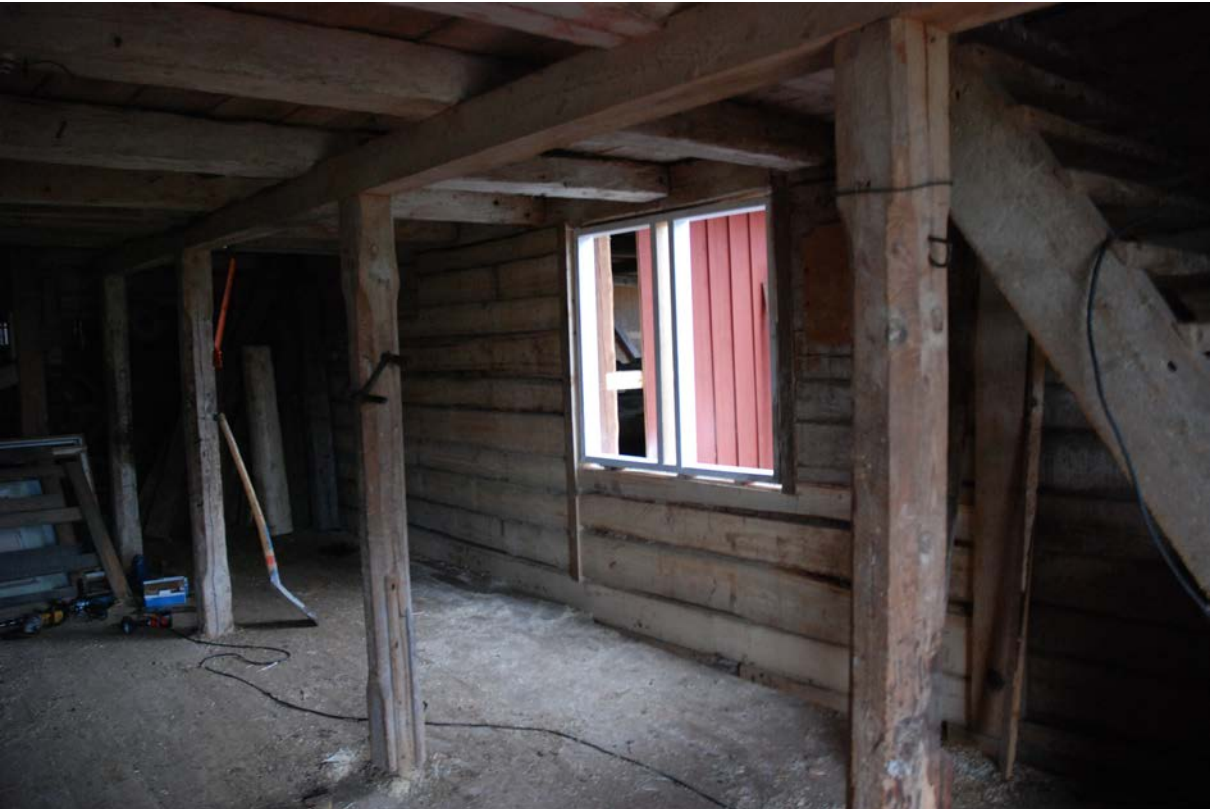
På kvarnens södra vägg efter ilagningar av eget sågat timmer.
