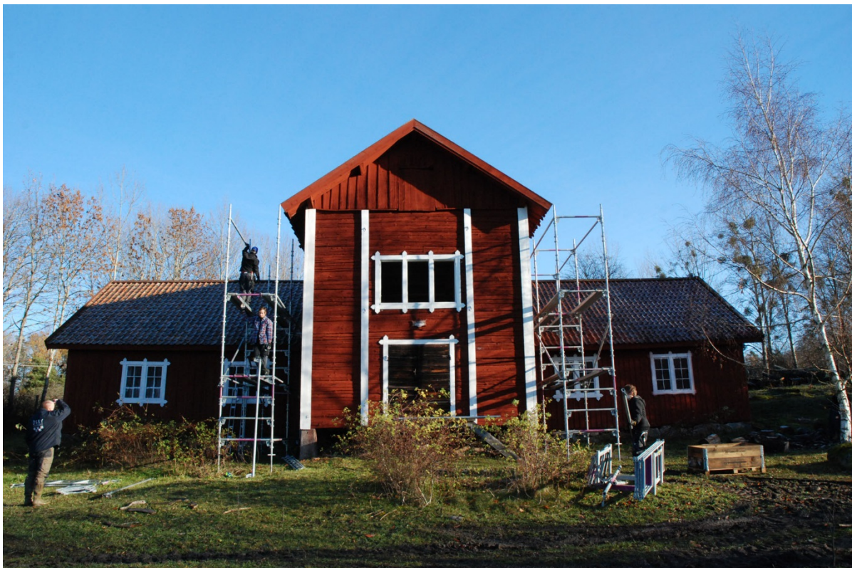
Såg- och kvarnbyggnadens västra fasad innan byggnadsvårdsåtgärdernas genomförande.
