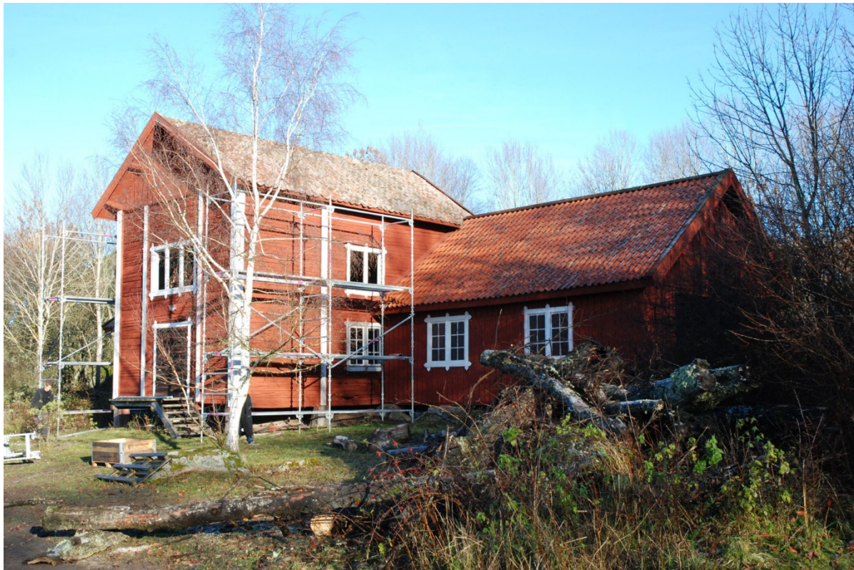
Såg- och kvarnbyggnadens södra fasad innan byggnadsvårdsåtgärdernas genomförande.
