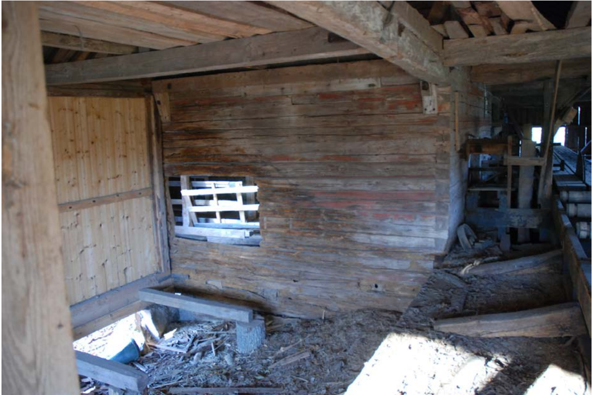
På kvarnens södra fasad, inne i sågverket. Innan byggnadsvårdsåtgärderna.
