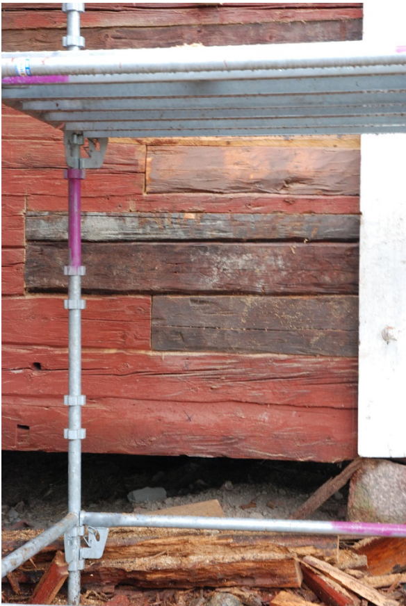
Timmervoarv har lagats med återanvänt timmer. Norra väggen efter timmerarbetet.
