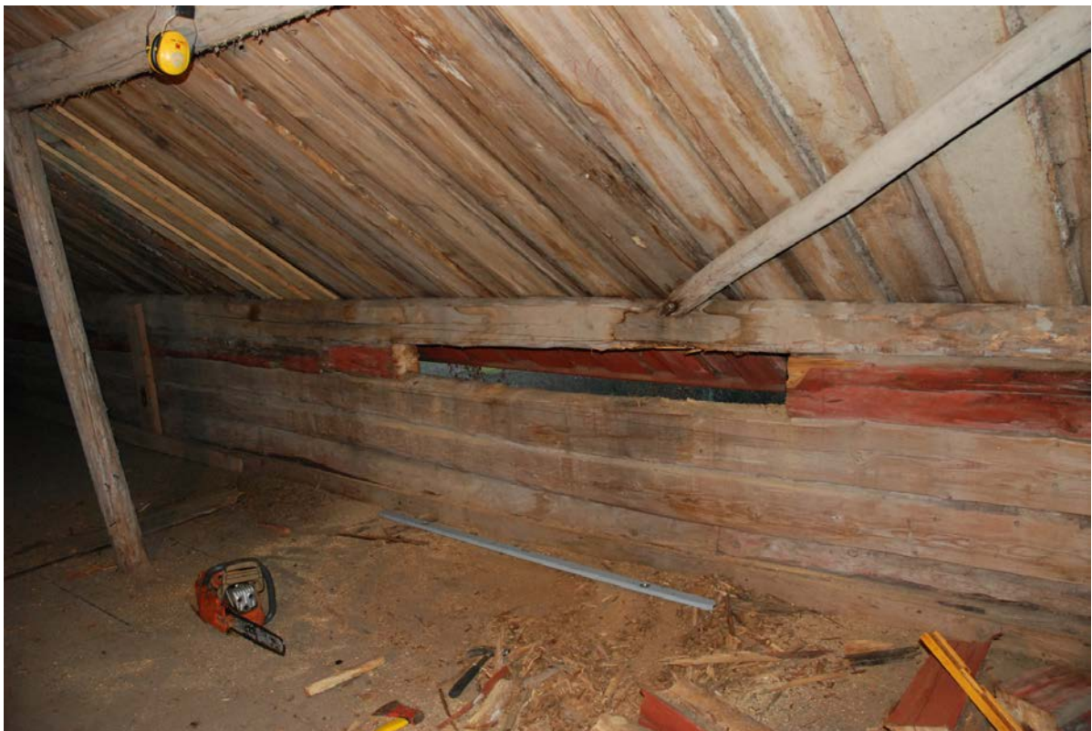
Skadade delar bytts ut och delar av undertaket har ersatts med nytt.
