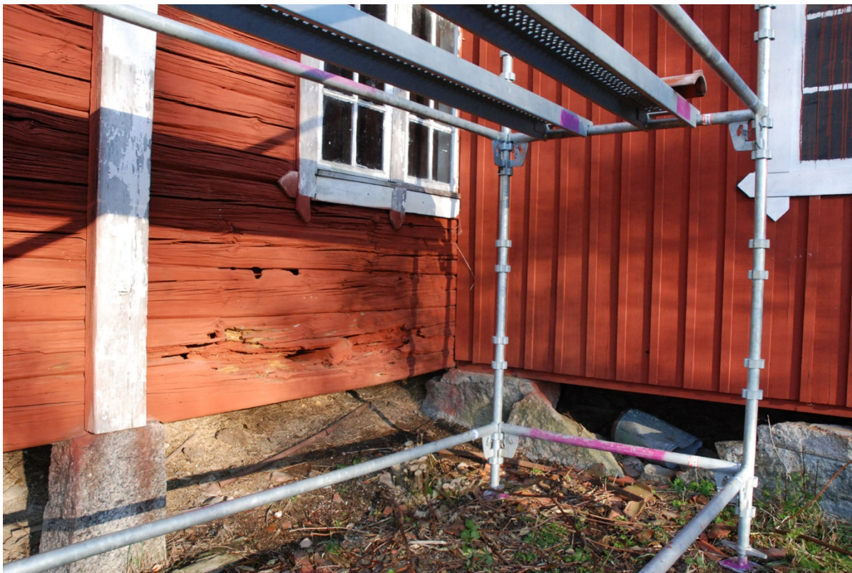
Timmerskador på södra fasaden.
