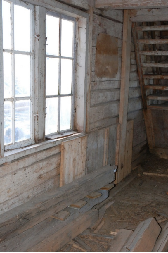
På kvarnens södra vägg innan åtgärder.
