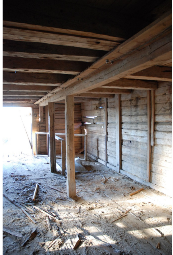
T v och t h kvarnens norra vägg med timmerskador. Nedan pågående lagningsarbete.
