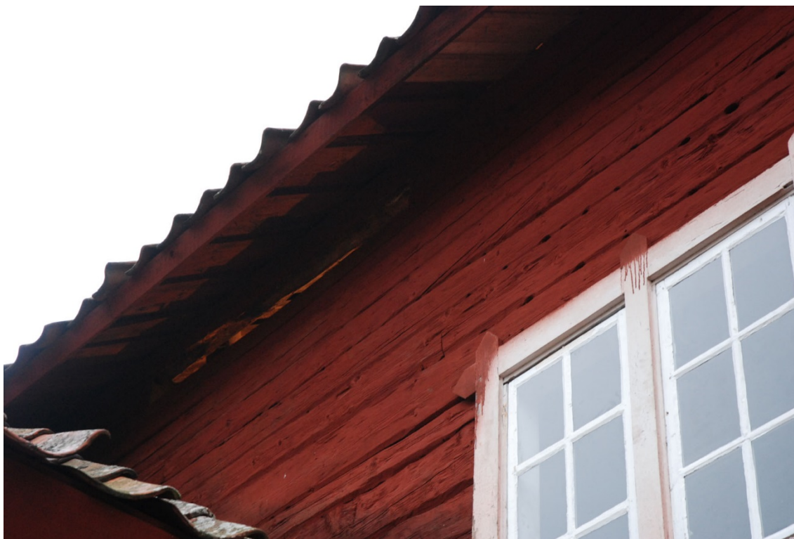
Skada på timret under takfot, på norra fasaden.
