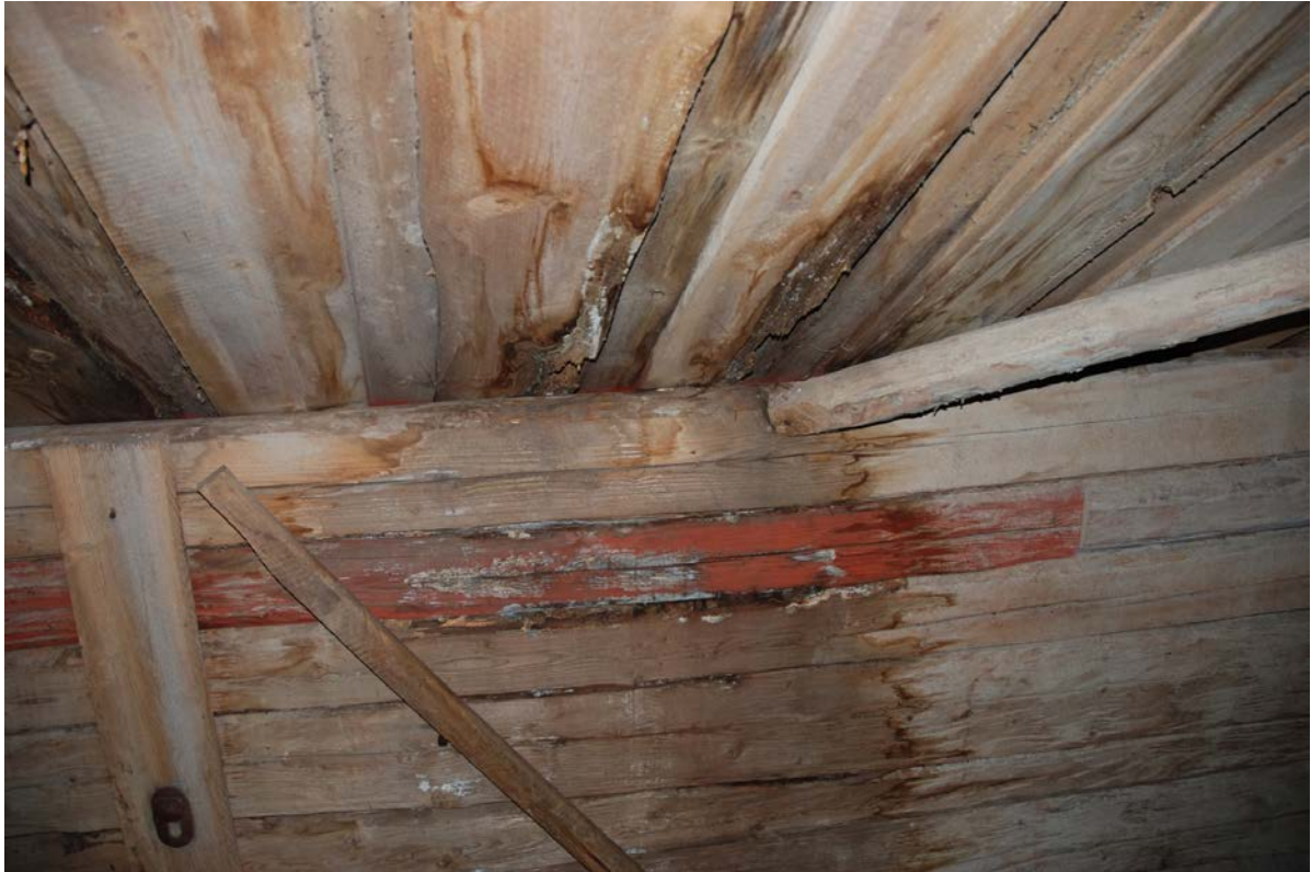
Fuktskada på undertaket och timmerväggen.
