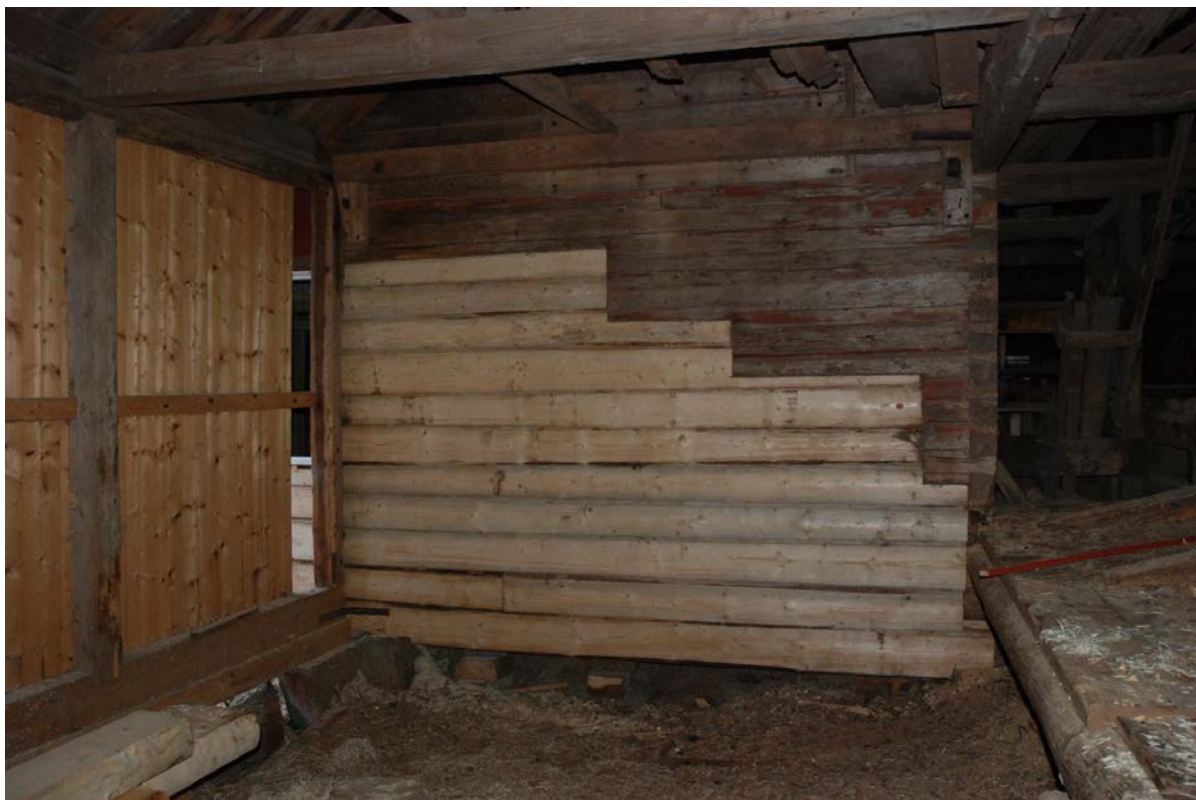
På kvarnens södra fasad, inne i sågverket. Efter byggnadsvårdsåtgärderna genomförande.
