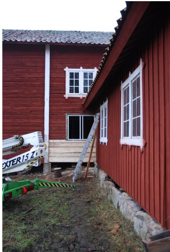
På kvarnens södra fasad, med ilagningar.
