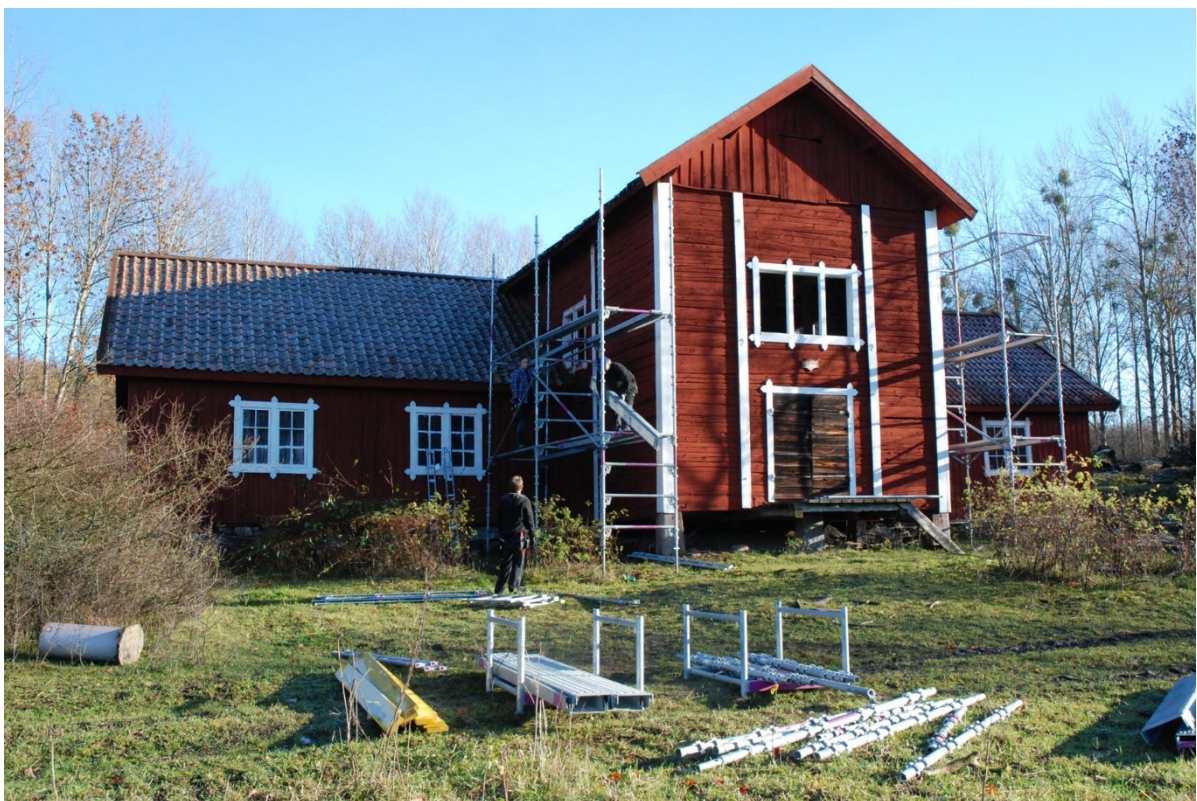
Såg- och kvarnbyggnadens norra fasad innan byggnadsvårdsåtgärdernas genomförande.
