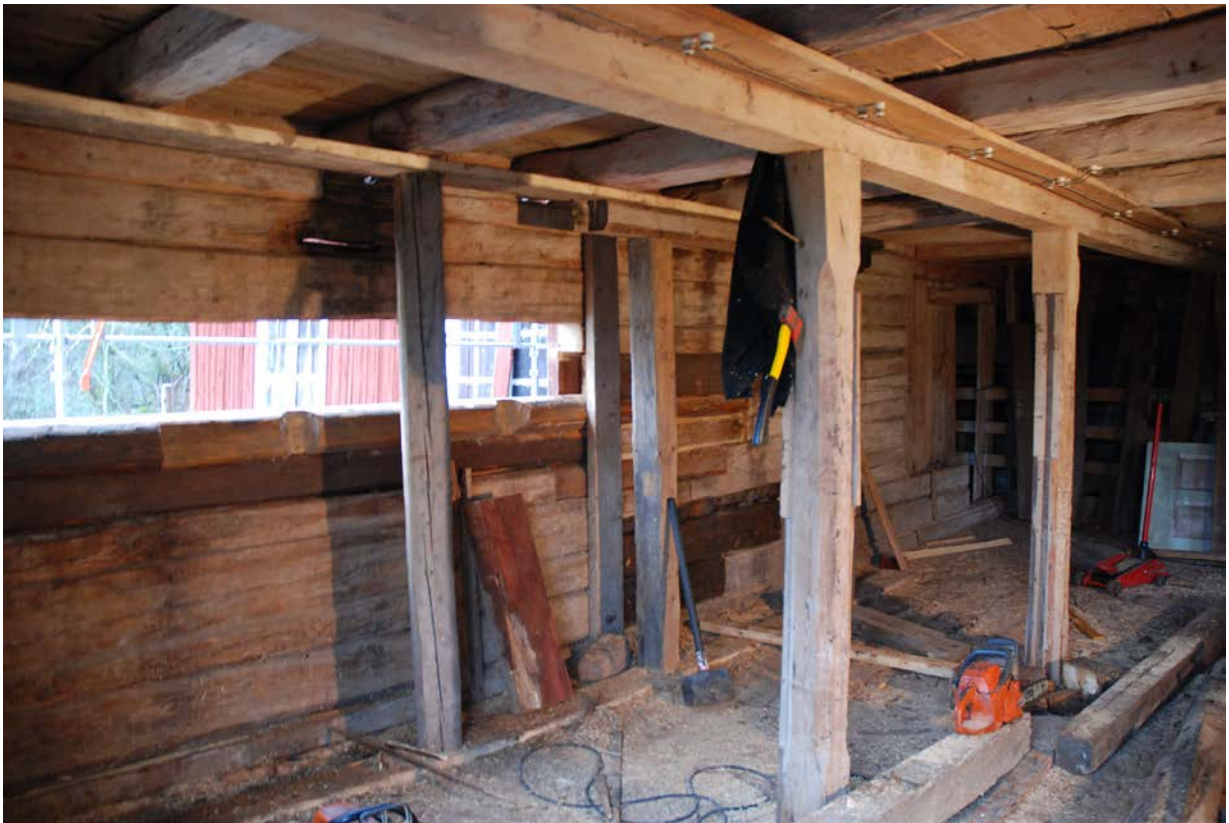
T v och t h kvarnens norra vägg med timmerskador. Nedan pågående lagningsarbete.
