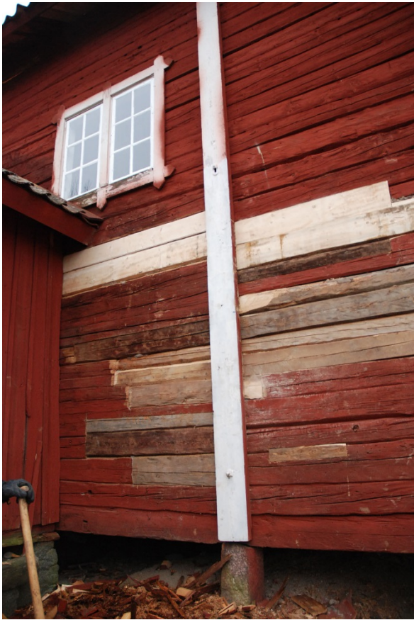
Timmerlagningar på norra fasaden.
