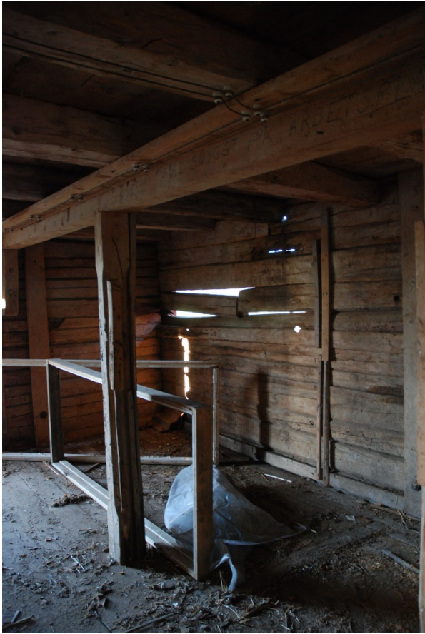
T v och t h kvarnens norra vägg med timmerskador. Nedan pågående lagningsarbete.
