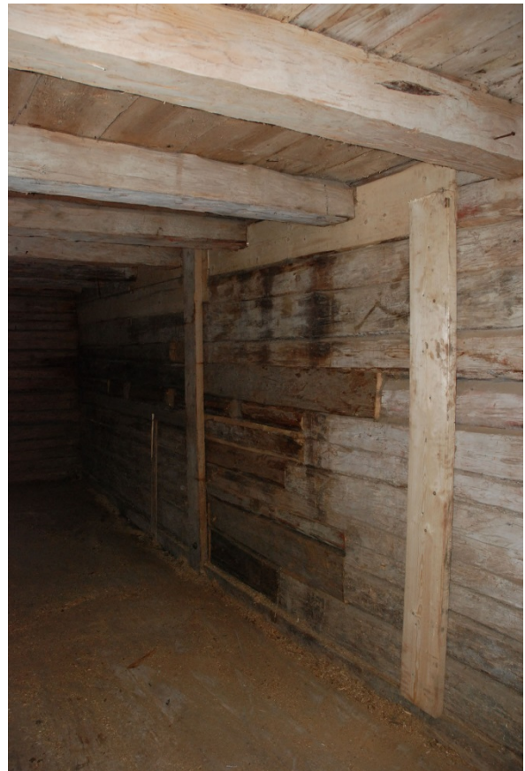
Timmervoarv har lagats med återanvänt timmer. Norra väggen efter timmerarbetet.
