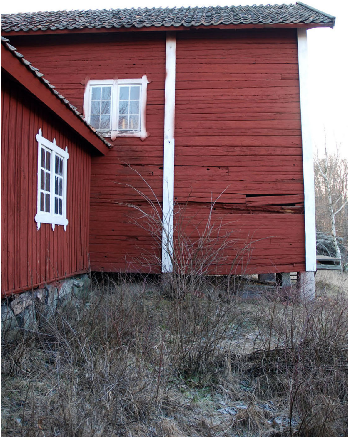
Koarnen mot norr men timmerskador.
