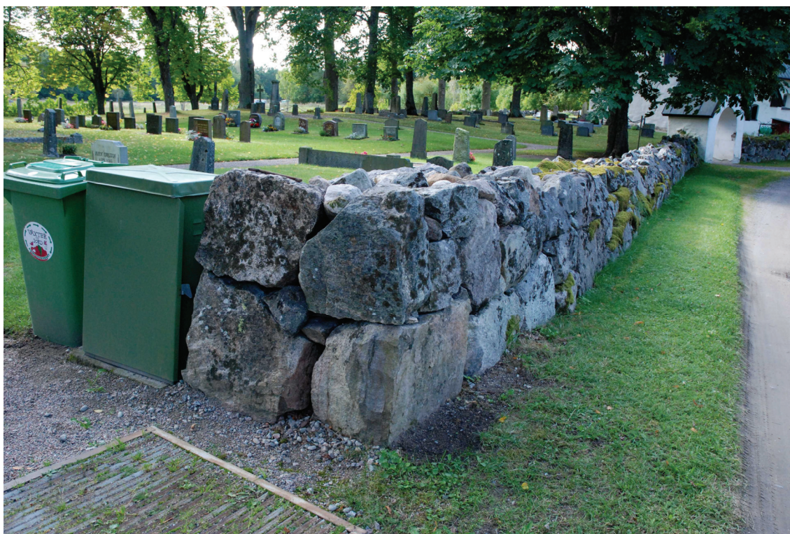
Bild 5: Parti D efter åtgärder.
