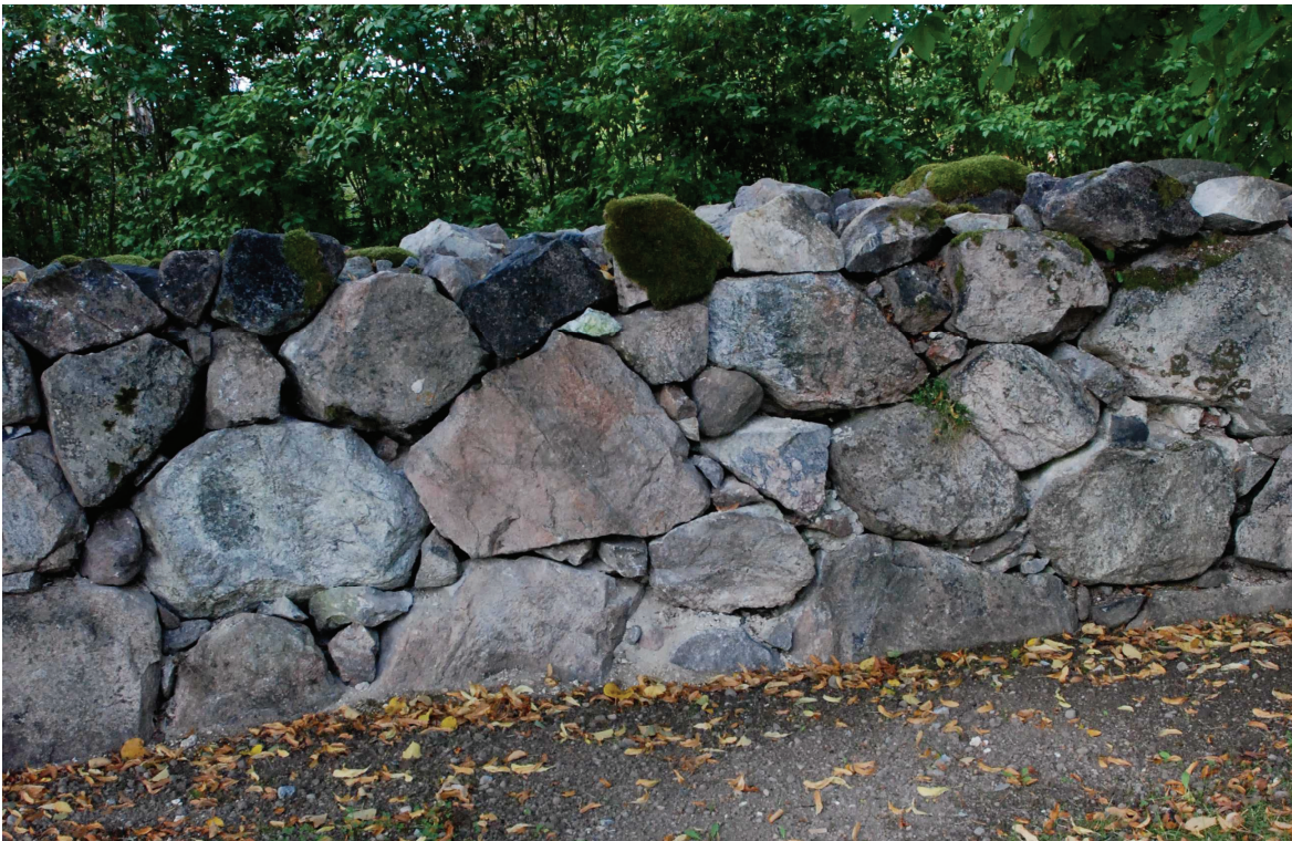
Bild 9: Parti A1 efter åtgärd.
