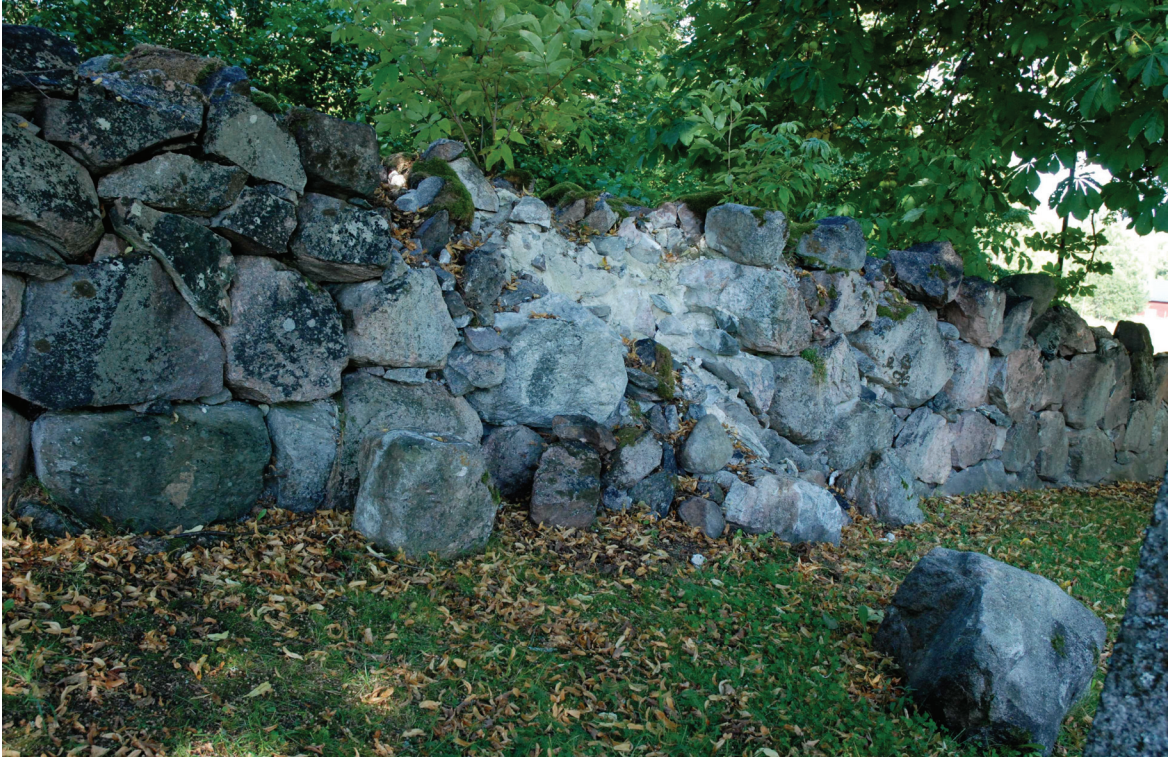
Bild 8: Parti A1 före åtgärd.
