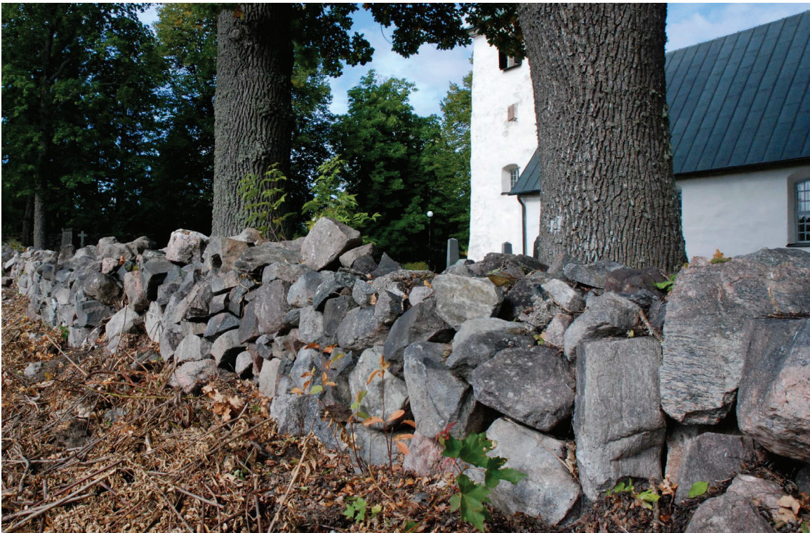
Bild 7: Parti B efter åtgärder.
