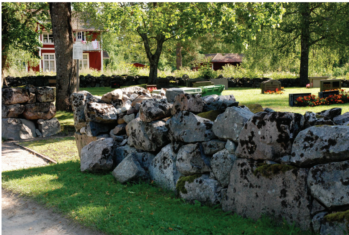
Bild 4: Parti D före åtgärder
