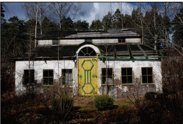
Byggnaden var före restaurering i mycket dåligt skick, framförallt taktäckningen av papp hade stora brister. Foto: Mia Jungskär 2008-03-20. VLM.
