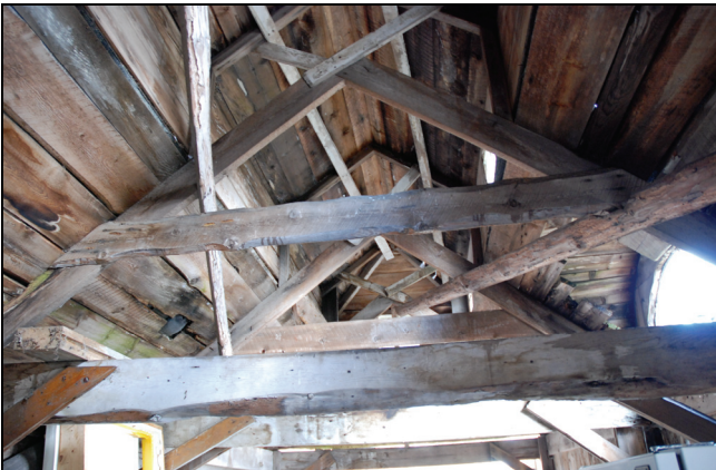
Byggnadens innertak före restaurering. Foto: Mia Jungskär 2008-03-20. VLM.
